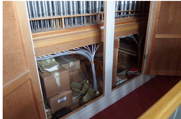
Figur 25. Förvaringsutrymme i orgeln.
