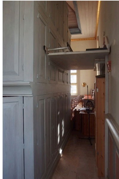
Figur 23. Stämgången saknar skyddsräcke.
