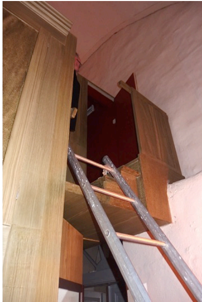
Figur 22. Stegen har stöd endast på höger sida.
