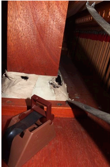
Figur 12. Läckage pga musätet skinn.
