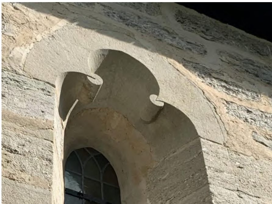
Korets södra fönster. Detalj av omfattningens bågrön. Foto JL 2020.
