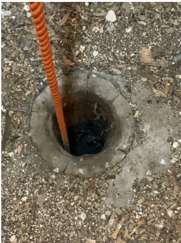
Tornets första övervåning. Linhål i golvet med sturk (träfodring). Till höger rummets norra mur med hål efter parställda bjälkar, sannolikt från tornets uppförande. Foto JL 2020.
