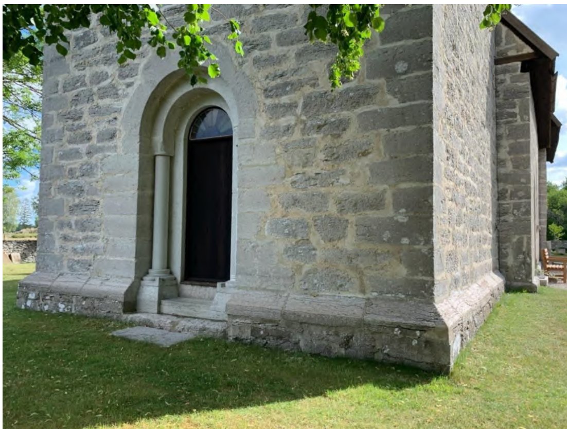
Tornets nedre del från sydväst. Foto JL 2020.
