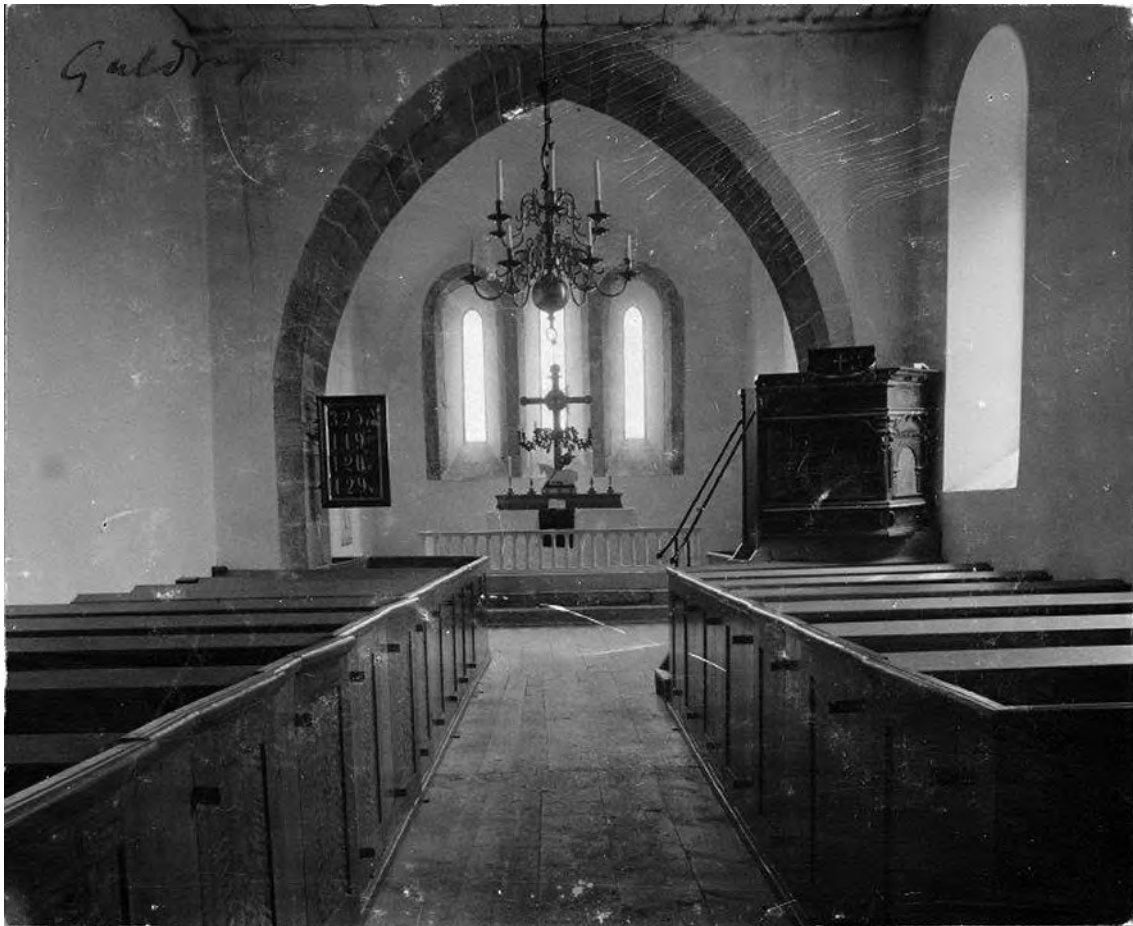
Interiör mot öster, sannolikt på 1890-talet. Äldre foto i RAÄ, Kulturmiljöbild.
