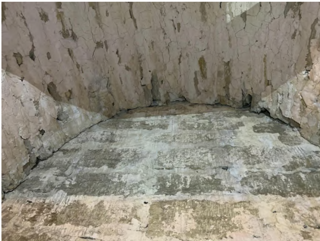
Långhusets västra mur sedd inifrån tornet med valvbåge i tornets östmur. Foto JL 2020.
