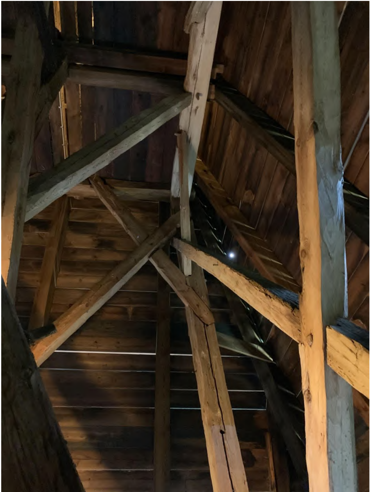
Tornhuvens inre konstruktion sedd uppåt mot nordväst. Foto JL 2020.
