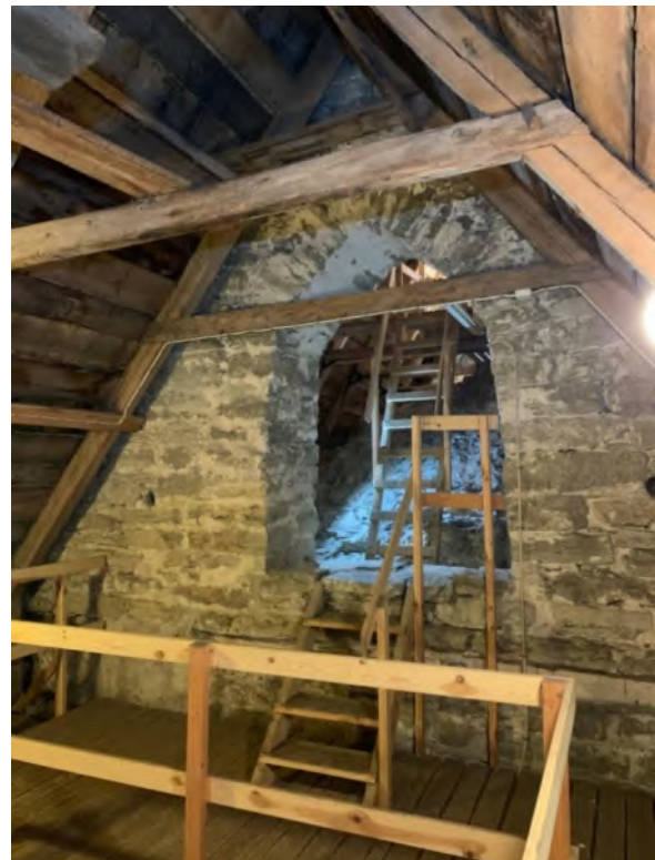
Styrbjälke från långhusets innertak, avlägsnad 1964–65. Till höger öppningen till korvinden sedd från långhusvinden. Foto JL 2020.
