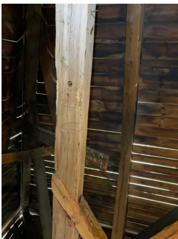
Tornhuvens inre konstruktion med inhuggna runor på den bärande konstruktionen. Till höger namn, sannolikt från tornhuvens reparation, skrivna med runor i krita 1882. Foto JL 2020.
