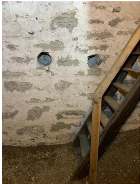
Tornets första övervåning. Linhål i golvet med sturk (träfodring). Till höger rummets norra mur med hål efter parställda bjälkar, sannolikt från tornets uppförande. Foto JL 2020.
