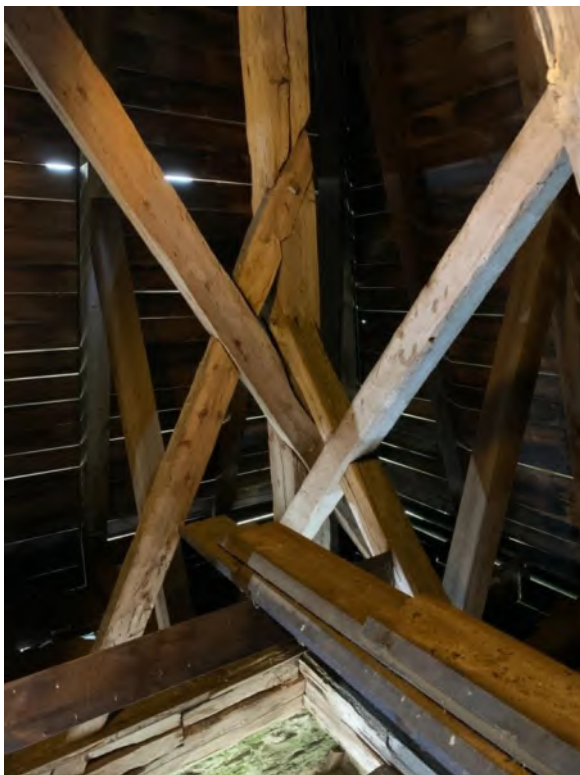
Tornhuvens inre, den bärande konstruktionen sedd mot sydväst samt av huvens övre del med hjärtstock. Foto JL 2020.
