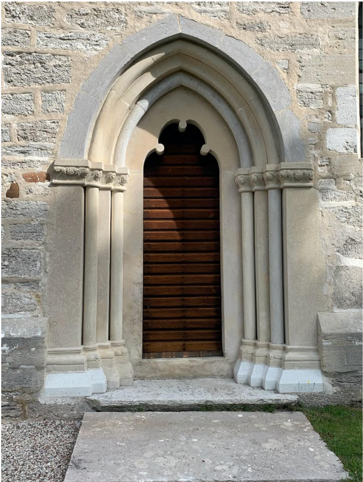
Korportalen. Ljusare partier i baserna utbytta 2005 Foto JL 2020.
