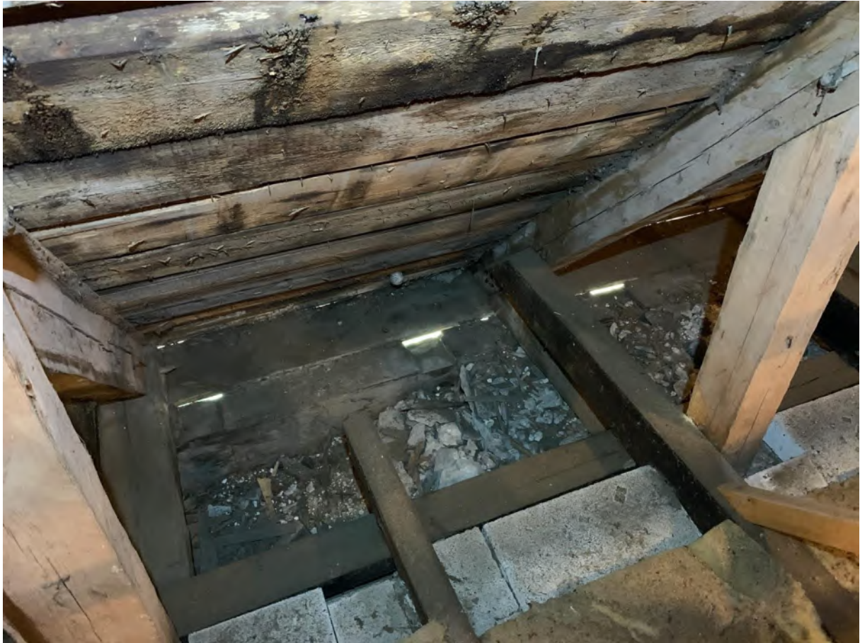
Långhusets södra murkrön med urtag i remstycket från tidigare bindbjälkar. 1964–65 års bjälkar för innertaket samt murarnas påbyggnad av betongsten i förgrunden. Foto JL 2020.
