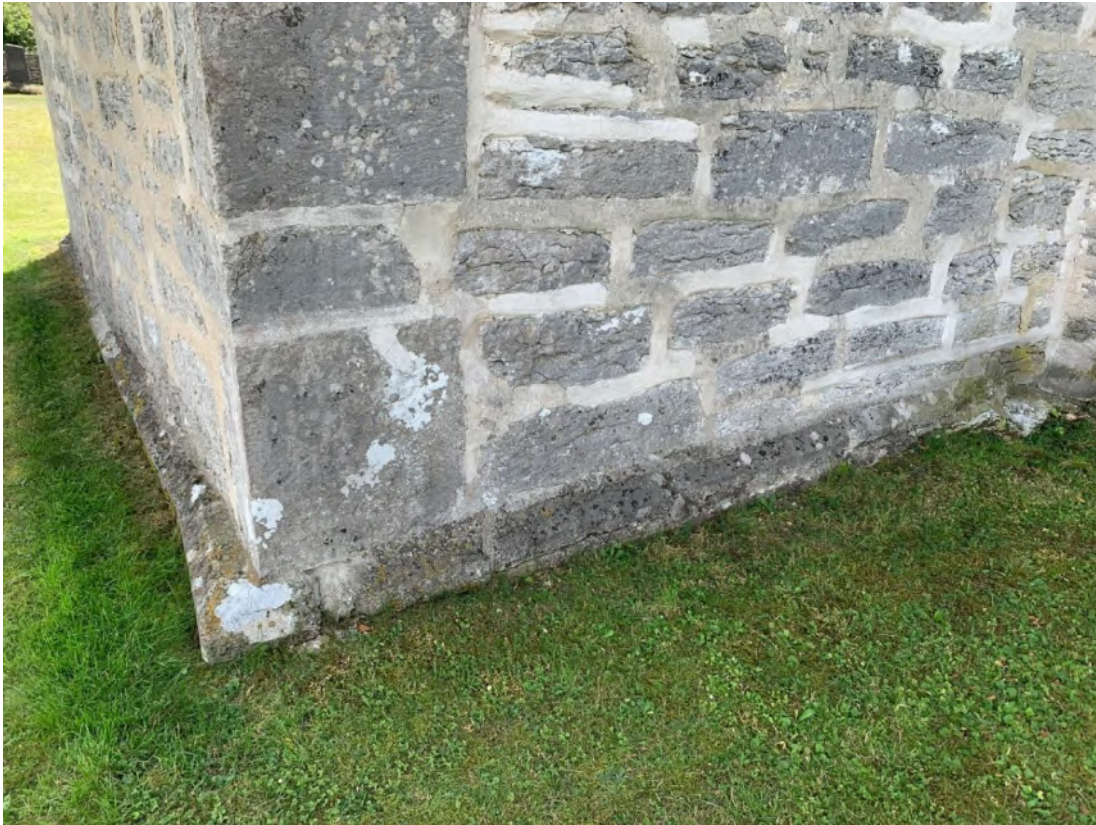
Sakristians sockel mot norr och väster, sannolikt återanvänd från det tidigare koret. Foto JL 2020.
