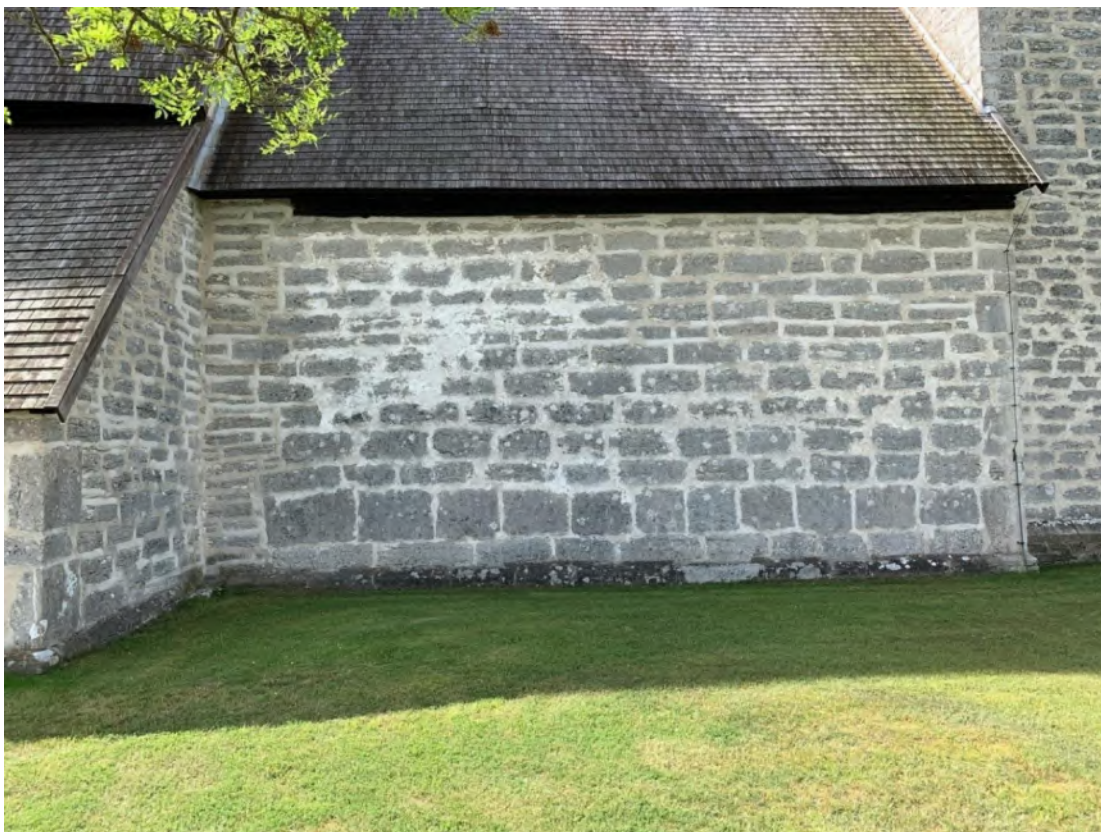
Långhusets norra fasad. Foto JL 2020.
