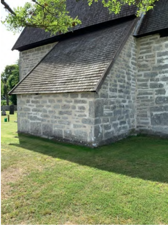
Sakristian från nordväst. Till höger hörnet mellan sakristians västra mur och långhusets nordmur. Sockeln till höger visar läget för långhusets tidigare nordöstra hörn. Foto JL 2020.
