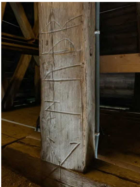
Tornhuvens inre konstruktion. Inhuggna runor och sammanfogningsmärken på hjärtstocken. Till höger sammanfogningsmärken på den bärande konstruktionen. Foto JL 2020.
