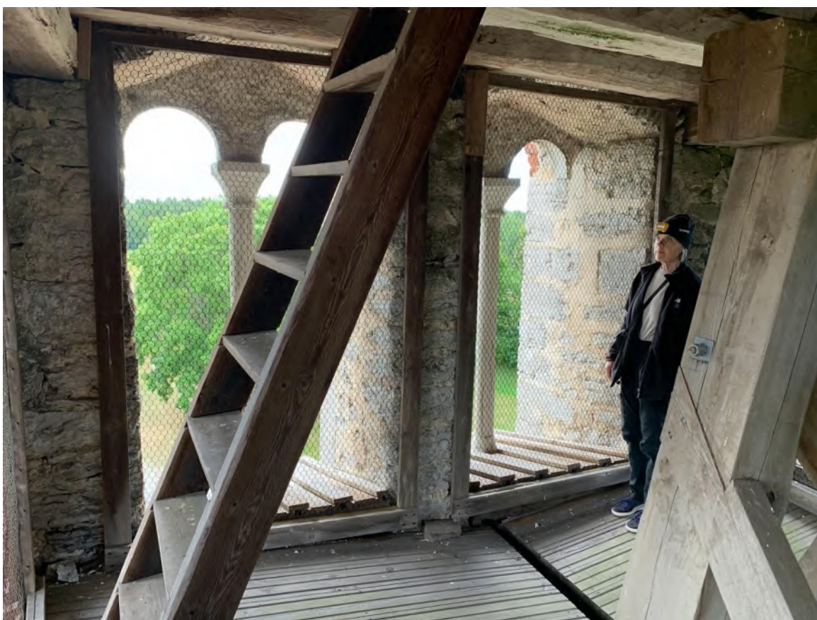
Klockvåningen sedd mot söder. Foto JL 2020.
