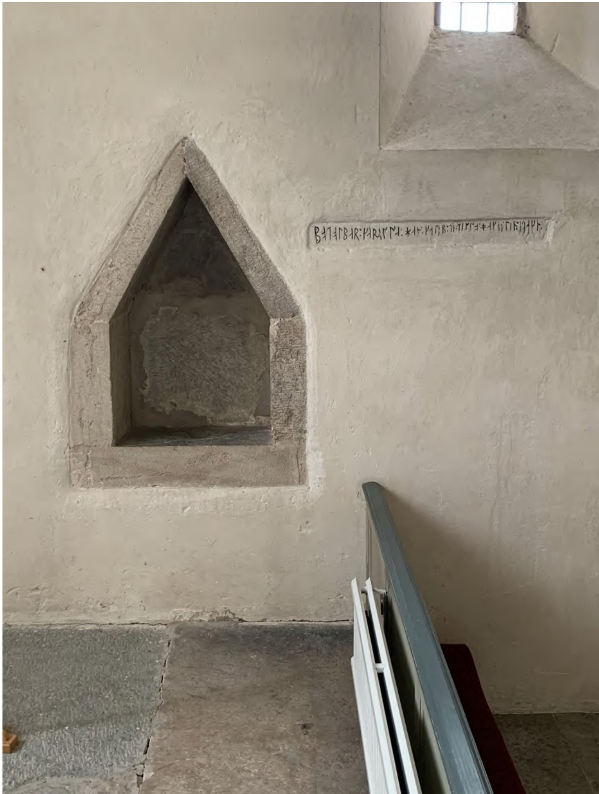
Korets södra mur med nisch och runinskrift. Foto JL 2020.
