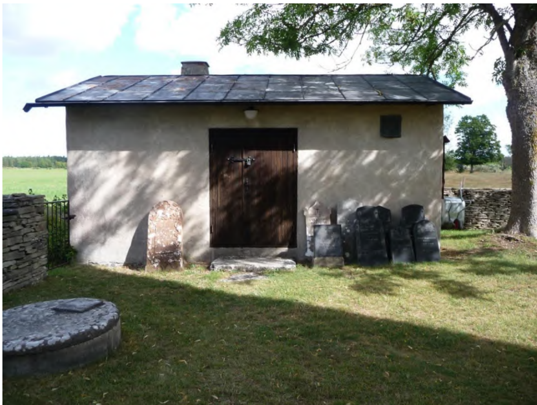
I det nordvästra hörnet finns en pannrumsbyggnad. Intill finns en liten ingång med en grind i smidesjärn. Foto ES 2020.
