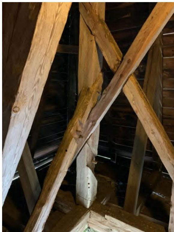
Tornhuvens inre, sett nedifrån och uppåt mot väster med hjärtstocken till höger, på vilken lampan är fäst. Till höger en bärande konstruktionen sedd mot sydöst. Foto JL 2020.
