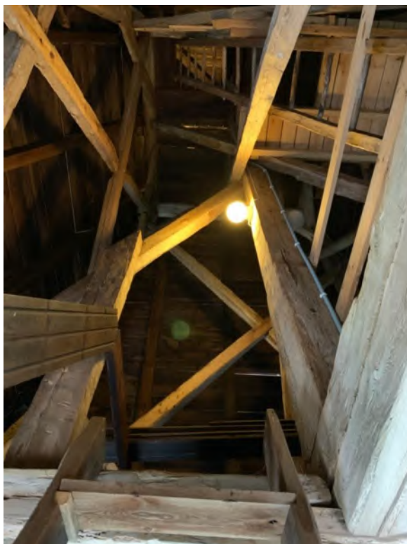
Tornhuvens inre, sett nedifrån och uppåt mot väster med hjärtstocken till höger, på vilken lampan är fäst. Till höger en bärande konstruktionen sedd mot sydöst. Foto JL 2020.
