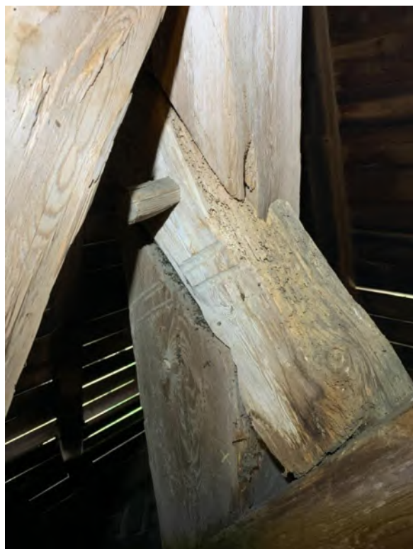
Tornhuvens inre konstruktion. Inhuggna runor och sammanfogningsmärken på hjärtstocken. Till höger sammanfogningsmärken på den bärande konstruktionen. Foto JL 2020.
