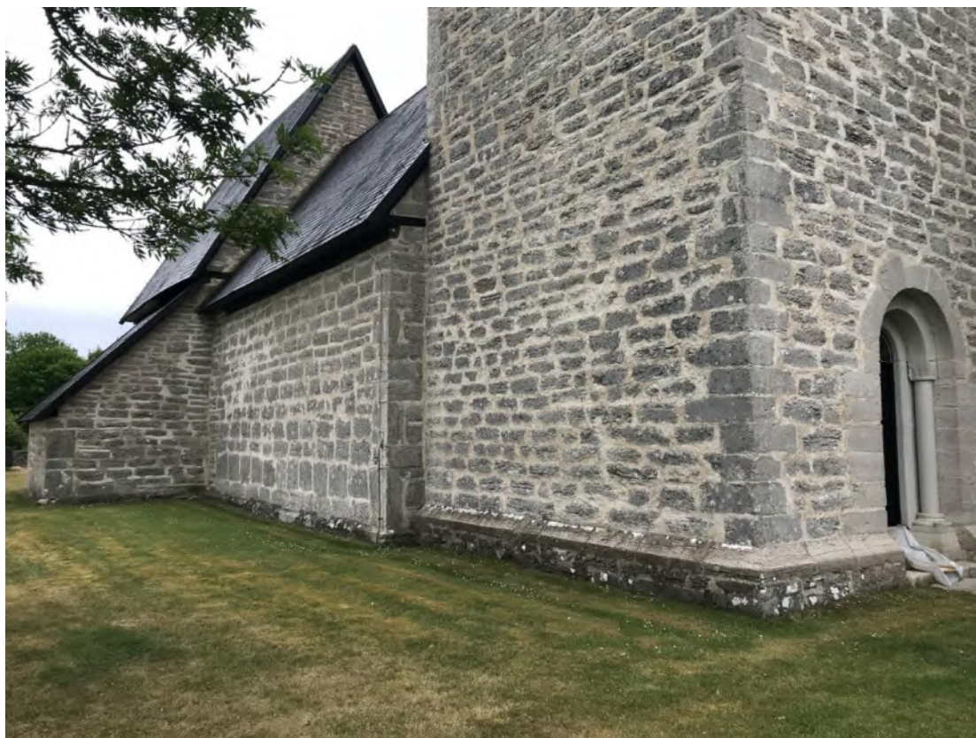
Långhusets och tornets norra fasader från nordväst. Foto JL 2018.
