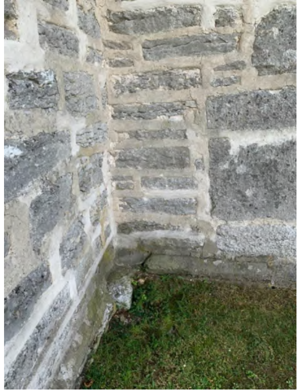
Sakristian från nordväst. Till höger hörnet mellan sakristians västra mur och långhusets nordmur. Sockeln till höger visar läget för långhusets tidigare nordöstra hörn. Foto JL 2020.
