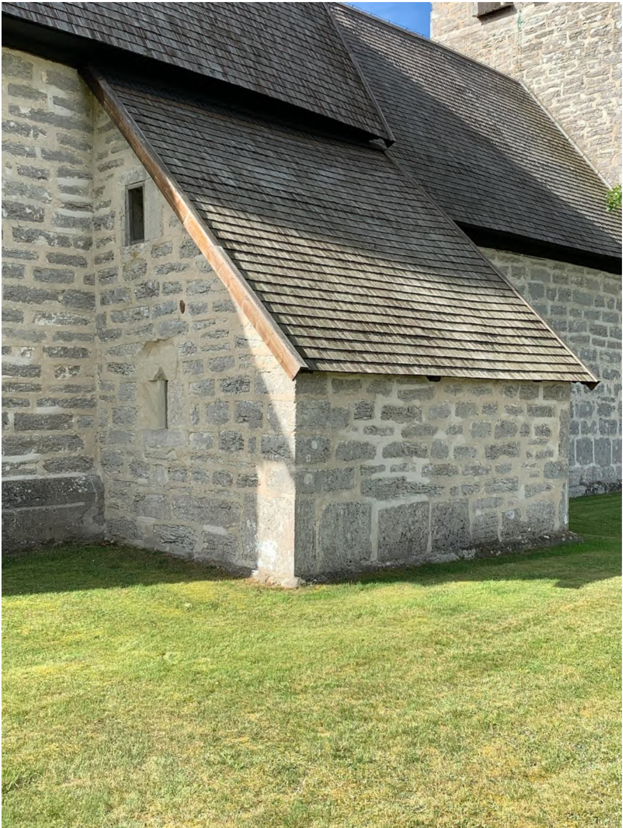
Sakristian från nordost. Foto JL 2020.
