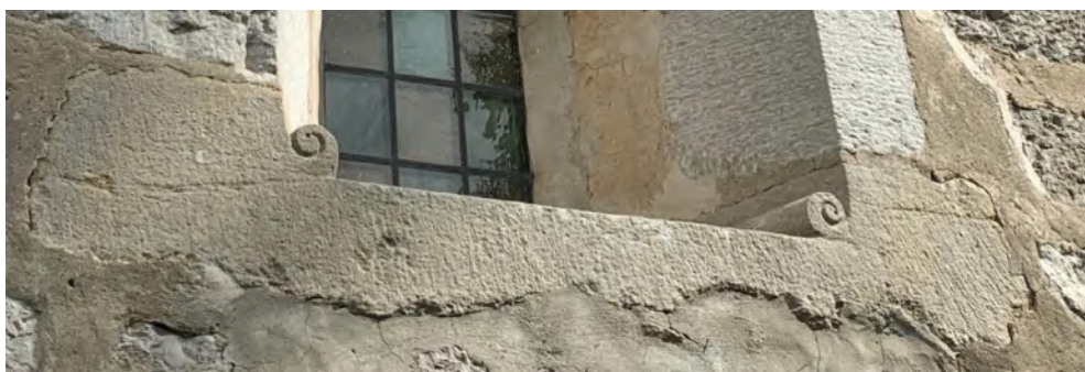
Korets södra fönster. Detalj av solbänken med voluter i hörnen. Foto JL 2020.
