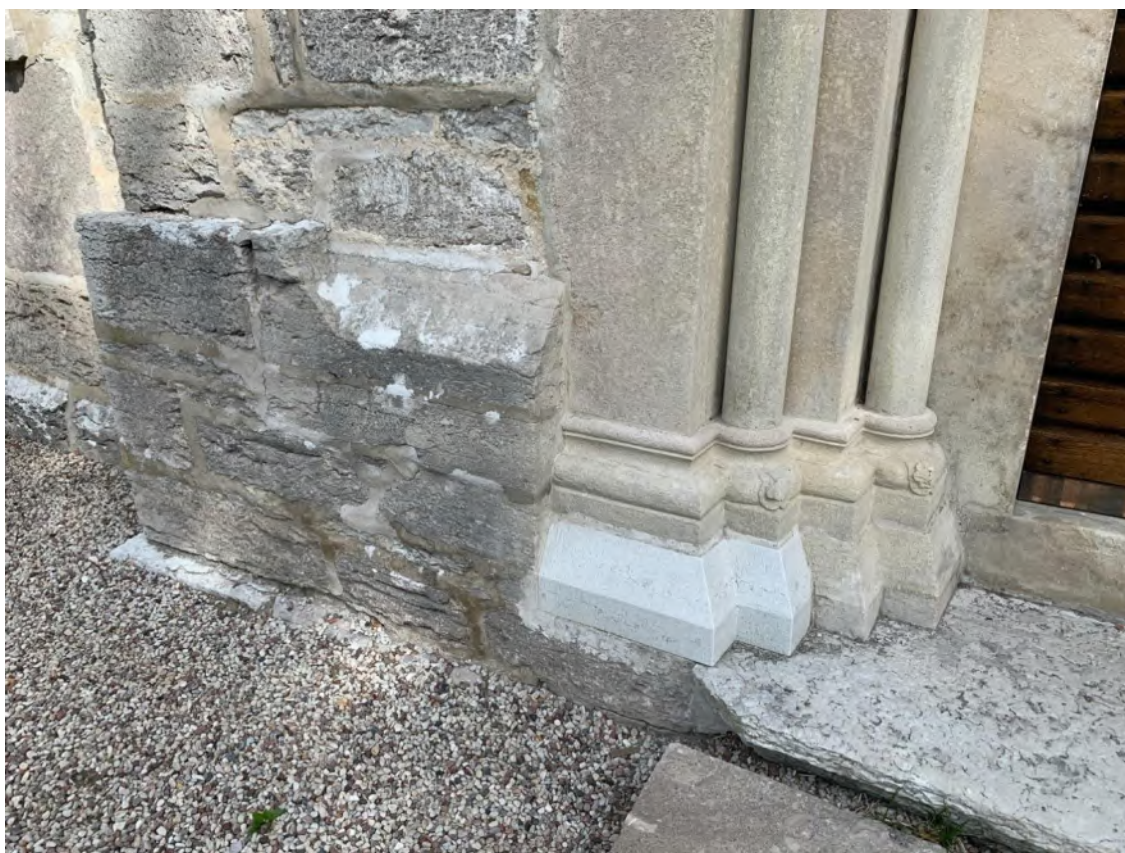
Korets sydvästra hörn med sockelns förtagning för ett planerat nytt långhus samt korportalens västra basband med nyligen utbytta delar. Foto JL 2020.
