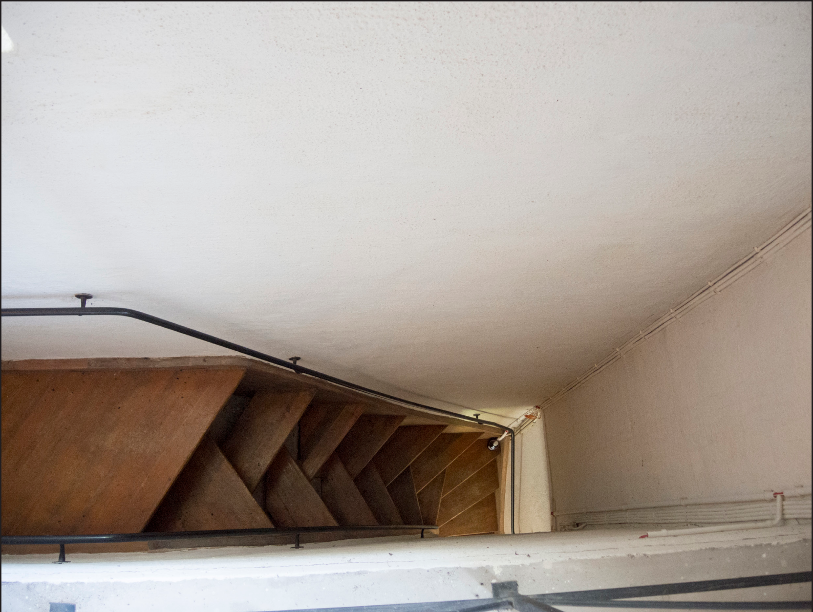
Stigningen mellan gapskullen och tornrummet ovanför är så brant att en wienertappa, eller spartrappa, byggs.
