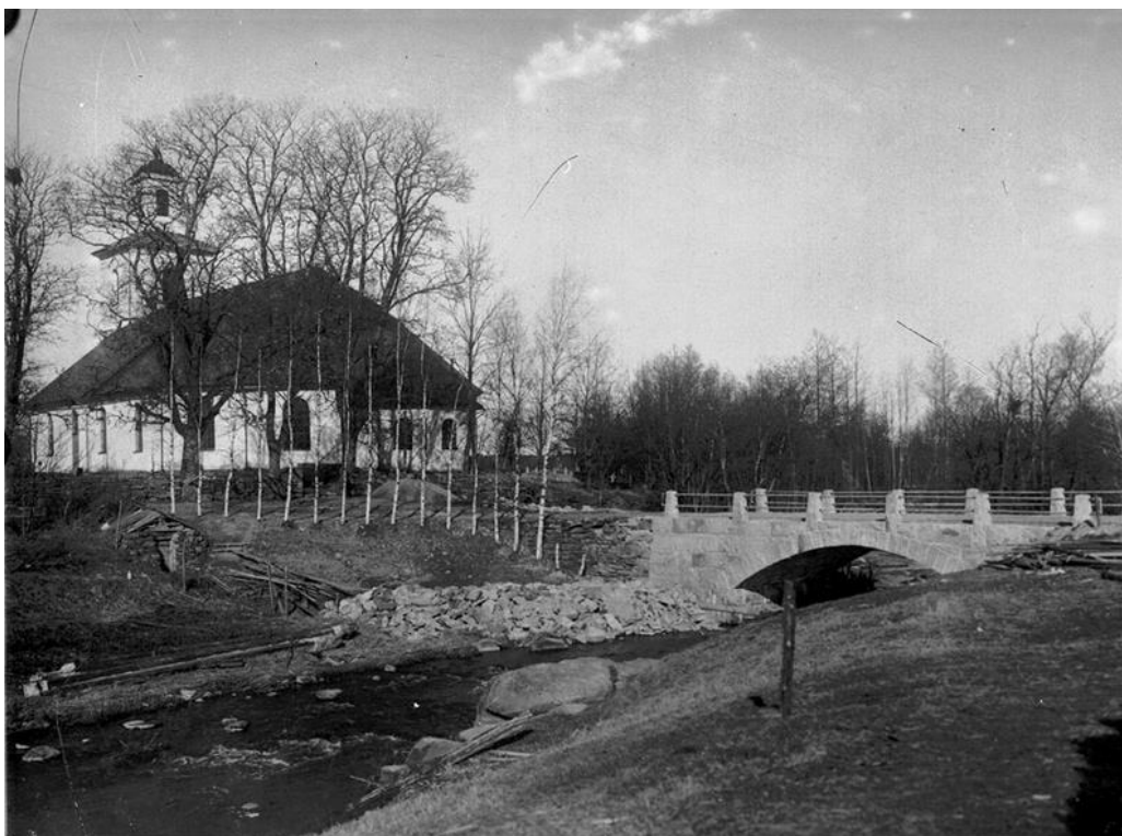
Ytterligare en bild som visar kyrkan sedd ifrån öst. Här syns stenvälsbron som troligen uppfördes i början på 1920-talet. Den är uppförd i ett spann och ersatte en äldre bro delvis av trä. Foto från Region Värmland, Värmlandsarkiv, omkring 1920-tal.
