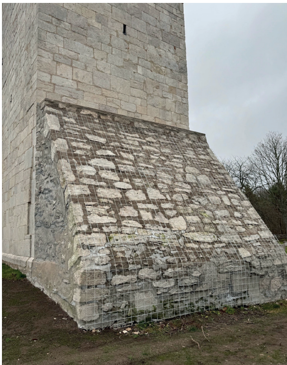
Bilder efter restaureringen. Strävpelaren i väster var helt täckt av murgröna som nu har tagits bort. Till höger långhusportalen, med den inmurade röda stenen. Dörrar, tak och tornspira har tjärats. Foto: Lars Bäckman, 2024.
