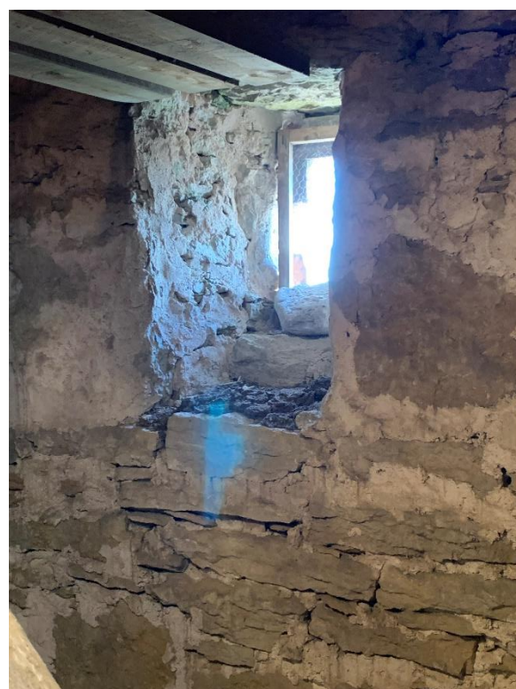
Korets östra gavelsöte mot nordöst med infällda större stenblock, kanske återanvända från en tidigare murad kyrka. Till höger glugg i korets östra gavel. Foto JL 2022.
