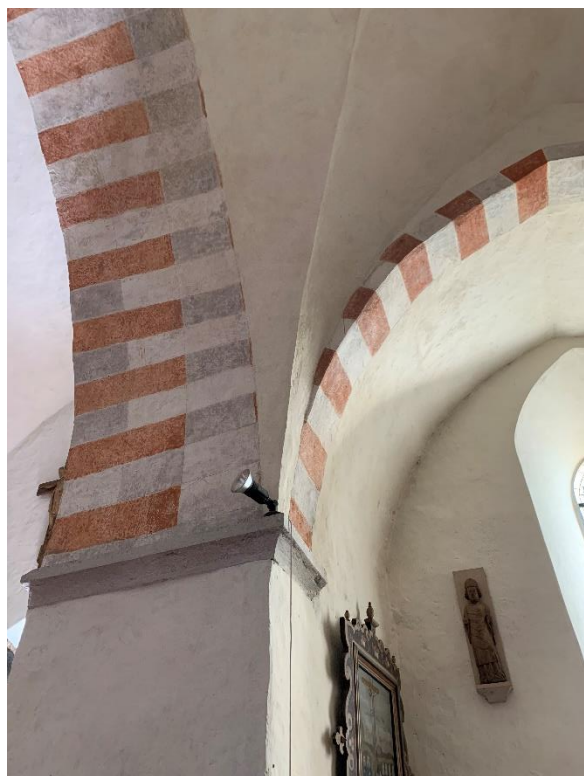
Ringkammarens bågar och valv, sedda mot sydöst. Foto JL 2022.
