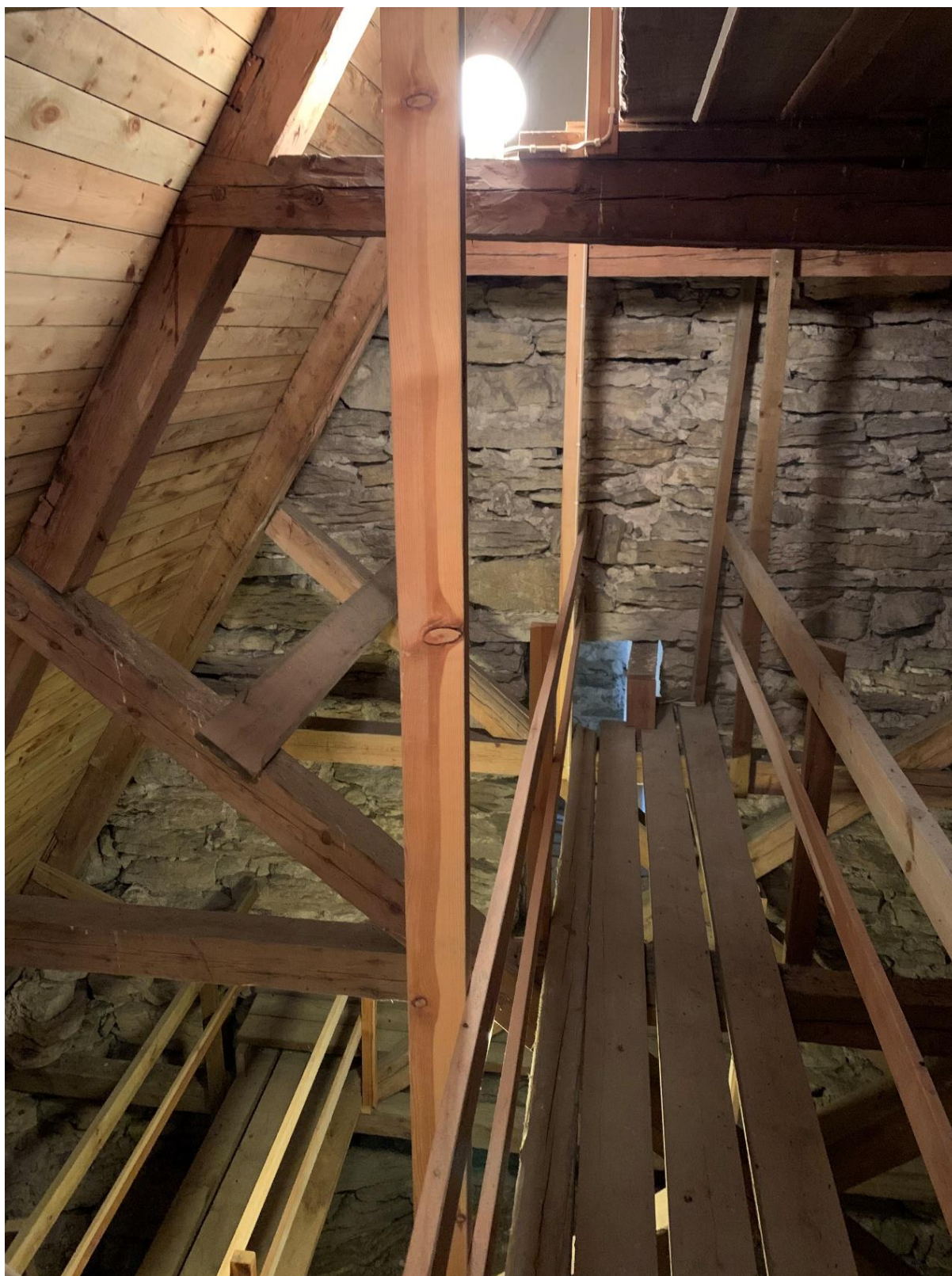
Långhusvinden mot väster med östra tornmuren. Foto JL 2022.
