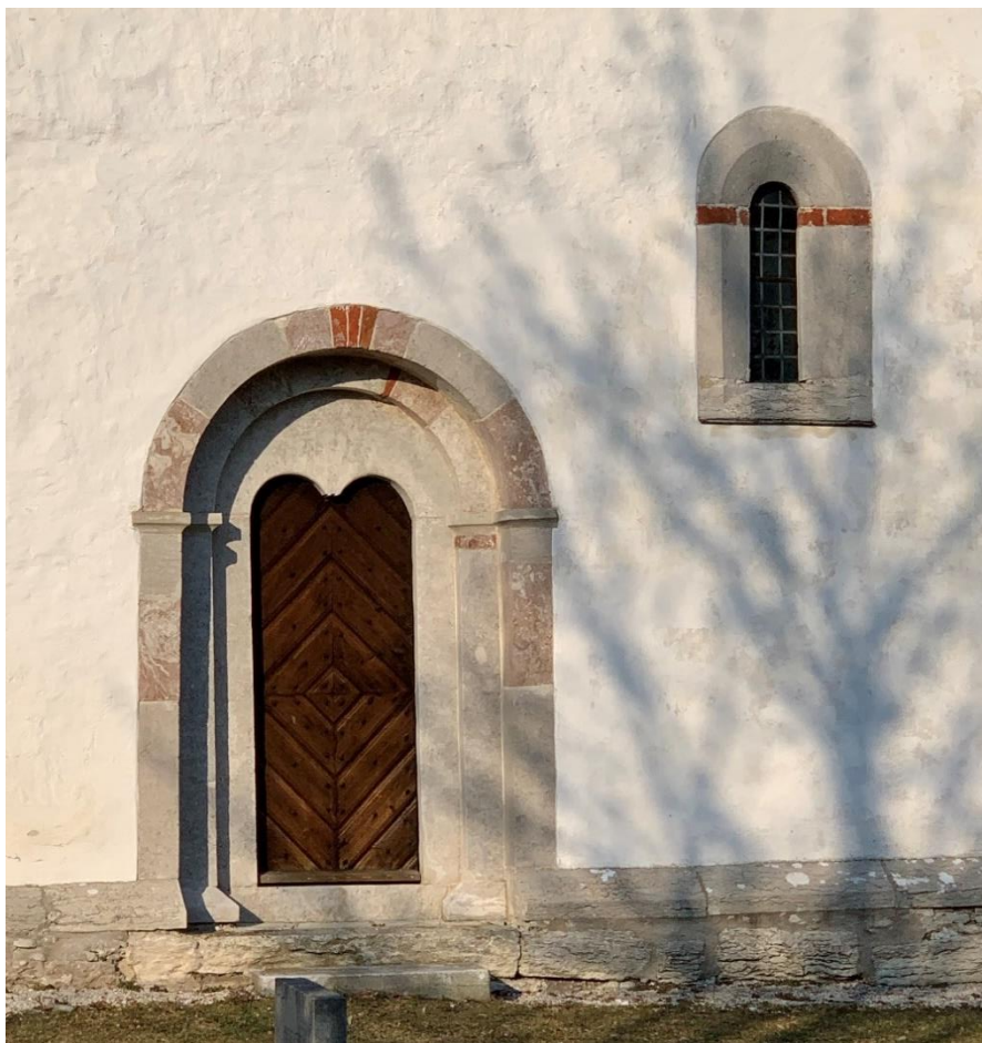
Korportalen och korets södra fönster. Foto JL 2022.
