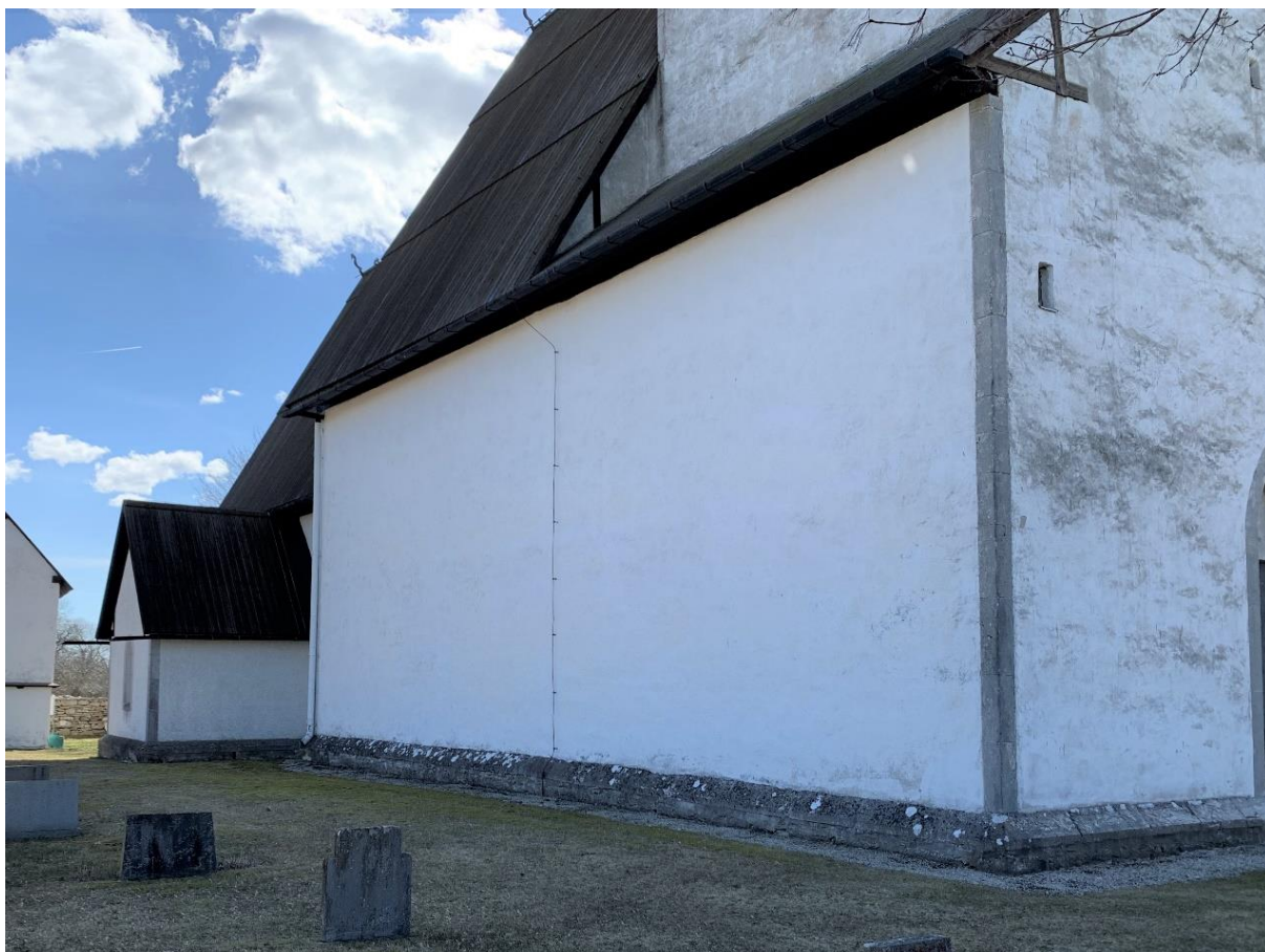
Långhusets och tornets norra fasad, sedd från nordväst. Foto JL 2022.
