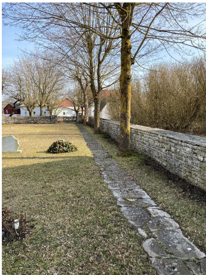
Den yngre kyrkogården omges av en kallmurad kalkstensmur. Gångarna är belagda med kalkstensflis. Foto ES 2022.
