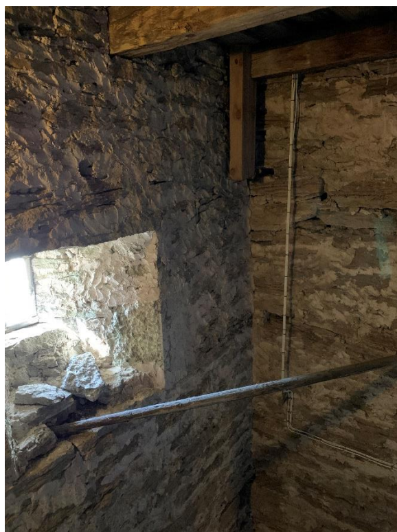
Tornets första övervånings nedre del mot sydöst samt övre delen mot sydväst i höjd med ljusgluggen. Gluggens kanter präglas av råta linjer och i västra smygen sitter ett inmurat välhugget stycke, sannolikt antingen återanvänt eller kasserat från annat håll. Foto JL 2022.
