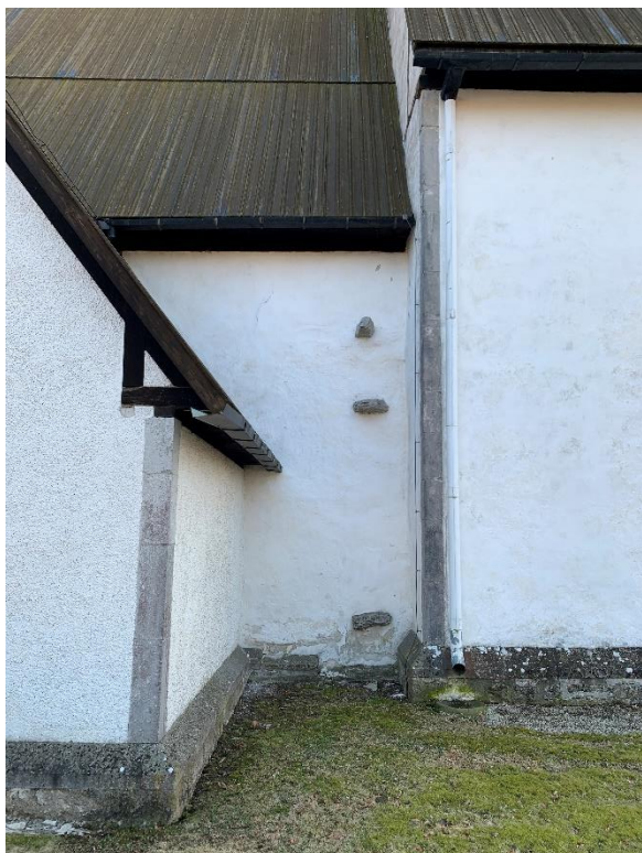
Förtagning i norra hörnet mellan koret och långhuset, sannolikt för långhusets gavelmur, som sedan lades ett stycke längre åt väster eller möjligen för en planerad sakristia. Foto JL 2022.
