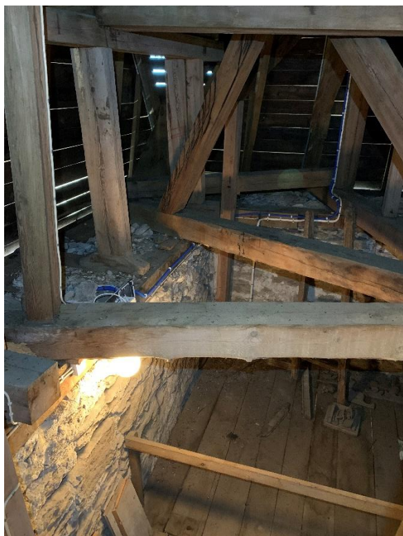
Tornets andra övervåning med murkrön och i stjärnform lagda bindbjälkar till tornhuvens, sedda mot sydväst och nordväst. Foto JL 2022.
