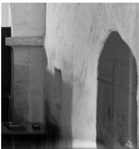
Detalj av korets norra mur kring den 1944 upptagna sakristieingången med 2002 framtagna rester av kalkmålning som utgjort målad omfattning till det tidigare sakramentsskåpet. Foto JL 2022. Till vänster sakramentsskåpets nisch som väggsåp, försedd med dörrar, borttagen 1944. Foto Alfred Edle 1933 (detalj), ATA.
