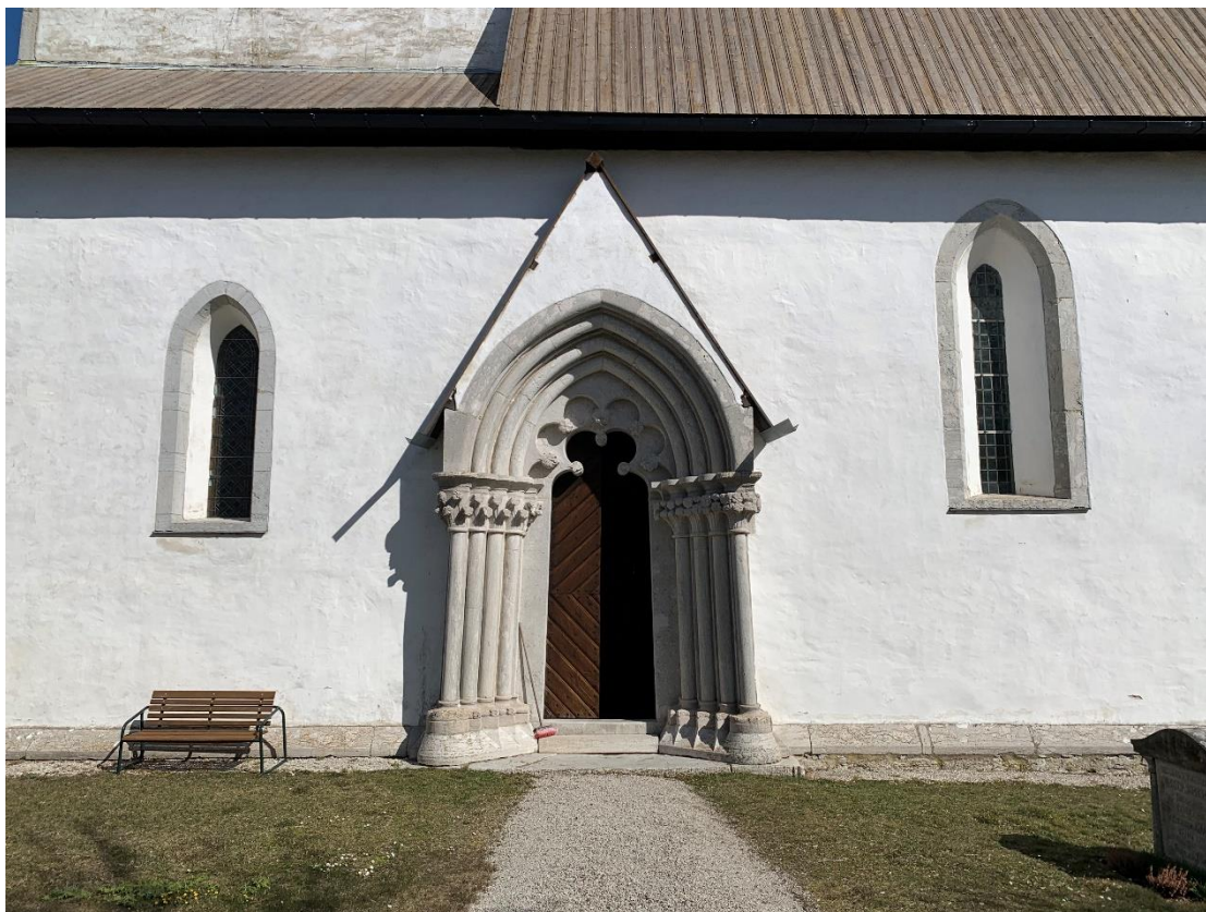
Tornets och långhusets sydfasad med portal och två fönster. Foto JL 2022.
