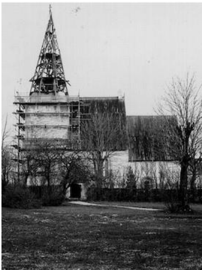
Kyrkan från söder under pågående restaurering 1966. Foto Waldemar Falck, Gotlands Museums arkiv. En skorsten, som troligen fanns från ca 1920 till 1966, syns på bilden.
