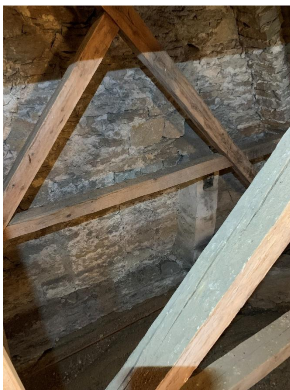
Korvinden mot nordväst med triumfbågsmurens övre och nedre del. I nedre delen strax ovanför valvet syns dels en rest av skorstensstocken från 1920-talet och till vänster om den en igensatt passage, troligen mellan korvinden och ett tidigare och lägre långhus vind. Foto JL 2022.
