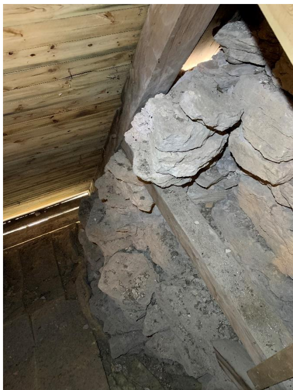
Svickeln mellan långhustaket och östra tornmuren med fyllningsmur, sedd mot sydväst och nordväst. Foto JL 2022.
