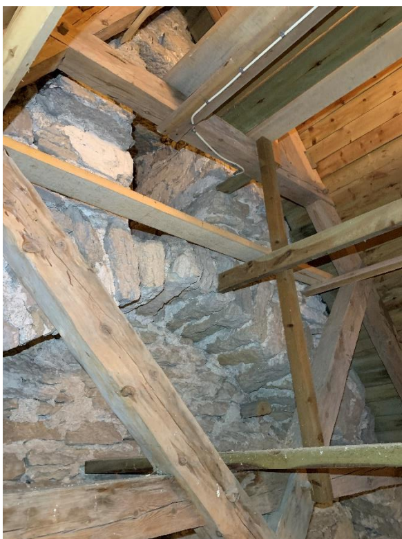
Korvinden mot nordväst med triumfbågsmurens övre och nedre del. I nedre delen strax ovanför valvet syns dels en rest av skorstensstocken från 1920-talet och till vänster om den en igensatt passage, troligen mellan korvinden och ett tidigare och lägre långhus vind. Foto JL 2022.
