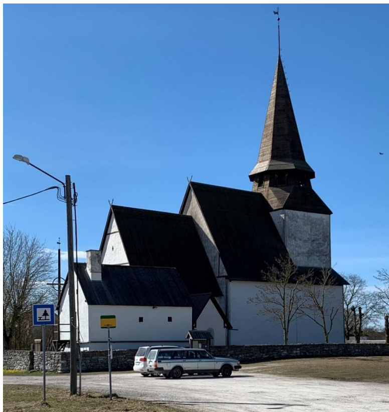
Exteriör från nordöst. Foto JL 2022.
