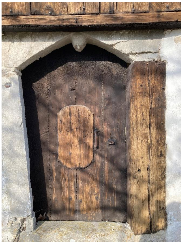
Den södra stigluckans södra sida. Till höger en ekstolpe som ersatt tidigare kalkstensstolpe. Dörrens övre omramning består av ett enda tympanonblock i vars triangelspets det sitter ett manshuvud. Foto ES 2022.
