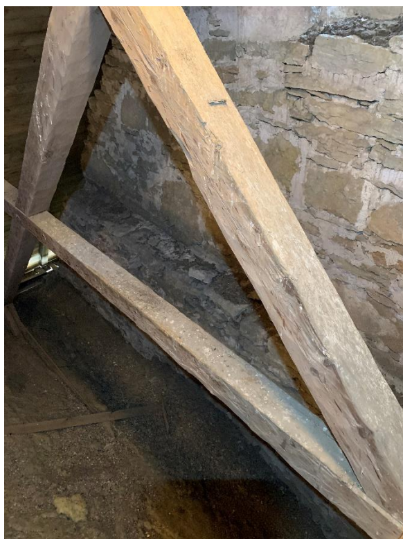
Korets östra gavelsöte mot nordöst med infällda större stenblock, kanske återanvända från en tidigare murad kyrka. Till höger glugg i korets östra gavel. Foto JL 2022.
