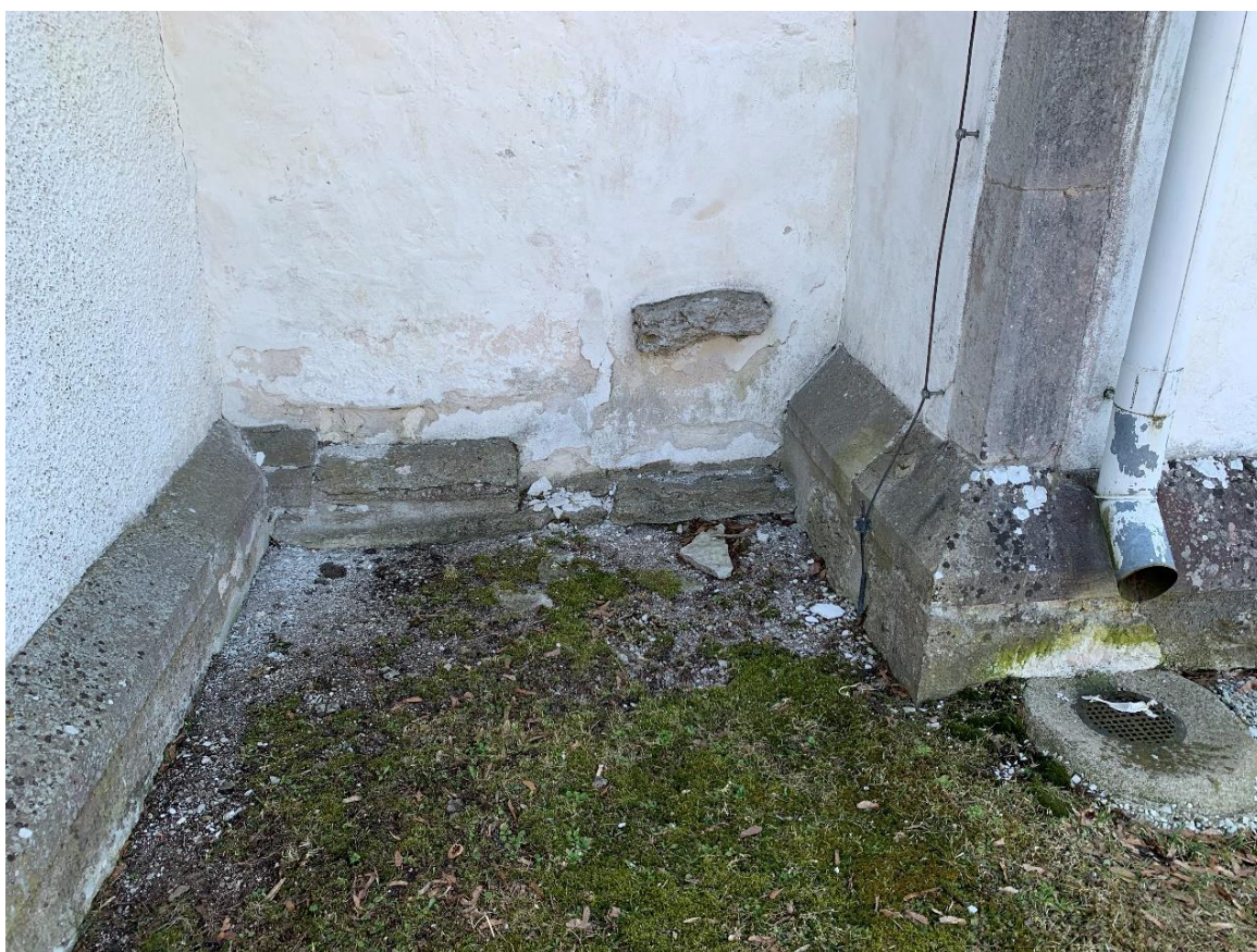
Norra hörnet mellan sakristian, koret och långhuset med förtagningsstenar och avbrott på sockeln. Sakristian till vänster har spritputs. Foto JL 2022.
