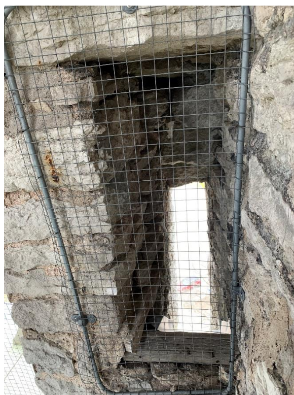
Sjätte övervåningen med de mellersta ljudgluggarna mot söder samt spaltformad glugg med starkt sluttande botten, kanske för lina från marken för ringning eller hissanordning. Foto JL 2022.
