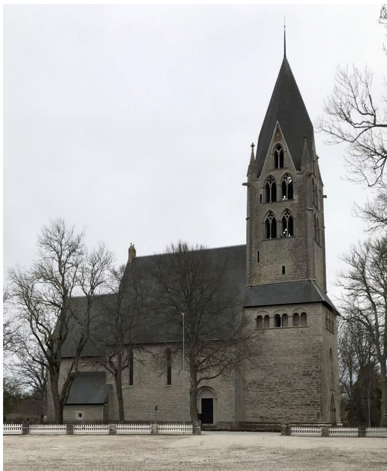
Exteriör från nordväst. Foto JL 2022.
