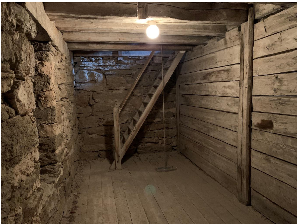
Tornets andra övervåning, södra rummet sett mot väster med trappa vidare upp i tornet. Till höger den skiftesverksvägg utan dörröppning vilken skiljer rummen åt. Foto JL 2022.
