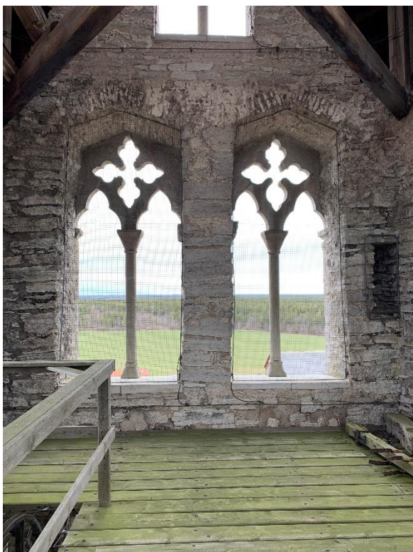
Sjätte övervåningen med de mellersta ljudgluggarna mot söder samt spaltformad glugg med starkt sluttande botten, kanske för lina från marken för ringning eller hissanordning. Foto JL 2022.
