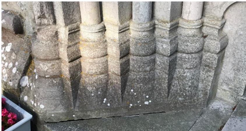
Sockel i norra hörnet mellan långhus och torn. Nedan tornets nedre del sedd från nordväst. Foto JL 2020 och 2022.
