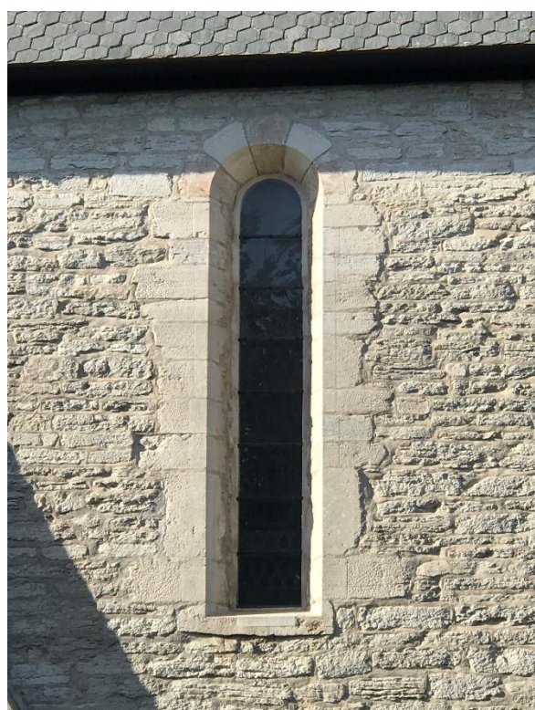
Långhusets sydvästra och sydöstra fönster. Foto JL 2020.
