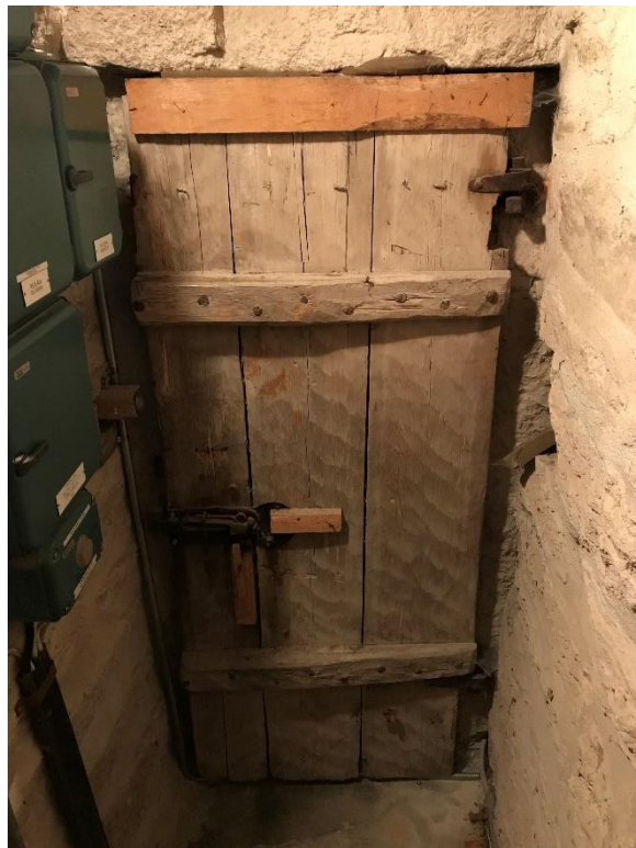
Uppgång till tornet. Foto JL 2020. Till höger torndörren inifrån med bilade bräder. En skjutbar bom kan tillsluta dörren inifrån. Foto JL 2022.
