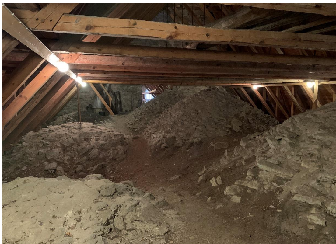
Långhusvinden mot öster med valvens ovansida. Foto JL 2022.
