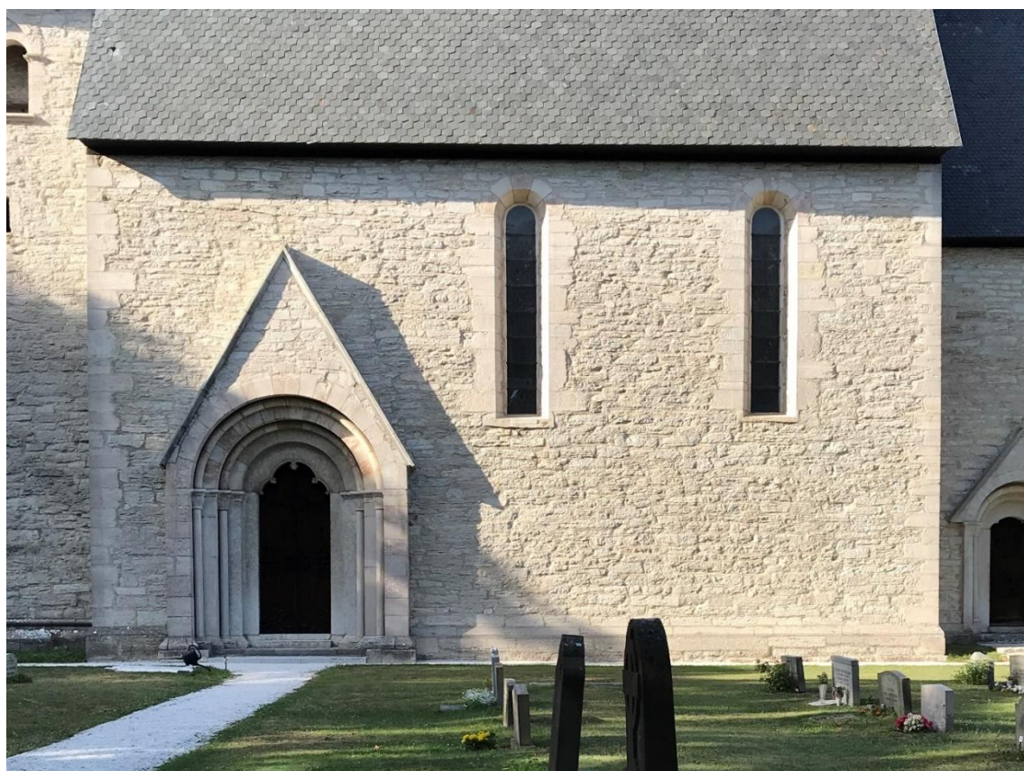
Långhusetets södra fasad. Foto JL 2020.
