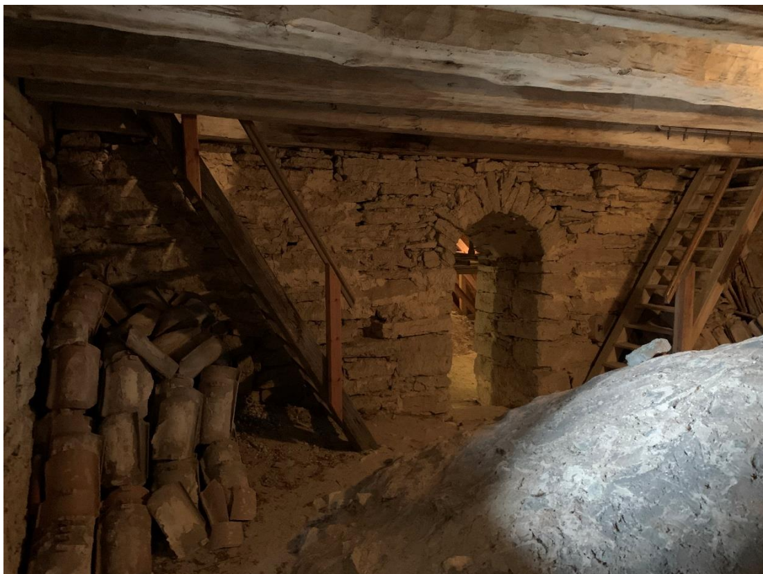
Tornets första övervåning mot öster. Ingången leder till långhusvinden. Trappan till vänster går upp till slutet magasinrum, den till höger går vidare upp i tornet. Det staplade teglet härrör från galleriets tidigare takmaterial. Foto JL 2022.
