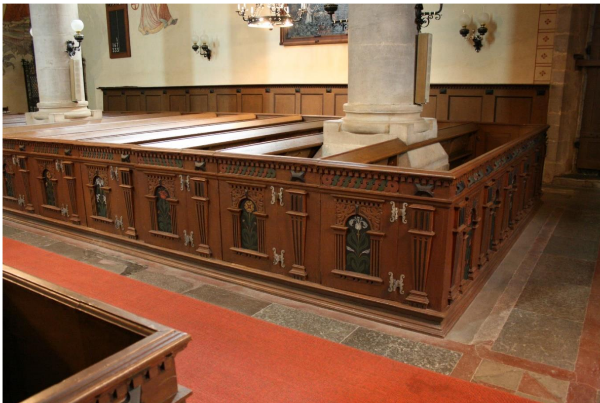
Långhusets södra bänkkvarter, från 1600-talet, kompletterat och målat omkring 1900. Väggskrämen på muren hämtad från ett äldre bänkkvarter. Foto Rebecka Svensson 2006, Visby stift.
