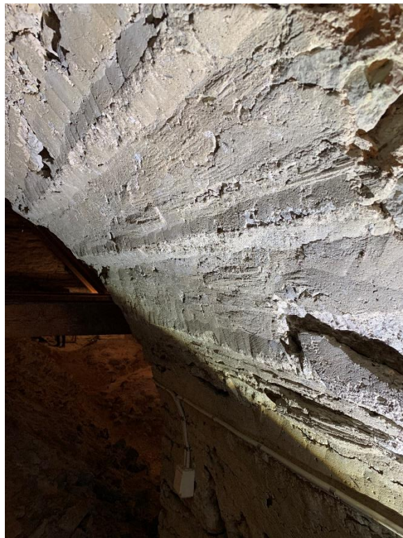
Bågöppning mellan långhusvinden och korvinden sedd mot väster från koret. Till höger detalj av bågens norra del med avtryck av skälbräder med fasad kant. Foto JL 2022.
