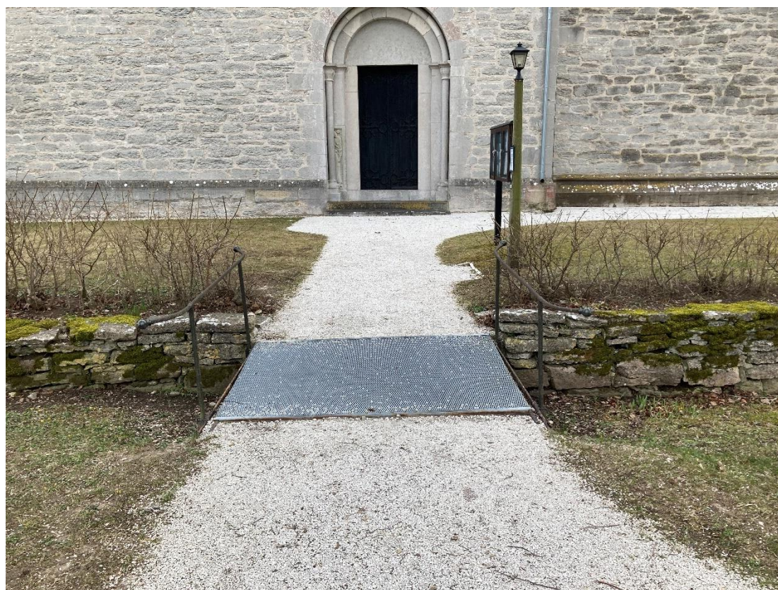
Den norra ingången med handledare i järn. Foto ES 2022.
