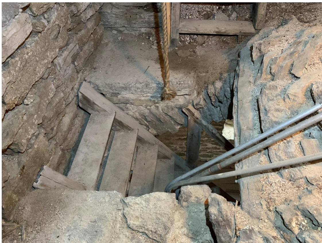
Ursprungligt hål för steg genom valvet upp till tornets låga fjärde övervåning mellan valvet och klockvåningen, sett mot norr. Foto JL 2022.
