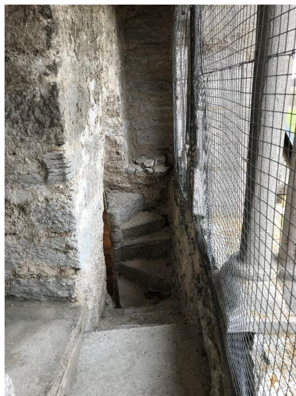
Spiraltrappan i tornets södra mur. Till höger trappans mynning i södra galleriets östra del. Foto JL 2022.
