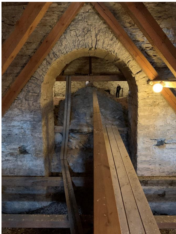
Bågöppning mellan långhusvinden och korvinden sedd mot väster från koret. Till höger detalj av bågens norra del med avtryck av skälbräder med fasad kant. Foto JL 2022.
