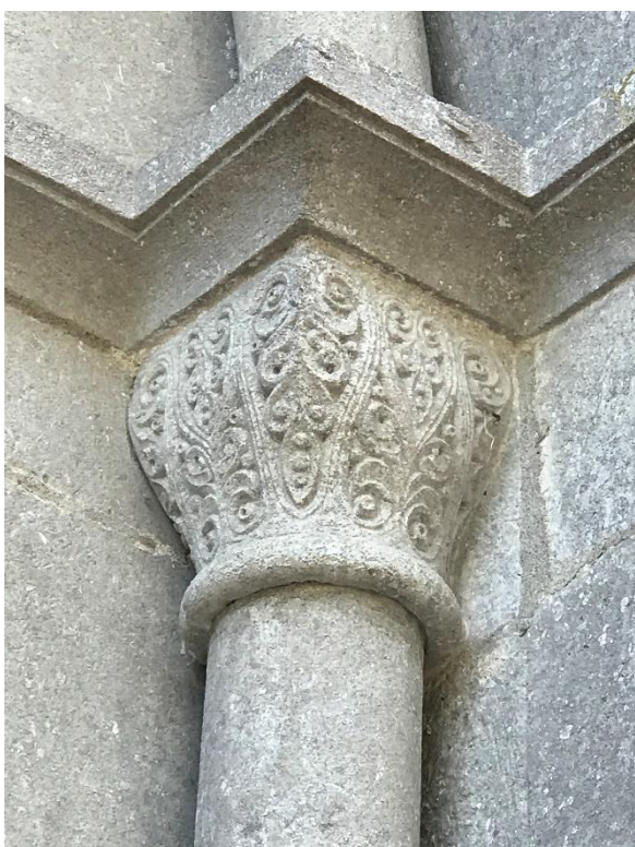
Långhusportalens västra kapitäl samt västra bas. Foto JL 2020.
