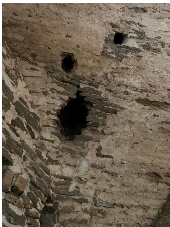
Hål i sydöstra delen av valvet över tornets tredje övervåning, sett nedifrån och ovanifrån med träkonstruktion. Foto JL 2022.
