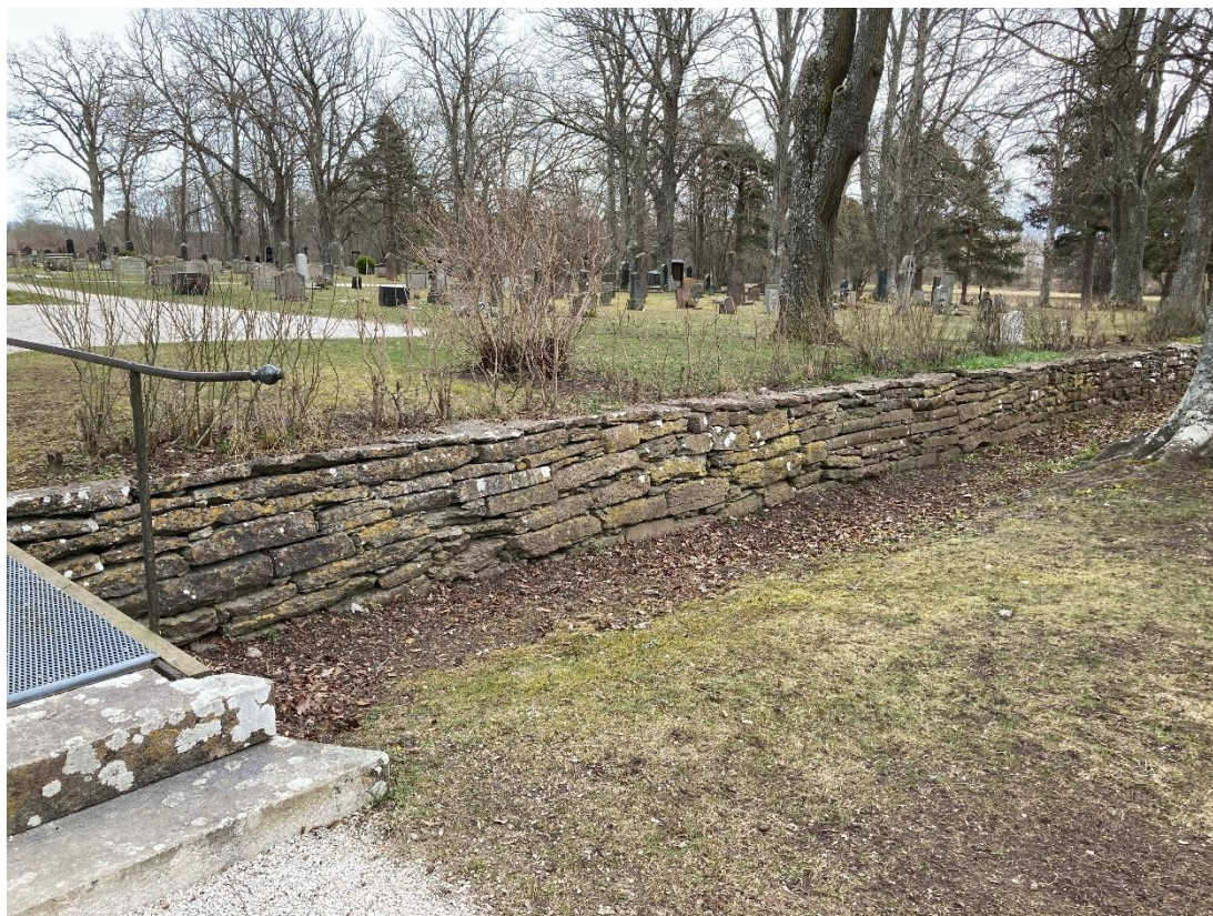
Den västra terrassmuren. Foto ES 2022.
