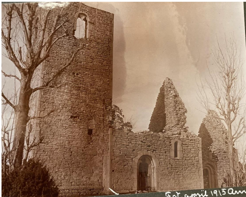
Exteriör från sydväst. Foto Ture Arne 1915, ATA. Rester av puts syns i hörnet mellan torn och långhus samt på långhusets nedre del.
