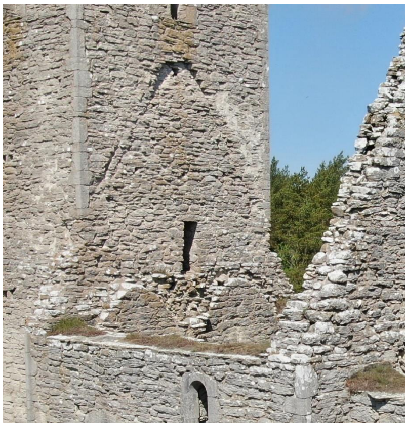
Tornets östmur samt rester av långhusvalven, sedda mot väster. Foto JL 2022. Till vänster långhusets västra gavelmur med rester av valvslagningen. Sköldmurarna med deras upplag för valven väl synliga. Foto Pär Malmros 2021, Visby stift.
