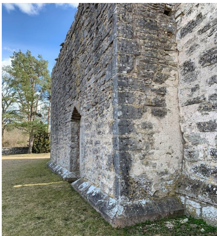
Långhusets nordfasad och nordvästra hörn. Foto JL 2022.
