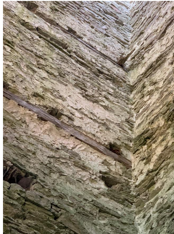
Trappmyrning ovanför tornvalvet. Till höger detalj av murverket i tornets övervåning visande kvarsittande ursprungligt trävirke vilket visar att kyrkan inte har brunnit. Foto JL 2022.
