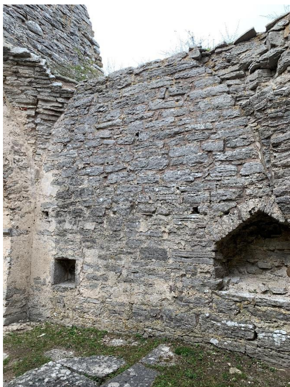
Korets norra mur och nordöstra hörn. Resterna av den breda tunnvalvda delen av valvet närmast östra muren framgår. Foto JL 2022.
