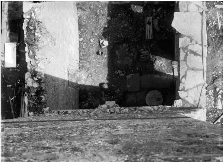
Bilder från konserveringen 1924. Ovan till vänster avtäckning med betong i tornkrönets sydvästra del. Ovan till höger murningsarbete i östra ljudgluggen. Till vänster blick nedåt från östra ljudgluggen utan respektive med avtäckning med hällar på långhusmurarnas krön. Foto Alfred Edle 1924, ATA.
