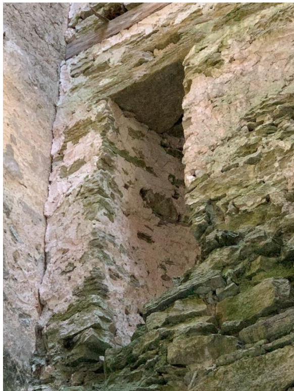
Trappmyrning ovanför tornvalvet. Till höger detalj av murverket i tornets övervåning visande kvarsittande ursprungligt trävirke vilket visar att kyrkan inte har brunnit. Foto JL 2022.
