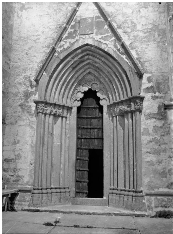
Korportalen före restaureringen 1891 med äldre dörr samt murverkets karaktär innan det putsades över 1955. Foto Olof Sörling ca 1890, ATA. Till höger fragment av relief visande en Tronande Kristus, sannolikt från vimpergen i korportalen eller södra långhusportalen. Foto Hanna Hermansson 1999–2001, Kyrkoinventeringen.
