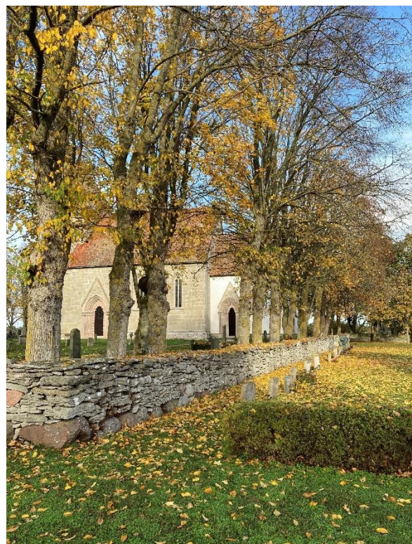
Den östra mursträckningen kring den äldre kyrkogården fotograferad från sydost. Foto ES 2022.
