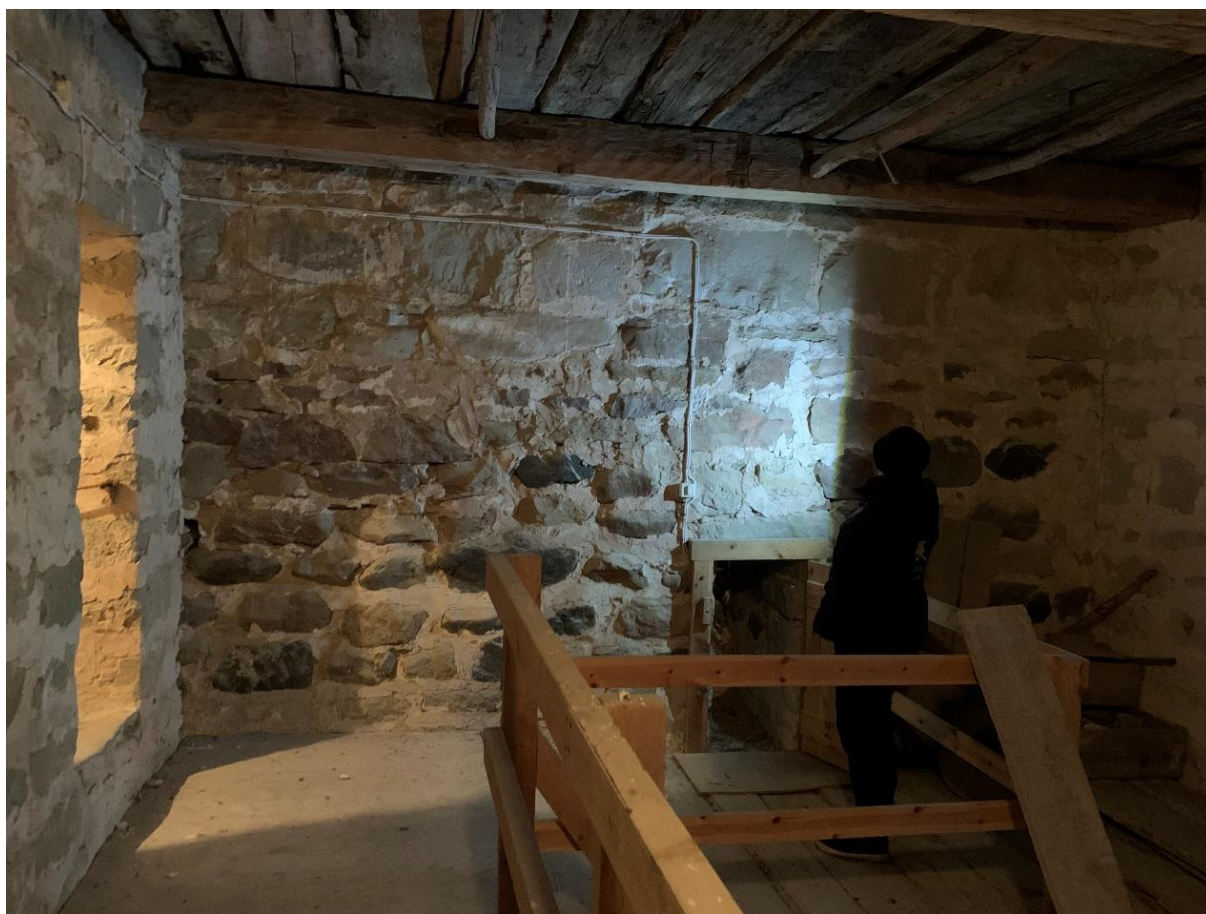
Tornets andra övervåning mot öster med ingång till långhusvinden. Murverket i fonden hör till det äldre långhusets västgavel. Foto JL 2022.
