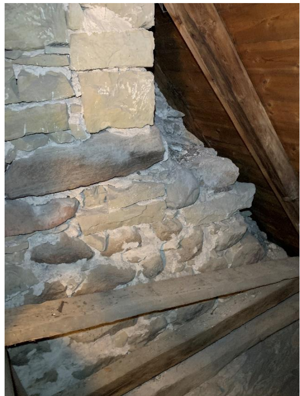
Del av triumfbågmurens norra del mot korvinden med rester av bjälkar. Till höger del av korets östra gavelröstes södra del. Foto JL 2022.
