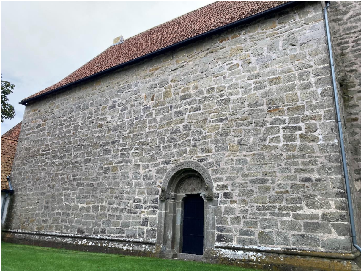
Långhusets nordfasad. Foto JL 2023.
