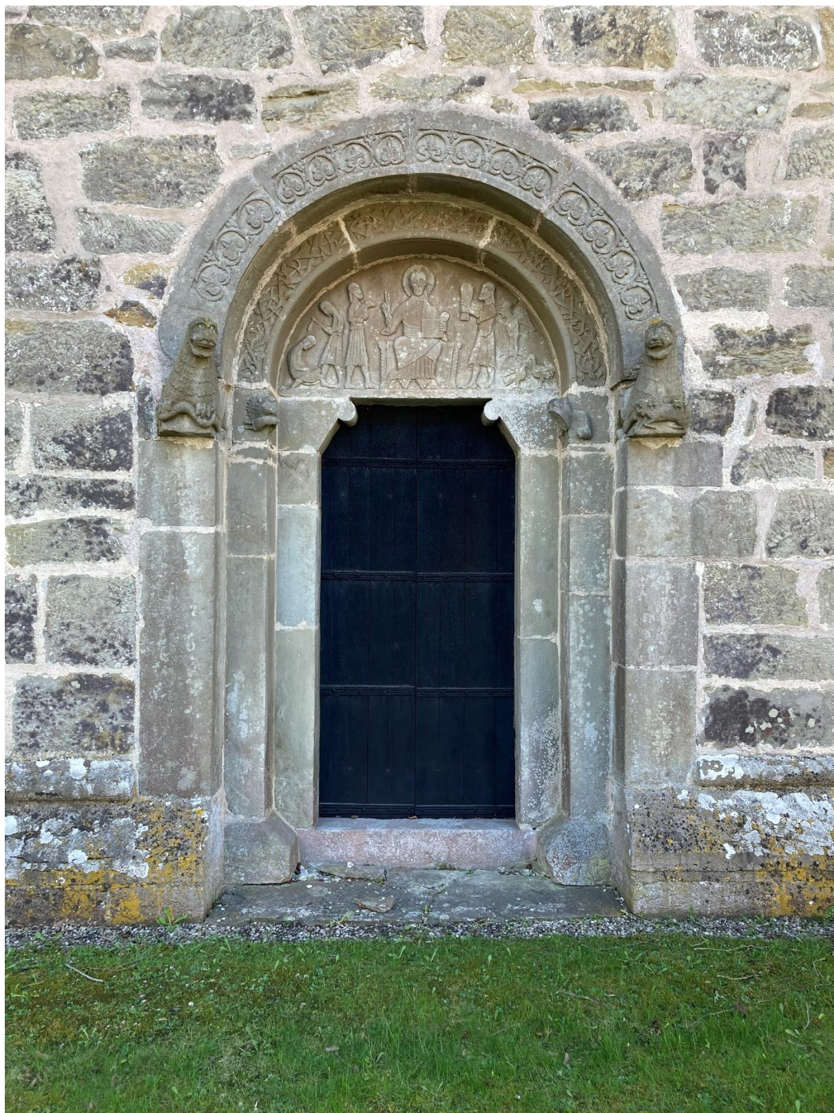
Nordportalen. Foto JL 2023.
