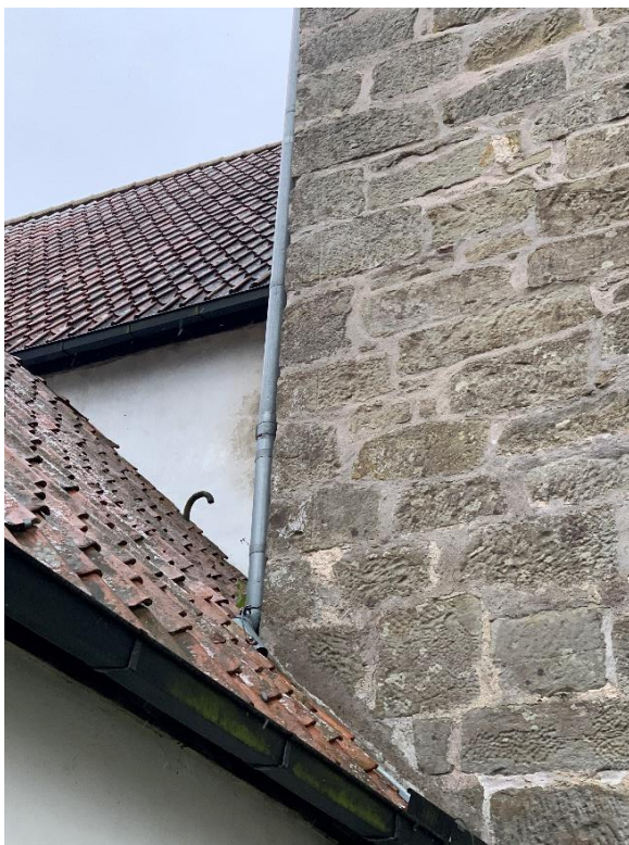
Långhusets nordöstra hörn med spår av putsrand, vilket visar att fasaden var avsedd att putsas. Till höger långhusets nordportal sedd från nordväst. Foto JL 2022 respektive 2023.
