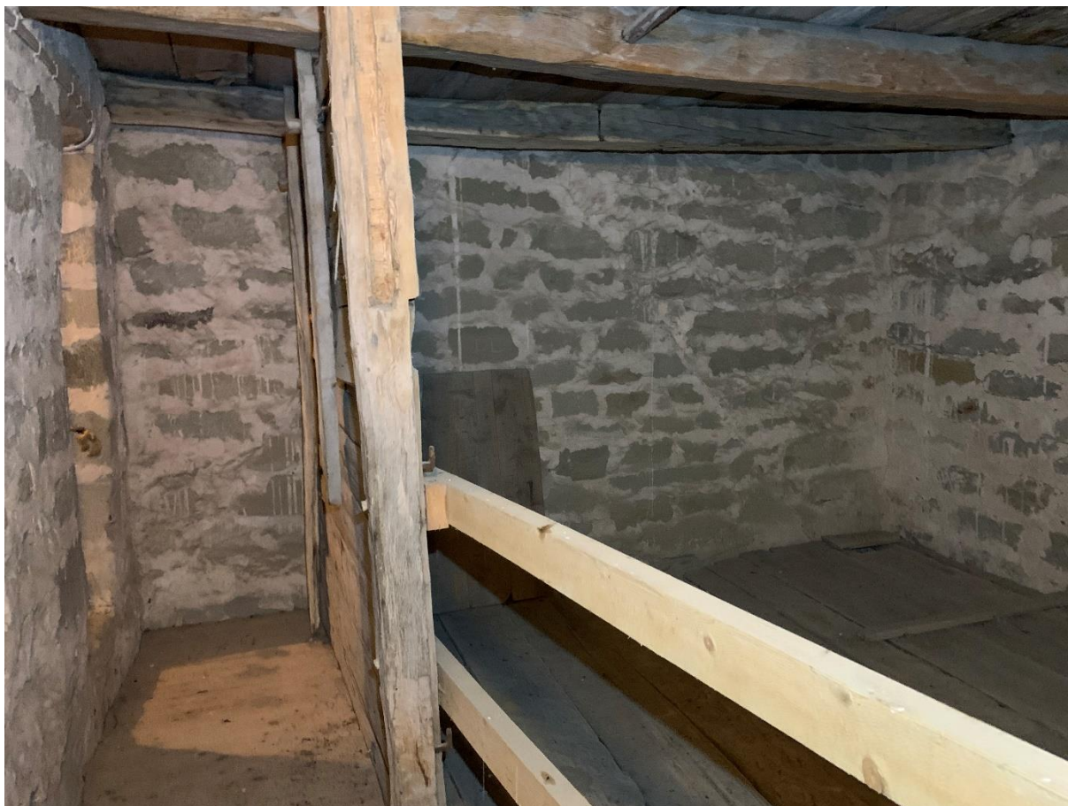
Tornets tredje övervåning mot öster med det äldre långhusets gavelröste synligt i murverket. Foto JL 2022.
