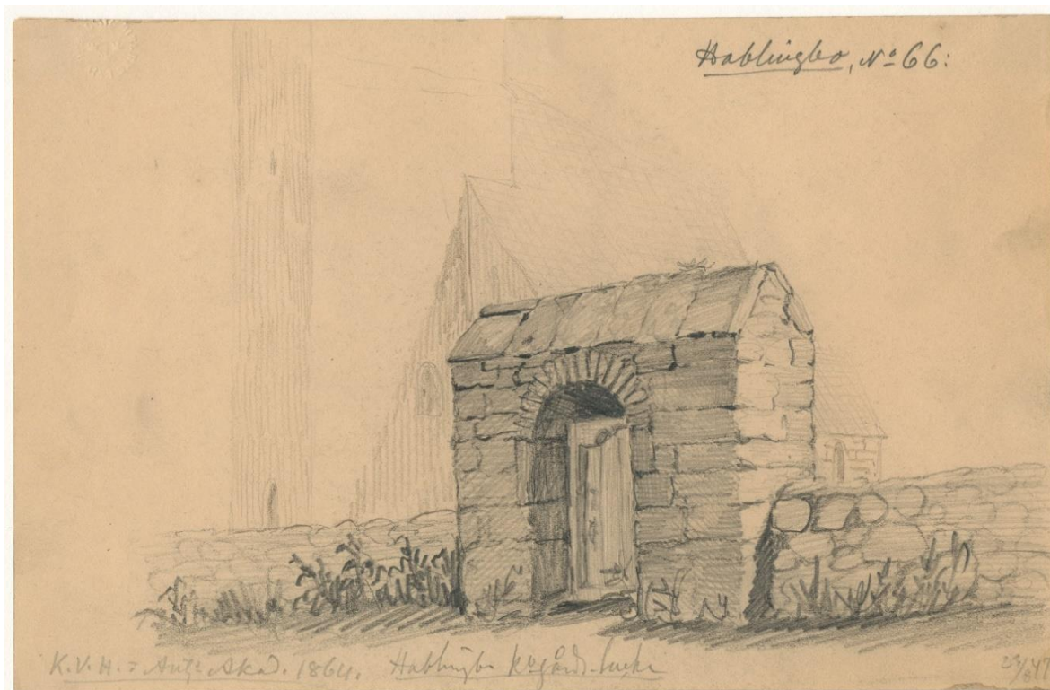
Den medeltida stigluckan i västra mursträckningen vilken var en genomgång mellan prästgården och kyrkan. Stigluckan var uppbyggd i sandsten med liknande utformning som flera stigluckor på södra Gotland, t.ex. Havdhem, Fide och Grötlingbo. Stigluckan revs omkring 1860. Teckning av Per Arvid Säve 1858. Alvin, UUB.
