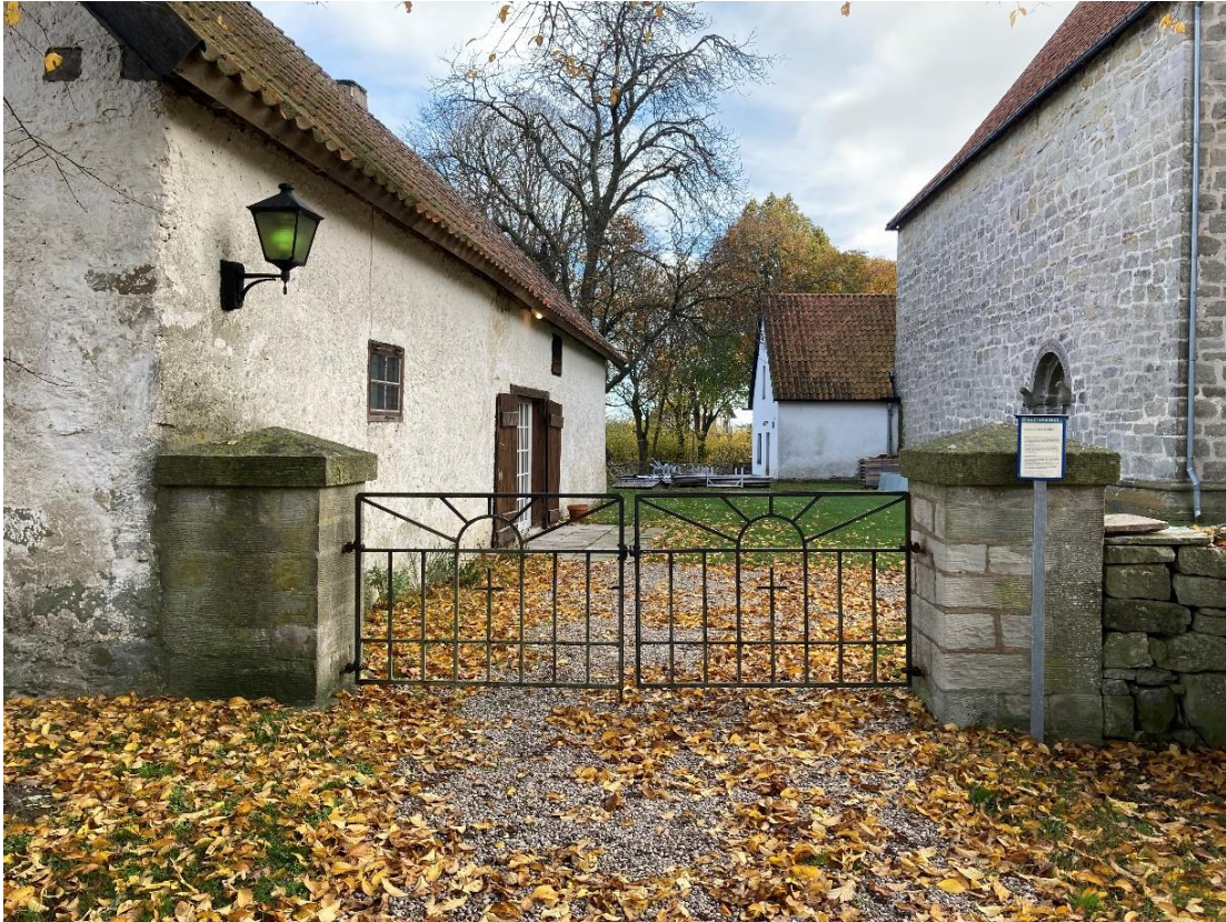
Ingången med pargrind i svartmålat smidesjärn och murade stolpar. Till vänster, syns det tidigare sockenmagasinet. Foto ES 2022.
