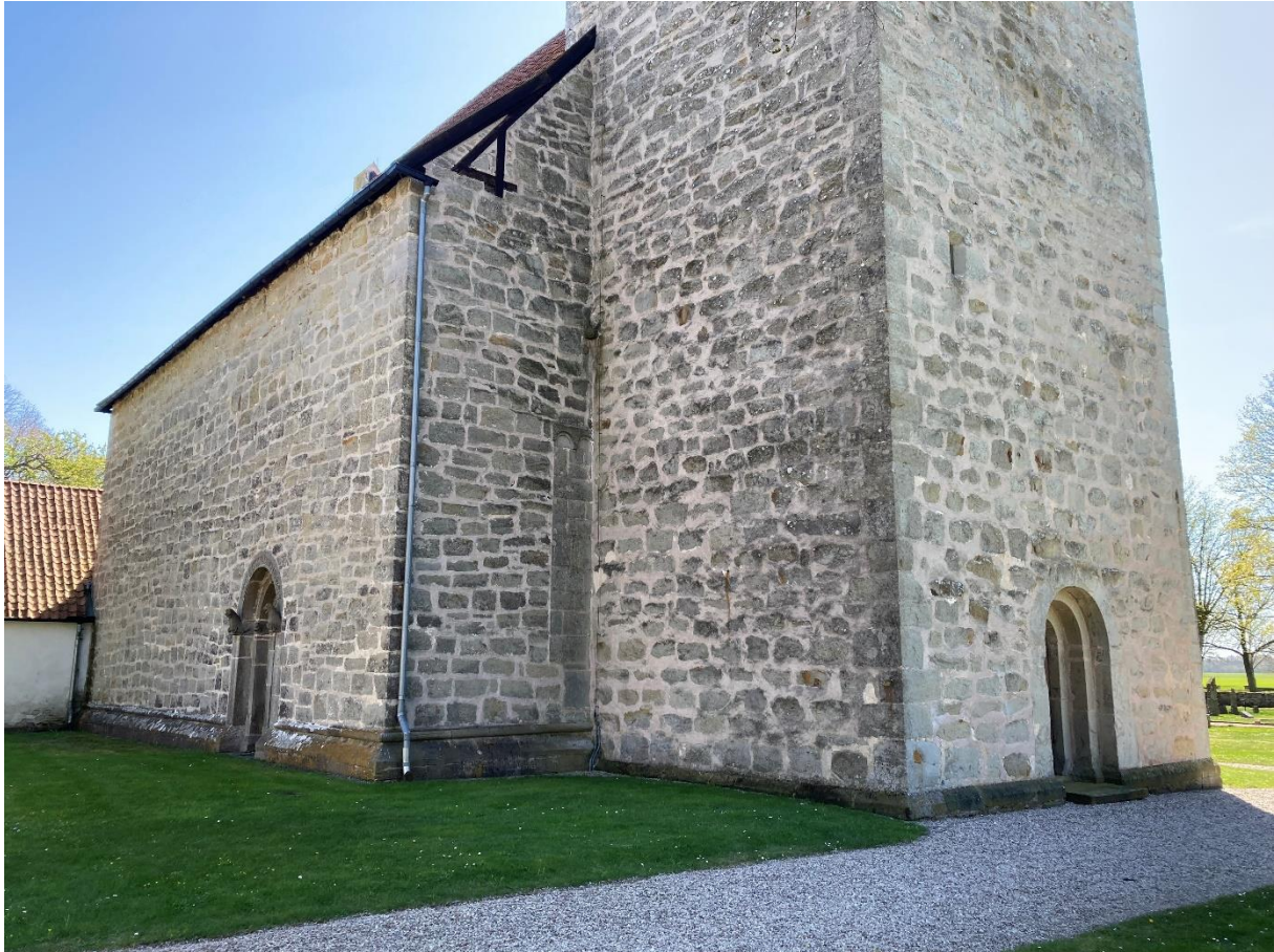
Långhuset och tornets nedre del från nordväst. Foto JL 2023.
