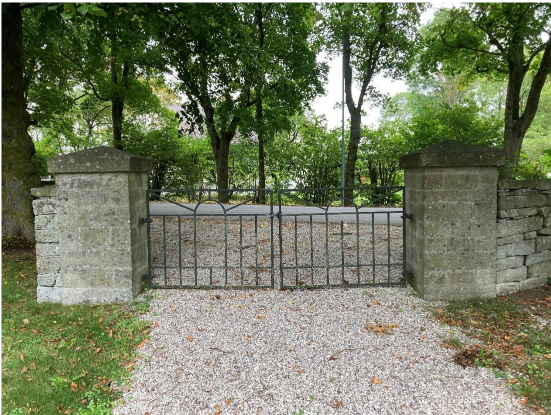
Ingång i norr till den yngre kyrkogården. En dubbel järngrind flankeras av putsade fyrkantiga stolpar med pyramidformade överliggare. Foto ES 2023.
