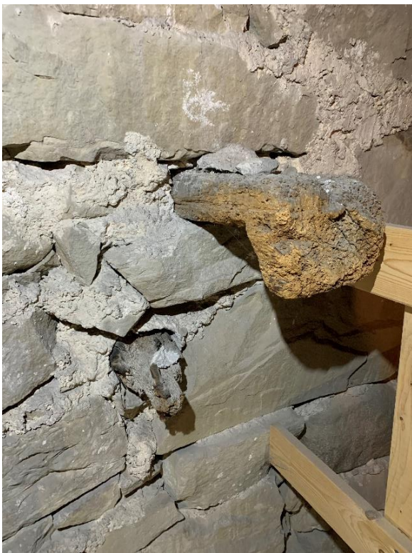
Del av triumfbågmurens norra del mot korvinden med rester av bjälkar. Till höger del av korets östra gavelröstes södra del. Foto JL 2022.
