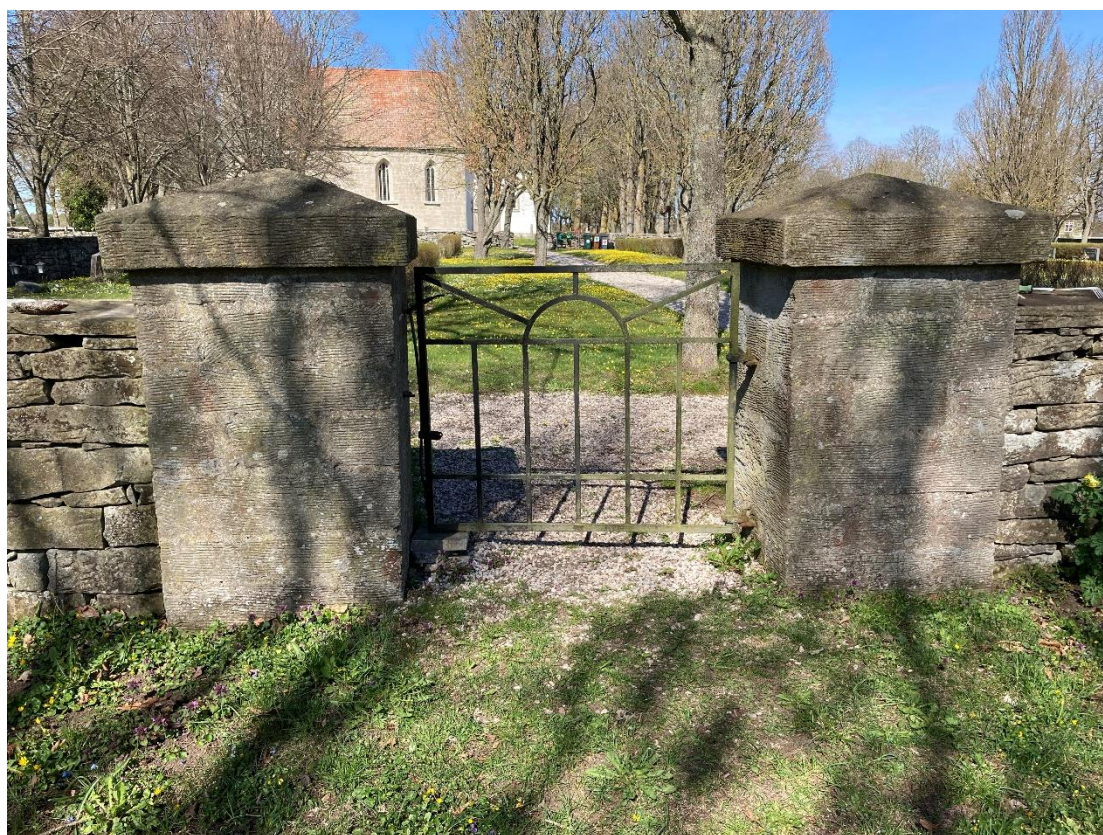
Ingång till den yngre kyrkogården från söder. En enkel järngrind flankeras av putsade fyrkantiga stolpar med pyramidformade överliggare. Foto ES 2022.
