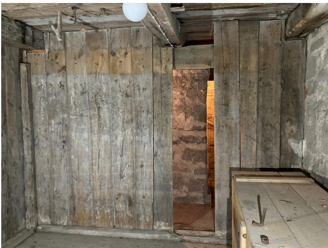
Kammaren i tornets första övervåning mot norr. Foto JL 2023.
