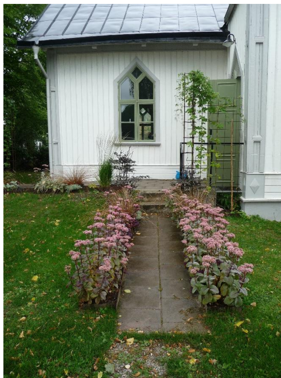
Ingången från söder är belagd med cementplattor och kantas av rabatter. Foto ES 2020.
