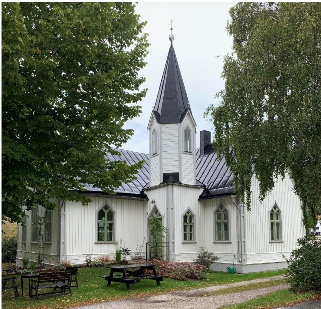
Exteriör från sydväst. Foto JL 2020.
