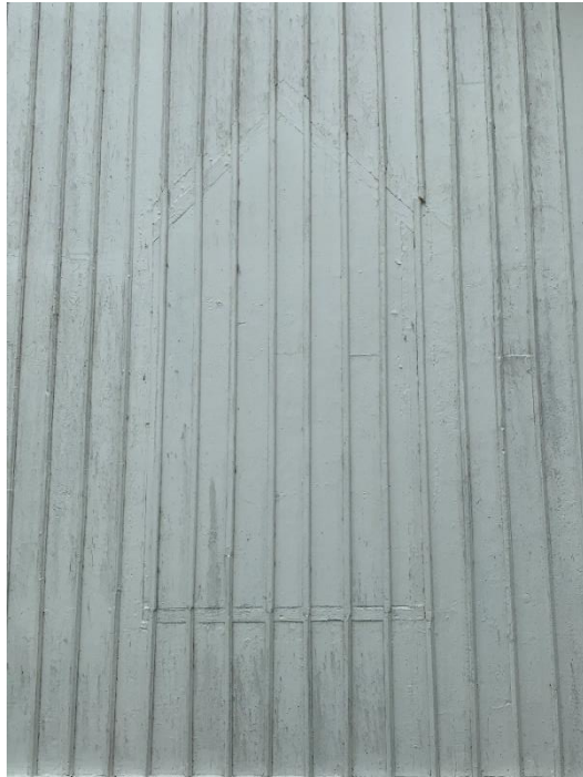
Spår av igensatta fönster på östgaveln, t.h. fönstret längst åt norr. Foto JL 2020.
