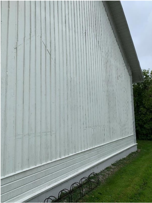
Spår av igensatta fönster på östgaveln, t.h. fönstret längst åt norr. Foto JL 2020.
