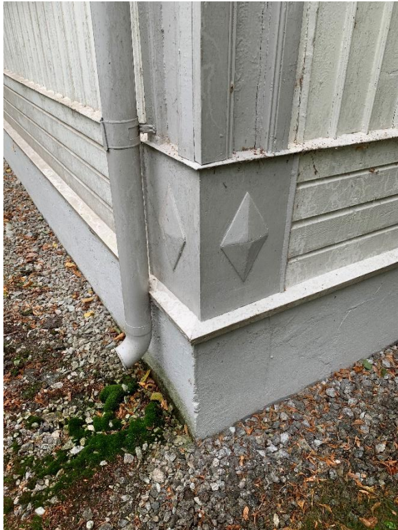
Nordvästra hörnet. Panelens nedre del och sockelmur. T.h. del av nordfasaden med ingång från norr. Foto JL 2020.
