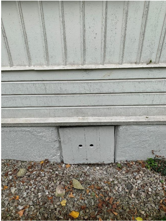
Inspektionsslucka till grunden, i sockenmuren mitt på nordfasaden, samt krypgrundens norra del mot väster. Foto JL 2020.
