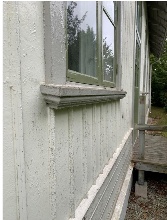
Nordfasaden sedd från öster. Detalj av fönstrens profilerade solbänk. Foto JL 2020.
