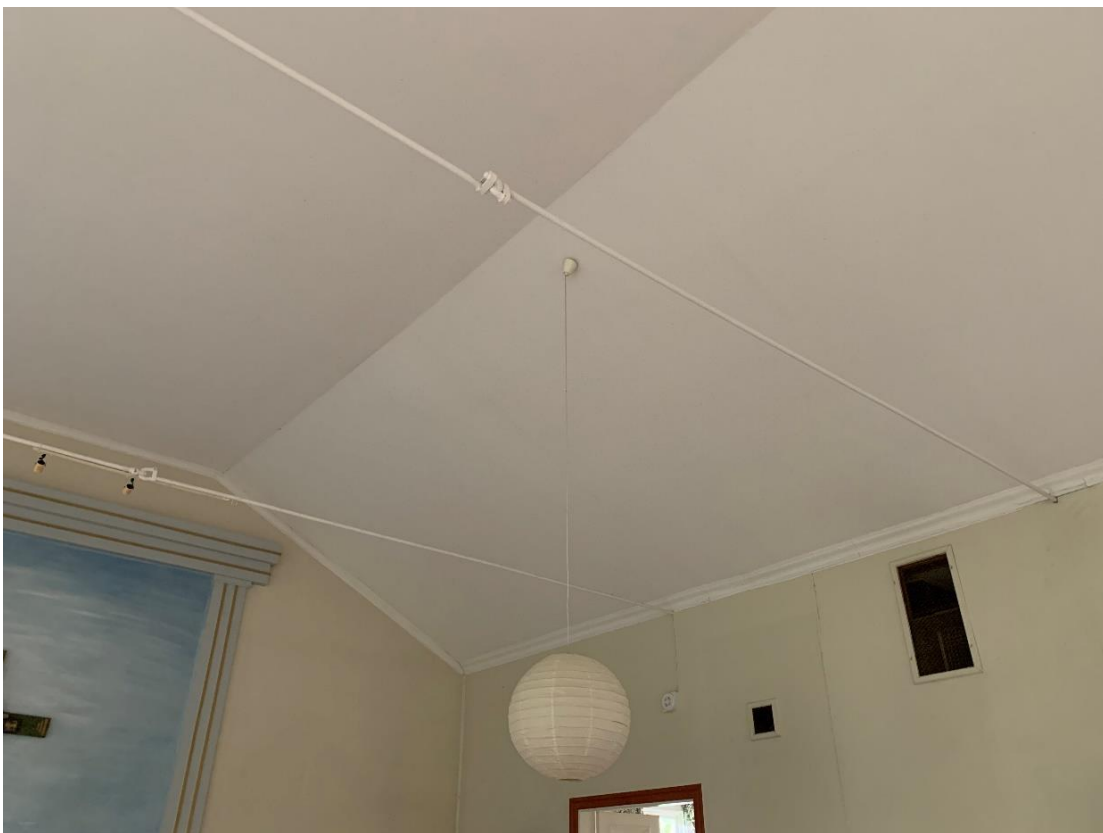
Innertaket, sett mot sydväst. Foto JL 2020.
