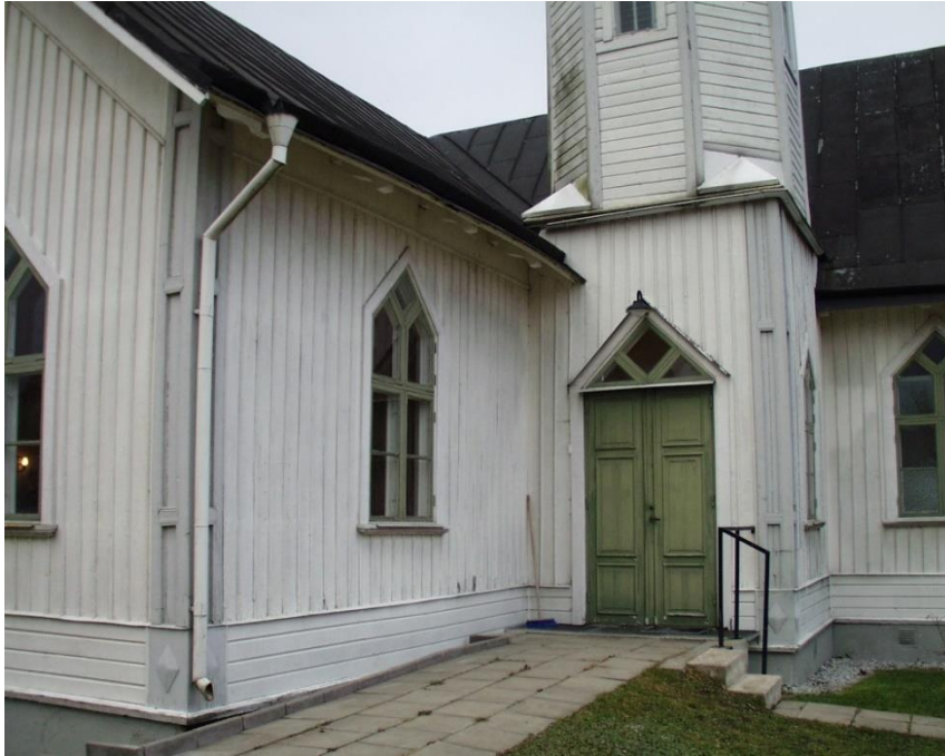
Ovan t.v. exteriör av tornets nedre del från väster, visande hur halvpyramiderna vid övergången från fyrkant till åttkant var målade i väggens ljusa färg liksom på ett av de äldre fotografierna. De är nu svarta. Foto Pär Malmros 2001-02, ur Arbetsbeskrivning för Hamnkyrkan Klinte Robbjäns 1:58 av Stefan Haase och Pär Malmros 2002, Gotlands Museums handlingar.
