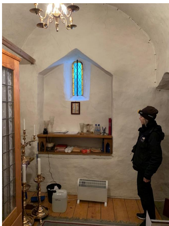
Sakristian mot öster med nisch kring östfönstret. Foto JL 2019.
