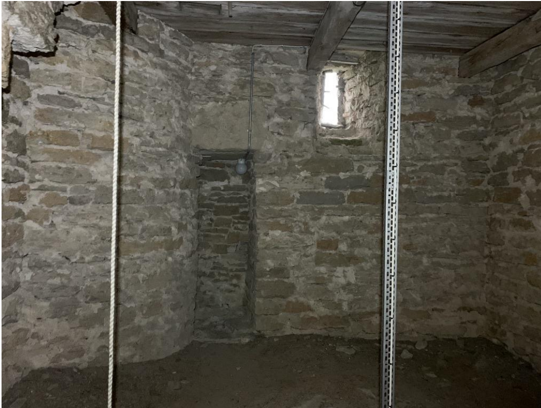
Tornets första övervåning mot väster. Foto JL 2019.
