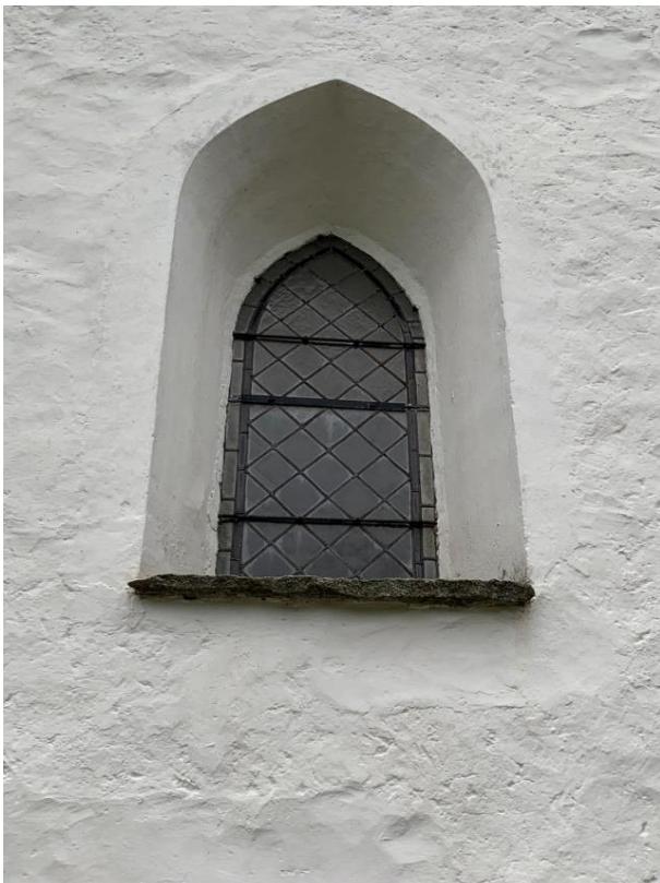
Tornets västra fönster. Foto JL 2019.
