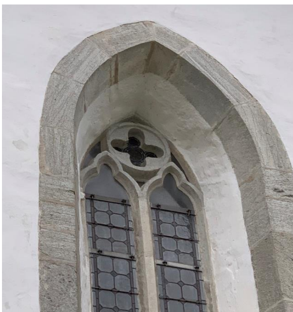
Långhusets södra fönster, masverket. Foto JL 2019.
