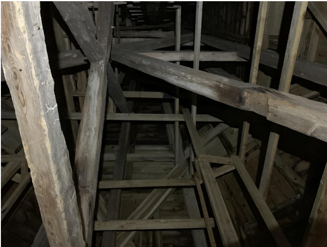
Tornhuvens konstruktion, sedd underifrån. Foto JL 2020.
