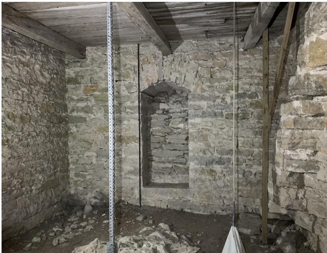
Tornets första övervåning mot öster. Den igenmurade öppningen ledde ursprungligen sannolikt till den äldre stenkyrkans vind. Foto JL 2019.
