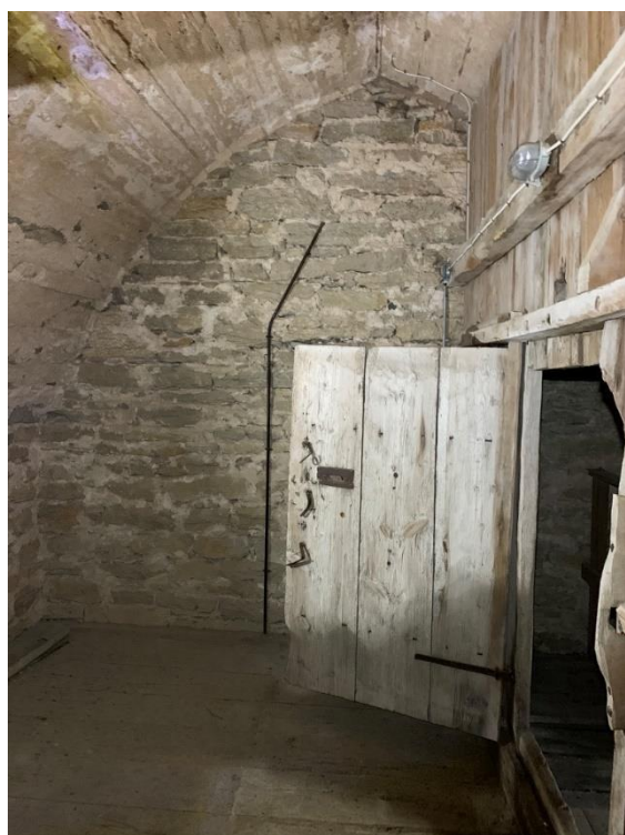
Tornets andra övervåning mot öster. Foto JL 2019.
