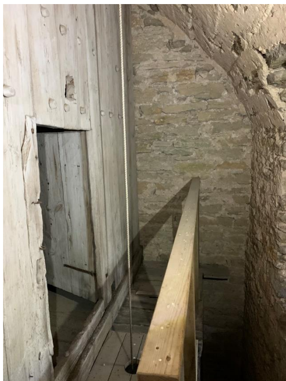
Tornets andra övervåning, dess södra del mot öster. Foto JL 2019.
