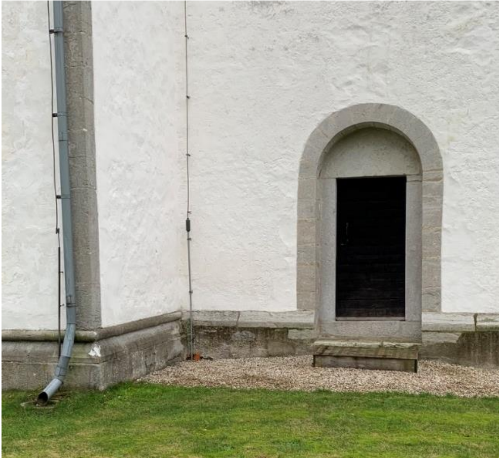
Tornets nordportal. Foto JL 2019.
