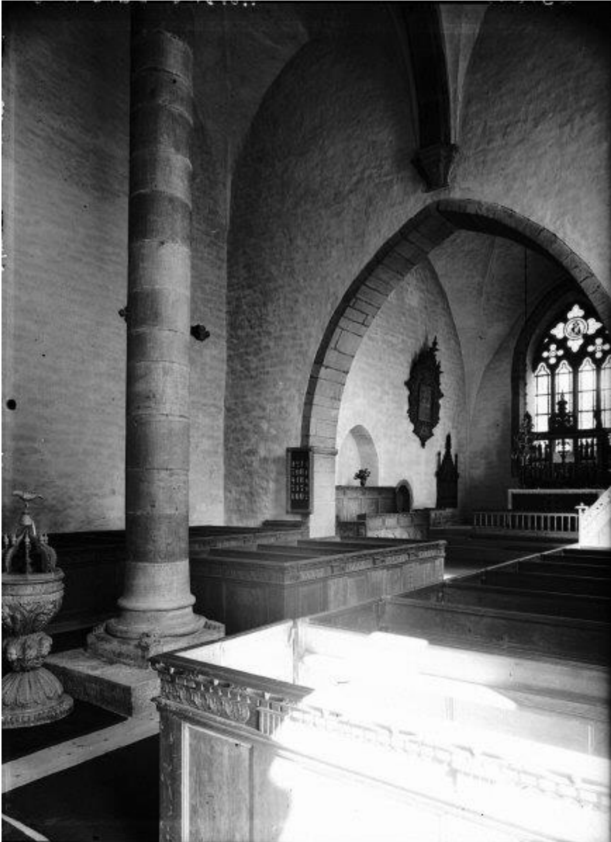
Interiör mot nordöst efter restaureringen 1937-38. Foto Alfred Edle 1945. RAÄ, Kulturmiljöbild.
