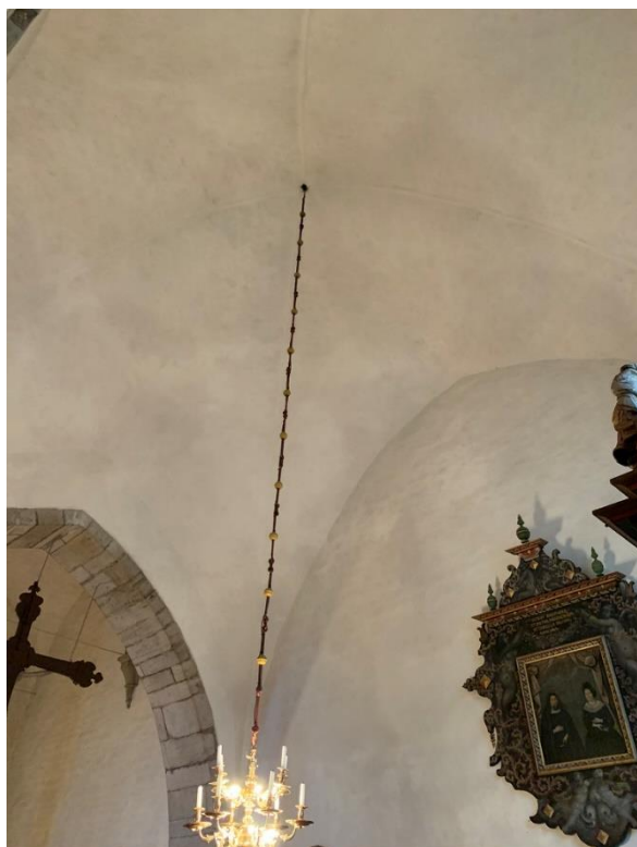
Korets valv sett underifrån mot nordväst. Foto JL 2019.
