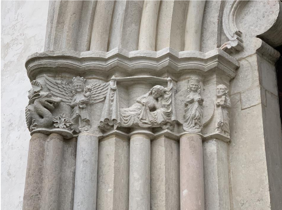
Långhusetportalens västra kapitälband. Foto JL 2019.
