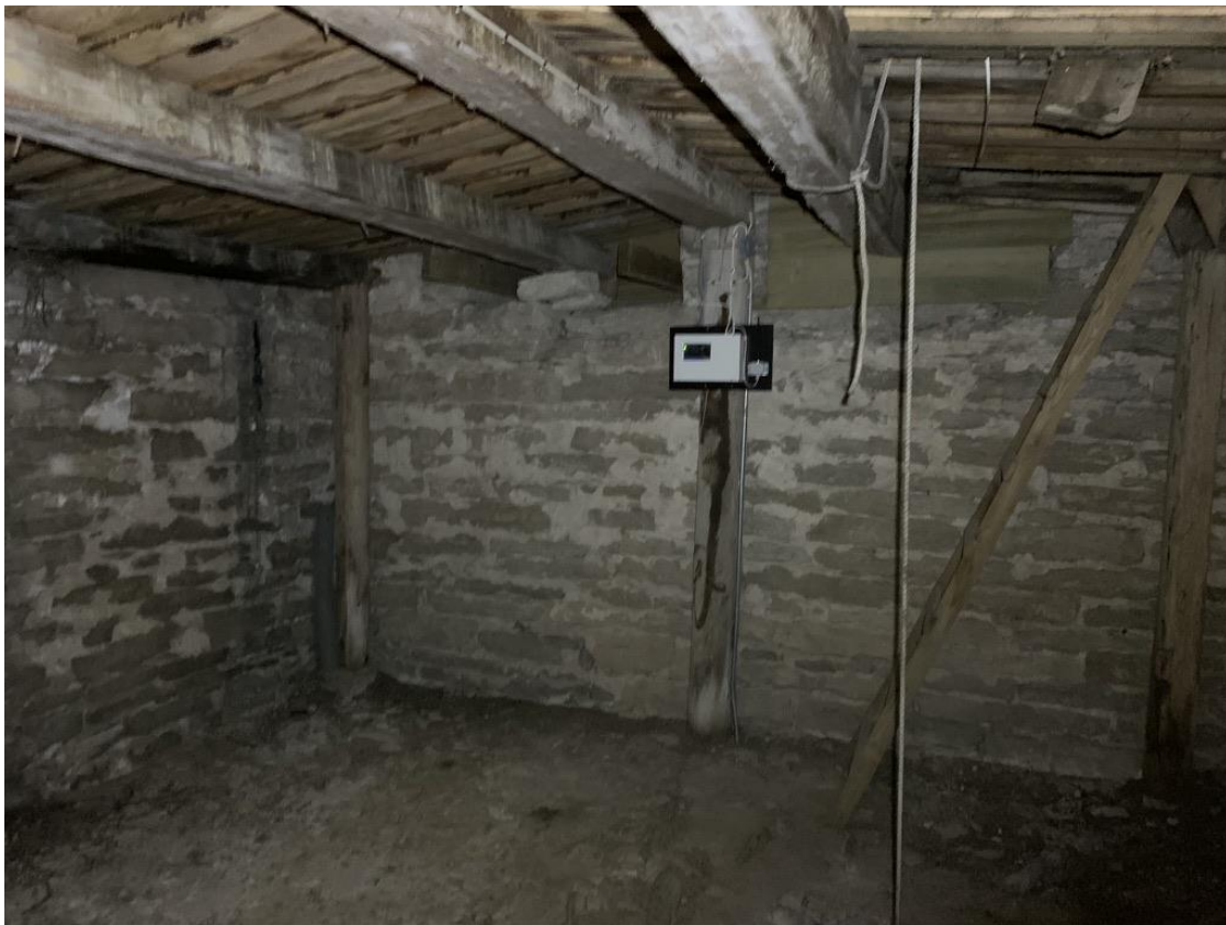
Tornets tredje övervåning sedd mot öster. Foto JL 2019.
