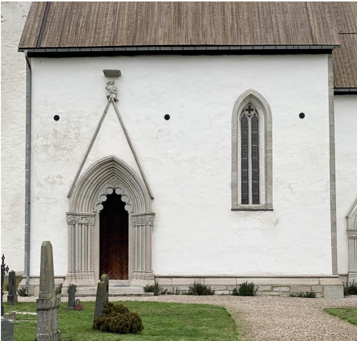
Långhusets södra fasad. Foto JL 2019.
