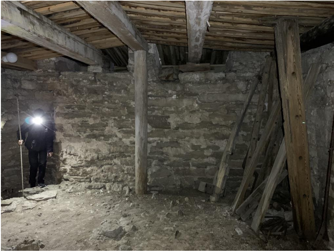
Tornets tredje övervåning sedd mot väster. Foto JL 2019.
