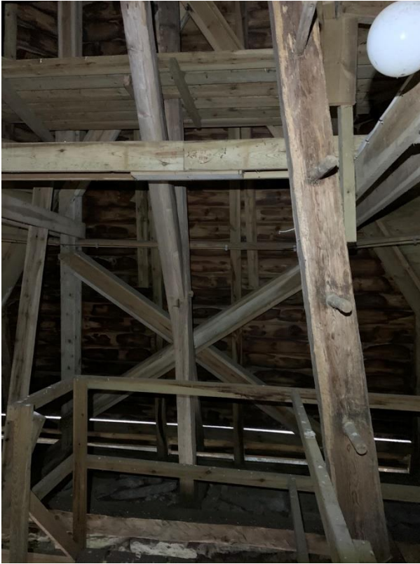
Tornhuvens konstruktion, med bevarade delar till en sannolikt medeltida huv med annan form. Foto JL 2019.
