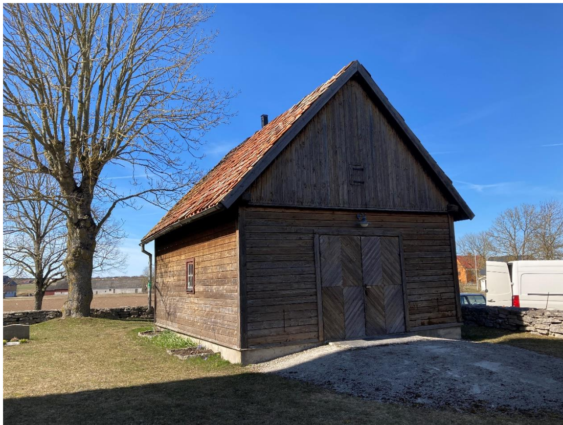
Sockenstuga ursprungligen uppförd omkring 1825, i den nordvästra delen av kyrkogården. Foto ES 2022.
