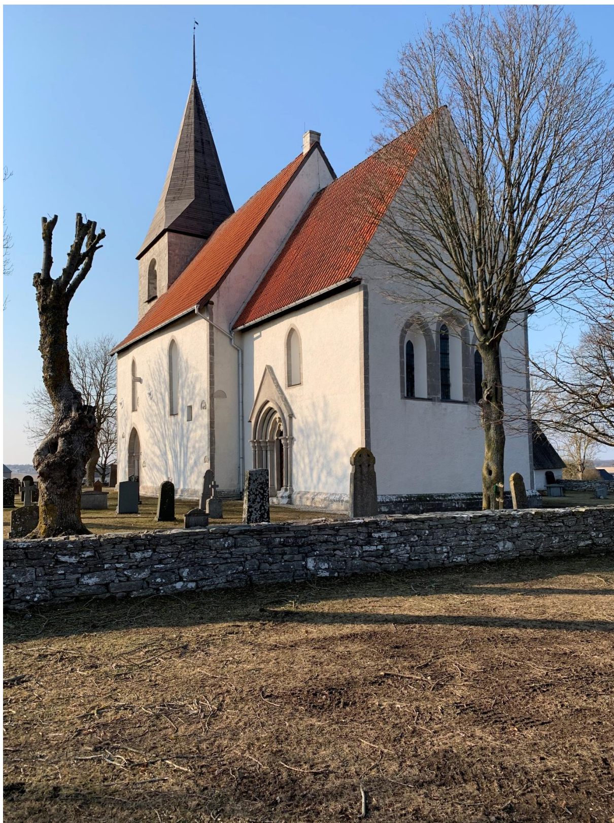
Exteriör från sydöst. Foto JL 2022.
