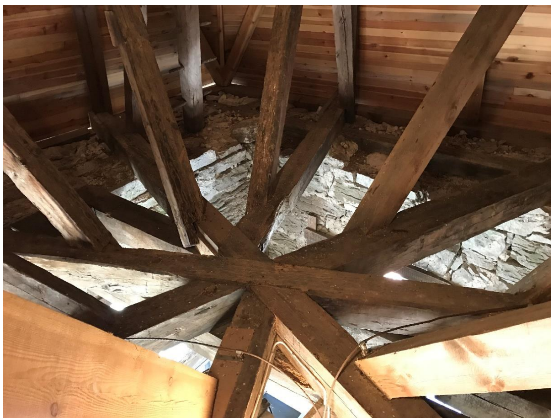
Tornkrönet och tornhuvens bottenbjälklag mot nordväst. Foto JL 2022.
