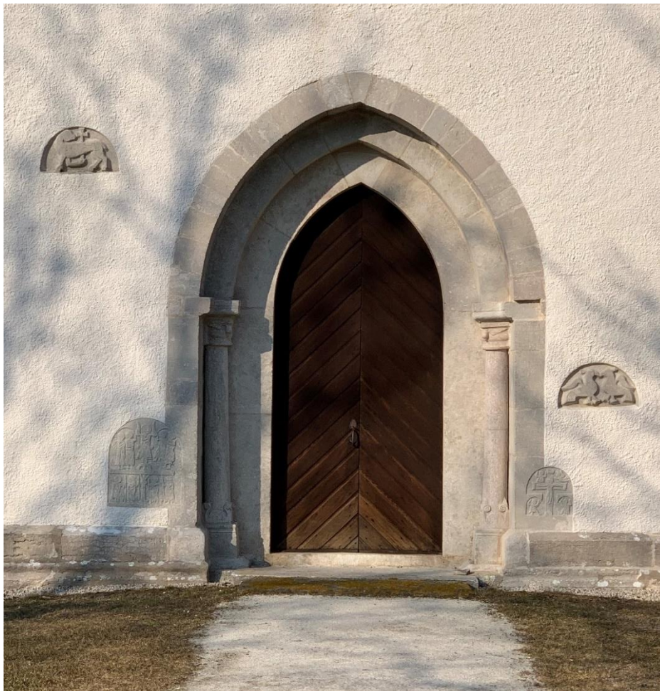
Långhusetets sydportal. Foto JL 2022. Delar av portalens omfattning samt kolonnerterna och deras kapitäl är återanvända från gamla kyrkan, men portalen förstorades och gjordes spetsbågig. Nedan till vänster det östra kapitålet, till höger östra posten.
