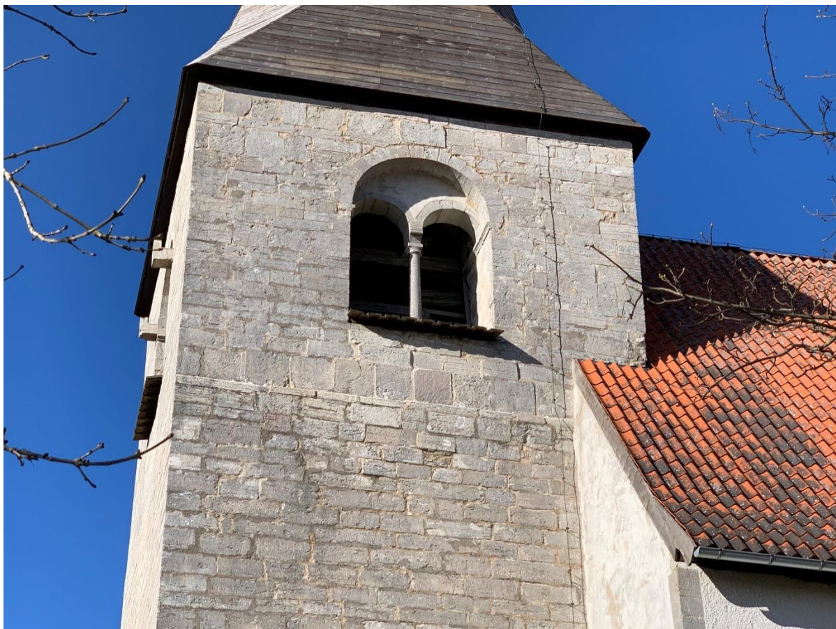
Tornets övre del från söder med större förekomst av kvaderstenar i den övre delen. Foto JL 2022.
