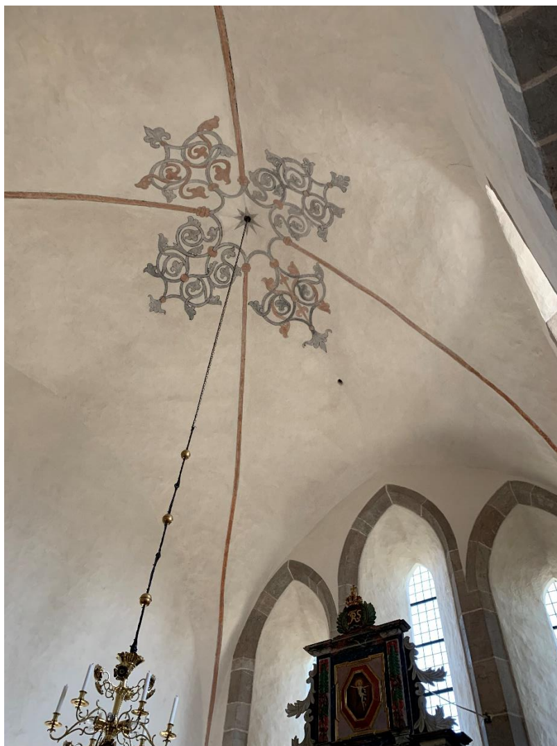
Korets valv sett underifrån mot nordöst med kalkmålning från byggnadstiden samt hål (ljudkruka?) ovanför altare. Nedan interiör av långhuset mot söder. Foto JL 2022.
