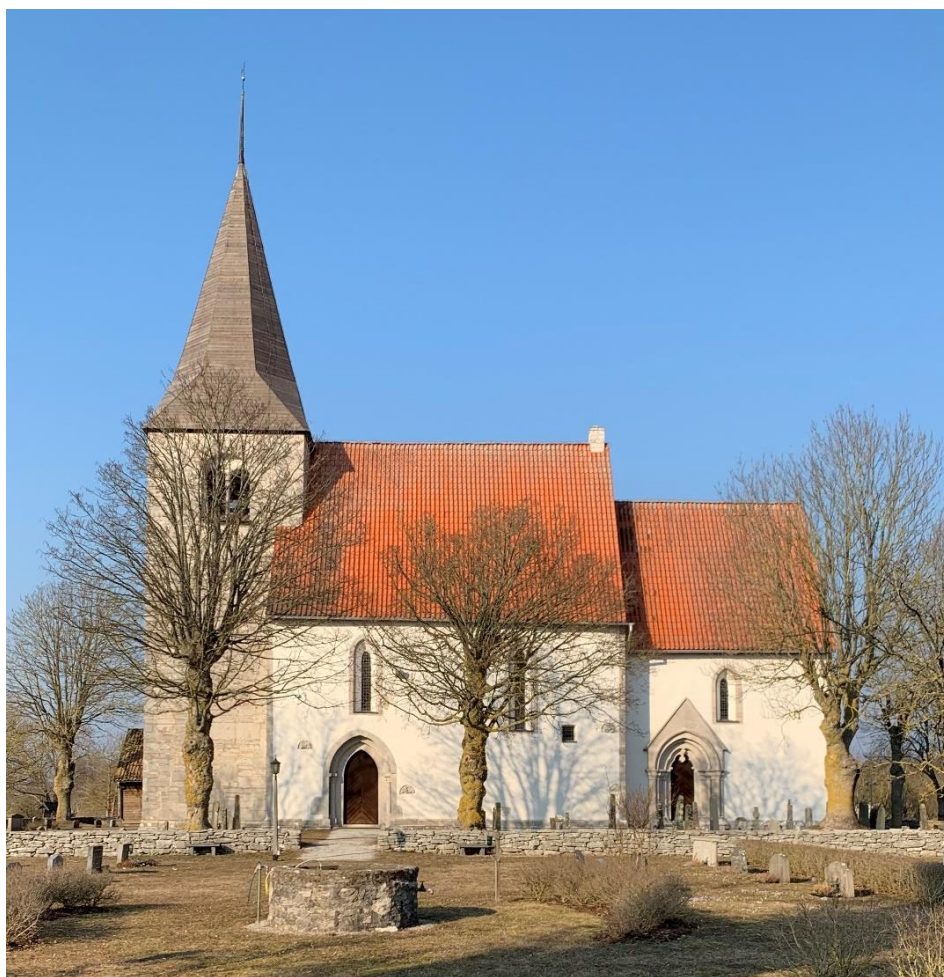
Exteriör från söder. Foto JL 2022.
