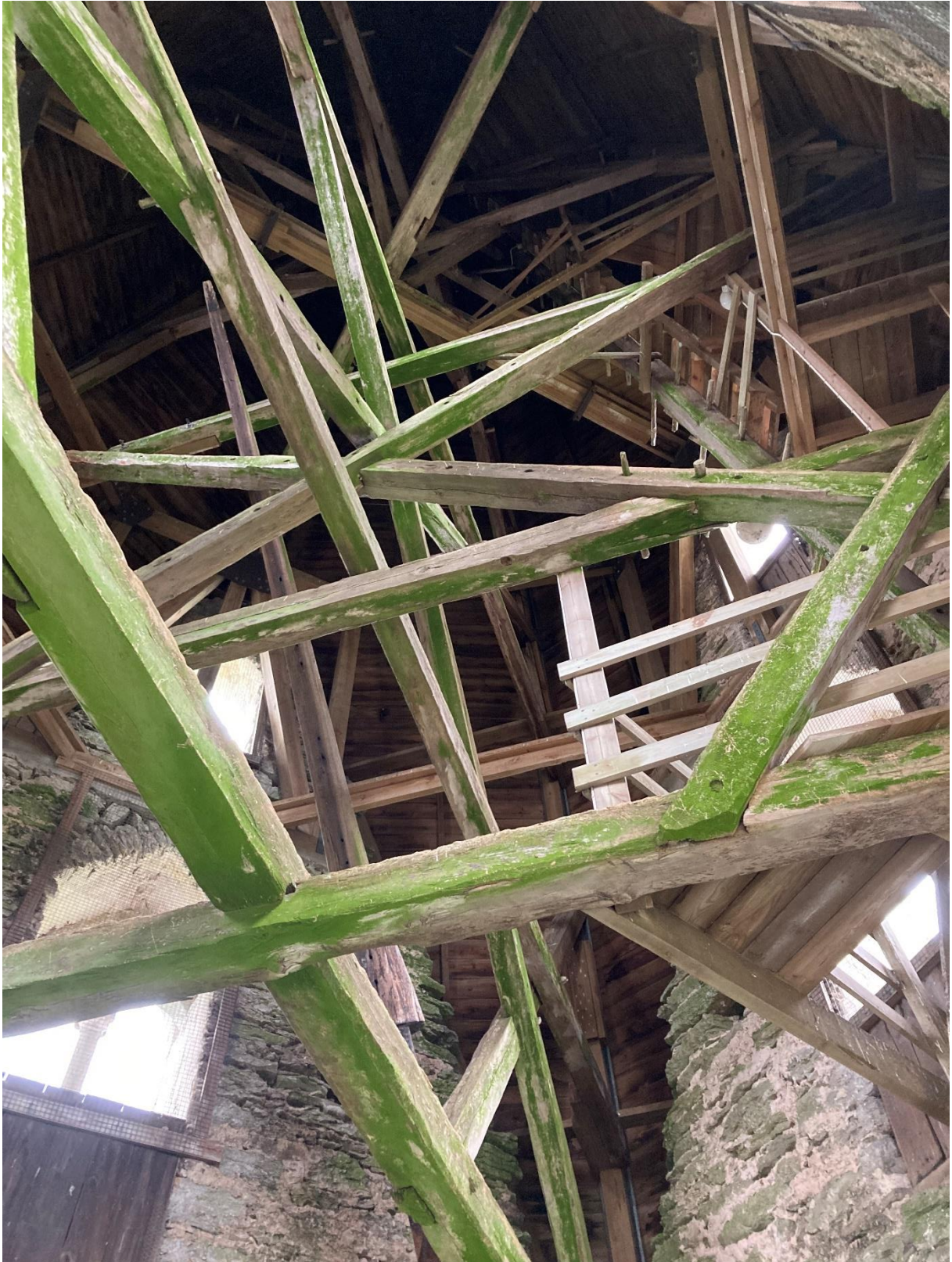
Huvkonstruktionen sedd underifrån. Foto JL 2023.
