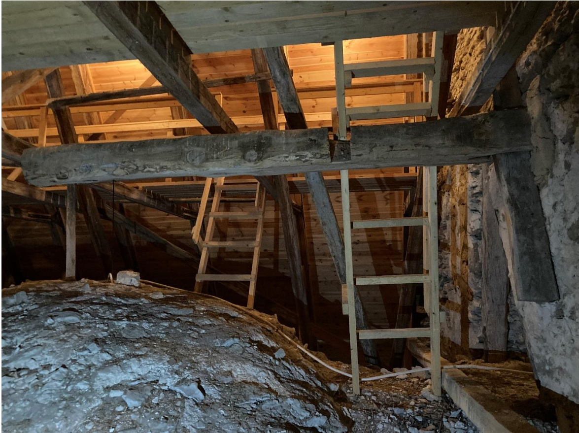
Långhusvindens östra del mot norr med ankarbjälken som även skjuter ut i korets östgavel. Foto JL 2023.
