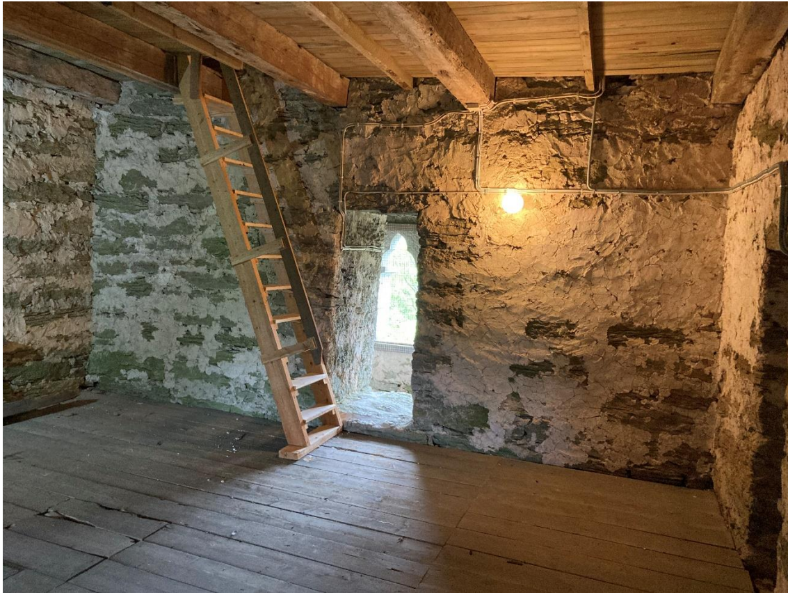
Tornets första övervåning mot nordväst. Foto JL 2023.
