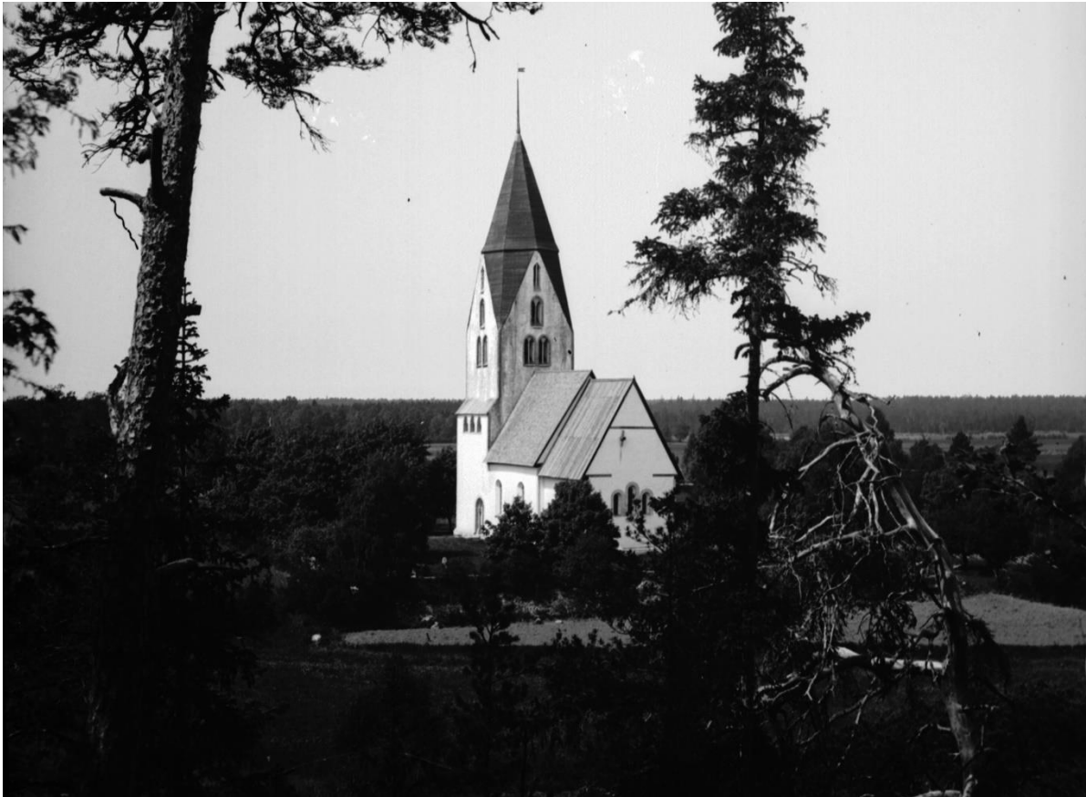
Exteriör från sydost. Foto Einar Erics 1915, ATA.
