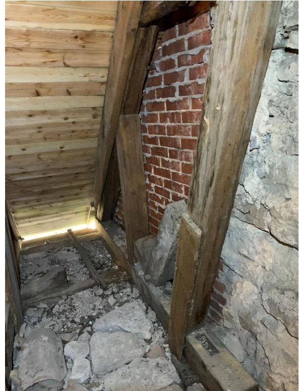
Långhusvinden mot väster. Till höger vindens sydvästra hörn med sentida påmurningar i tegel på långhusgaveln på var sida av tornet. Foto JL 2021.
