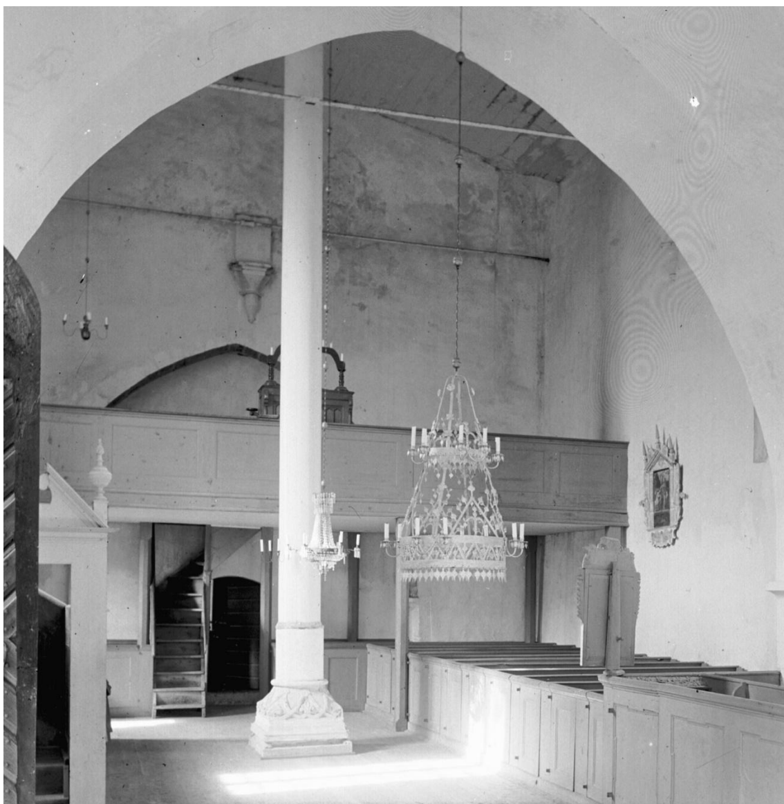
Interiör mot väster före restaureringen 1925-26. Nedan förstoring. Bilden visar det flacka trätunnvalv som på 1860-talet ersatte de rasade murade valven. Mittkolonnen är av trä. Läktaren tillkom vid samma tid liksom väggen i tornbågen. Läktaren ersatte en äldre, men att bänk-inredningen och predikstolen bibehölls tyder på att valvrasat främst drabbade långhusets västra del. Foto Anders Roland 1925, ATA.
