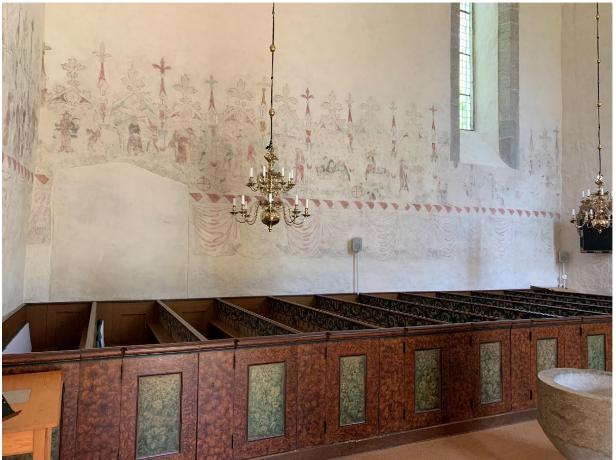
Långhusets norra mur med den igenmurade nordportalen och kalkmålningar från 1400-talet. Foto JL 2021.
