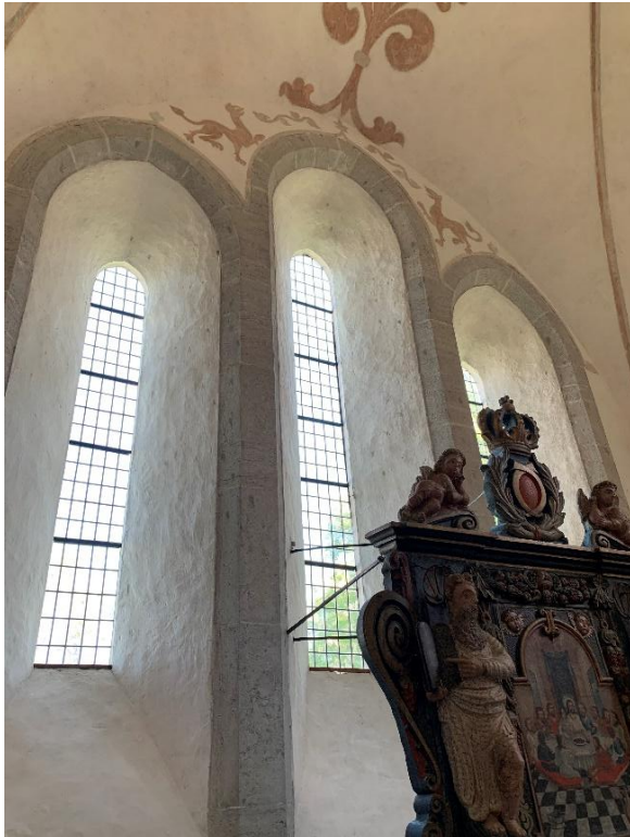
Korets östra och södra fönster. Foto JL 2021.
