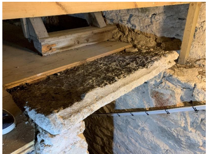
Murtrappans mynning i tornets första övervåning. Till höger trappmyrningens täcksten, vars profil och inhuggna kors visar att den utgjort skiva till altare, sannolikt ett sidoaltare. Foto JL 2021.
