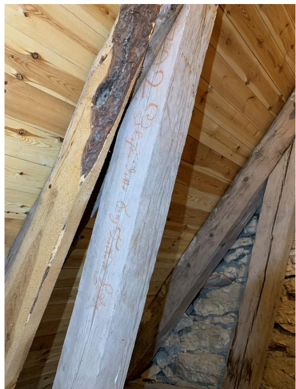
Avbränt ställningsvirke i triumfbågsmuren, kanske från den eldsvåda 1695, som omtalas på kyrkklockan. Till höger en av flera inskrifter på takstolen, denna från 1702 berättar om takbygge, kanske efter branden. Foto JL 2021.
