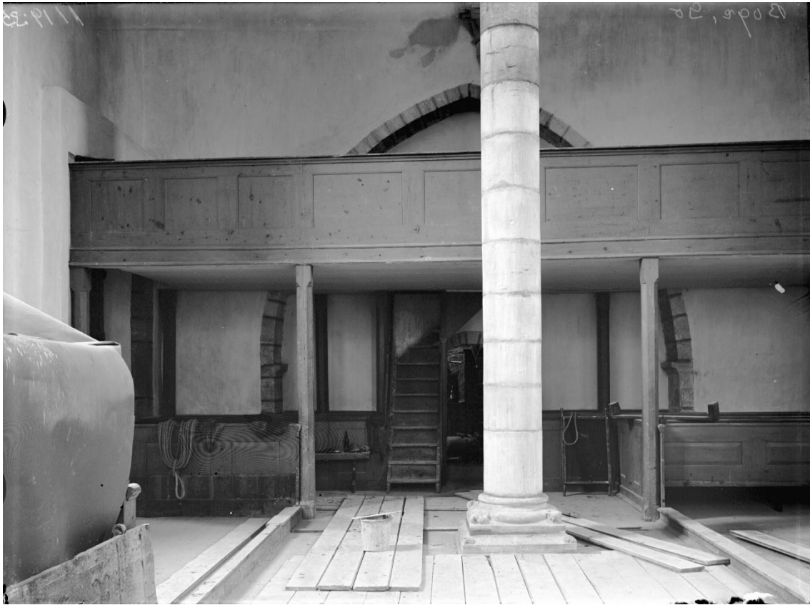
Interiör mot väster visande 1865 års läktare strax före rivningen. Foto Alfred Edle 1926, ATA.
