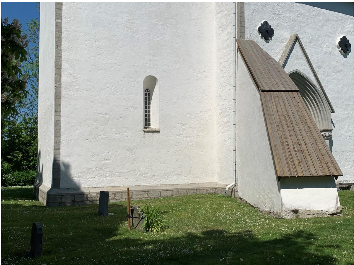
Tornets nederdel samt strävpelaren från sydväst. Foto JL 2021.
