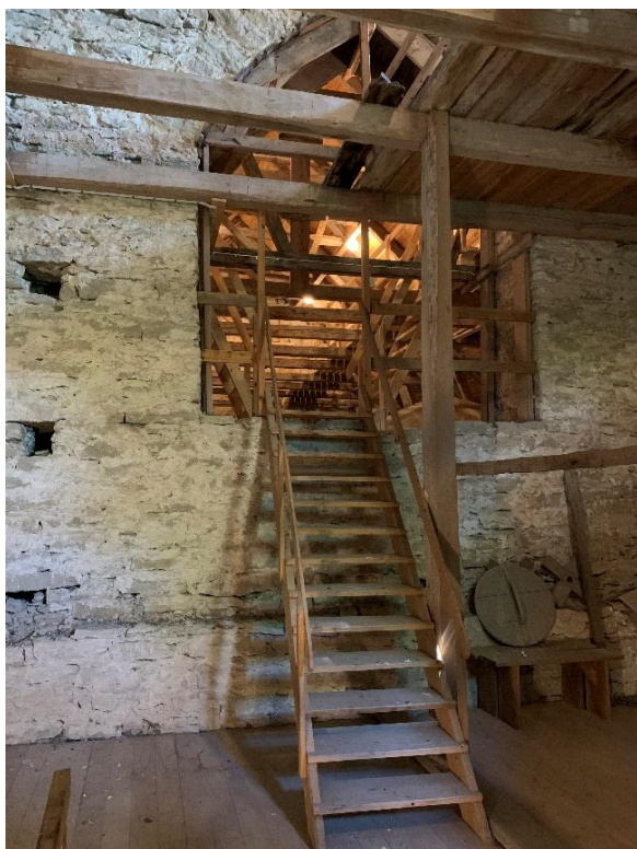
Tornets första övervåning mot öster med öppning mot långhusvinden. Till höger öppningen sedd från tornets andra övervåning. Öppningen från 1890-talet har kvar träställningen från när bågen slogs. Foto JL 2021.
