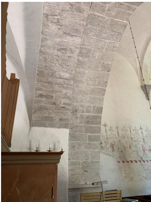
Tornbågens anfang mot norr samt bågen underifrån. Den högra delen av bågen tillkom vid långhusets byggnadstid medan den vänstra, västra delen togs upp 1926 i en mur från 1867. Foto JL 2021.
