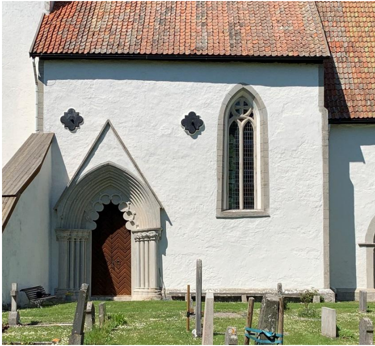
Långhusets södra fasad. Foto JL 2021.
