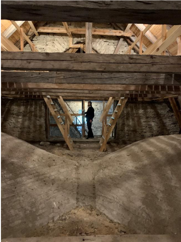
Långhusvinden mot väster. Till höger vindens sydvästra hörn med sentida påmurningar i tegel på långhusgaveln på var sida av tornet. Foto JL 2021.
