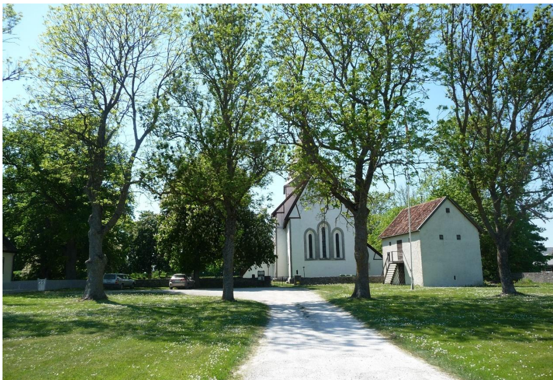
Område öster om Boge kyrka. Området avgränsas av en trädrad med ask mot landsvägen. Här växer även enstaka äldre träd. Till höger syns sockenmagasinet. Foto ES 2021.
