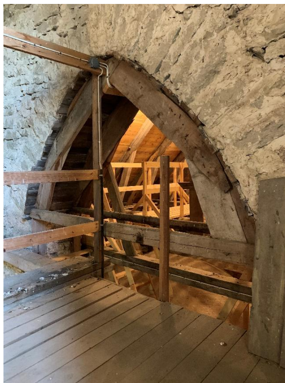
Tornets första övervåning mot öster med öppning mot långhusvinden. Till höger öppningen sedd från tornets andra övervåning. Öppningen från 1890-talet har kvar träställningen från när bågen slogs. Foto JL 2021.
