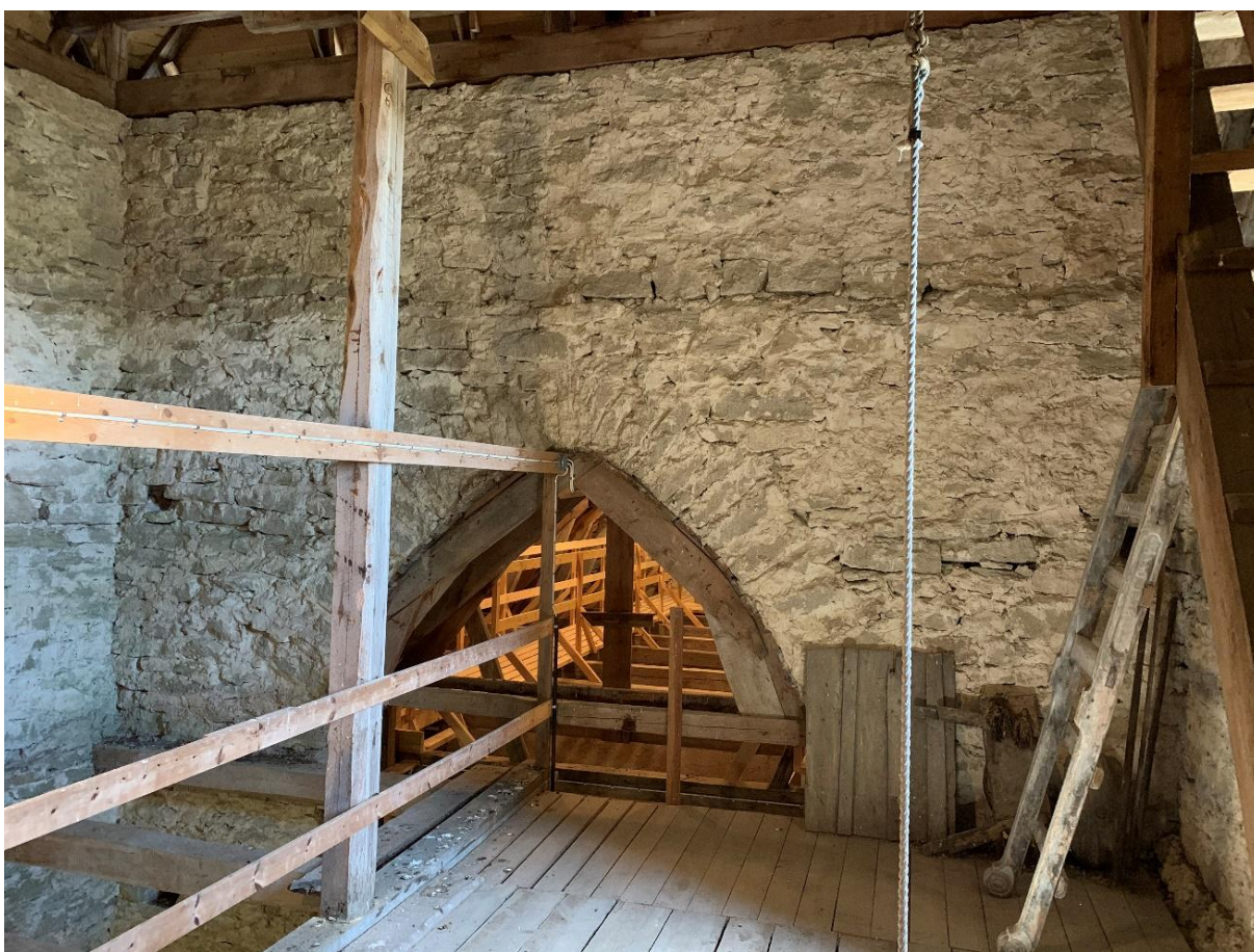
Tornets andra övervåning mot öster. Foto JL 2021.
