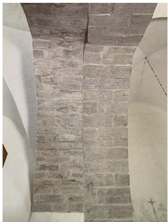
Tornbågens anfang mot norr samt bågen underifrån. Den högra delen av bågen tillkom vid långhusets byggnadstid medan den vänstra, västra delen togs upp 1926 i en mur från 1867. Foto JL 2021.
