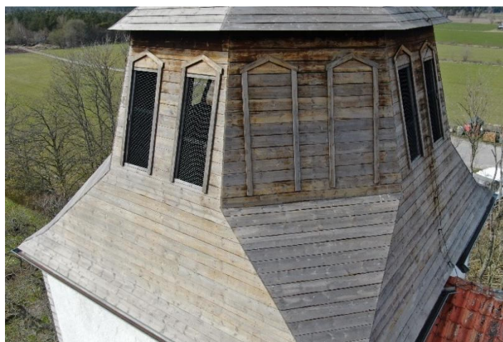
Korsformad glugg i tornets västra mur samt fönster i övre delen av södra tornmuren. Foto JL 2021. Till höger ljugluggarna i tornhuven. Blinderingarna var tidigare öppna och, liksom alla gluggarna, försedda med stängningsbara luckor. Foto Pär Malmros 2021, Visby stift.
