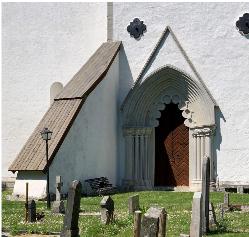
Södra långhusportalen och strävpelaren från sydöst. Foto JL 2021.
