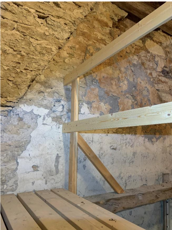
Korets västra gavel avtecknande sig i triumfbågsmuren. Till höger passagen till korvinden, sedd från långhusvinden i väster. Foto JL 2021.
