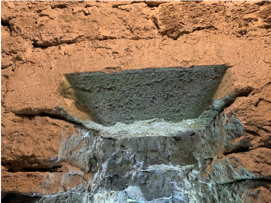
Överstykke till den inre fönsternischen i den västra tornmurens korsformade glugg. Den huggna stenen är troligen en återvänd solbänk (sten längst ner i ljusöppning), möjligen en korsformad glugg som utgjort förebild till den nuvarande gluggen. Foto JL 2021.
