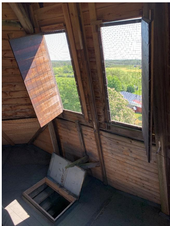
Klockvåningen i tornhuvn sedd mot söder och väster. Före 2013-14 fanns luckförsedda ljudgluggar även mot tornets hörn, nu ersatta av panel och utvändiga blindgluggar. Foto JL 2021.
