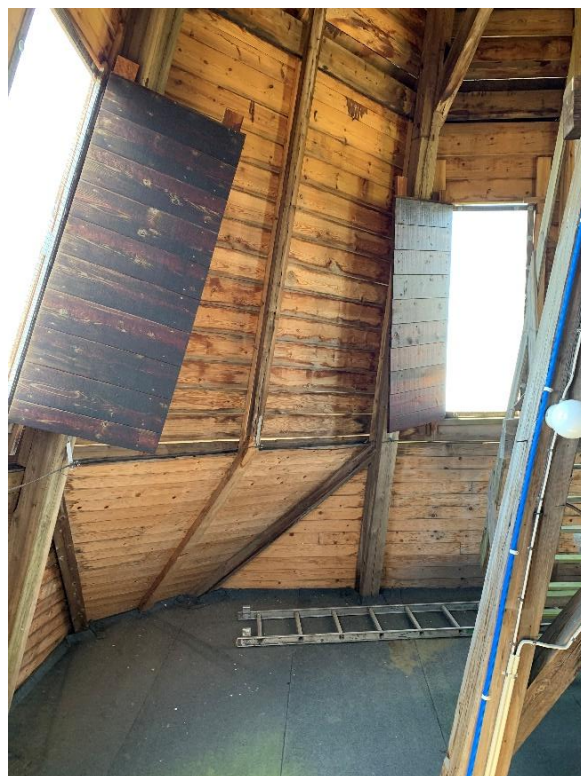
Klockvåningen i tornhuvn sedd mot söder och väster. Före 2013-14 fanns luckförsedda ljudgluggar även mot tornets hörn, nu ersatta av panel och utvändiga blindgluggar. Foto JL 2021.
