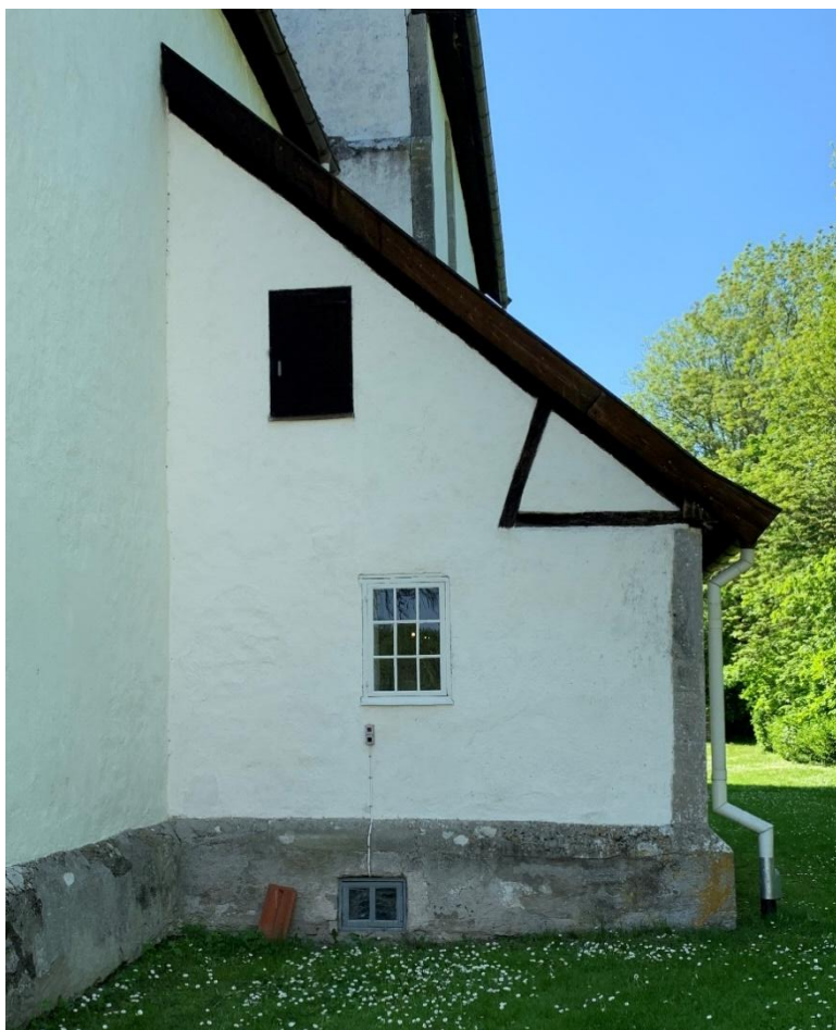
Sakristians östfasad med fönster till källaren och lucka till vinden. Foto JL 2021.
