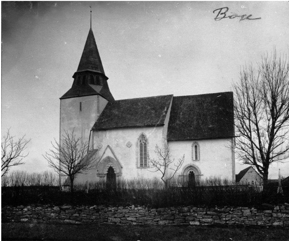
Boge kyrka fotograferad från söder. Muren har sänkts till en låg terrassmur och en häck har planterats vid muren. Okäntfotograf och datum. RAÄ, Kulturmiljöbild.
