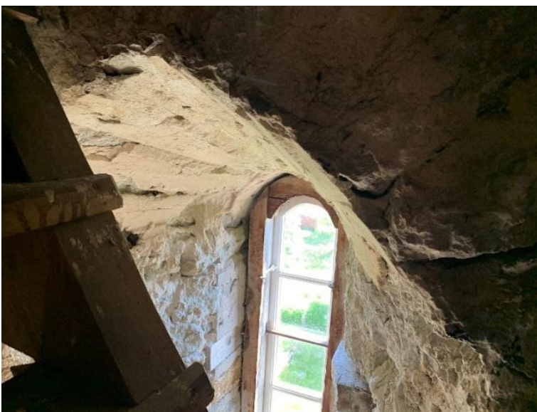
Fönster i tornets andra övervåning mot söder. Överst, taket över tornets andra övervåning, klockvåningens vattendäck, sett mot norr. Foto JL 2021.
