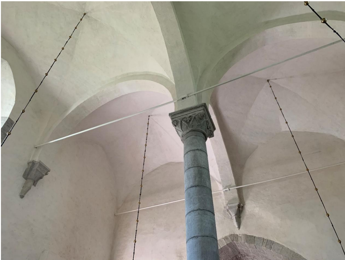
Långhusvalven sedda underifrån mot sydväst. Valven byggda 1925 som rekonstruktion av de gamla som rasade 1858. Foto JL 2021.
