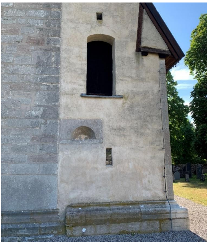
Bönekammaren sedd från sydväst. Foto JL 2020.
