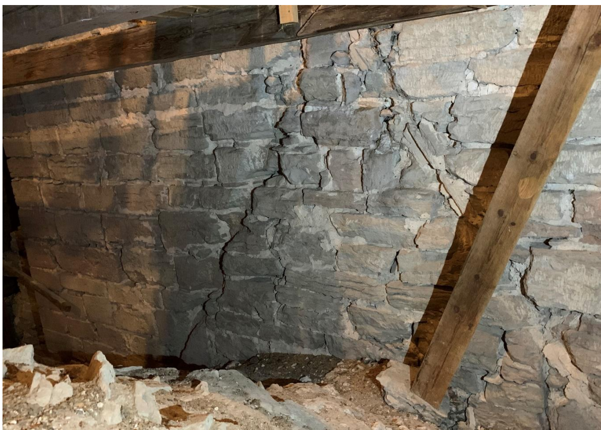
Tornets östra mur med avtryck av den äldre långhusgaveln. Foto JL 2022.
