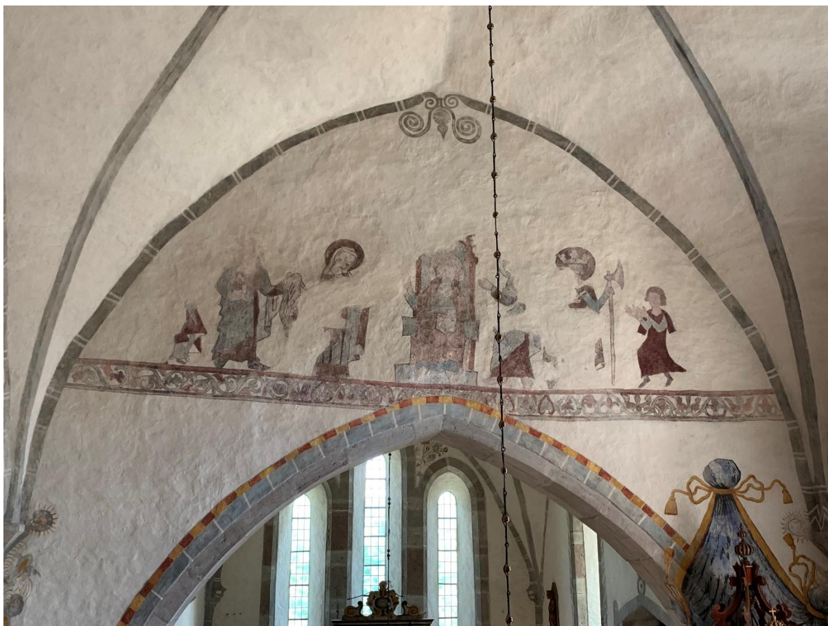
Kalkmålning från omkring 1300 över triumfbågen, mot långhuset, framtagen på 1950-talet. Foto JL juni 2022.
