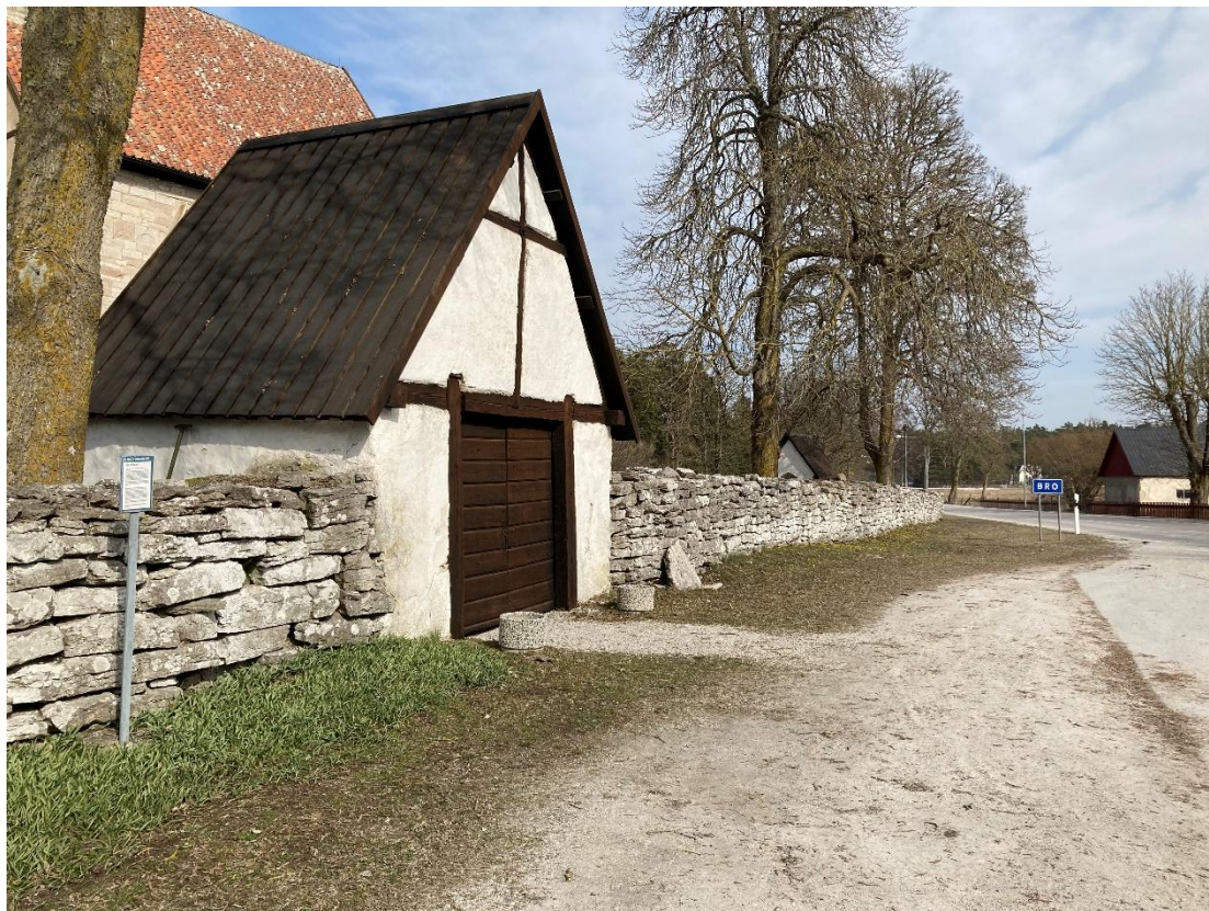
Den södra stigluckan och mursträckningen fotograferade från väster. Foto ES 2022.
