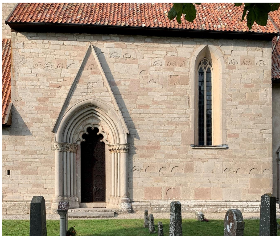
Långhusets sydfasad. Foto JL 2020.
