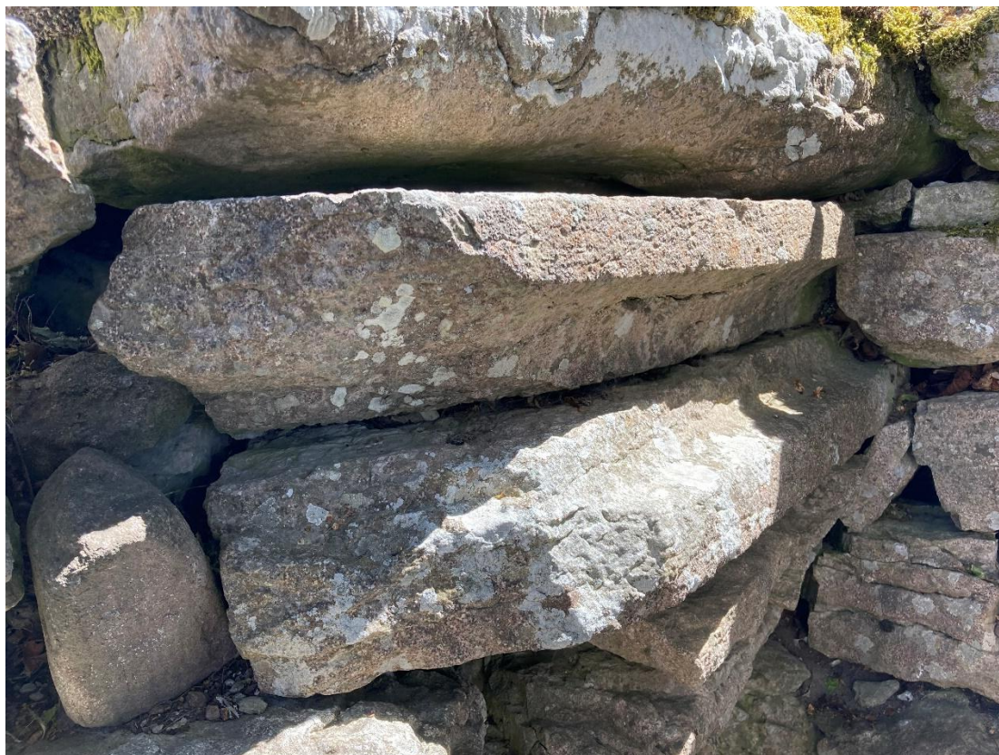
I murens sydöstra hörn finns en del stendetaljer. Troligen en del av en altarskiva. Foto ES 2022.
