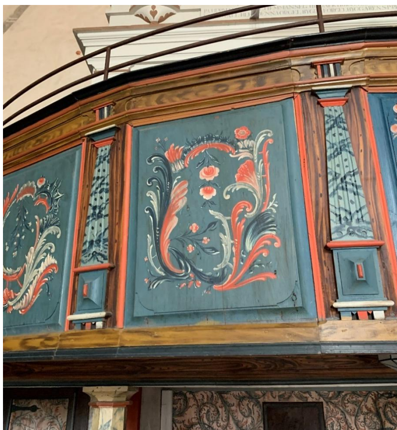
Läktare från 1779-1780, målad 1781 av Tomas Malmberg. Utbuktning och pelare troligen från orgelns tillkomst 1839. Foto JL juni 2022.
