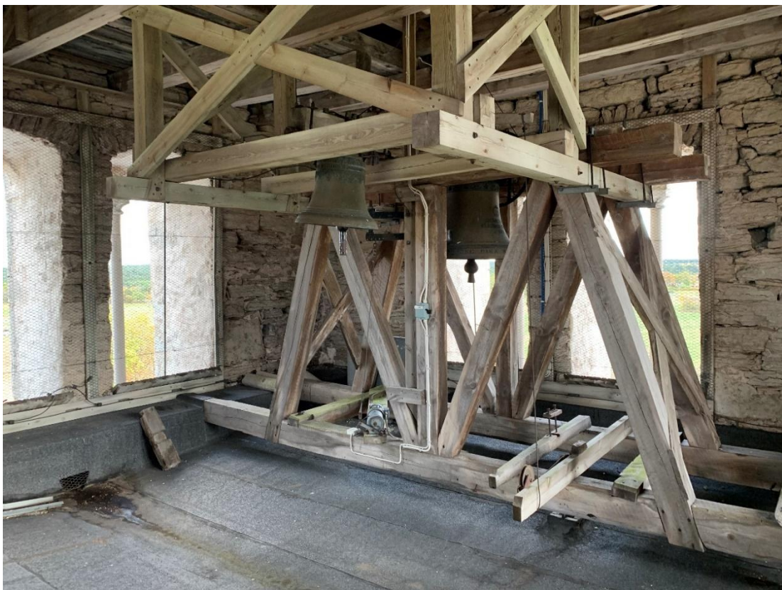
Klockvåningen mot sydöst. Klockstolen, sannolikt från 1927 när storklockan göts, utvidgad 1983 när lillklockan återbördades från Bungemuseet. Foto JL 2021.
