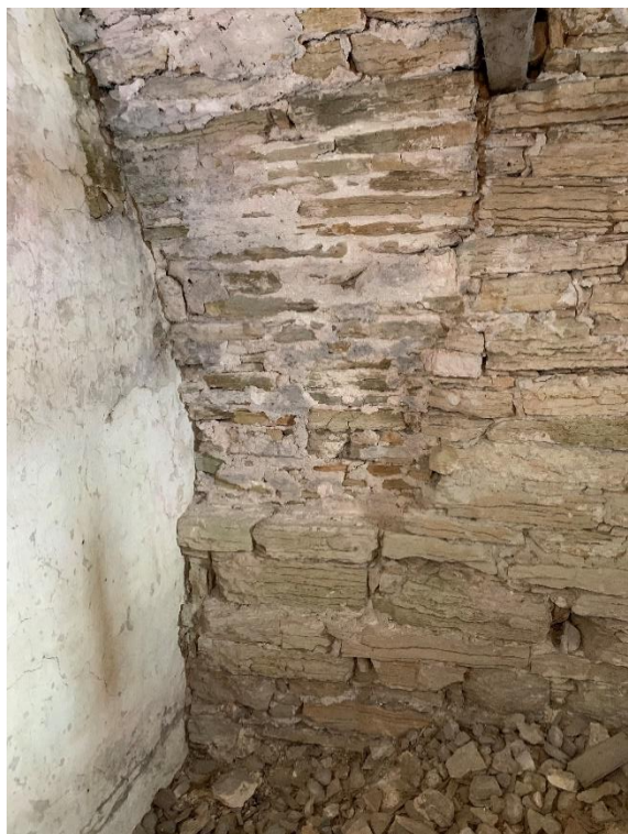
Första övervåningens sydöstra hörn. Bågen något indragen, sannolikt för att avsatsen använts som upplag för bärkonstruktionen. Till höger våningen sedd mot sydväst med steg uppåt. Foto JL 2021.
