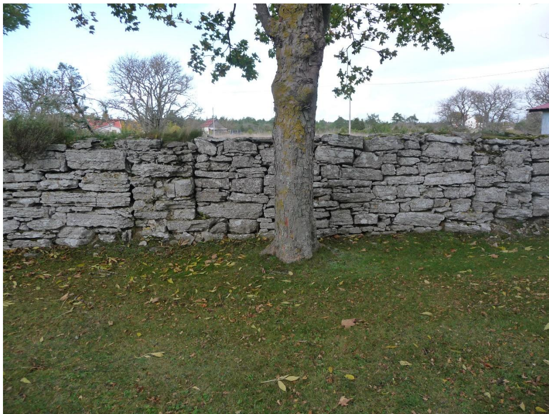
Den norra muren. Tidigare fanns en stiglucka här vilket markeras av de mindre stenarna mellan synliga poster. Foto ES 2021.
