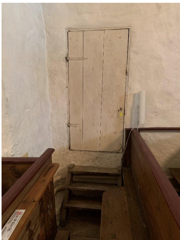
Uppgång till murtrappan i tornets södra mur i ringkammarens sydöstra hörn. Till höger trappan sedd uppåt mot väster Foto JL 2021.
