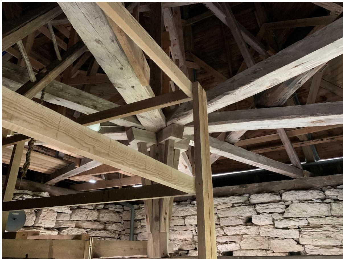
Tornhuvens bärlag, sett underifrån mot sydväst. Foto JL 2021.
