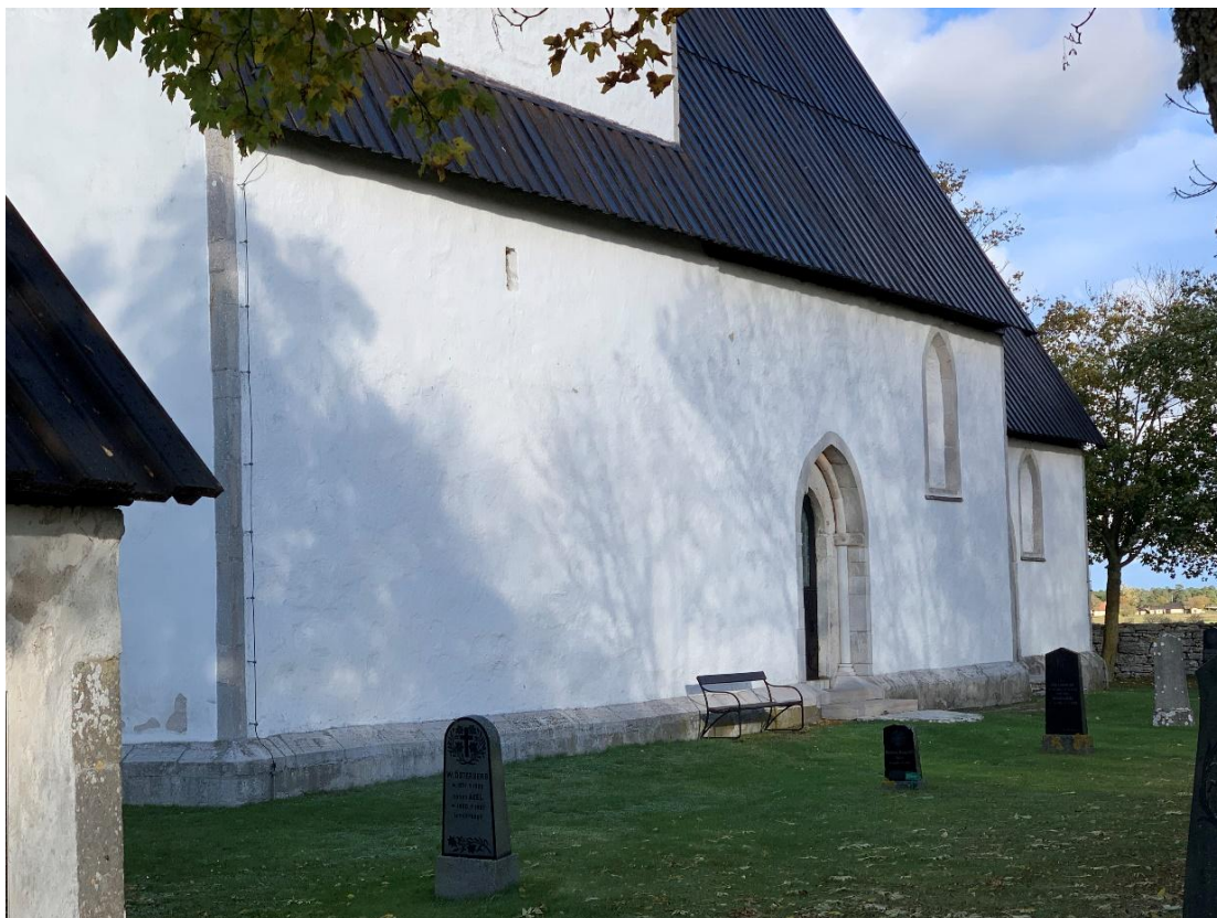
Sydfasaden mot öster. Foto JL 2021.
