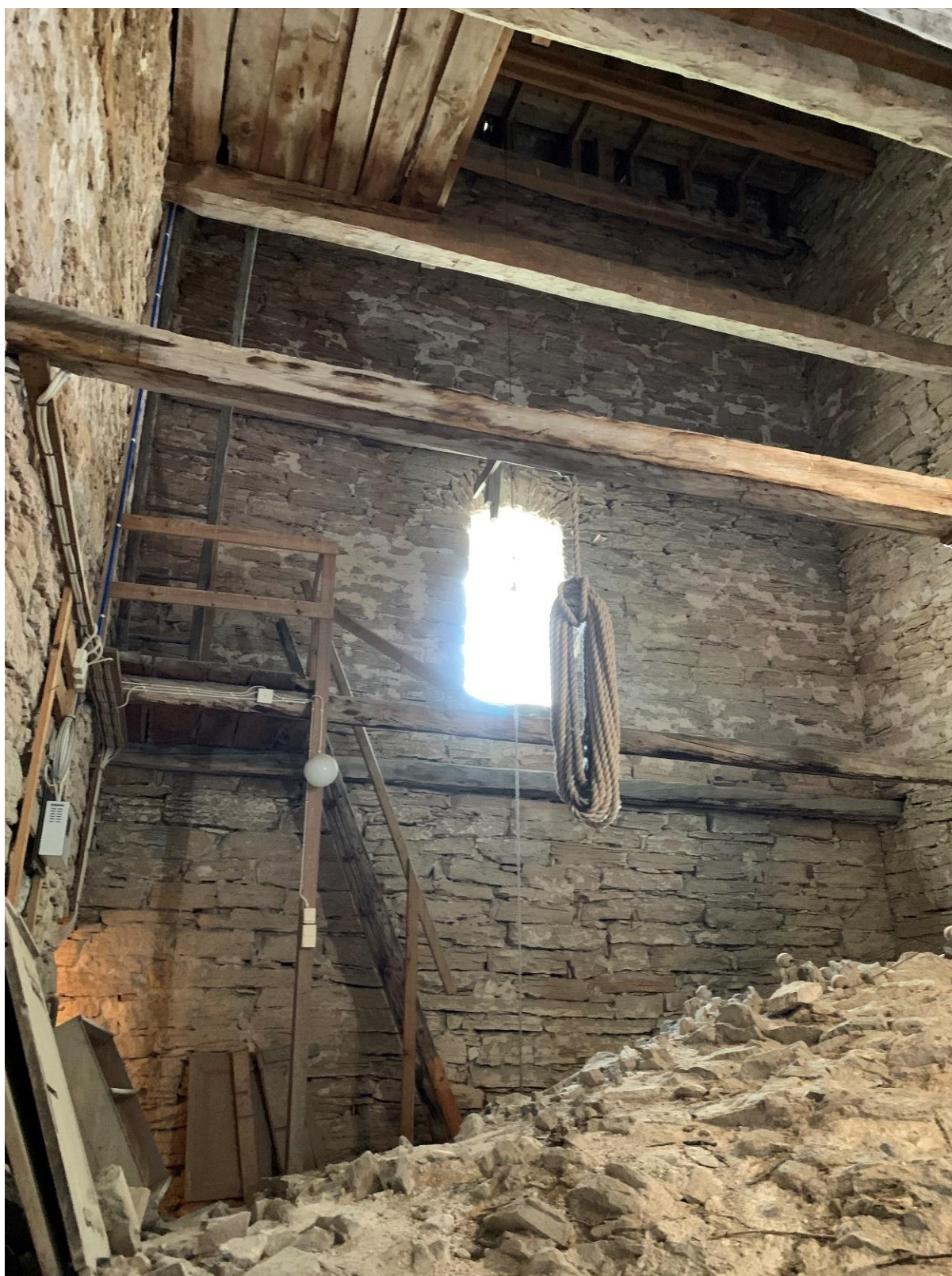
Tornets första övervåning sedd mot väster. Bjälklagen visar att rummet delats i tre våningar varav ett mindre golv finns i den översta. Den stora öppningen har utgjort lastport till den mellersta av dessa tre våningar. Foto JL 2021.
