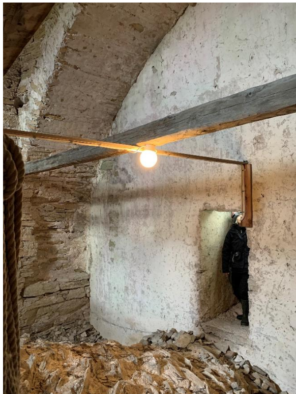
Gångöppningen till långhusvinden från tornet, placerad i långhusets västgavel som en gång var synlig utifrån och vars puts lades på innan tornet byggdes. Putsen följer med in i gångöppningen som alltså både till sin form, omfattning och ytbehandling är bevarad sedan långhusets byggnadstid under 1200-talets förra hälft. Foto JL 2021.
