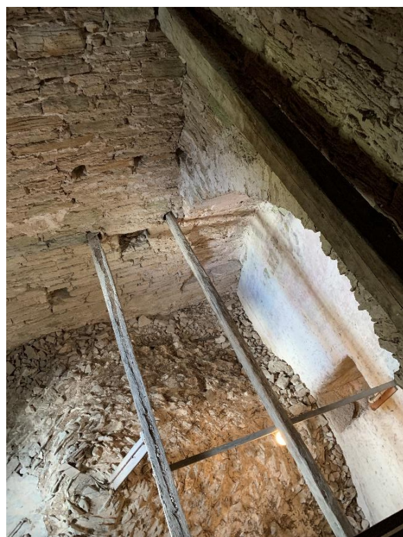
Nisch i norra muren strax under bjälklaget för klockvåningen. Möjligen igensatt tidigare öppning för ett spygatt eller till en draglina för att kunna klämta i en klocka utifrån av ett slag som synes ha funnits i några kyrktorn. Till höger tornets valv sett ovanifrån. Foto JL 2021.
