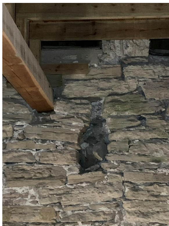
Nisch i norra muren strax under bjälklaget för klockvåningen. Möjligen igensatt tidigare öppning för ett spygatt eller till en draglina för att kunna klämta i en klocka utifrån av ett slag som synes ha funnits i några kyrktorn. Till höger tornets valv sett ovanifrån. Foto JL 2021.
