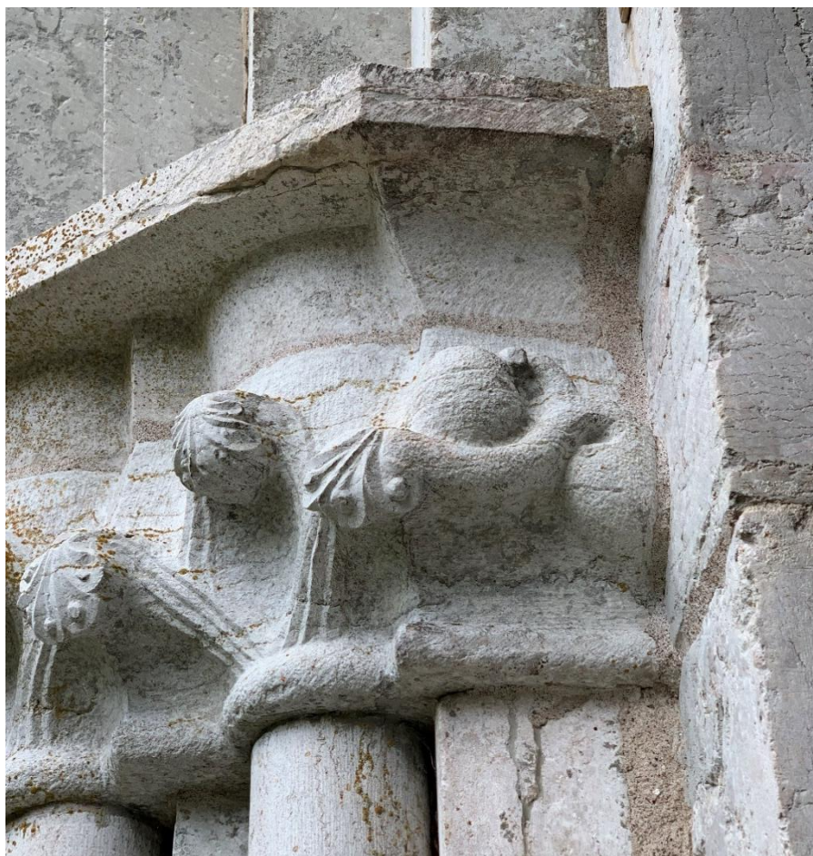
Innersta delen av västportalens norra kapitälband med ej fullföljt ornament. Foto JL 2021.
