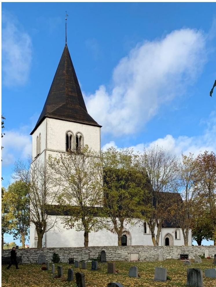
Exteriör från sydväst. Foto JL. 2021.
