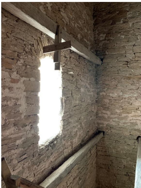
Lastport i tornets västra mur. Foto JL 2021.
