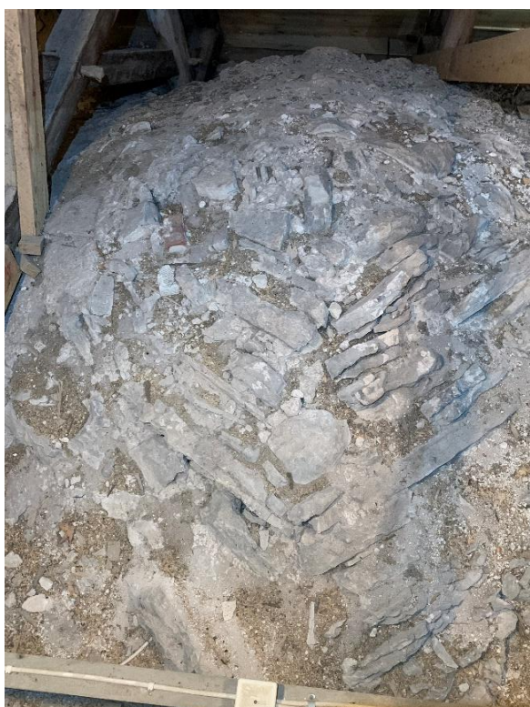
Ett av långhusets valv ovanifrån. Till höger detalj av det brandskadade murverket i triumfbågsmuren, sett från långhusvinden. Foto JL 2021.
