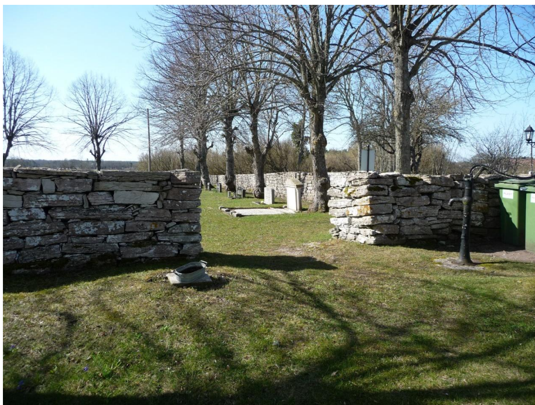
Öppning i väster mellan den äldre och yngre kyrkogården, fotograferad från norr. Foto ES 2021.
