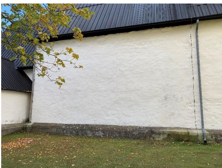
Långhusets nordfasad. Foto JL 2021.
