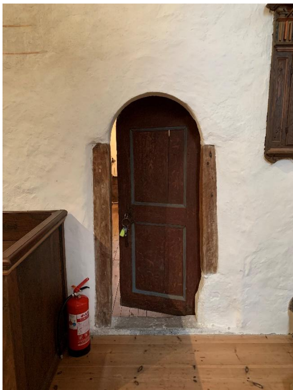
Ingången till sakristian. De båda posterna av trä kan vara ersättning för brandskadade poster och talar då för att sakristian är medeltida men omgjord senare. Foto JL 2021.
