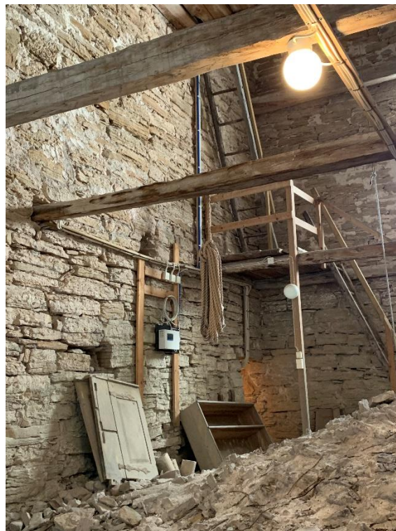
Första övervåningens sydöstra hörn. Bågen något indragen, sannolikt för att avsatsen använts som upplag för bärkonstruktionen. Till höger våningen sedd mot sydväst med steg uppåt. Foto JL 2021.
