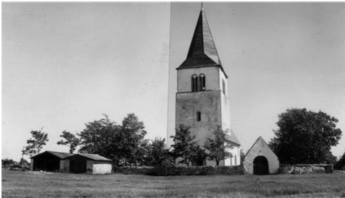
Exteriör från väster på 1950- eller 60-talet. Foto Inga-Lill Granlund, Gotlands Museum (GFF916_31). Taken på tornens sidor tillkom sannolikt vid 1940-talets restaurering. Öppningen i den västra muren är nu igensatt.
