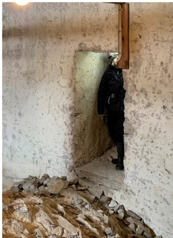
Gångöppningen till långhusvinden från tornet, placerad i långhusets västgavel som en gång var synlig utifrån och vars puts lades på innan tornet byggdes. Putsen följer med in i gångöppningen som alltså både till sin form, omfattning och ytbehandling är bevarad sedan långhusets byggnadstid under 1200-talets förra hälft. Foto JL 2021.
