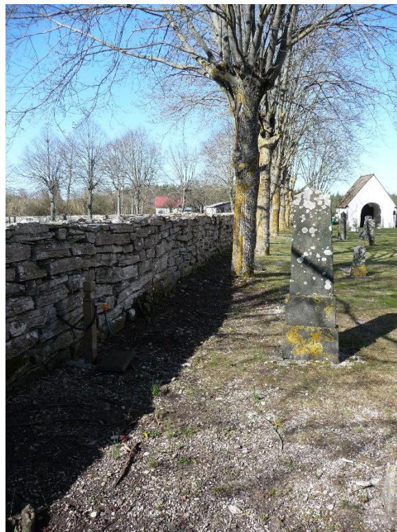
Den södra mursträckningen fotograferad från väster. Foto ES 2021.
