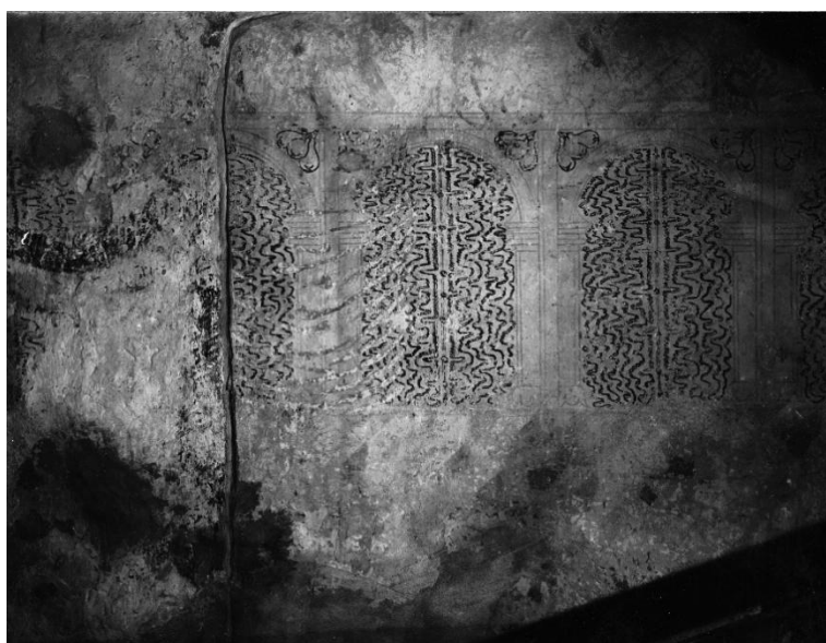
Igenmurad portal på långhusets norra sida. Foto JL 2021. Till höger den nyupptäckta portalen och de nyframtagna kalkmålningarna. På igenmurningen återfinns inte bara kalkmålningarna av 1500-talstyp utan även rester av draperimålningar, sannolikt från Passionsmästarens målningar från 1400-talets mitt, vilket visar att portalen murades igen redan på medeltiden. Foto Alfred Edle 1946, ATA.
