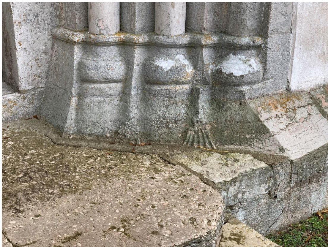
Västportalens södra basband. Baserna ansluter på ett ovanligt tydligt sätt till den omgivande sockeln. Foto JL 2021.
