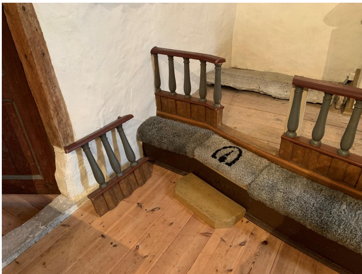
Del av altarringen med grinden som öppnas genom att hakas av. Foto JL 2021.
