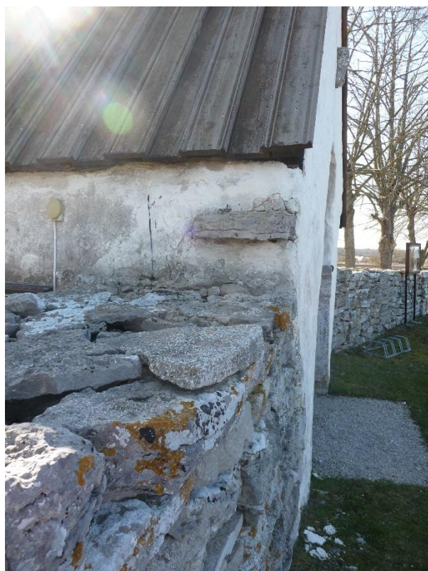
I den norra väggen på stigluckan finns en utkragning som visar en ursprunglig högre höjd på muren. Foto ES 2021.
