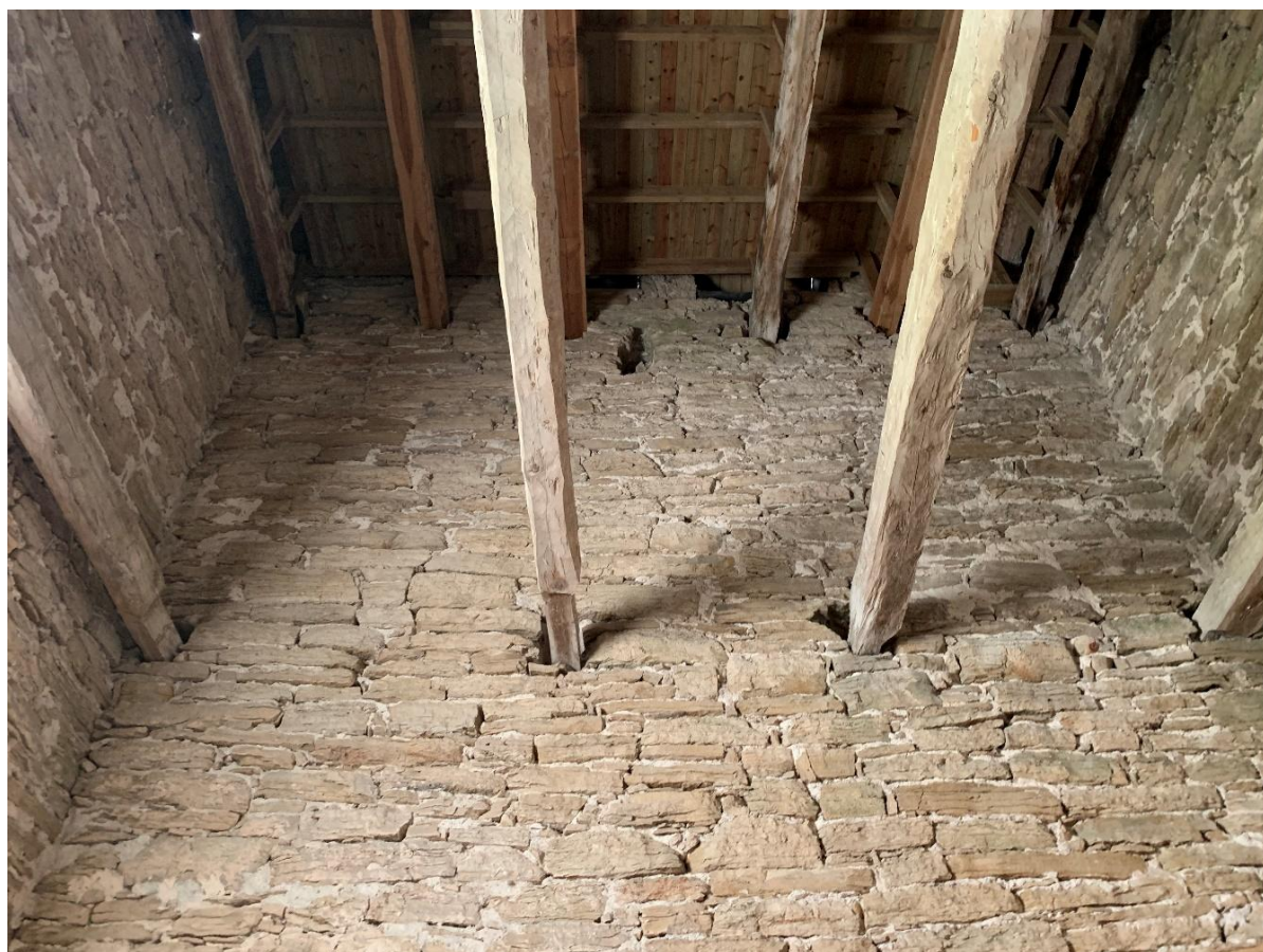
Tornets övervåning sedd uppåt mot norr. Foto JL 2021.
