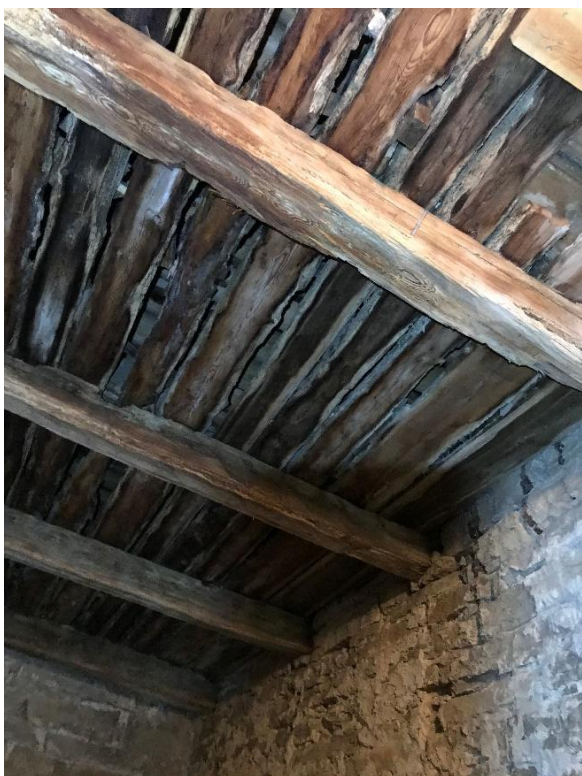
Bjälklag över det höga rummet i tornets första övervåning med lucka i nordöstra hörnet. Golvbräderna, som tidigare utgjort golv i klockvåningen, är starkt anfrätta. Ett yngre golv med bjälkar och klockdäck ligger ovanpå detta. Foto JL 2021.
