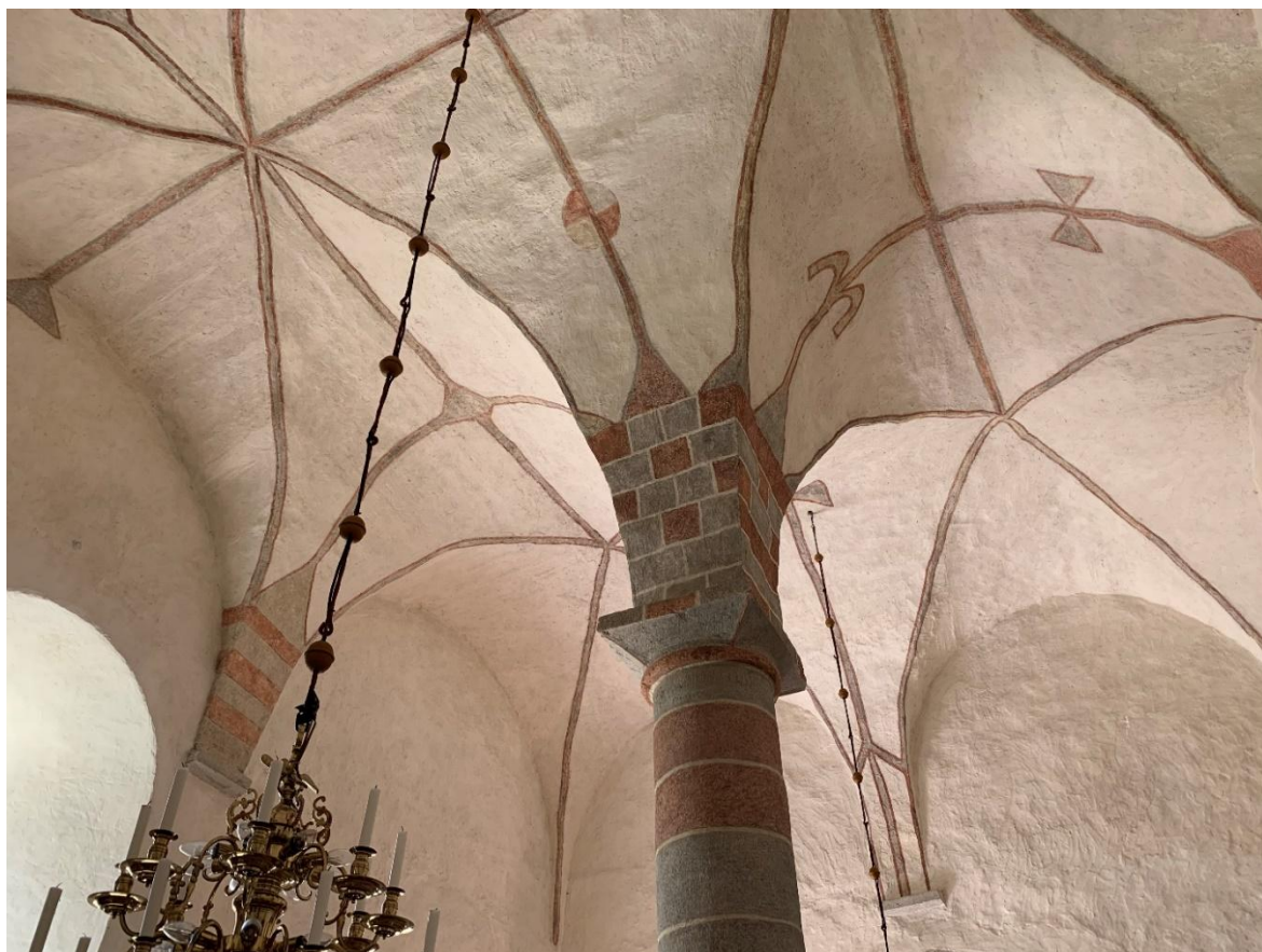
Långhusvalven sedda mot sydväst. Den beslagsliknande målade ornamentiken och kvaderstenskdekoren tillkom vid byggnadstiden. Kolonnens ursprungliga bemålning återställdes 2007 efter äldre spår, sedan kalkstenen helt frilagts från färglager 1956. Foto JL 2021.
