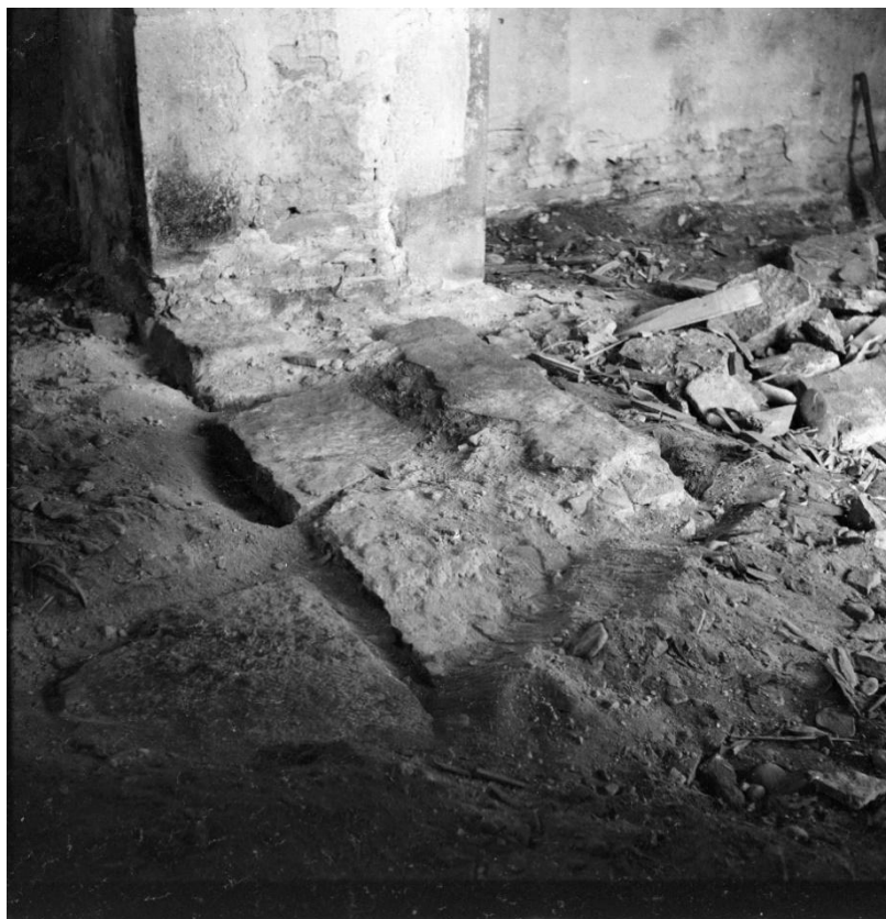
Grundmur under tornbågen, frilagd vid restaurering. Foto Erik Olsson Sanda 1956, ATA, RAÄ.
