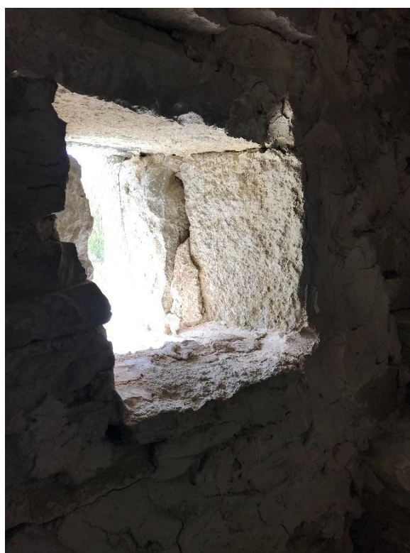
Brett utstruket bruk i murtrappans nedre del. Till höger ljuslugg till trappan. Foto JL 2021.
