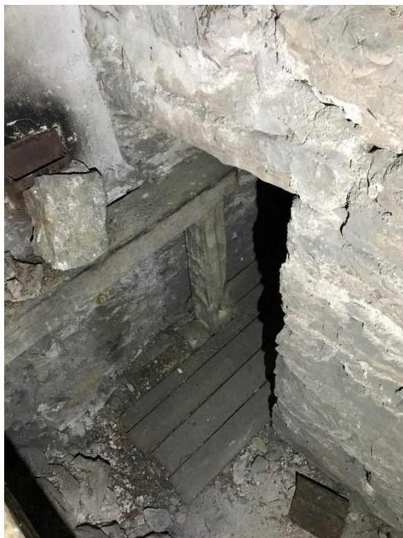
Genomgång från långhus- till korvinden med välmurad omfattning, sedd från sydväst och från öster med stöd för den längsgående hjärtbjälken. Skorstensstocken synlig i vänstra bildens borte kant. Foto JL 2021.
