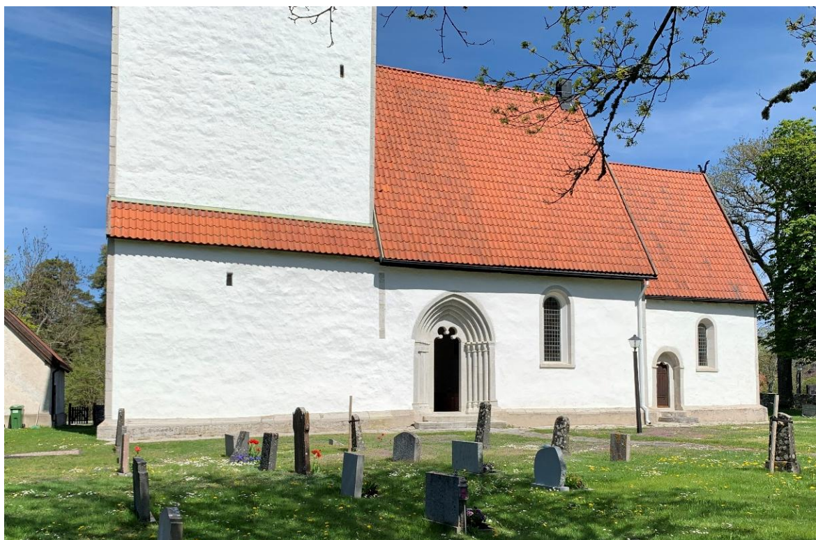
Tornets anslutning till långhuset på södra sidan, där murarna ligger i liv med varandra och tornets sockel fortsätter på den övriga kyrkans. Hörnkedjan är frilagd i sin övre del. Foto JL 2021.
