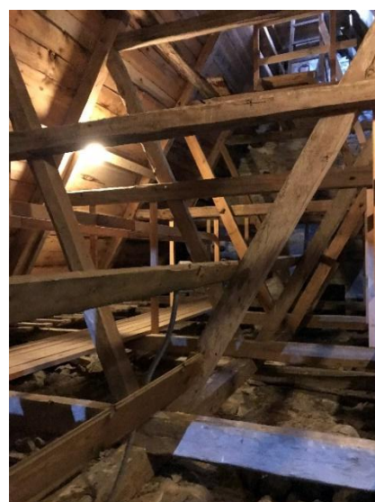
Ovasidan av långhusets valv sedd mot väster. En längsgående hjärtbjälke löper i östvästlig riktning mitt under de tvärställda bindbjälkarna. Mittpartiet ovanför kolonnen är uppfyllt och bildar en plan yta mellan långhusets fyra kryssvalv. Till höger långhusvinden mot väster. Foto JL 2021.
