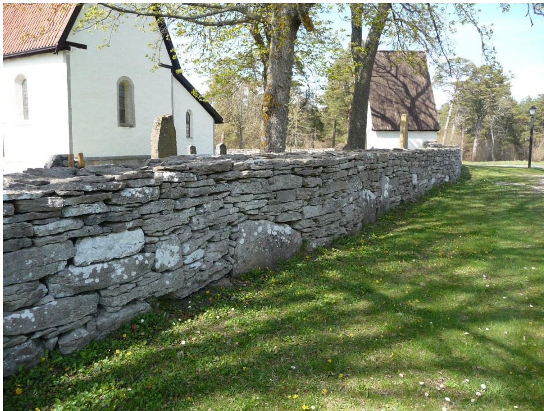
Den östra mursträckningen. I muren nedre delar finns sten av olika storlek, varav många stora stenar vilket brukar vara ett tecken på att muren har en hög ålder. Foto ES 2021.
