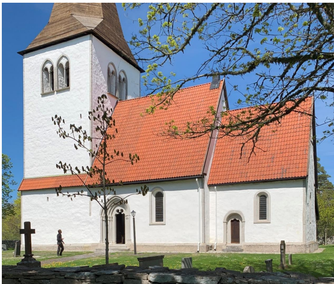
Kyrkans södra fasad. Tornet reser sig utanför den ursprungliga västgaveln vars hörnkedja frilagts i putsen, varför långhus och kor uppvisar sina ursprungliga proportioner. Foto JL 2021.
