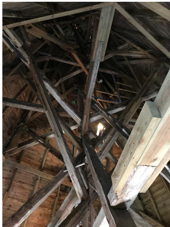
Tornhuvens nedre del med stjärna av bindbjälkar och mittstolpe under hanbjälkar och kryss, sedd mot öster. En tidigare spirstock med stigbyglar ligger lös. Foto Ola Nyström 2021, Gotlands Museum. Till höger blick upp i tornhuvnen. Foto JL 2021.
