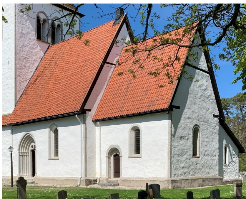
Långhus, kor och sakristia från sydöst. Portaler och korets östfönster är medeltida medan sakristians fönster och fönstren åt söder är från 1800- och 1900-talen. Foto JL 2021.
