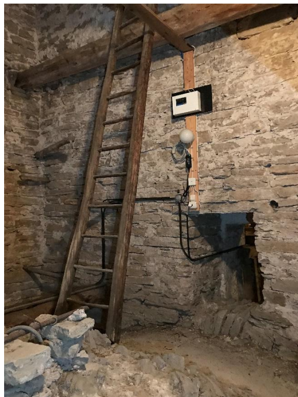
Tornets första övervåning. Till vänster klockhälet genom valvet med träskoning, så kallad sturk. Till höger våningen mot nordöst med valvets ovansida och ingången till långhusvinden. Foto JL 2021.
