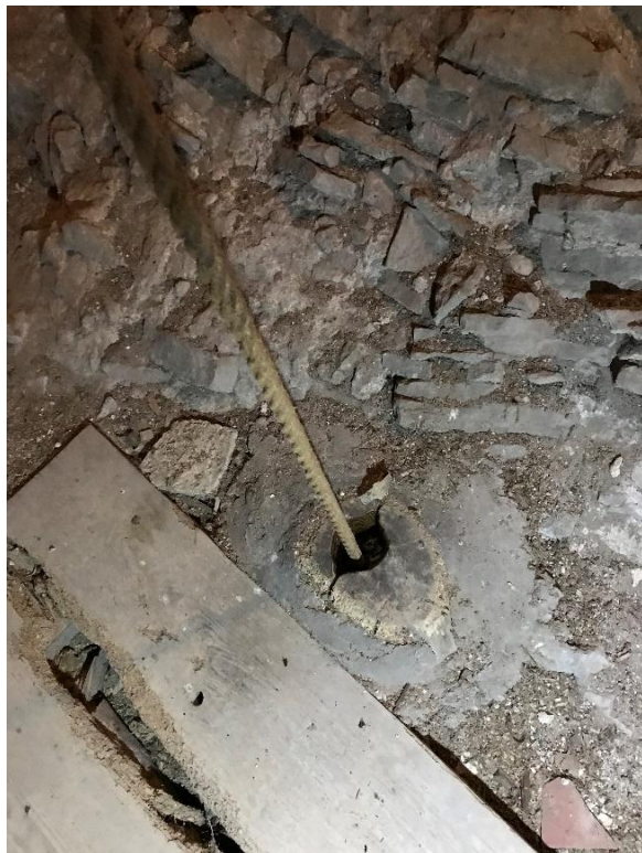
Tornets första övervåning. Till vänster klockhälet genom valvet med träskoning, så kallad sturk. Till höger våningen mot nordöst med valvets ovansida och ingången till långhusvinden. Foto JL 2021.
