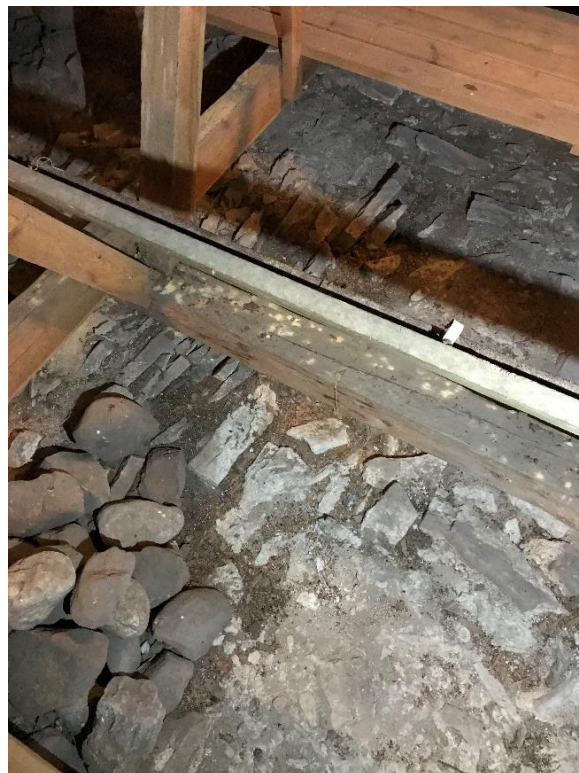
Långhusvinden mot väster med långhusets ursprungliga västgavel bevarad med en mindre ljusglugg strax under nocken. Foto Ola Nyström 2021, Gotlands Museum. Till höger ovasidan av långhusets nordvästra valv. Foto JL 2021.
