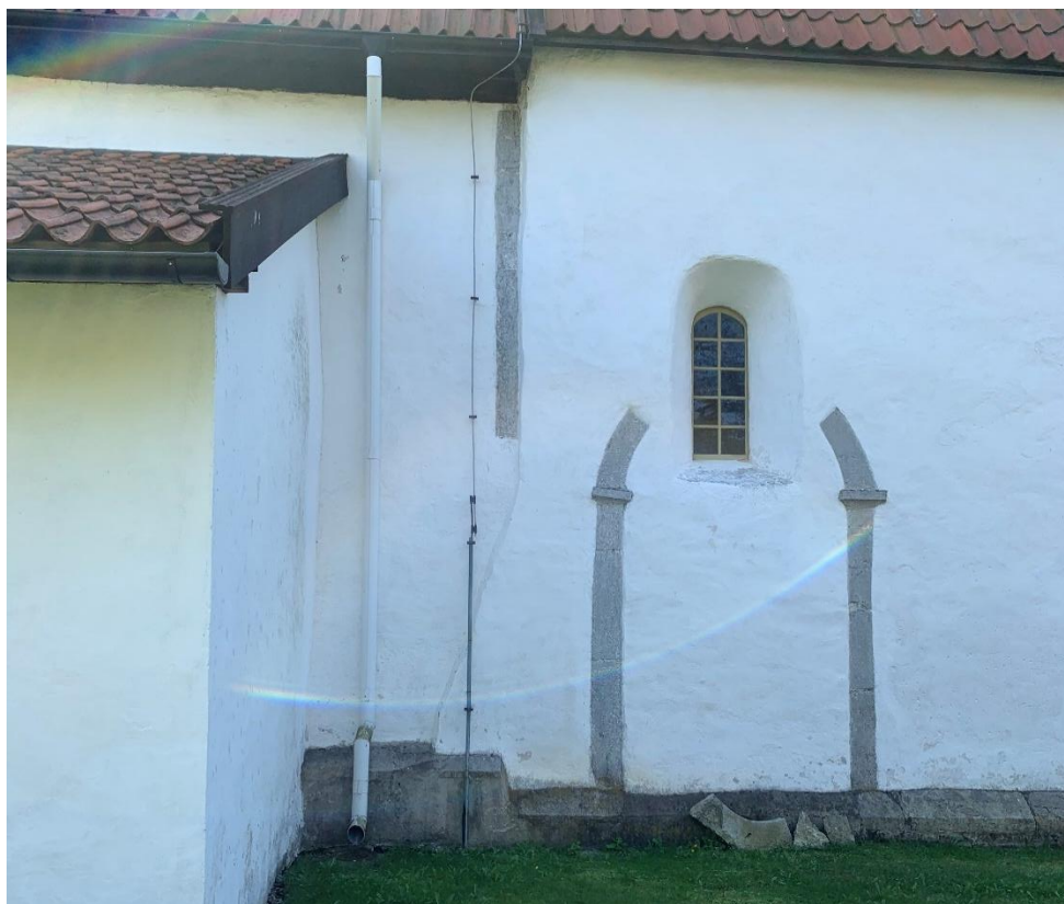
Anslutningen mellan långhus och torn på norra sidan där tornmuren springer fram något utanför långhusmuren. Foto JL 2021.
