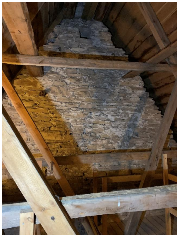
Långhusvinden mot väster med långhusets ursprungliga västgavel bevarad med en mindre ljusglugg strax under nocken. Foto Ola Nyström 2021, Gotlands Museum. Till höger ovasidan av långhusets nordvästra valv. Foto JL 2021.
