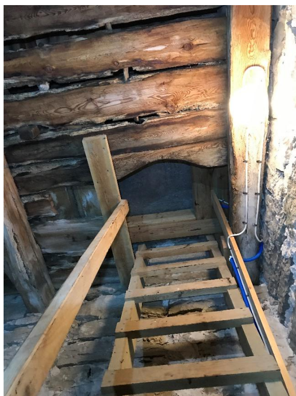
Bjälklag över det höga rummet i tornets första övervåning med lucka i nordöstra hörnet. Golvbräderna, som tidigare utgjort golv i klockvåningen, är starkt anfrätta. Ett yngre golv med bjälkar och klockdäck ligger ovanpå detta. Foto JL 2021.
