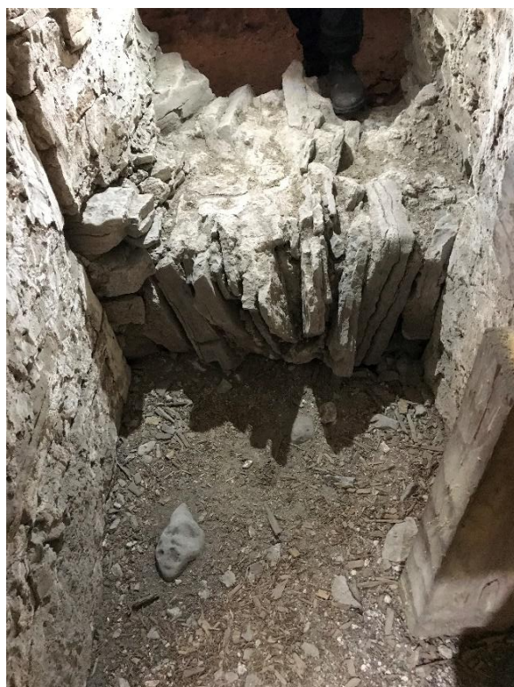
Passage från tornvinden till långhusvinden, sedd från sydväst och från öster. Öppningen löper med murad, rak omfattning genom torn- och långhusmuren. I tornmurens tröskel är stenar lagda på högkant i valvformation. Tornmuren vilar på den yttre, östligaste delen av valvet över ringkammaren. Foto JL 2021.
