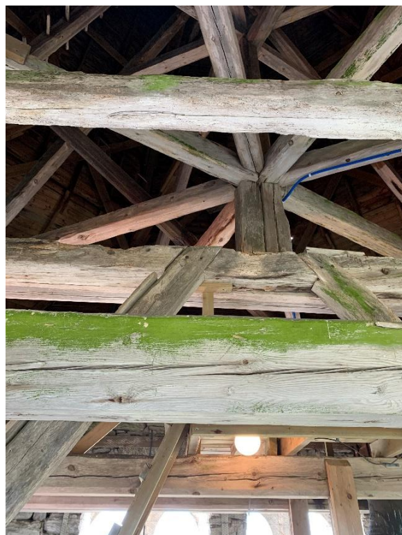
Klockväningens nordöstra hörn med de i muren infällda ankarbjälkarna. Foto JL 2021. Till höger blick upp mot tornhuvens bärverk med en bockkonstruktion som bär stjärnan i tornhuvens botten. Foto Ola Nyström 2021, Gotlands Museum.
