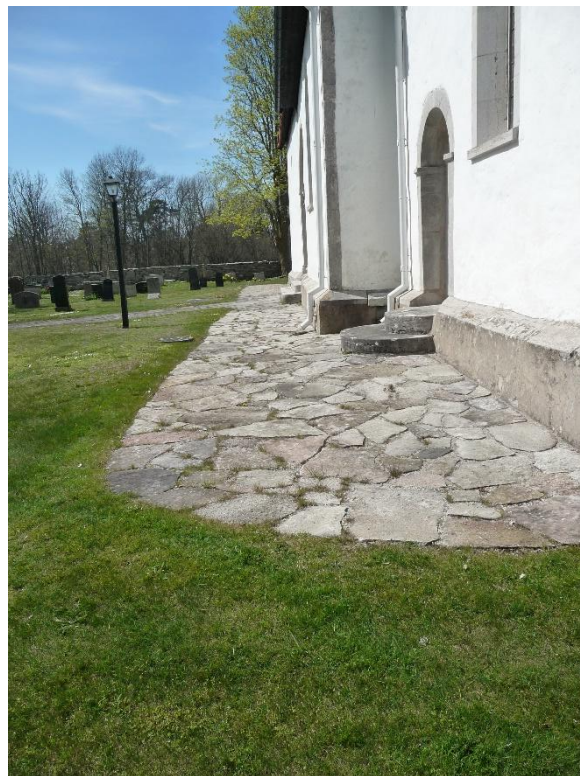
Invid kyrkans södra sida finns en beläggning med kalkstensflis. Foto ES 2021.
