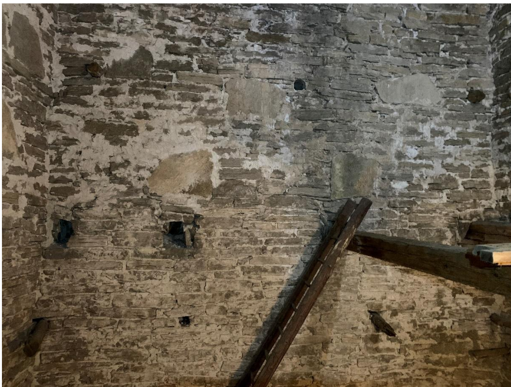
Tornets andra övervåning mot norr i höjd med det golvbjälklag som tidigare delat våningen i två. De runda hålen ovanför och nedanför utgör sannolikt bombhål för byggnadsställningen, varav några rester sitter kvar. I murens övre del ändras murningstekniken och stora stenblock eller hällar har använts. Foto Ola Nyström 2021, Gotlands Museum.
