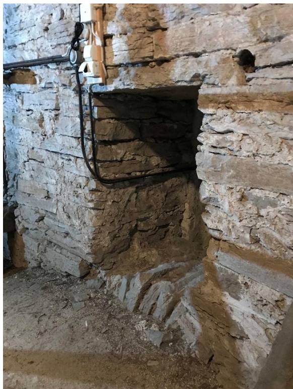
Passage från tornvinden till långhusvinden, sedd från sydväst och från öster. Öppningen löper med murad, rak omfattning genom torn- och långhusmuren. I tornmurens tröskel är stenar lagda på högkant i valvformation. Tornmuren vilar på den yttre, östligaste delen av valvet över ringkammaren. Foto JL 2021.
