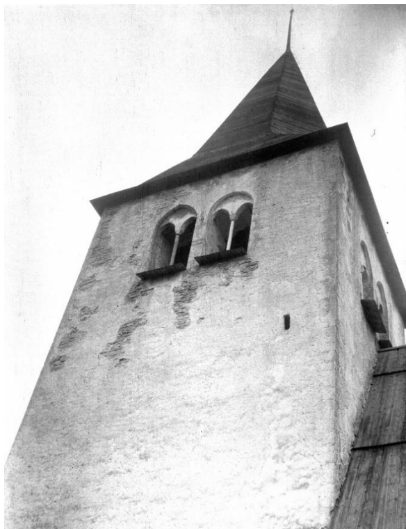
Tornet från sydöst. Foto 1909, ATA, RAÄ. Putsen är i dåligt skick men foton från 1916 visar att den lagats däremellan. Till höger exteriör från söder. Foto (Alfred Edle?) 1933 (beskuret), ATA, RAÄ. Spritputsen är kvar. Den utbyttes 1956 mot slätputs, varvid långhusets faltak byttes mot tegel. Skorstenen från 1938 har ännu inte tillkommit.
