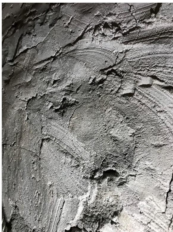
Brett utstruket bruk i murtrappans nedre del. Till höger ljuslugg till trappan. Foto JL 2021.
