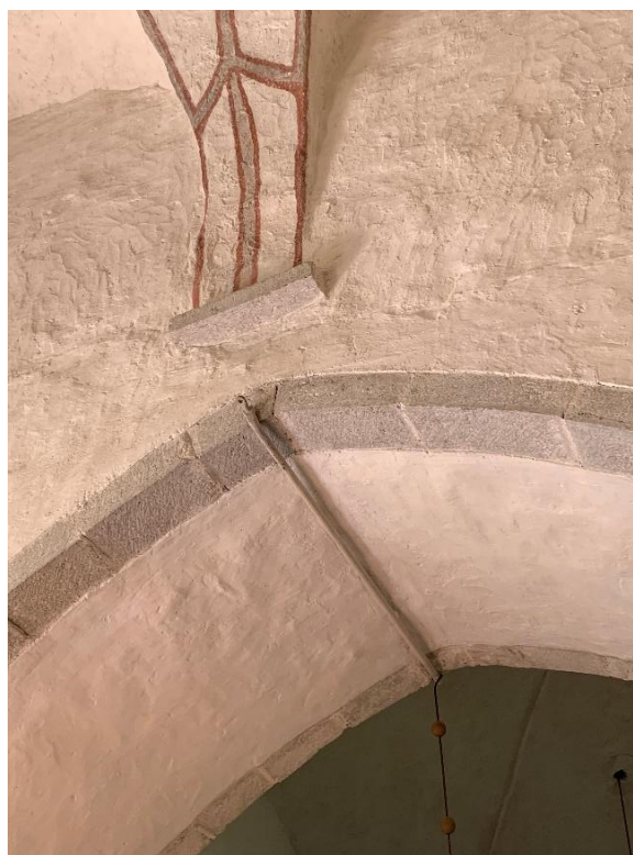
Långhusvalven sedda underifrån. Foto Ola Nyström 2021, Gotlands Museum. Till höger långhusets västra valvkonsol och tornbågen med äldre upphängningsanordning i metall. Foto JL 2021.
