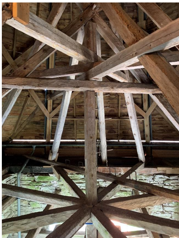
Tornhuvens nedre del med stjärna av bindbjälkar och mittstolpe under hanbjälkar och kryss, sedd mot öster. En tidigare spirstock med stigbyglar ligger lös. Foto Ola Nyström 2021, Gotlands Museum. Till höger blick upp i tornhuvnen. Foto JL 2021.
