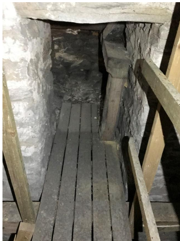
Genomgång från långhus- till korvinden med välmurad omfattning, sedd från sydväst och från öster med stöd för den längsgående hjärtbjälken. Skorstensstocken synlig i vänstra bildens borte kant. Foto JL 2021.
