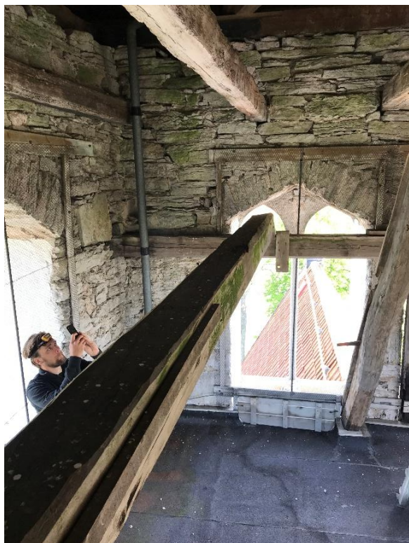
Klockväningens nordöstra hörn med de i muren infällda ankarbjälkarna. Foto JL 2021. Till höger blick upp mot tornhuvens bärverk med en bockkonstruktion som bär stjärnan i tornhuvens botten. Foto Ola Nyström 2021, Gotlands Museum.
