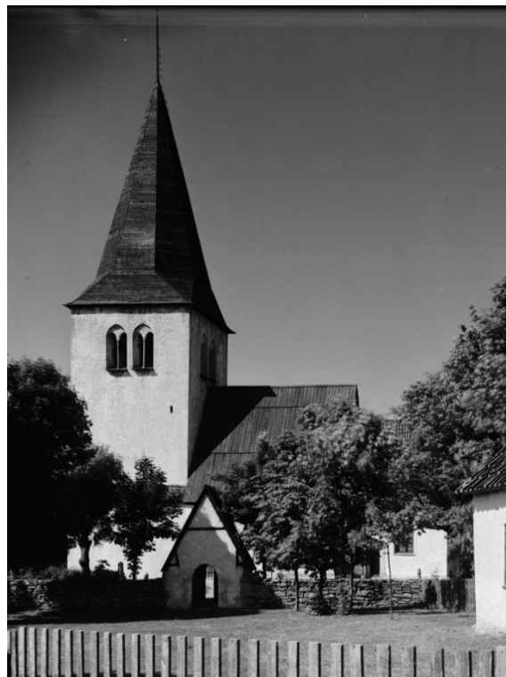
Tornet från sydöst. Foto 1909, ATA, RAÄ. Putsen är i dåligt skick men foton från 1916 visar att den lagats däremellan. Till höger exteriör från söder. Foto (Alfred Edle?) 1933 (beskuret), ATA, RAÄ. Spritputsen är kvar. Den utbyttes 1956 mot slätputs, varvid långhusets faltak byttes mot tegel. Skorstenen från 1938 har ännu inte tillkommit.
