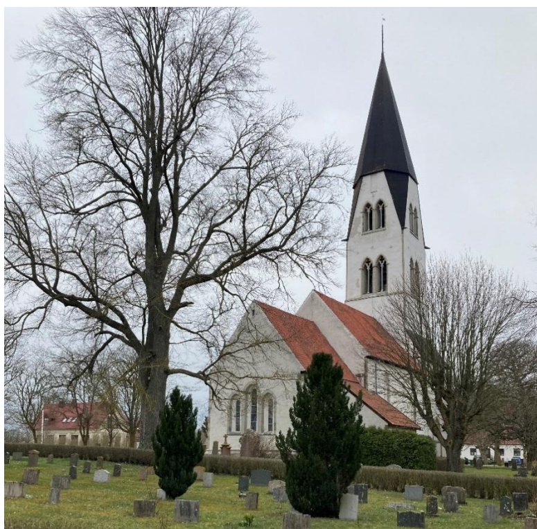
Exteriör från nordöst. Foto JL 2023.
