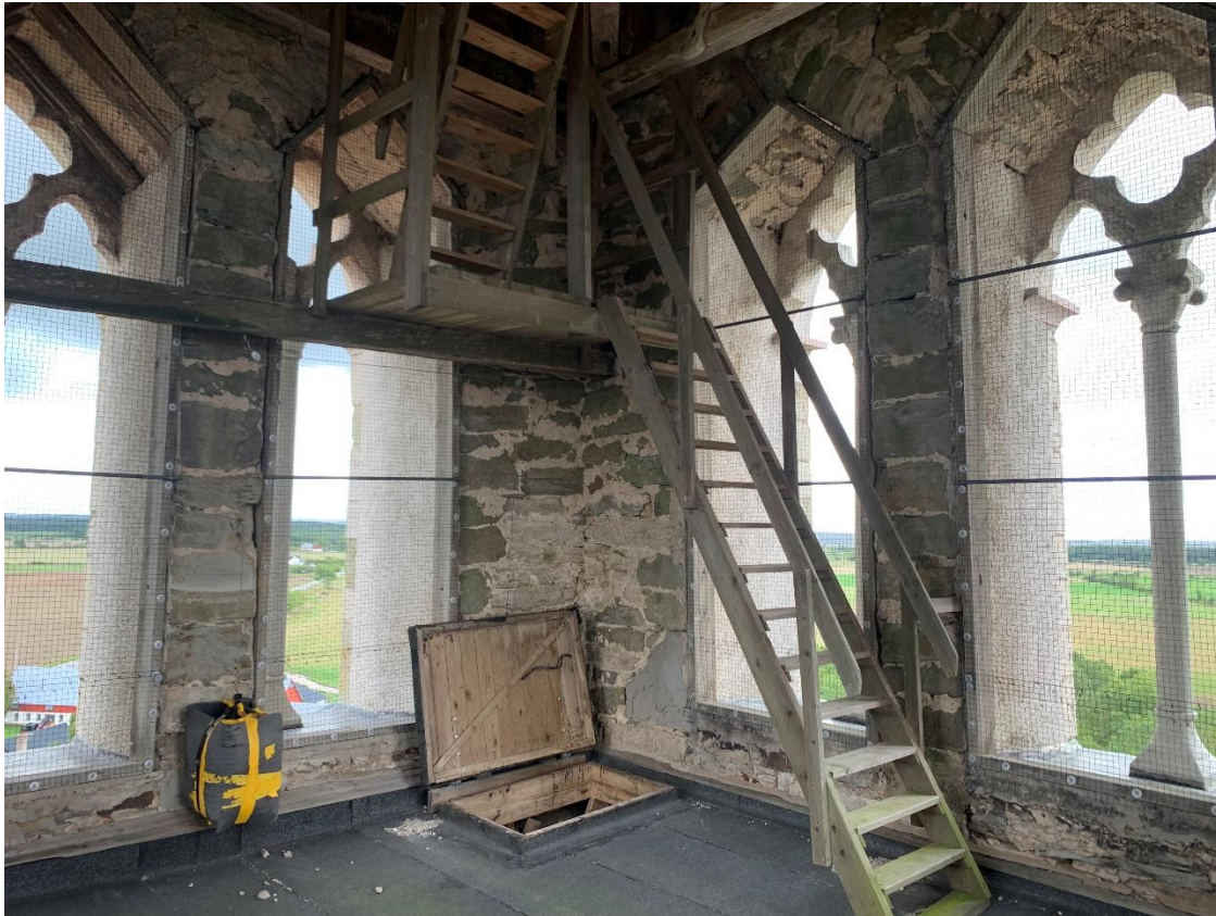
Tornets tredje övervåning med de övre ljudgluggarna. Foto JL 2023.
