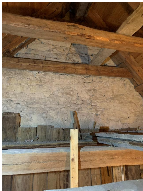
Ingång till kyrkvinden från tornet, sedd från långhusvinden. Till höger östra tornmuren med träväggen, troligen från 1800- eller 1900-talet av delvis återanvänt virke, och ovanför den stenar i den murade bågen mellan tornet och kyrkvinden. Foto JL 2023.
