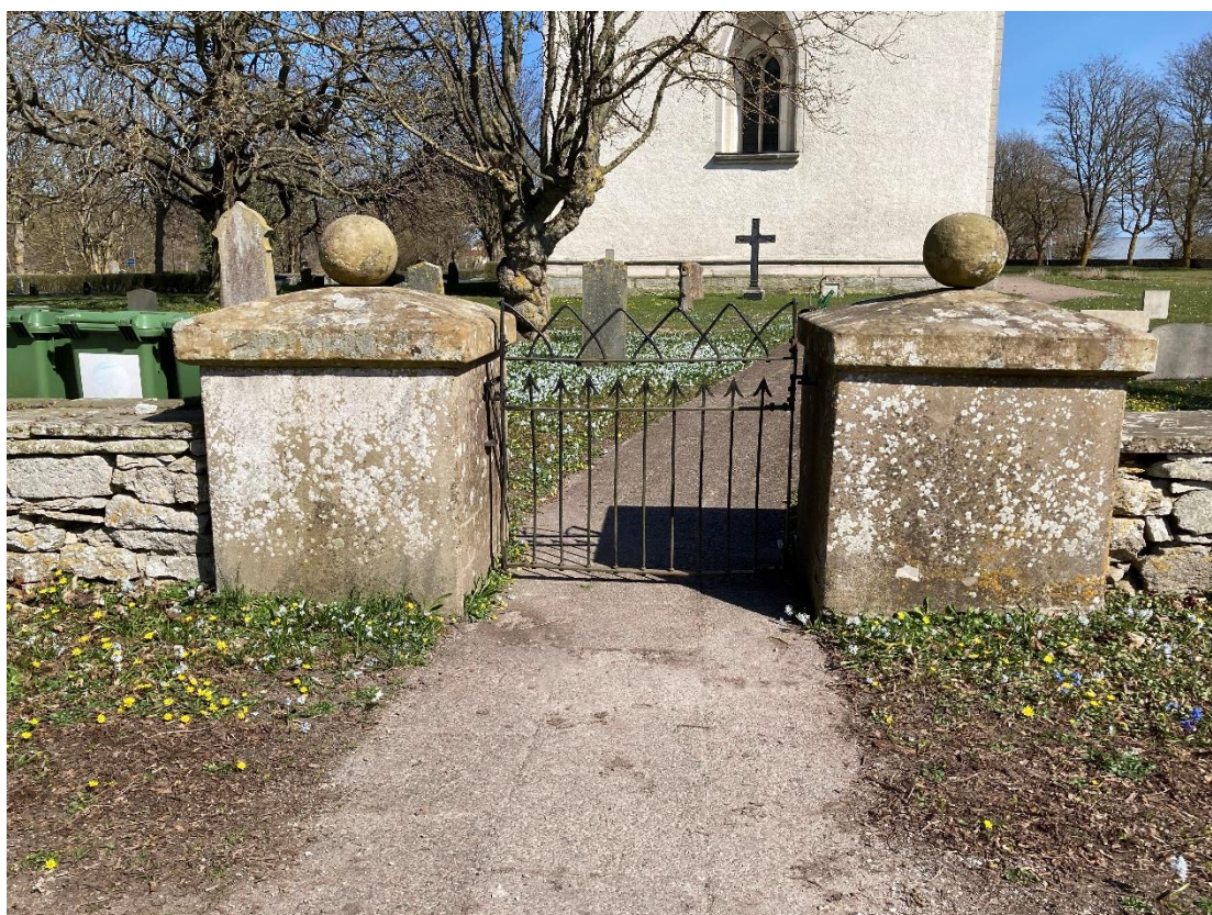
Den västra ingången med en enkel grind i svartmålat smide och murade och putsade fyrkantiga stolpar med pyramidformade överliggare som kröns av sandstensklot. Foto ES 2023.
