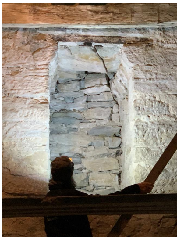
Igensatt öppning i östra muren, troligen tidigare passage till kyrkvindens övre del, igensatt när yttertaken sänktes, troligen 1817-1819. Till höger bjälklag mot klockvåningen. Foto JL 2023.
