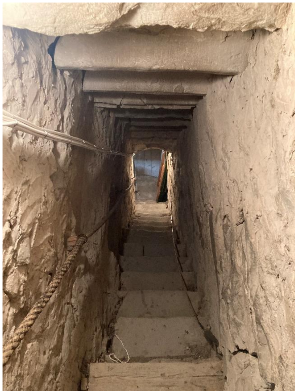
Murtrappa i tornets södra mur sedd ovanifrån mot öster. I taket är infäst återanvända eller ej använda byggnadsdelar. Trappan, som ingår i tornets första byggnadsfas, uppvisar sprickor. Foto JL 2023.
