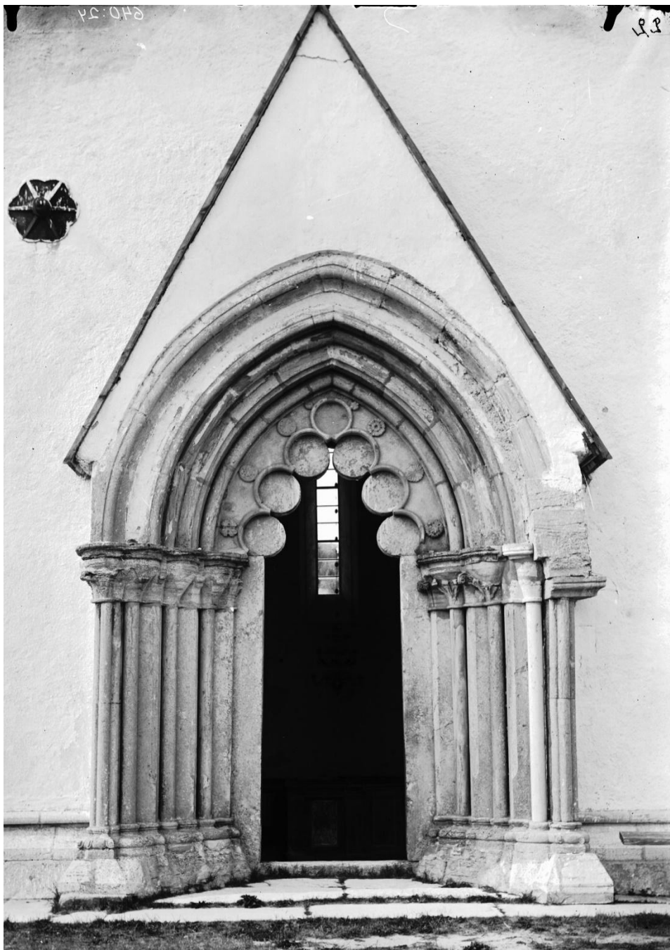
Långhusportalen före restaureringen 1915. Foto Olof Sörling 1889, ATA.
