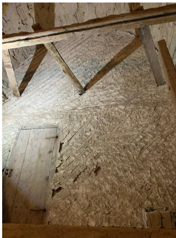
Tornets första övervåning mot öster med igensatt öppning till långhusvinden. Till höger detalj av igensättningen av öppningen samt dörr in till vinden. En bindbjälke under båge har en urskärning som kan vara från en tidigare vägg eller utgöra ett återanvänt virke från annan plats. Foto 2023.
