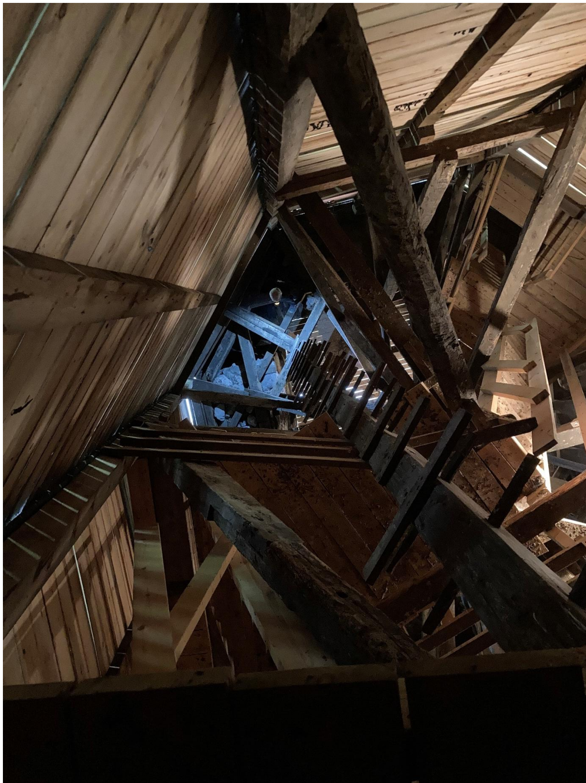
Tornhuvens inre sett ovanifrån. Foto ES 2023.
