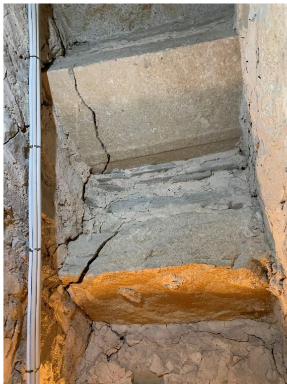
Murtrappa i tornets södra mur sedd ovanifrån mot öster. I taket är infäst återanvända eller ej använda byggnadsdelar. Trappan, som ingår i tornets första byggnadsfas, uppvisar sprickor. Foto JL 2023.
