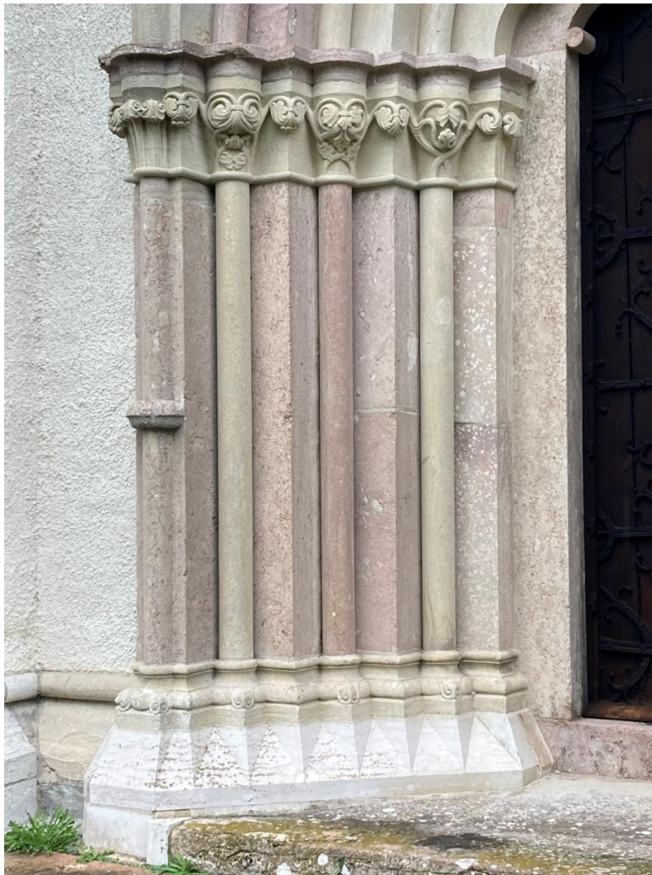
Korportalens västra post med kapitälband och basband. Foto JL 2023.
