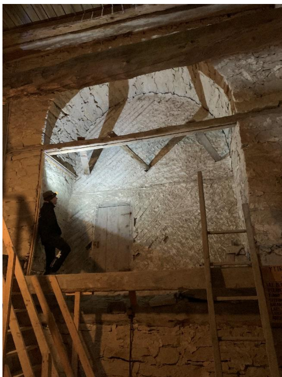
Tornets första övervåning mot öster med igensatt öppning till långhusvinden. Till höger detalj av igensättningen av öppningen samt dörr in till vinden. En bindbjälke under båge har en urskärning som kan vara från en tidigare vägg eller utgöra ett återanvänt virke från annan plats. Foto 2023.
