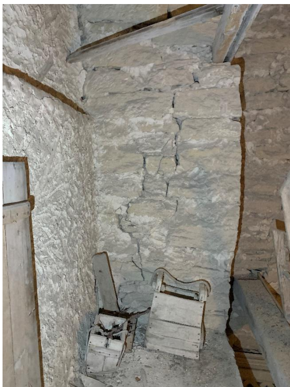
Den igensatta bågöppningens södra vederlag. Till höger första övervåningen sedd mot sydväst snett ovanifrån. Foto JL 2023.
