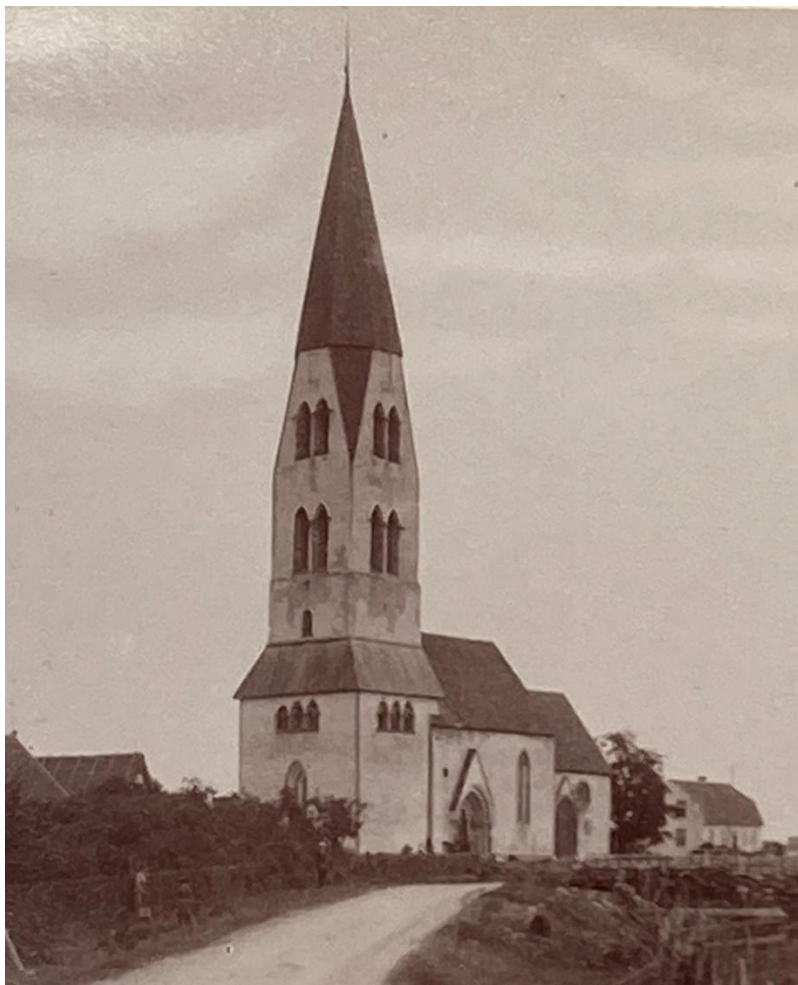
Exteriör från sydväst och söder i två foton av kyrkan från 1880-talet. Mellan bilderna tycks putsen i fasaderna ha reparerats och kalkats. Ljudgluggarna är skadade. Två av ankarjärnen i långhuset har ännu inte satts upp. Foto Olivia Wittberg respektive troligen Olof Sörling 1889, Gotlands Museums arkiv.
