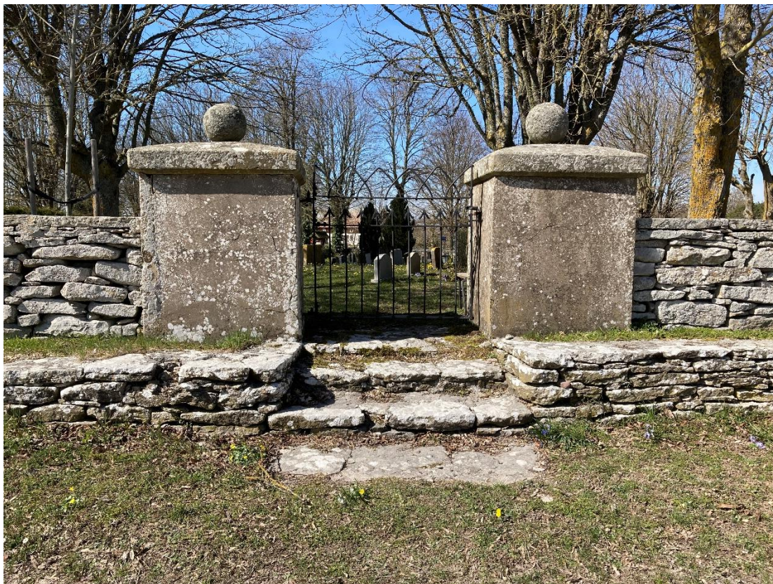
Ingång i den östra mursträckningen med en liknande utformning som den västra ingången. Foto ES 2023.
