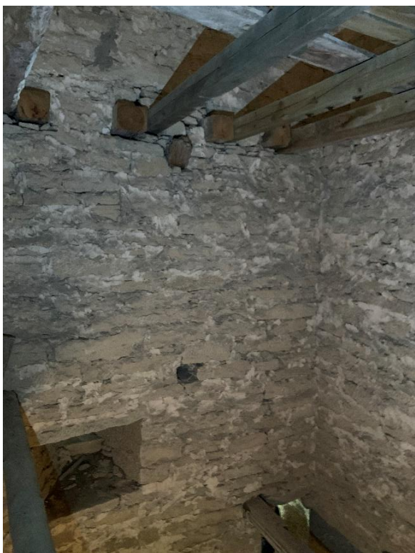
Tornets första övervånings övre del med bjälklag för tidigare golv sett underifrån mot sydväst och ovanifrån mot sydöst. Foto JL 2023.
