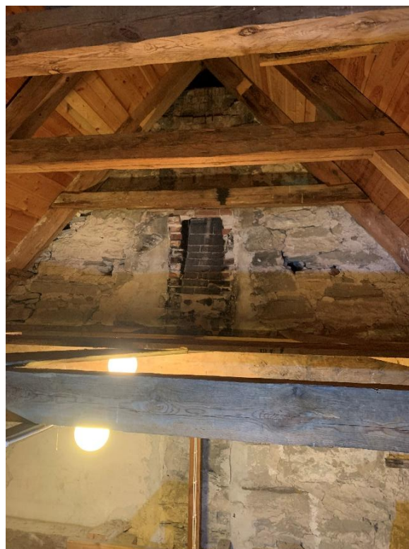
Triumfbågsmuren från väster med synliga spår av korets kringbyggda korgavel med delvis kvarsittande puts från korets byggnadstid under 1200-talets senare del. Till höger, spår av den 1913-1915 murade och 1998 bortbrutna skorstenen. Foto JL 2023.
