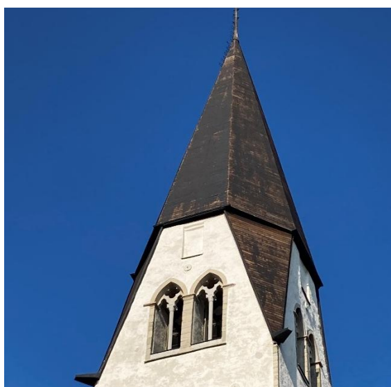
Tornhuven från sydväst. Foto JL 2023.
