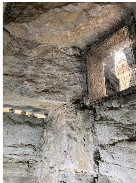
Murtrappans övre del som högst upp övergår i en kort spiraltrappa. I trappans överbyggnad ingår ljusgluggar som ger ljus från södra galleriet. Foto JL 2023.
