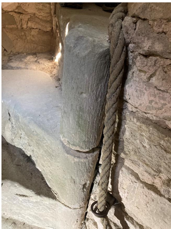
Murtrappans övre del som högst upp övergår i en kort spiraltrappa. I trappans överbyggnad ingår ljusgluggar som ger ljus från södra galleriet. Foto JL 2023.
