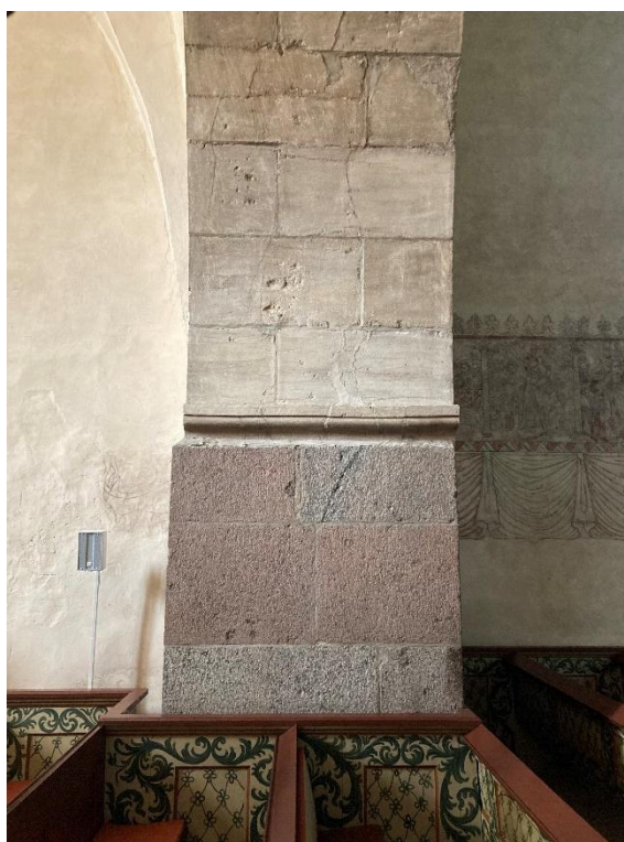
Tornbågens södra och norra vederlag med granitförstärkning från 1878. Foto JL 2023.
