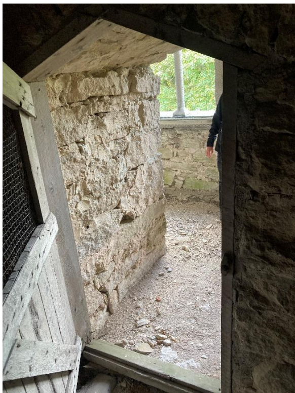
Utgång till gallerierna samt norra galleriet mot öster med murförstärkning från 1878. Foto JL 2023.
