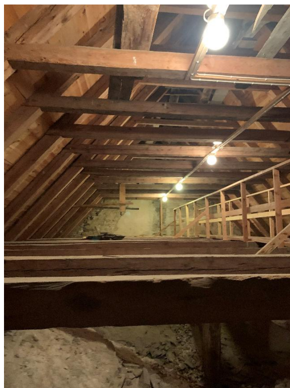
Långhusvinden sedd mot öster direkt ovanför valven samt ovanför bindbjälkarna. Foto JL 2023.
