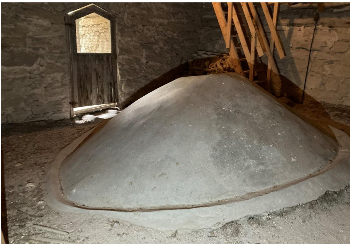
Tornets första övervåning mot nordöst med det av betong troligen 1913-1915 övermurade valvet samt utgång mot norr till gallerierna. Foto JL 2023.
