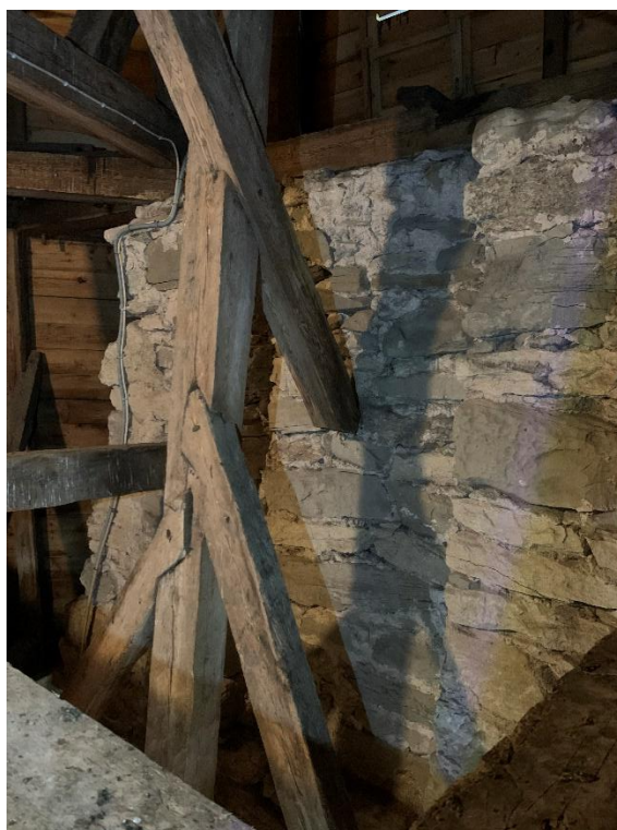
Svickel på tornhuven sedd ovanifrån. Till höger del av tornspirans bärverk. Foto JL 2023.
