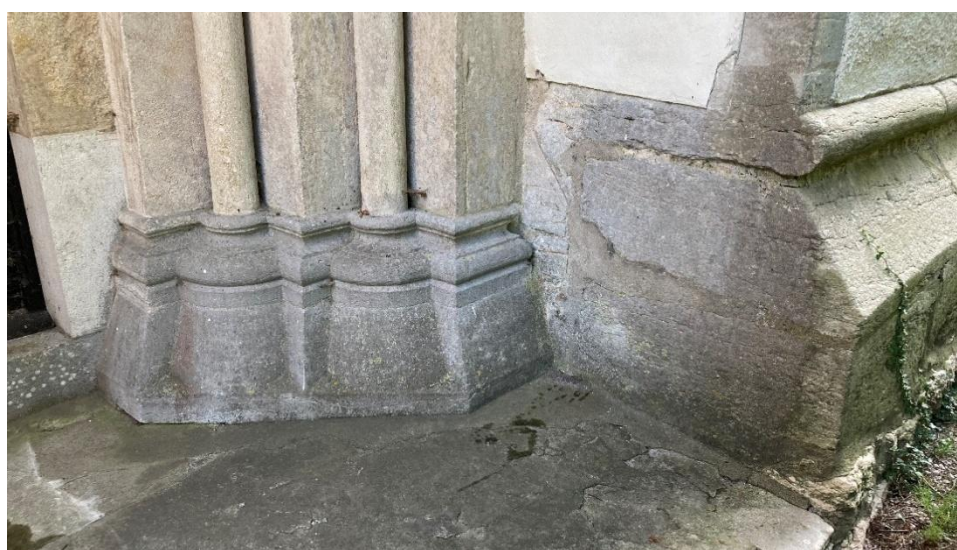
Tornportalens västra basband. Närmast portalen syns tornets äldre sockel, från innan muren breddades. Foto JL 2023.
