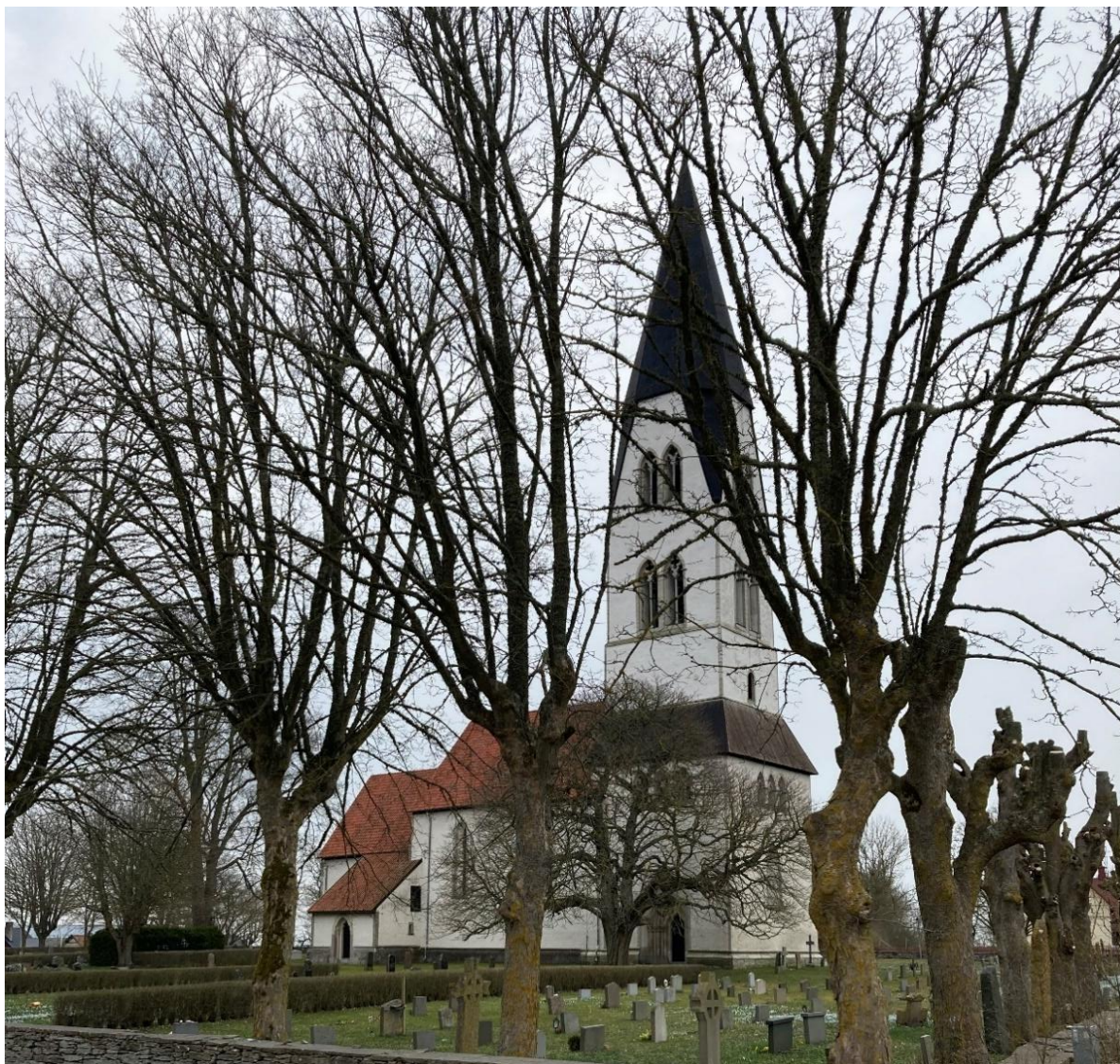
Exteriör från nordväst. Foto JL 2023.
