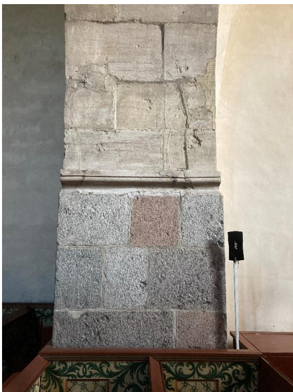
Tornbågens södra och norra vederlag med granitförstärkning från 1878. Foto JL 2023.
