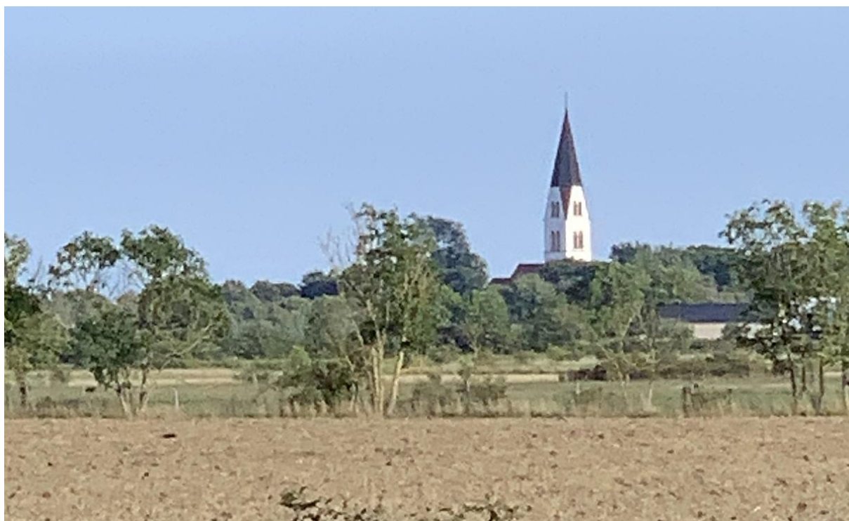
Rone kyrka från nordväst. Kyrktornet är synlig på långt avstånd i landskapet och har även utgjort ett sjömärke. Foto JL 2023.
