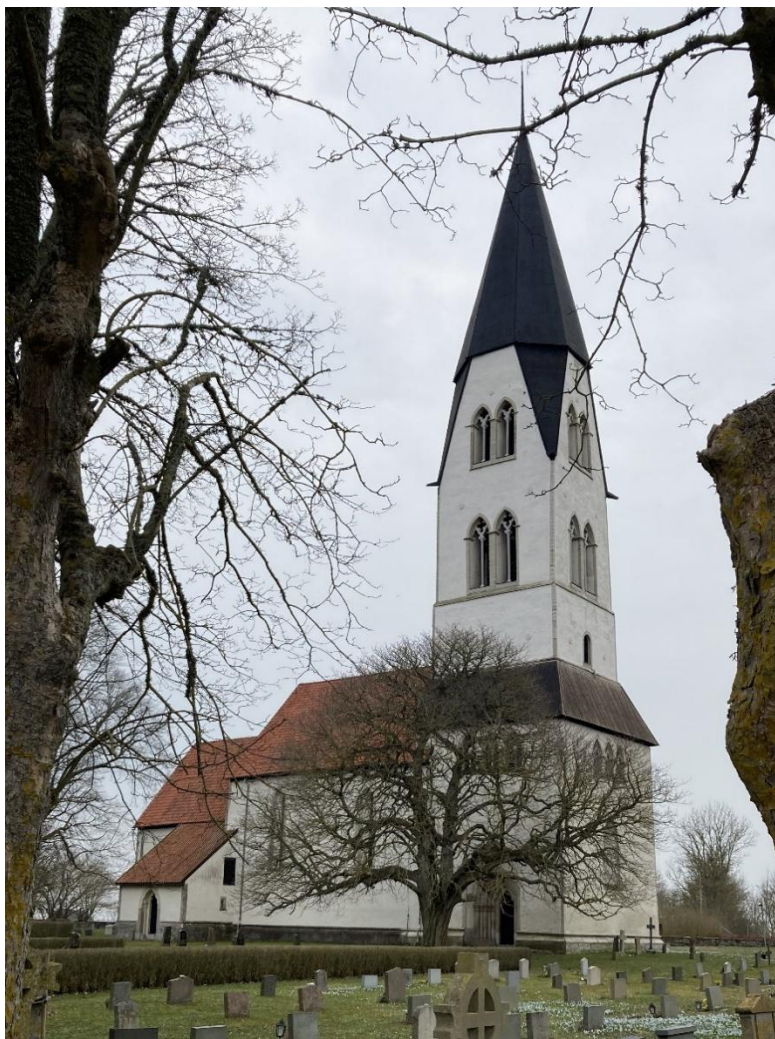
Exteriör från nordväst. Foto JL 2023.
