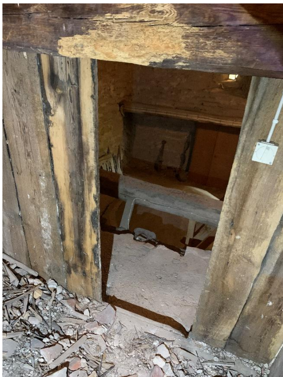
Ingång till kyrkvinden från tornet, sedd från långhusvinden. Till höger östra tornmuren med träväggen, troligen från 1800- eller 1900-talet av delvis återanvänt virke, och ovanför den stenar i den murade bågen mellan tornet och kyrkvinden. Foto JL 2023.
