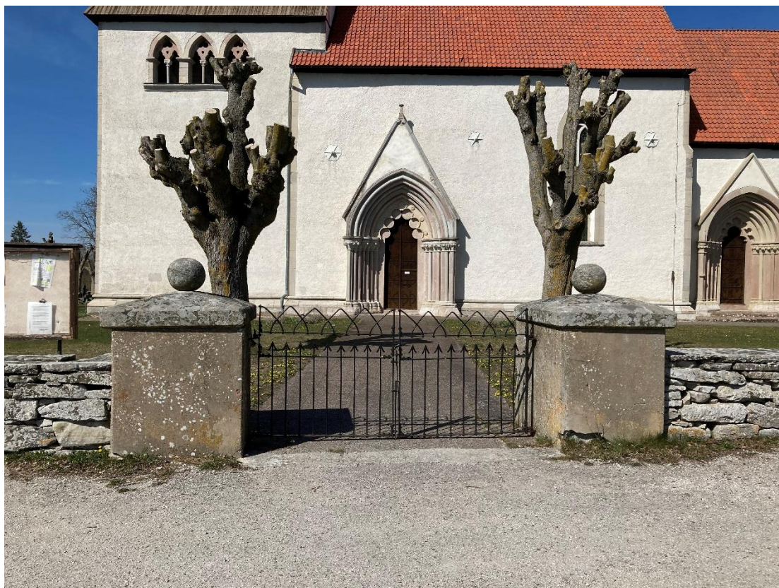
Den södra huvudingången med grindar i svartmålat smide och murade och putsade fyrkantiga stolpar med pyramidformade överliggare som kröns av sandstensklot. Foto ES 2023.
