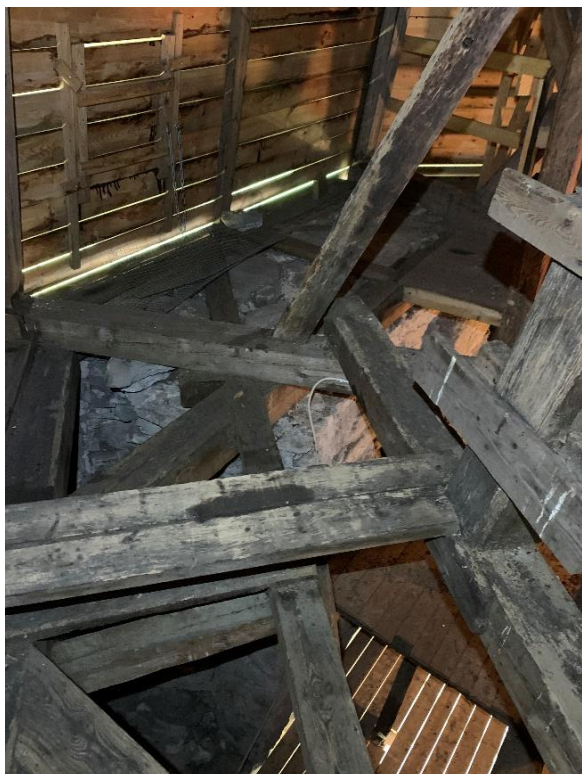
Bärverk för tornhuvens övre del, lagd på de kapade gavlarnas krön. Till höger blick uppåt i tornhuv. Foto JL 2023.
