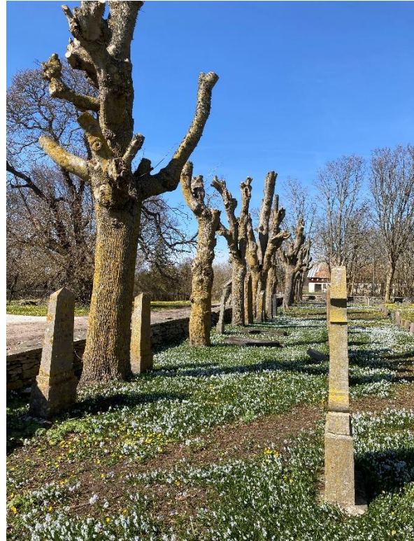
Den västra mursträckningen fotograferad från söder. Foto ES 2023.
