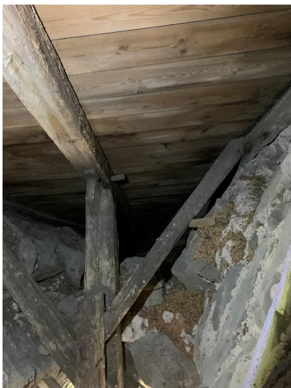
Svickel på tornhuven sedd ovanifrån. Till höger del av tornspirans bärverk. Foto JL 2023.
