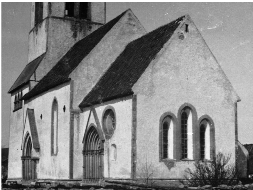
Detalj av föregående. Observera spår av korets tidigare högre takfall samt det nedre korfönstrets enkla omfattning före 1910-talets restaurering. Nedan tornet med sina skadade ljudgluggar, sett från nordväst och sydväst. Foto Johnny Roosval ca 1905 (detalj) respektive av okänd fotograf ca 1910, ATA.
