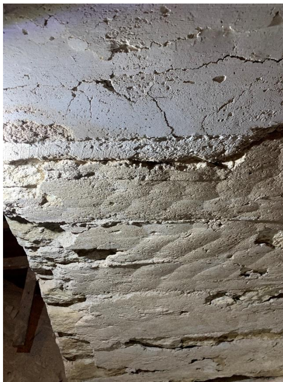
Triumfbågsmurens vindsöppning sedd från öster med norra vederlaget och den 1913-1915 inbyggda rökkanalen från kaminen. Till höger del av bågen med avtryck av skälbräder från byggnadstiden med olika träbehuggning. Den översta släta brädan möjligen från skorstensstockens byggnadstid på 1910-talet. Foto JL 2023.
