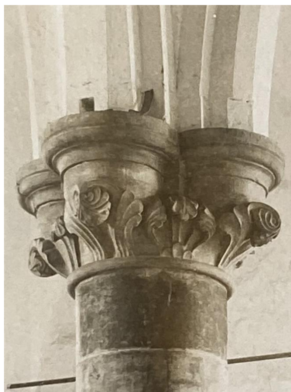
Hål mot väster på ovensidan av långhuskolonnens kapitel. Troligen för en hissbom till ett dopfuntslock vilket kan visa att dopfunten varit placerad på kolonnens västra sida. Till höger samma kapitel före restaureringen 1913-1915 med något som möjligen är ett inmurat järnbeslag för bommens infästning. Foto JL 2023 respektive Louis Nilsson 1898, Gotlands Museums arkiv (detalj).
