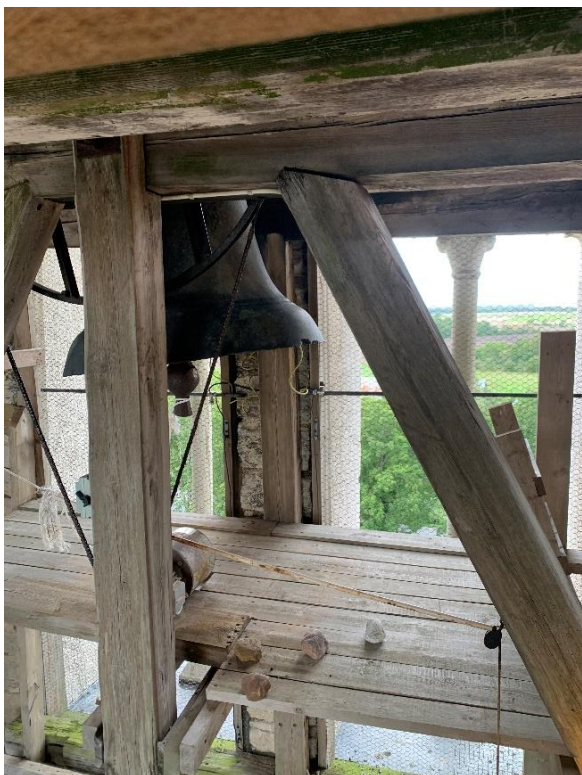
Klockvåningen mot norr med klockupphängning och kimbningsstenar samt dess övre del mot väster. Foto JL 2023.
