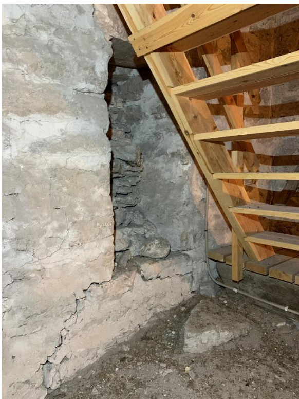
Tornets första övervåning med igenmurad tidigare öppning i tornets östra mur som en gång var utgång till äldre kyrkans vind. Till höger avtryck i putsen av en tygtrasa. Foto JL 2022.
