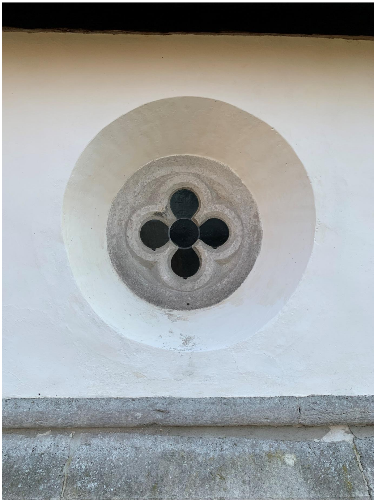
Fyrpassformat fönster i sakristians nordmur. Ursprungligen från den medeltida prästgården. Något kompletterat och insatt under 1920-talet på platsen för ett sentida rektangulärt fönster. Foto JL 2022.
