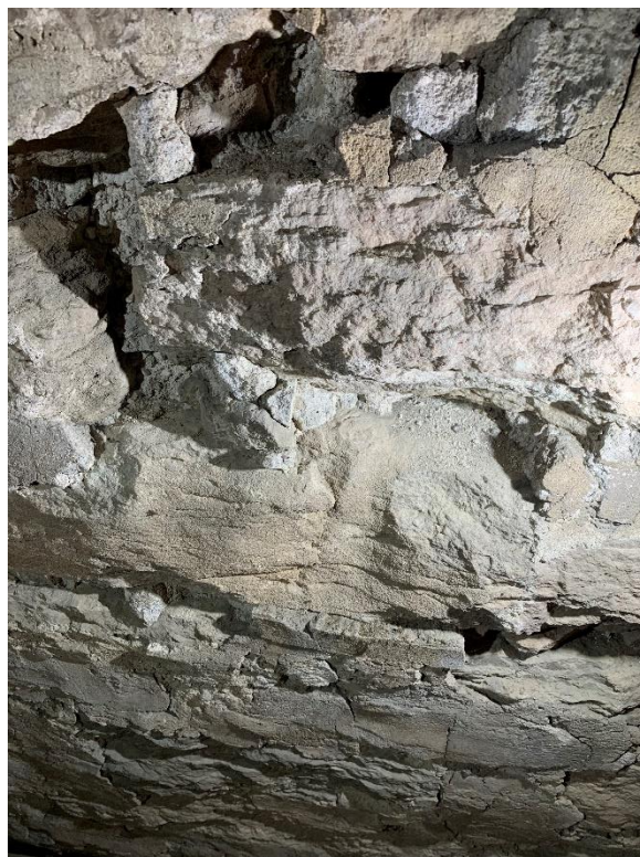
Ljusglugg mot väster i tornets andra övervåning. Till höger skador i murverket som kan tyda på en tidigt inträffad eldsvåda. Foto JL 2022.
