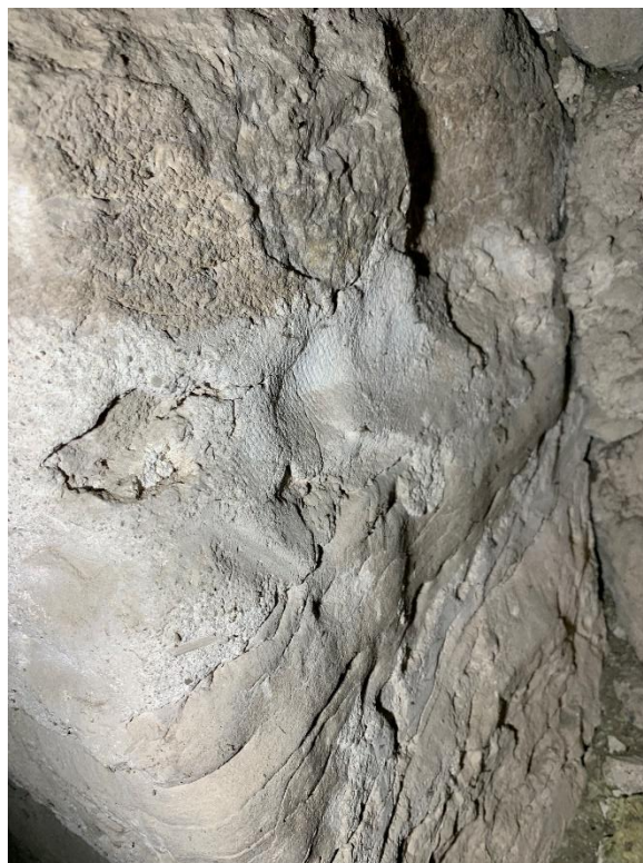
Tornets första övervåning med igenmurad tidigare öppning i tornets östra mur som en gång var utgång till äldre kyrkans vind. Till höger avtryck i putsen av en tygtrasa. Foto JL 2022.
