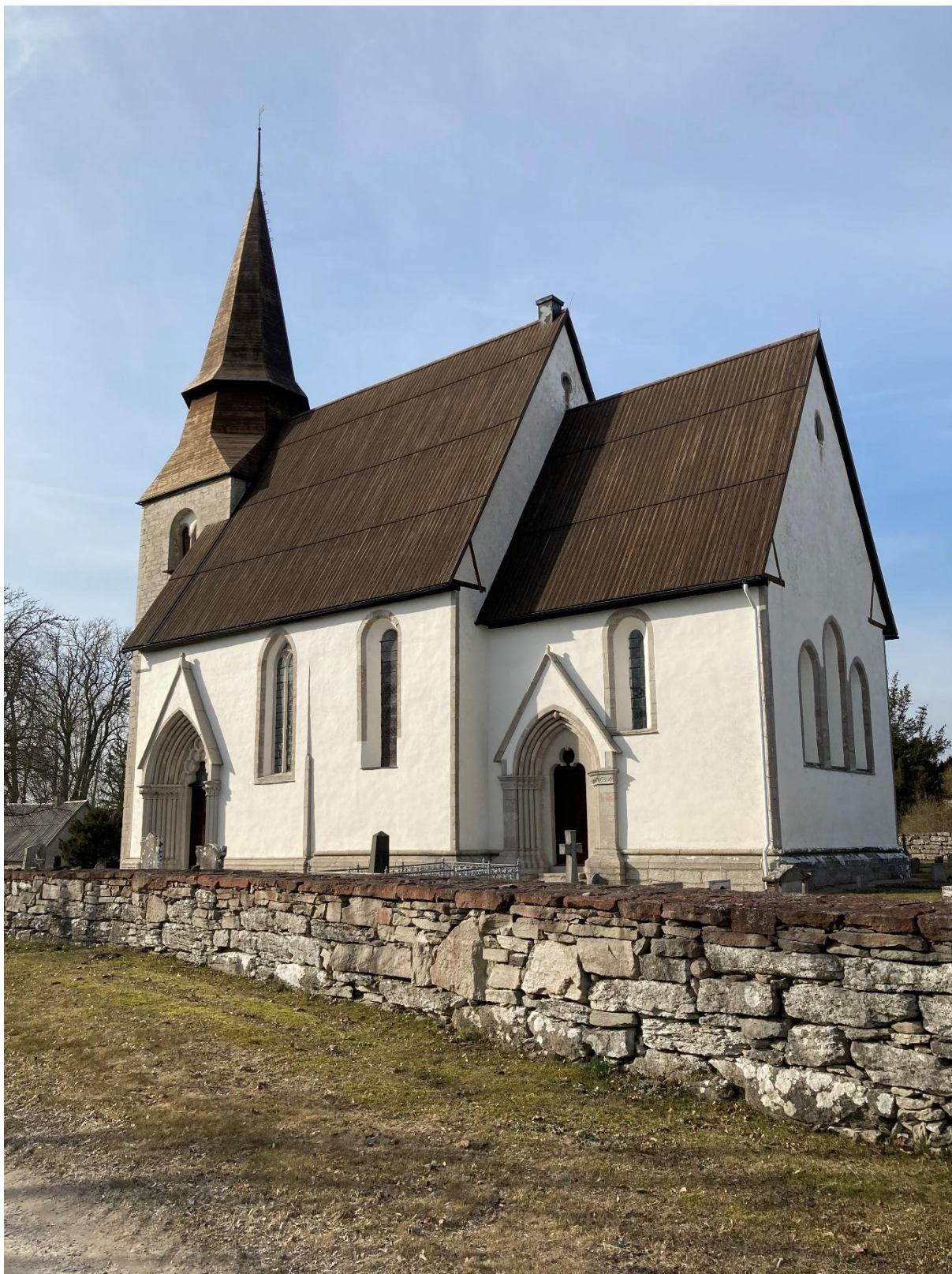
Fole kyrka fotograferad från sydost. Närmast syns den södra mursträckningen med stenar av olika storlek varav flera större i basen vilket ger muren en ålderdomlig karaktär. Foto ES 2022.
