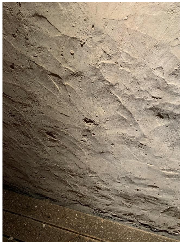
Sakristievinden mot öster. Till höger detalj av putsen, troligen från 1200-talets mitt. Foto JL 2022.
