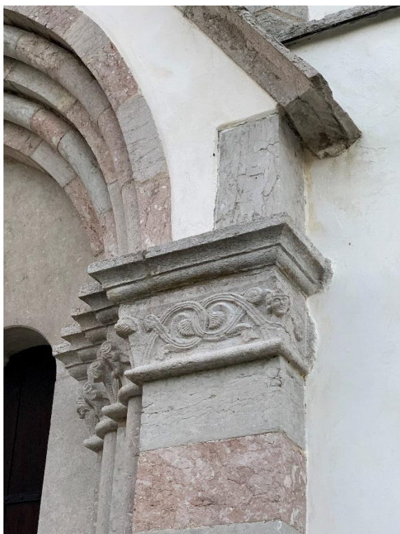
Korportalens östra del visande växelmurningen i röd och grå kalksten. Till höger del av runinskrift på inre västra posten. Foto JL 2021.
