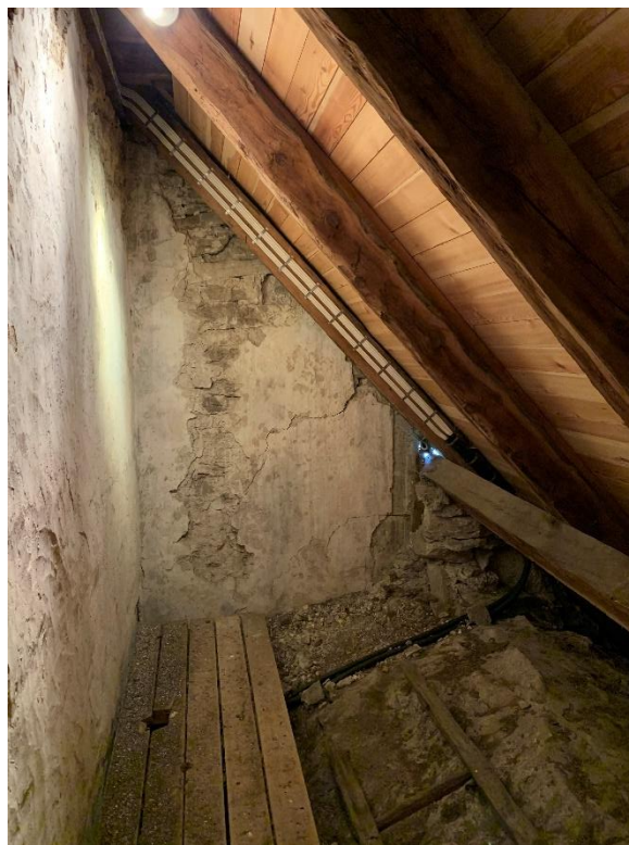
Korvinden mot öster. Till höger sakristievinden mot väster. Att yttermurarna är putsade visar att sakristian inte är helt samtida med koret. Foto JL 2022.
