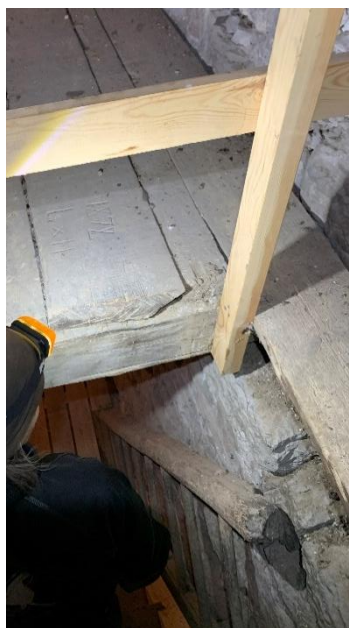
Tornets andra övervåning mot öster. Till höger inskrivet årtal 1872 i golvplankorna samt den äldre stegen, sparad vid den yngres sida, men inbyggd. Foto JL 2022.
