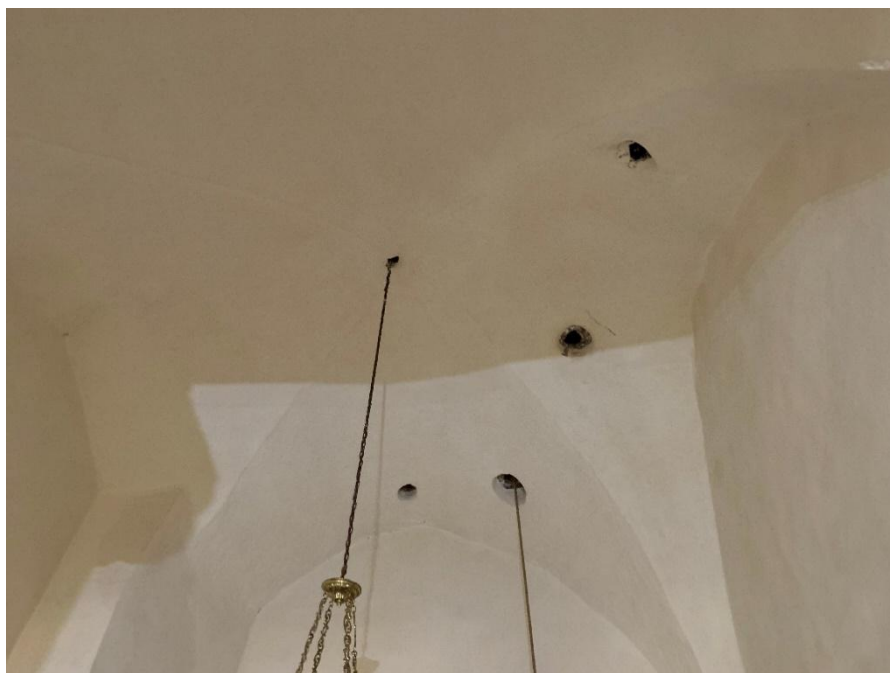
Ringkammarens valv sett mot väster. Foto JL 2022.
