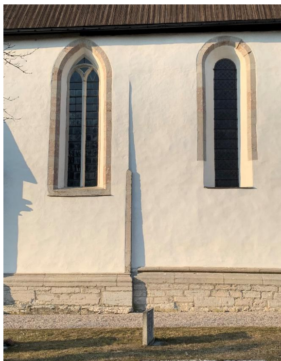
Exteriör från söder. Till höger långhusets fönster och den tydliga skarven mellan bygnadsdelarna. Det högra fönstret troligen förlängt nedåt. Foto Pär Malmros 2020, Visby stift, respektive JL 2022.
