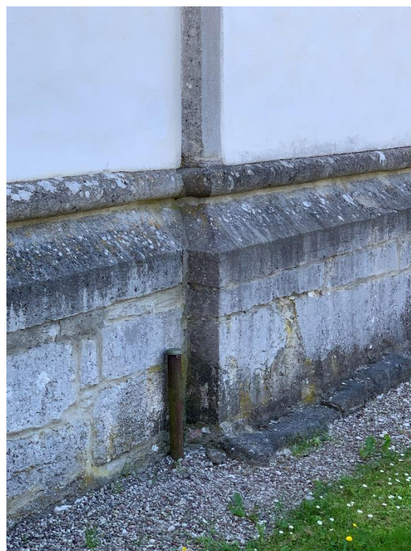
Skarv mellan långhusets äldre östra och yngre västra del. Till höger närbild av sockeln. Foto JL 2022.
