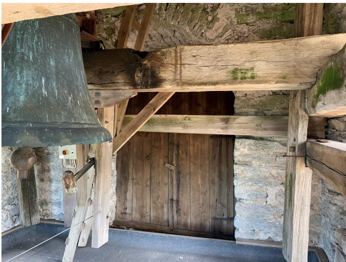
Klockvåningen sedd mot öster med passage till vinden genom tidigare östra ljudgluggen. Foto JL 2022.
