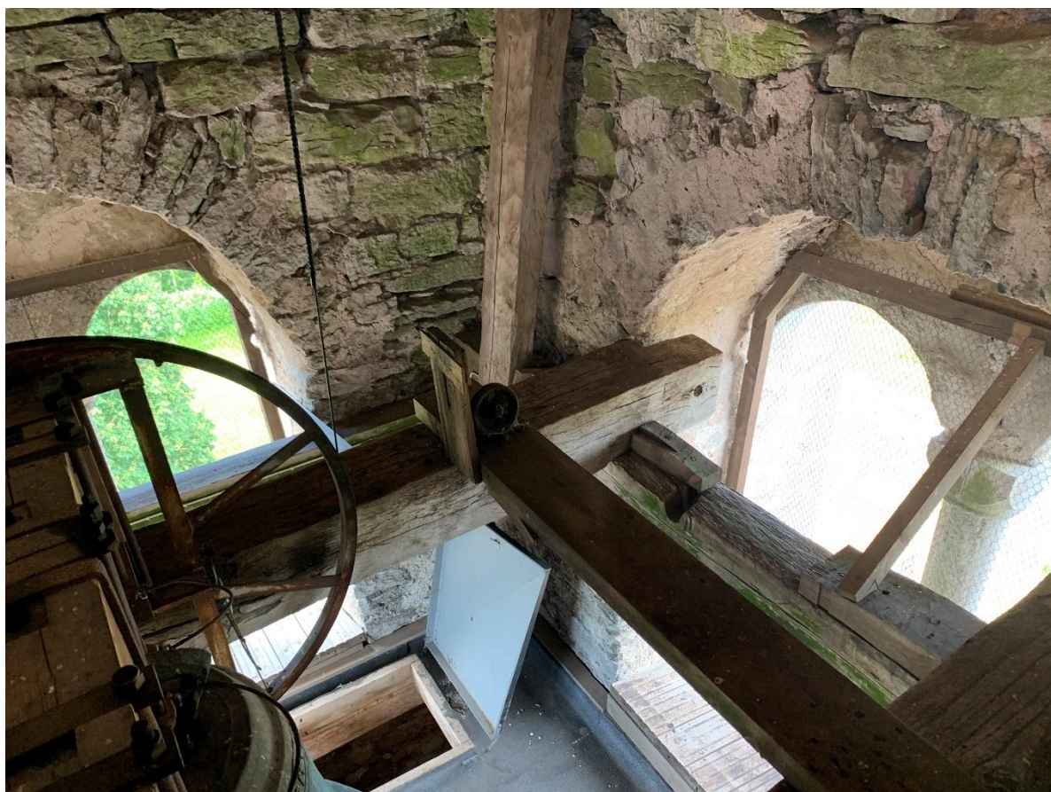
Klockvåningens nordvästra hörn. Foto JL 2022.
