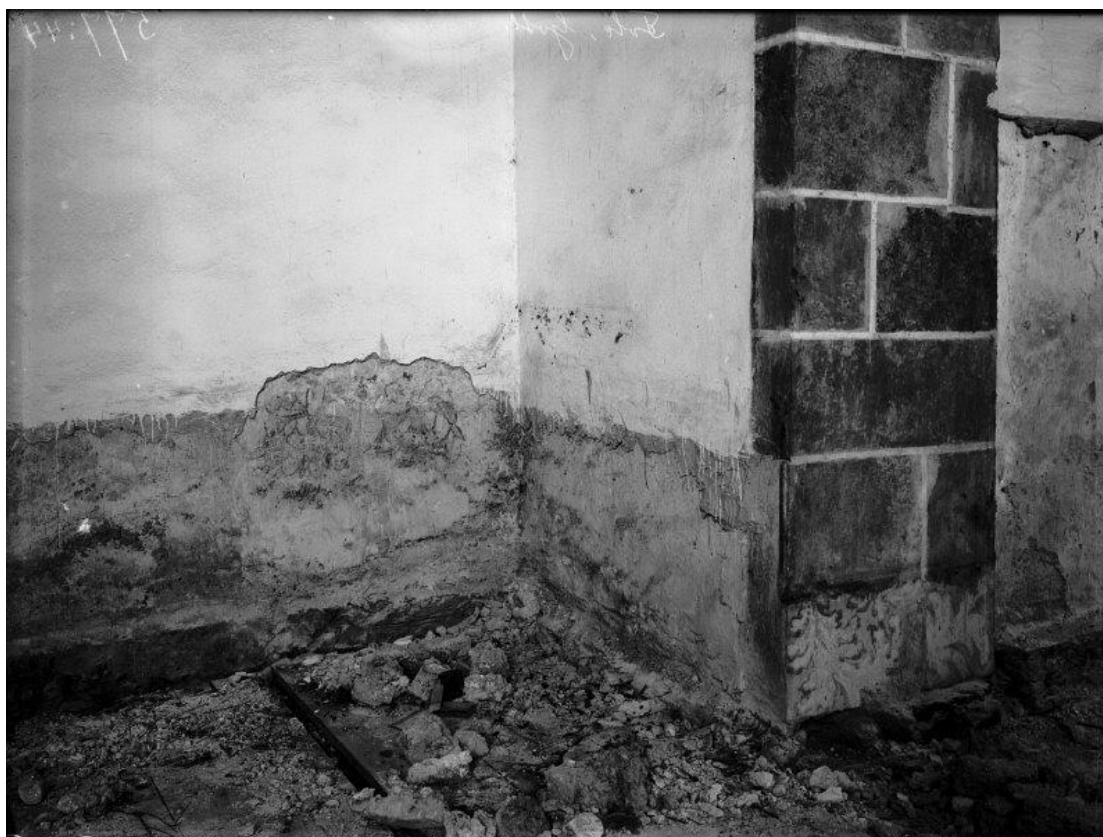
Långhusets nordöstra hörn och triumfbågen under restaurering med frilagda spår av målad dekor, troligen från 1700-talet. Foto Alfred Edle 1923, ATA.
