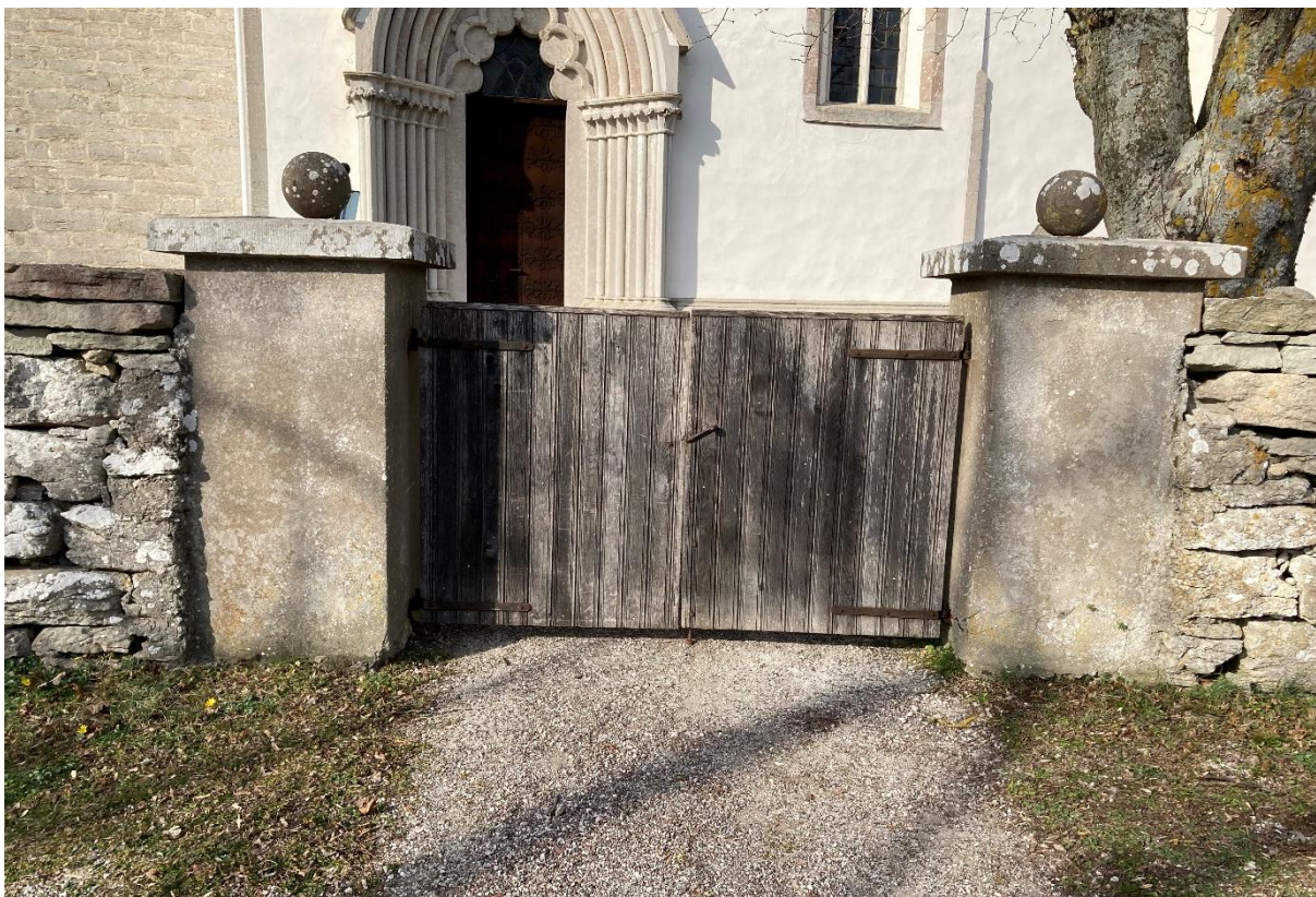
Den södra ingången med dubbel trädgrind mellan murade stolpar med överliggare av kalksten krönt av klot. Foto ES 2022.
