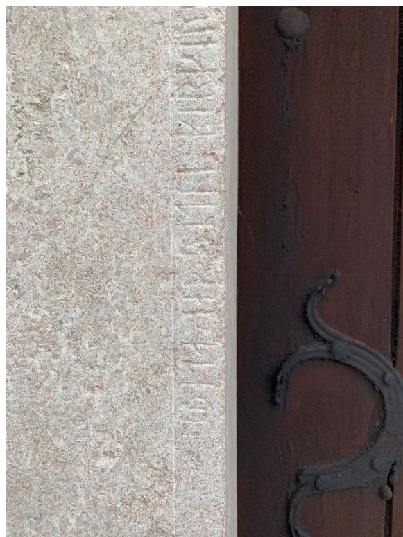
Korportalens östra del visande växelmurningen i röd och grå kalksten. Till höger del av runinskrift på inre västra posten. Foto JL 2021.
