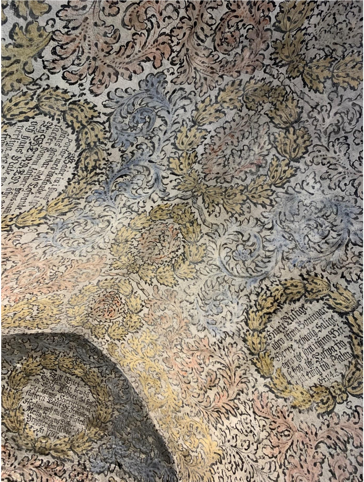
Sakristians valv sett mot nordväst med kalkmålning från 1707. Foto JL 2022.
