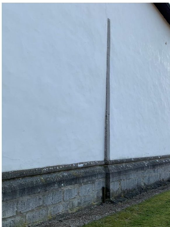
Skarv mellan långhusets äldre östra och yngre västra del. Till höger närbild av sockeln. Foto JL 2022.
