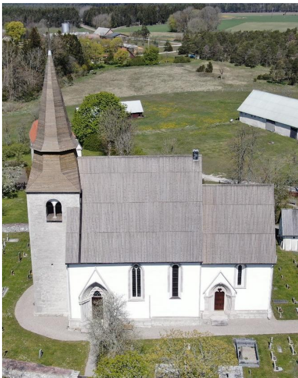
Exteriör från söder. Till höger långhusets fönster och den tydliga skarven mellan bygnadsdelarna. Det högra fönstret troligen förlängt nedåt. Foto Pär Malmros 2020, Visby stift, respektive JL 2022.
