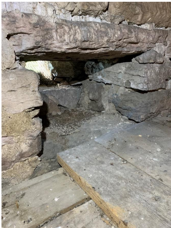
Ljusglugg mot väster i tornets andra övervåning. Till höger skador i murverket som kan tyda på en tidigt inträffad eldsvåda. Foto JL 2022.
