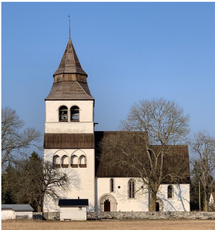
Exteriör från söder. Foto JL 2022.
