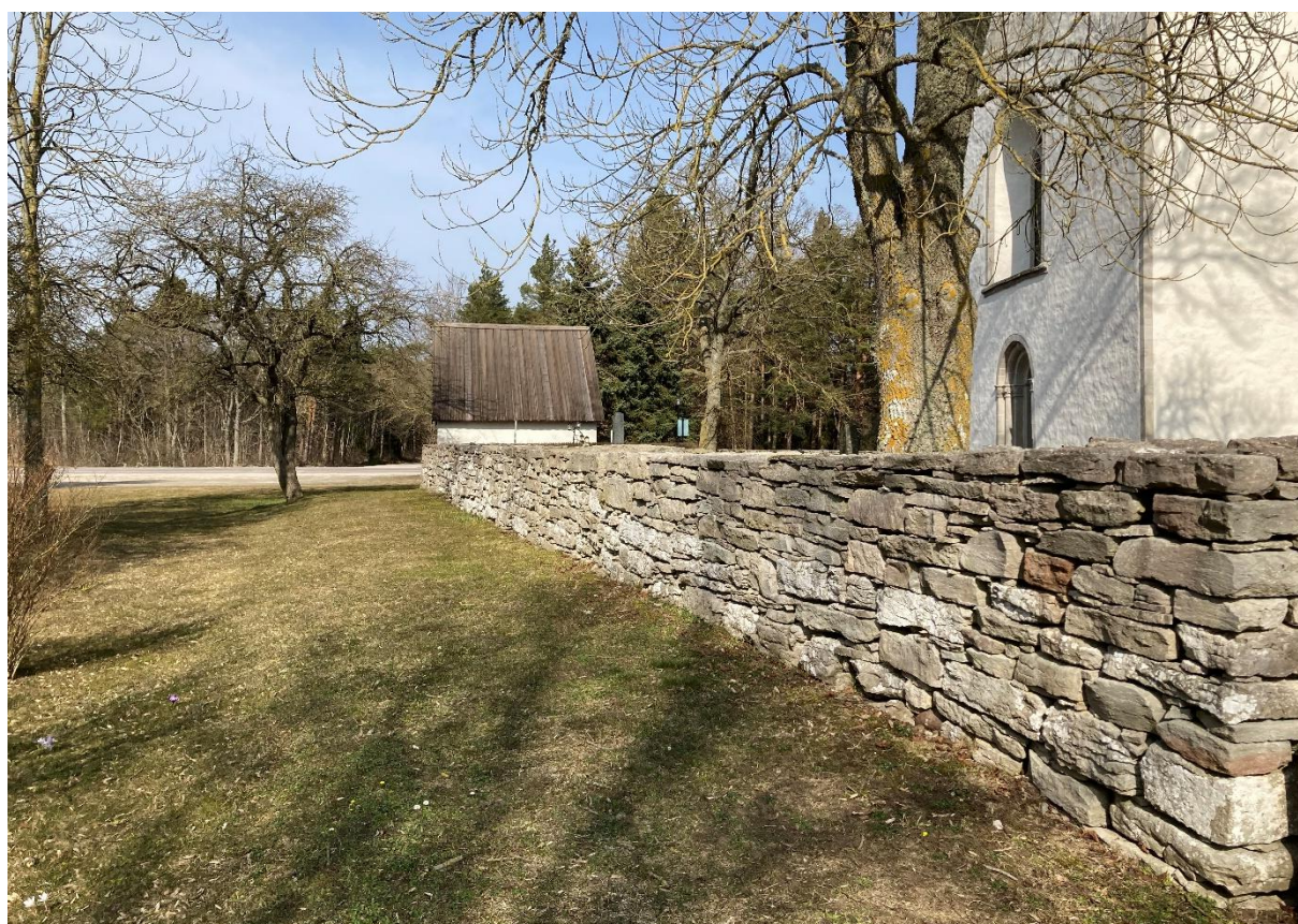
Den västra mursträckningen fotograferad från söder. Foto ES 2022.
