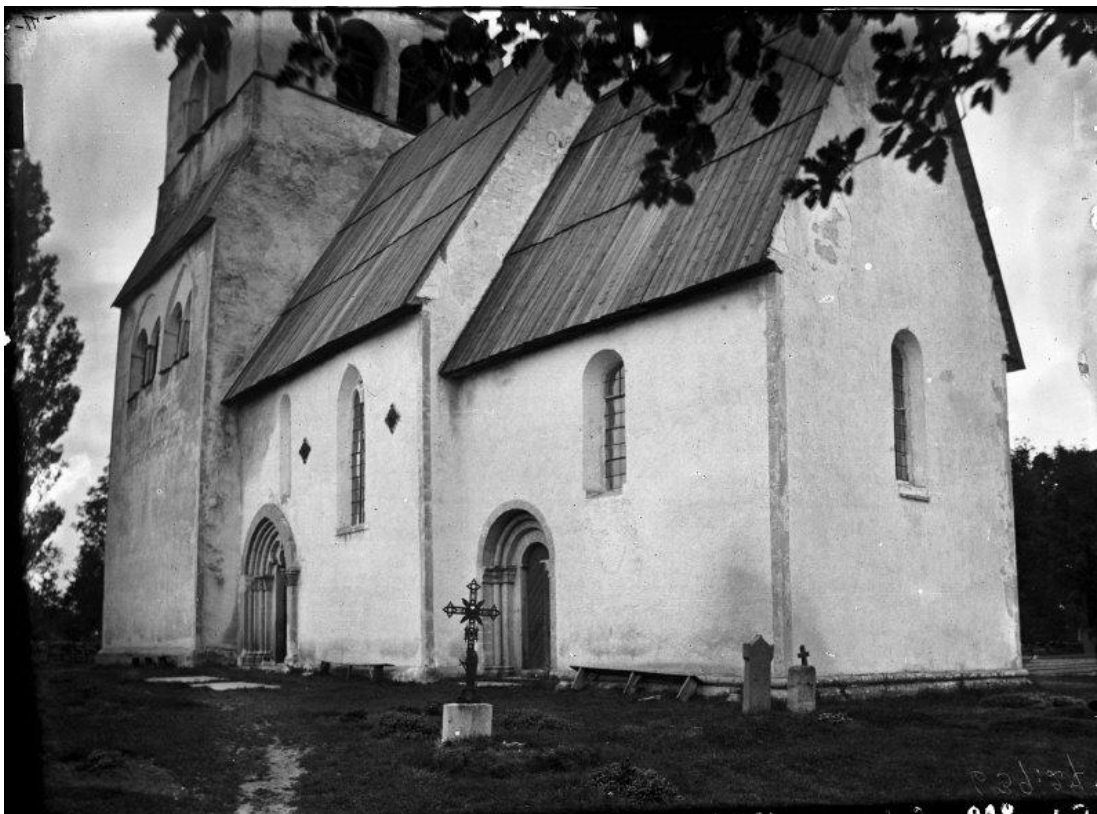
Sydost om kyrkan syns gjutjärnskorset tillverkat av K G Quarnström i mitten av 1800-talet Foto Olof Sörling 1890. Kyrkogården är bevuxen med gräs och en stig leder fram till södra långhusporten. I övrigt finns flera gravkullar RAÄ, Kulturmiljöbild.
