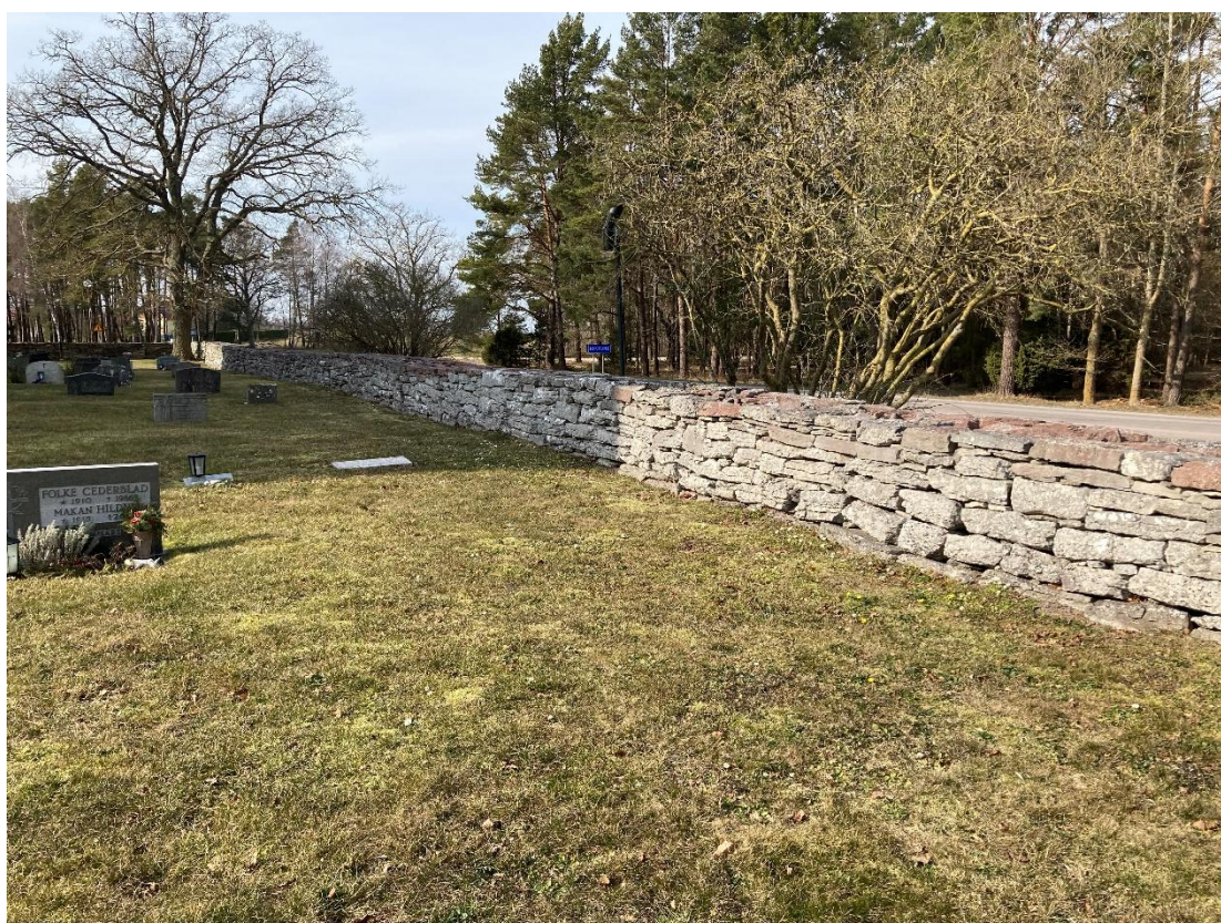
Den norra mursträckningen fotograferad från öster. I nordvästra hörnet växer en stor ek. Foto ES 2022.
