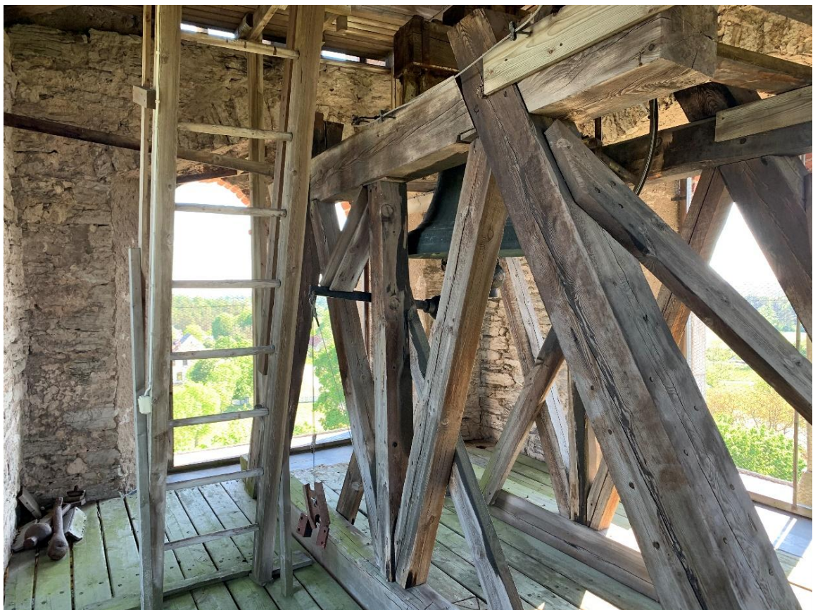
Klockvåningen mot sydväst. Foto JL 2021.
