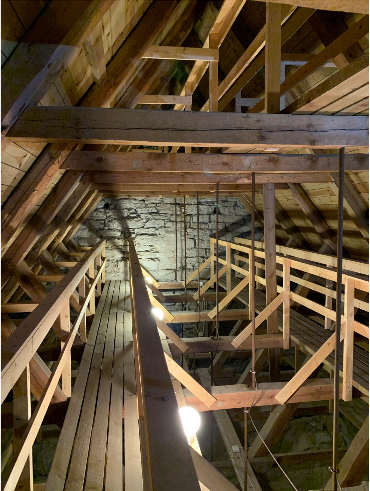
Långhusvinden mot väster. Foto JL 2021.
