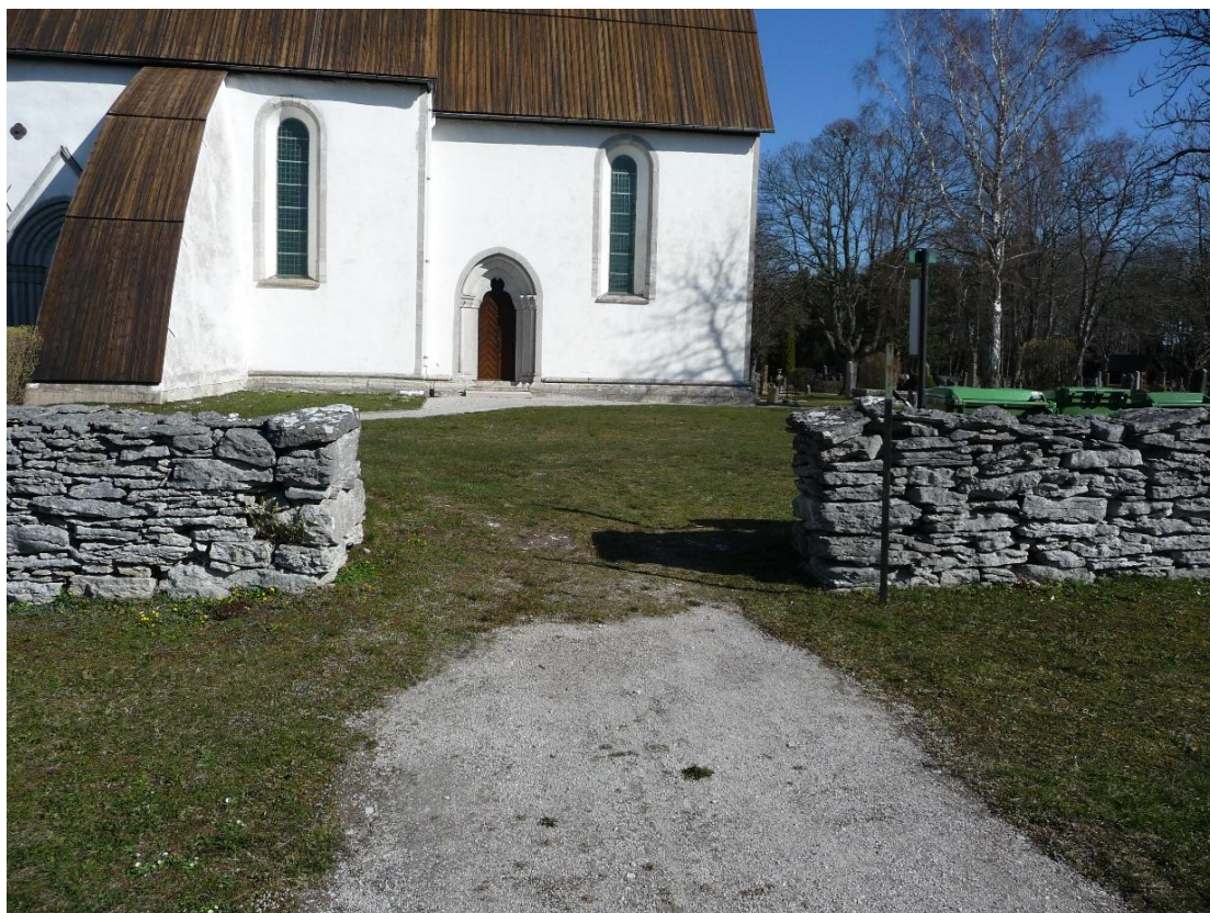
Öppning i den södra muren. Foto ES 2021.
