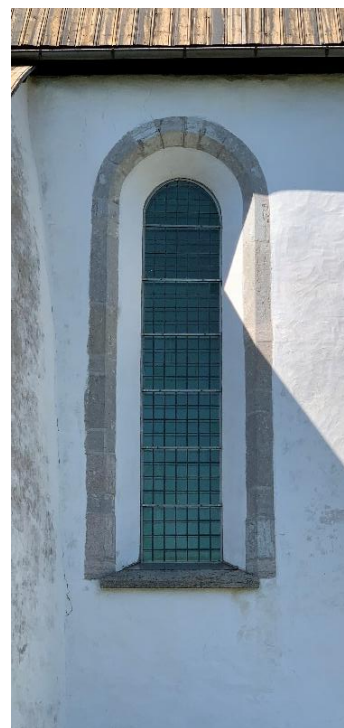
Långhusets sydfasad med strävpelaren från söder. Till höger långhusets fönster, förändrat och sannolikt utvidgat 1882. Vid Brunius besök omkring 1860 fanns här ett smalt och högt spetsbågigt fönster. Foto JL 2021.
