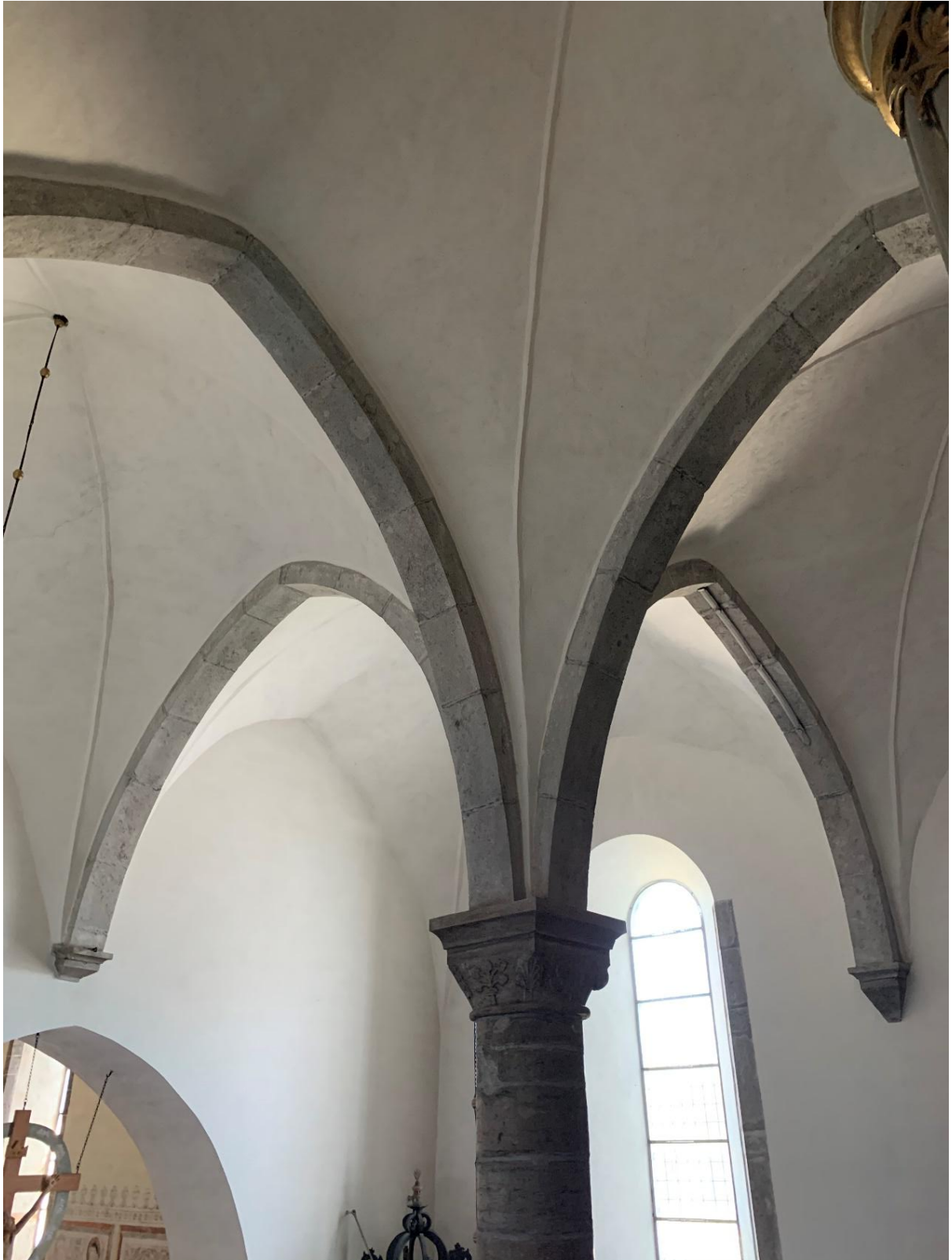
Långhusets valv, sedda mot sydöst. Foto JL 2021.
