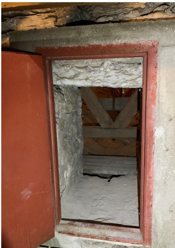
Öppningen från långhusvinden, sedd från korvinden. Till höger påmurning från 1967 på den västra kanten av triumfbågsmuren, sedd från nordöst på korvinden. Teglet skapar en brandmur eftersom den yttre gaveln mellan långhuset och koret är av trä. Foto JL 2021.
