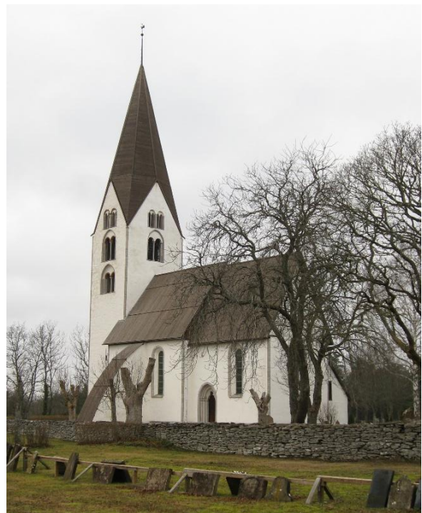
Exteriör från söder efter restaurering 1967, då bland annat tegel vid omputsningen togs fram i ljudgluggarnas omfattningar. Foto Hans Hemlin ca 1970, efter Söderberg, Kyrkorna på Gotland (1978). Till höger exteriör efter omputsningar 1993 och 2006. Foto Rebecka Svensson 2008, Visby stift.
