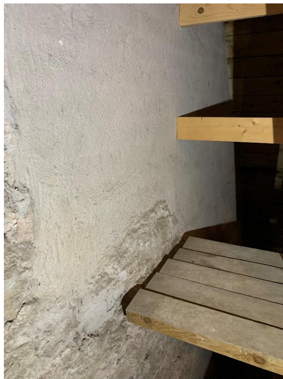
Långhusvinden mot öster med triumfbågsmuren i fonden. Till höger påbyggnad i mot långhusvinden putsat tegel, troligen från 1969, av triumfbågsmuren som inte sträckt sig upp till långhustaket och i fasaden kompletteras av en gavel i trä. Foto JL 2021.
