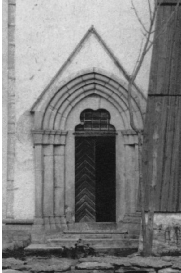
Södra långhusportalen. Dess låga vimperg talar för att den tidigare haft högre vinkel, men fotot till höger från 1890-talet visar att den huggna avtäckningen sannolikt är ursprunglig såvida den inte tillkom vid restaureringen 1882. Foto JL 2021 respektive troligen Olof Sörling 1891, ATA.
