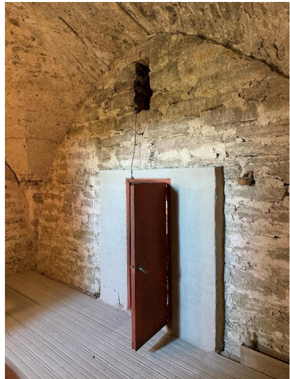
Tornets tredje övervåning mot norr och mot nordöst. Kvarsittande virken i murarna visar att denna del inte drabbats av brand, vare sig 1908 eller tidigare. Foto JL 2021.
