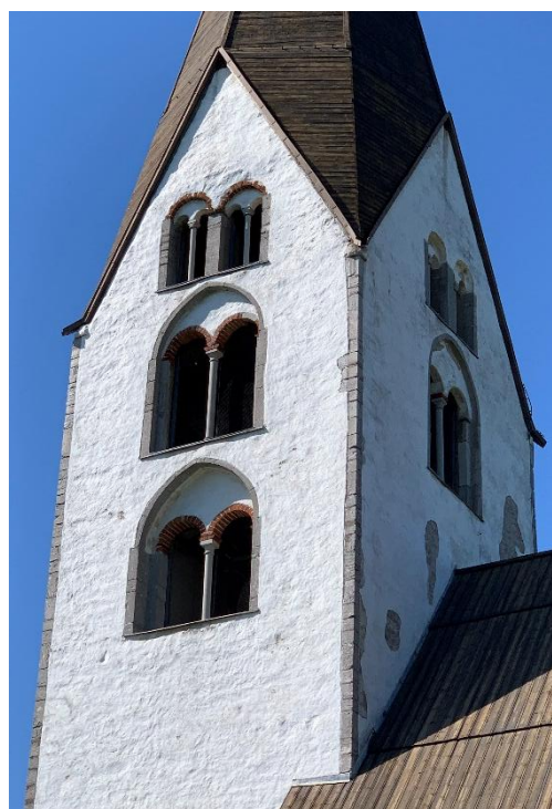
Tornet från sydöst med släpljus över sydfasaden. Även om murverket blir något mer ojämnt uppåt framträder ingen tydlig skarv som kunnat visa att den övre delen är en påbyggnad av ett äldre torn. Foto JL 2021. Till höger tornets övre del snett uppifrån från nordväst och underifrån från sydöst. Den nedersta våningens ljudgluggar är djupare försänkta i murverket än de ovanför. Foto Pär Malmros 2021, Visby stift, respektive JL 2021.
