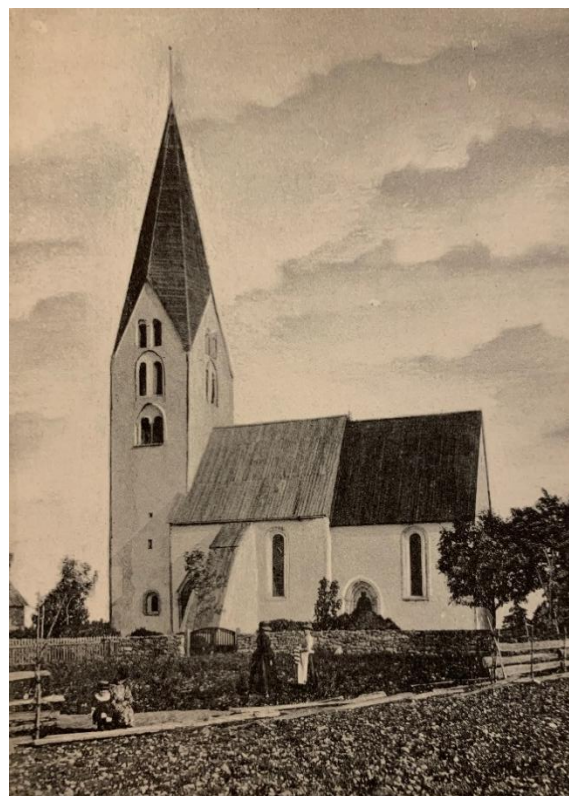
Ljudgluggarnas utseende mot söder före 1909 med sentida förstärkningar och förenklingar, kanske från tornets reparation 1769. Detalj av föregående bild. Till höger exteriör från sydöst omkring 1900. Vykort från Carl Nilssons Ljustrycksanstalt, Stockholm, Gotlands Museums arkiv.
