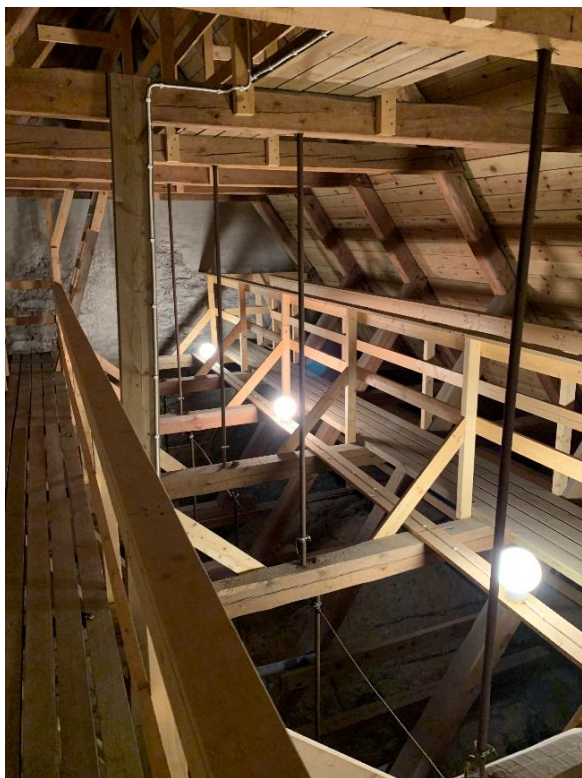
Långhusvinden mot öster med triumfbågsmuren i fonden. Till höger påbyggnad i mot långhusvinden putsat tegel, troligen från 1969, av triumfbågsmuren som inte sträckt sig upp till långhustaket och i fasaden kompletteras av en gavel i trä. Foto JL 2021.
