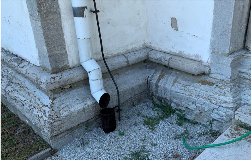
Sockeln i södra hörnet mellan långhus och kor, som visar att de är planerade i ett sammanhang. Foto JL 2021.
