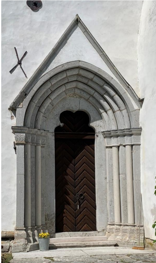
Södra långhusportalen. Dess låga vimperg talar för att den tidigare haft högre vinkel, men fotot till höger från 1890-talet visar att den huggna avtäckningen sannolikt är ursprunglig såvida den inte tillkom vid restaureringen 1882. Foto JL 2021 respektive troligen Olof Sörling 1891, ATA.
