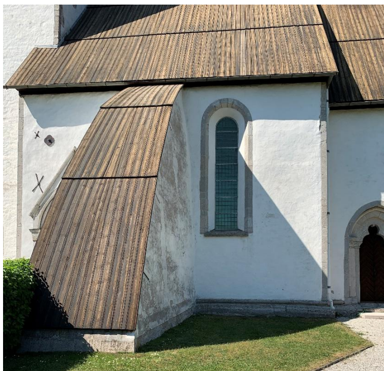
Långhusets sydfasad med strävpelaren från söder. Till höger långhusets fönster, förändrat och sannolikt utvidgat 1882. Vid Brunius besök omkring 1860 fanns här ett smalt och högt spetsbågigt fönster. Foto JL 2021.
