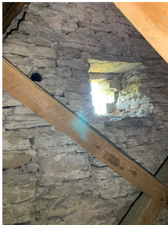
Korvinden mot öster. Till höger det östra gavelröset med kvarsittande bränt ställningsvirke samt korsformad ljusglugg. Foto JL 2021.
