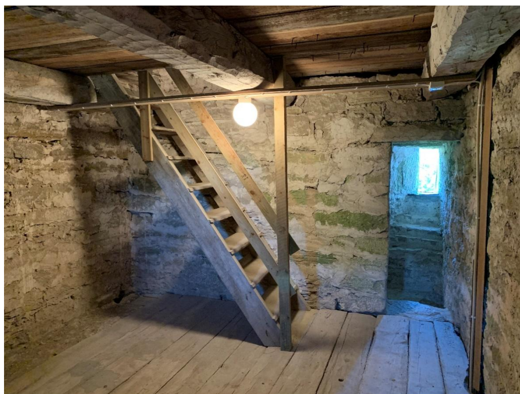
Tornets andra övervåning mot norr. Murtrappan övergår till en trätrappa. Foto JL 2021.
