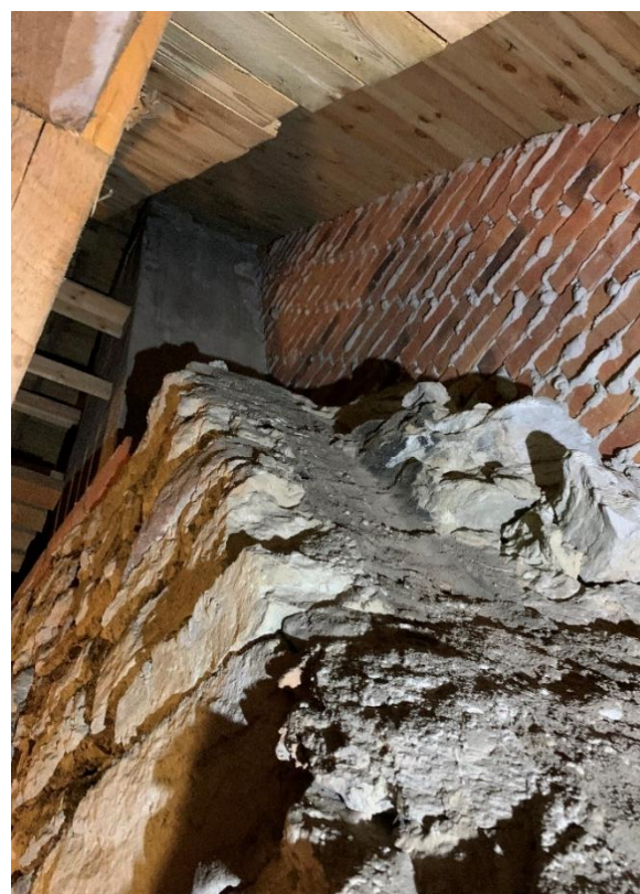
Öppningen från långhusvinden, sedd från korvinden. Till höger påmurning från 1967 på den västra kanten av triumfbågsmuren, sedd från nordöst på korvinden. Teglet skapar en brandmur eftersom den yttre gaveln mellan långhuset och koret är av trä. Foto JL 2021.
