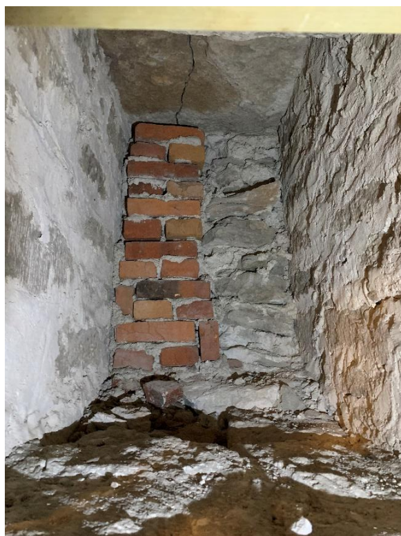
Till vänster den norra av nischerna i första övervåningens östra mur, centrerad i kyrkans mittlinje och placerad bakom långhusets västra valvkonsol. Ursprungligen troligen utgång till vinden i den romanska kyrkan, eller möjligen till en läktare. Till höger den södra av nischerna. Träskoningen antyder en lucka in mot kyrkorummet. Den synbarligen sent tillkomna igenmurningen tyder på att hela nischen öppnats in mot det nuvarande långhuset, strax under valven. Foto JL 2021.
