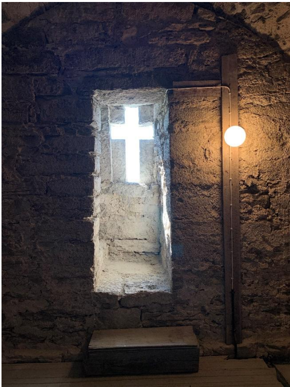
Korsformig ljusglugg till tredje övervåningen. Till höger öppningen med murtrappan synligt. Såväl här som längre ned utmärks trappan av ett murverk med skarpa hörn. Foto JL 2021.
