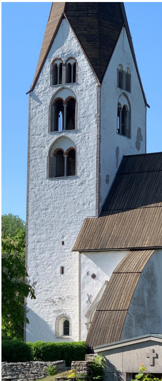
Tornet från sydöst med släpljus över sydfasaden. Även om murverket blir något mer ojämnt uppåt framträder ingen tydlig skarv som kunnat visa att den övre delen är en påbyggnad av ett äldre torn. Foto JL 2021. Till höger tornets övre del snett uppifrån från nordväst och underifrån från sydöst. Den nedersta våningens ljudgluggar är djupare försänkta i murverket än de ovanför. Foto Pär Malmros 2021, Visby stift, respektive JL 2021.
