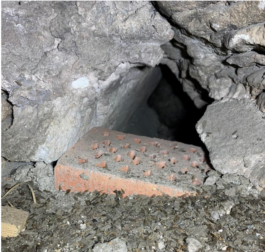
Öppningen ovanför passagen från långhusvinden till korvinden, sedd från korvinden i öster. Sannolikt avtryck av det äldre långhusets taknock, vilket ger en ledning om dess höjd. Foto JL 2021.
