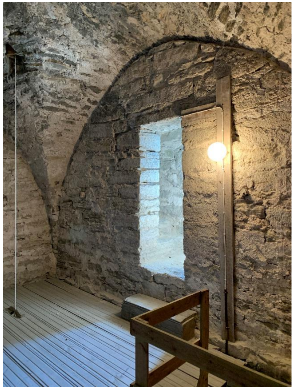
Korsformig ljusglugg till tredje övervåningen. Till höger öppningen med murtrappan synligt. Såväl här som längre ned utmärks trappan av ett murverk med skarpa hörn. Foto JL 2021.
