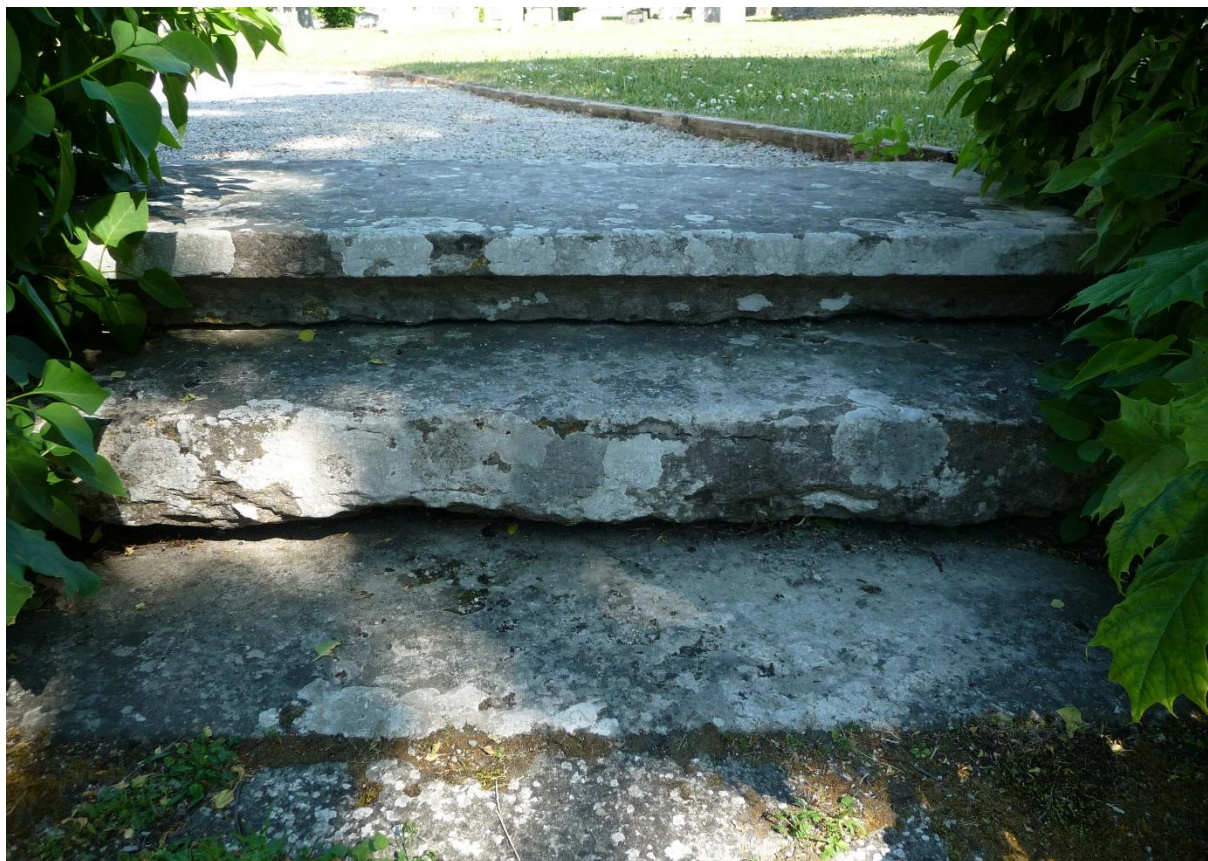
Trappa från den södra ingången mot öster. Det översta trappsteget är skråkantat vilket tyder på att det är en återanvänd stendetalj, eventuellt en altarskiva. Foto ES 2021.
