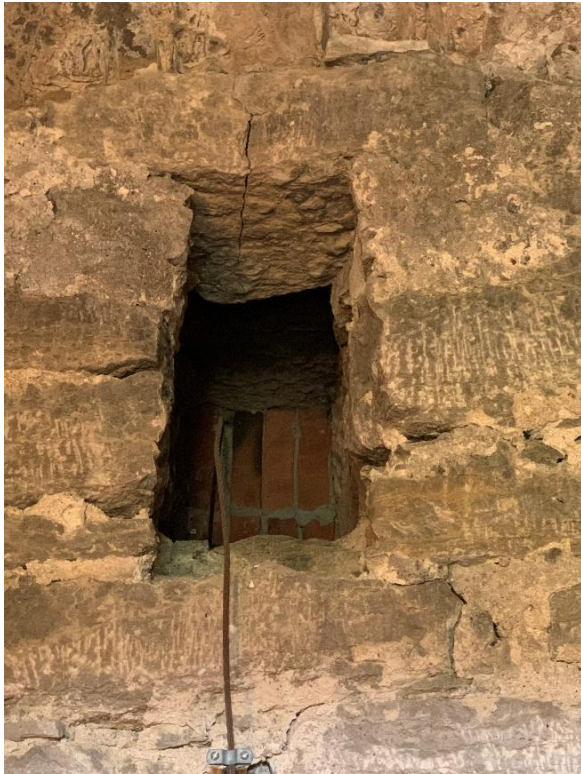
Öppning i övre delen av tornets östra mur i tornets tredje övervåning. Ursprungligen möjligen ljusglugg, igenmurad 1967. Till höger öppning i våningens västra mur till murtrappa förbi valvet. Foto JL 2021.
