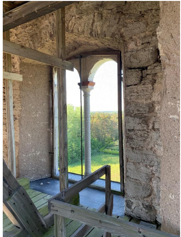
Klockvåningen innanför den mellersta våningen med ljudgluggar, sedd mot norr, med den norra ljudgluggen. Omfattningarna innerdelar förefaller något grövre i de övre än de nedersta ljudgluggarna. Foto JL 2021.
