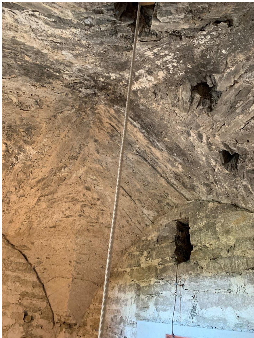
Valvet över tredje övervåningen, sett mot nordöst. Öppningen är nu igensatt men har gått in till vinden och var innan dess troligen en vindsglugg. Foto JL 2021.
