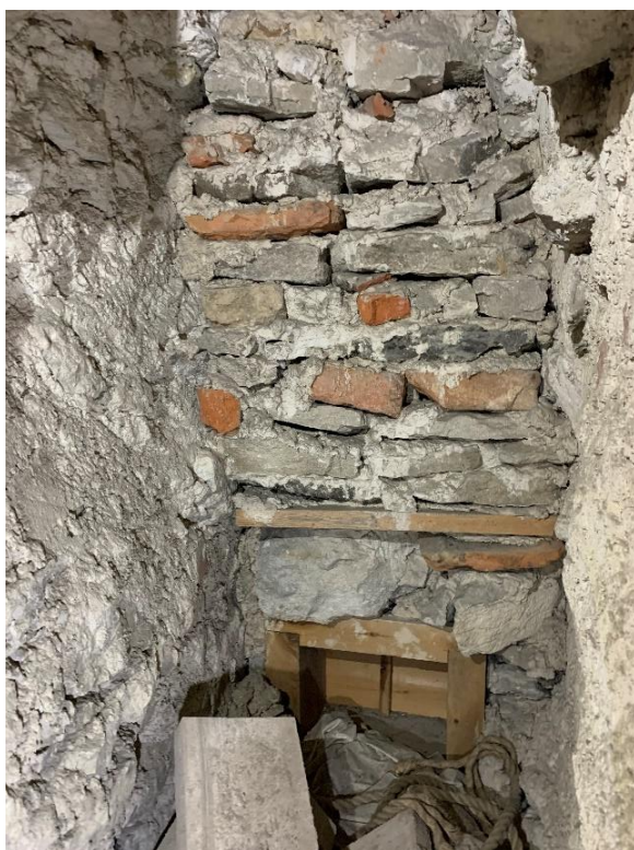
Till vänster den norra av nischerna i första övervåningens östra mur, centrerad i kyrkans mittlinje och placerad bakom långhusets västra valvkonsol. Ursprungligen troligen utgång till vinden i den romanska kyrkan, eller möjligen till en läktare. Till höger den södra av nischerna. Träskoningen antyder en lucka in mot kyrkorummet. Den synbarligen sent tillkomna igenmurningen tyder på att hela nischen öppnats in mot det nuvarande långhuset, strax under valven. Foto JL 2021.
