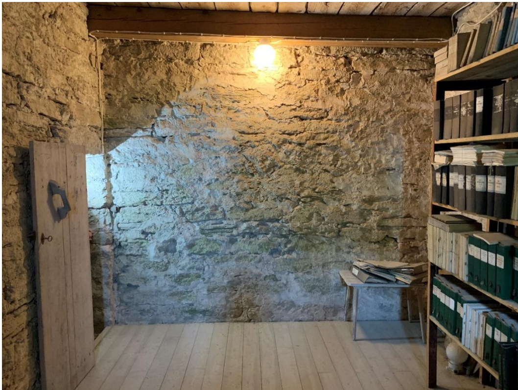
Tornets första övervåning. Interiör mot norr.
