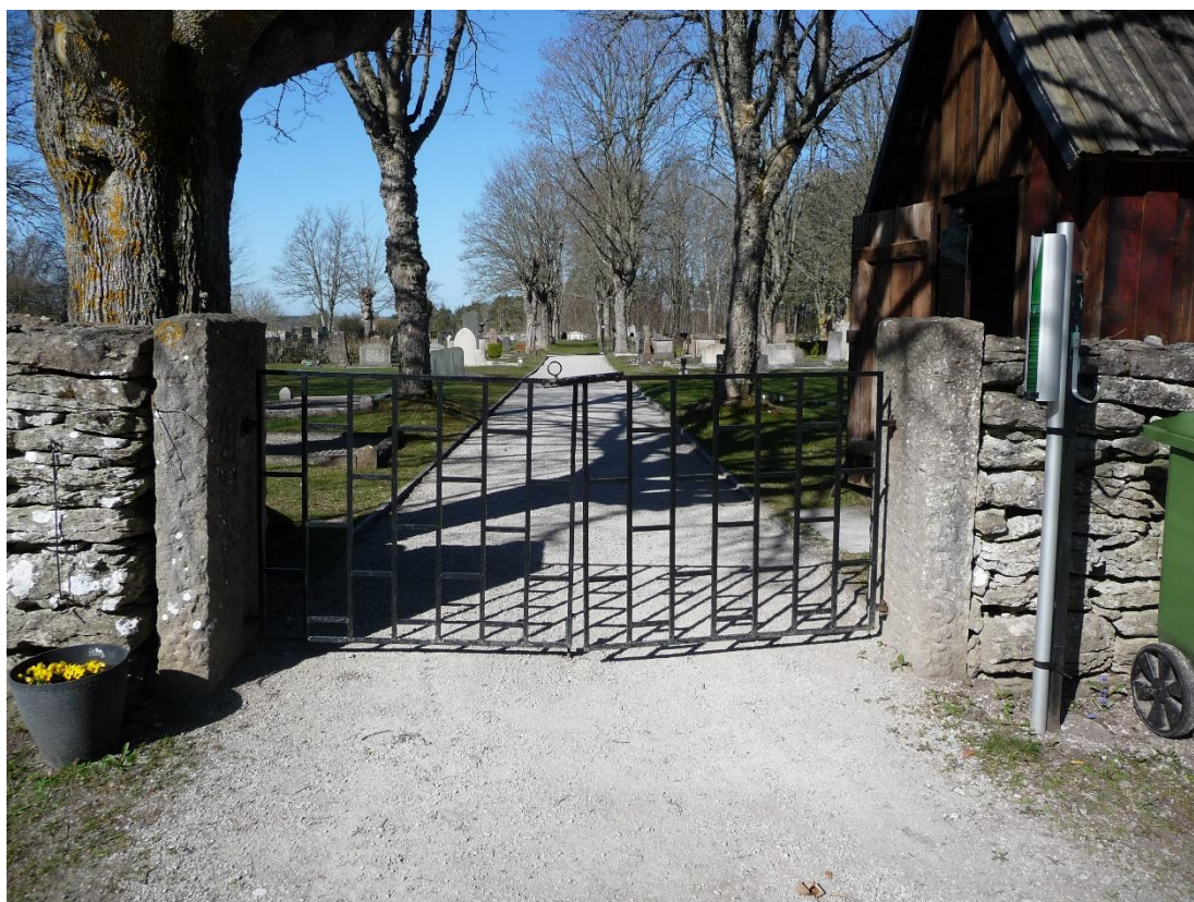
Den nordöstra ingången till den äldre kyrkogården med dubbel järngrind flankerad av stenstolpar. Foto ES 2021.
