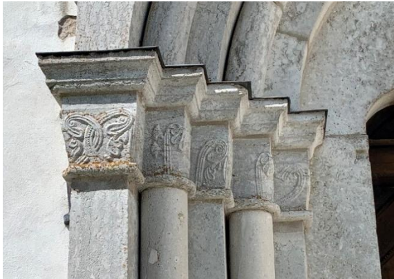
Södra långhusportalen. Dess låga vimperg talar för att den tidigare haft högre vinkel, men fotot till höger från 1890-talet visar att den huggna avtäckningen sannolikt är ursprunglig såvida den inte tillkom vid restaureringen 1882. Foto JL 2021 respektive troligen Olof Sörling 1891, ATA.
