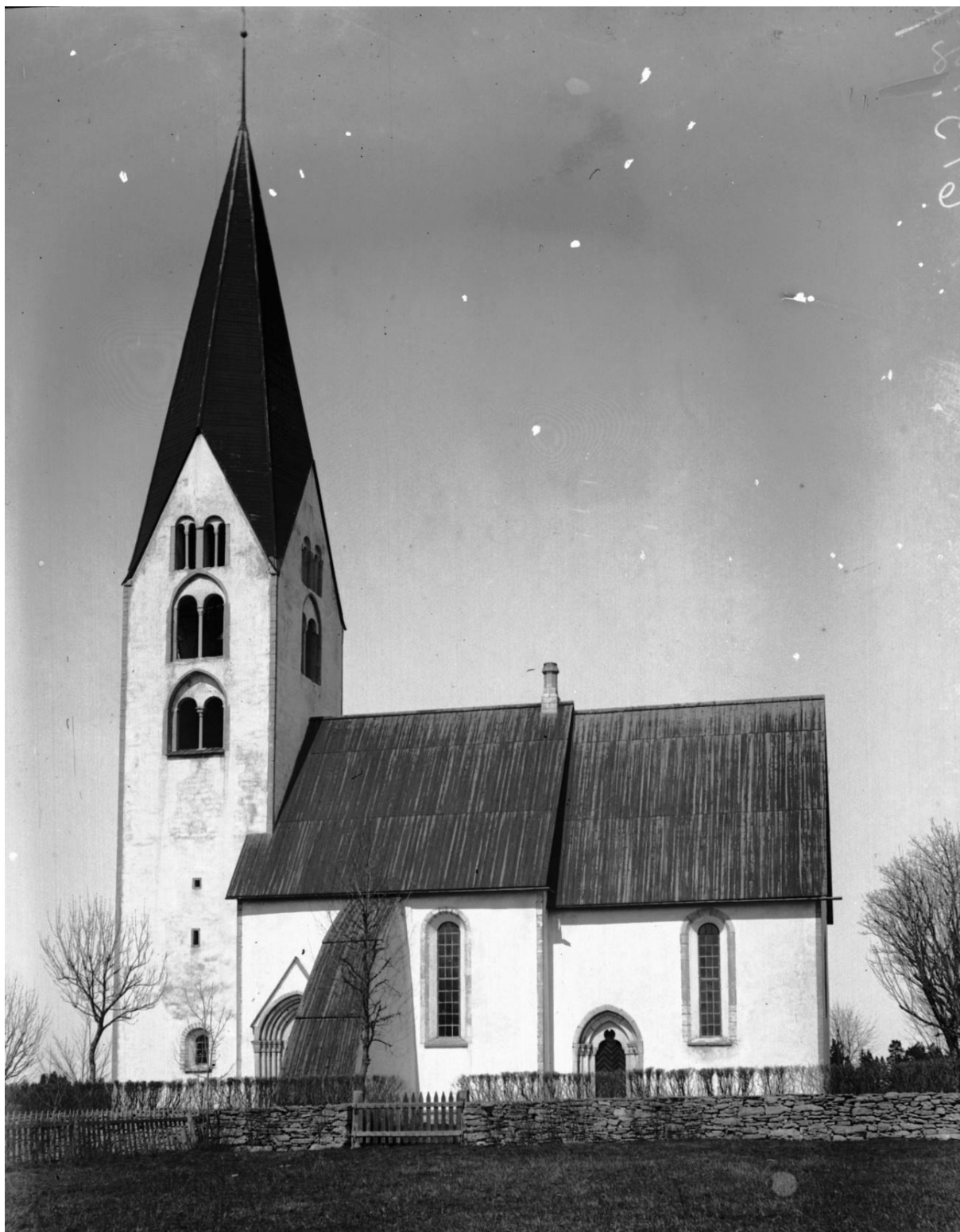
Exteriör från söder efter återuppbyggnaden 1909. Ny tornspira och nya yttertak har byggts. Ljudgluggarnas omfattningar har restaurerats till sitt äldre skick. Skorsten har tillkommit. Foto Einar Erici 1914, ATA.
