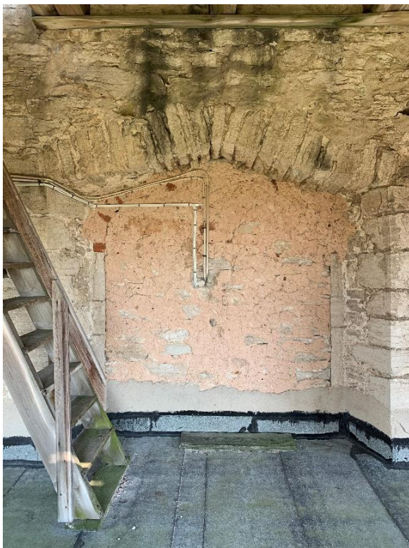
Tornets nedersta våning med ljudgluggar. Den igensatta ljudgluggen mot öster, som delvis skymms av långhusets yttertak. Till höger synlig del av ljudgluggens ursprungliga kapital med inhuggna bokstäver. Foto JL 2021.
