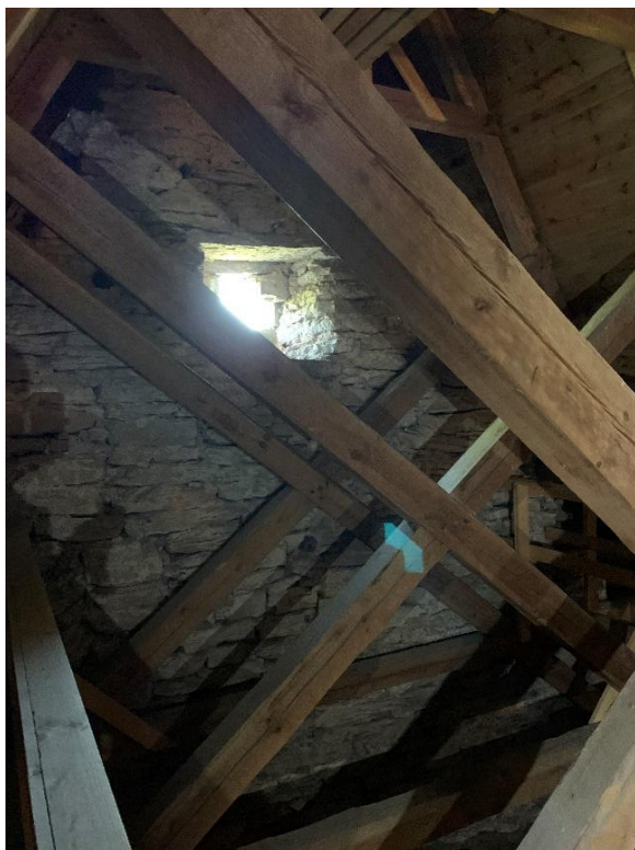
Korvinden mot öster. Till höger det östra gavelröset med kvarsittande bränt ställningsvirke samt korsformad ljusglugg. Foto JL 2021.
