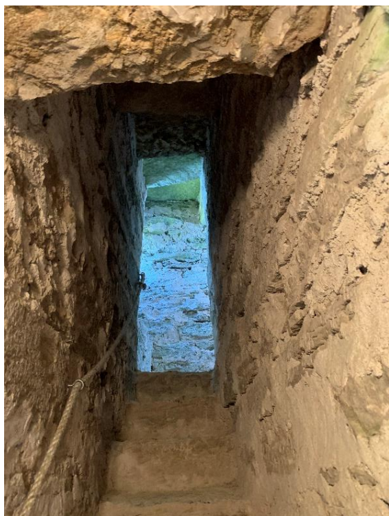
Murtrappa i norra muren mellan första och andra övervåningen, präglad av raka murar med skarpa hörn. Till höger andra övervåningen mot söder och öster. Den östra muren saknar spår av tidigare långhusets västgavel. Foto JL 2021.
