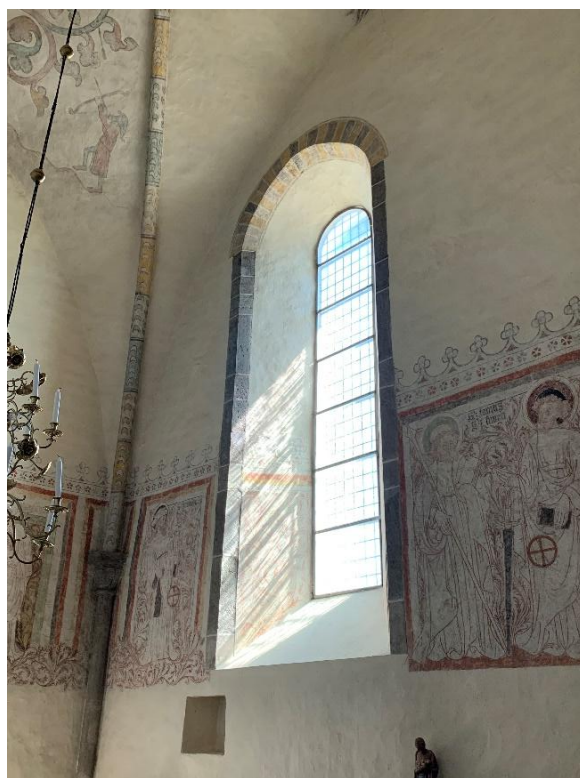
Valvpilaster i korets sydvästra hörn mellan kalkmålningar från 1400-talets början. Till höger korets södra fönster. Den inre omfattningen visar inte samma utvidgning nedåt som den yttre i fasaden. Foto JL 2021.
