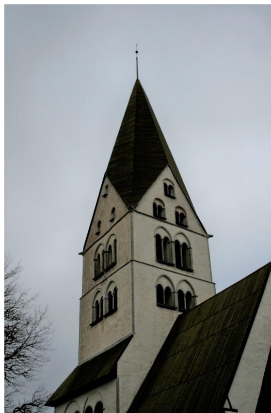
Tornet från söder och sydöst efter restaureringen 1999, då de nedersta södra ljudgluggarnas yttre omfattning rekonstruerades och fasadernas slätputs ersattes med spritputs och översta gluggarnas tegelomfattning frilades, före restaureringen 2015-17. Foto Rebecka Svensson 2007, Visby stift.
