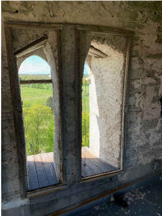
Klockvåningen mot väster. Till höger ett av urtagen för tvärgående bjälkar i klockvåningens hörn. Bjälkarna, vars placering att döma av hålen var ursprunglig, avlägsnades vid någon av 1900-talets restaureringar. Foto JL 2021.
