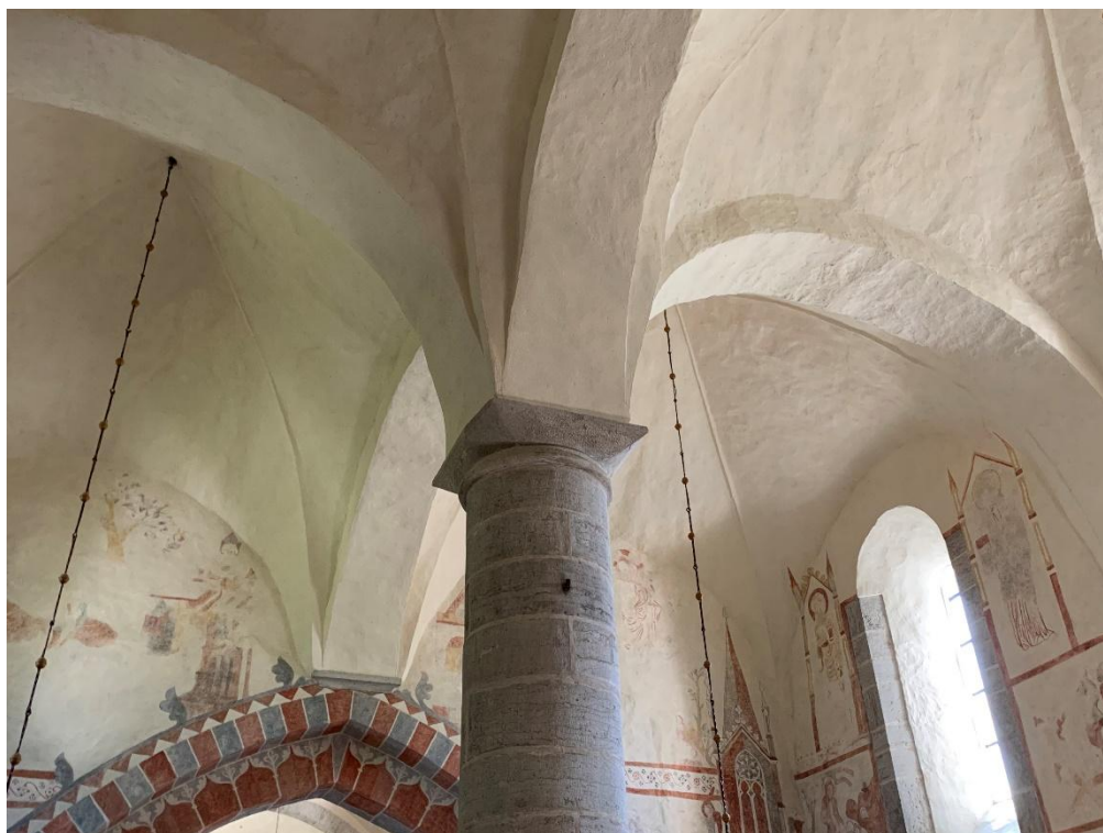
Långhusets valv sedda mot sydöst. Foto JL 2021.
