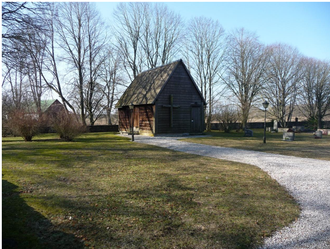
Det tidigare sockenmagasinet som byggdes om till bårhus 1954-1955 och som sedan användes som materialbod. Det invigdes som gudstjänstrum 2017 av dåvarande Biskop Sven-Bernhard Fast för att kunna husera församlingen i väntan på mögelsanering och restaurering.
