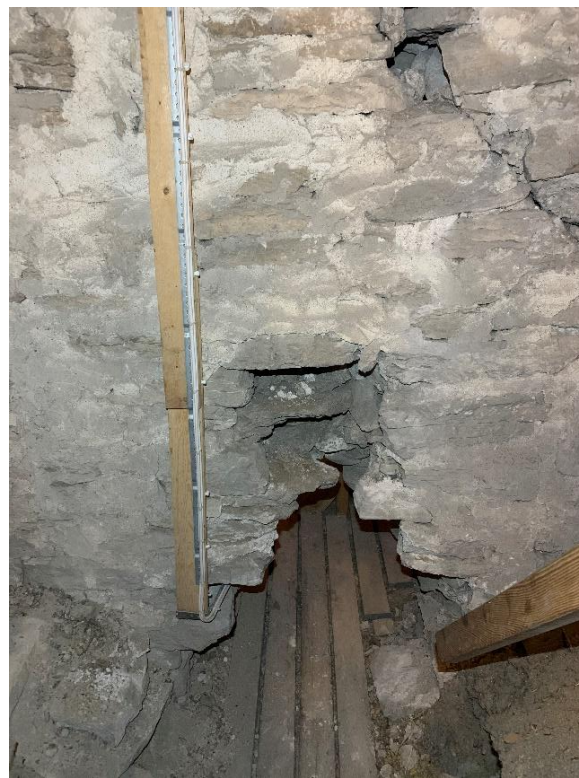
Del av bildsten inmurad i det äldre långhusets gavel in mot den dåvarande vinden och visande att bildstensmaterialet ingick redan den äldre kyrkans murverk. Till höger passage mellan långhusets och korets vindar, sedd från väster. Öppningen synes inte vara ursprunglig utan uppbruten i den äldre kyrkans triumfbågsgavel. Foto JL 2021.
