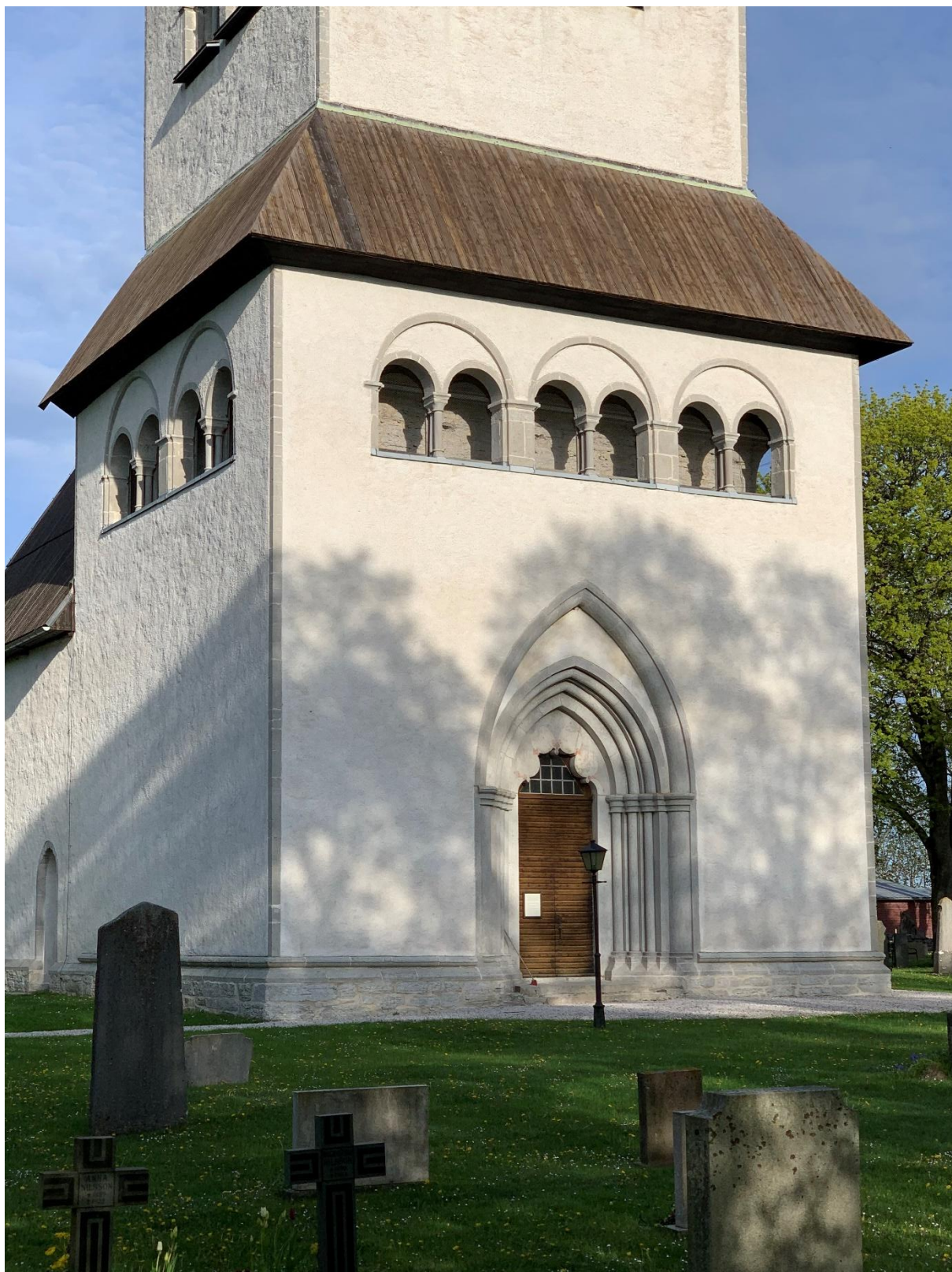
Tornets nedre del, sedd från nordväst. Foto JL 2021.
