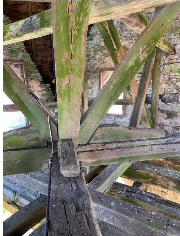
Västra gavelröstets ovansida mot norr med takstolens syll lagd i bruk mot gaveln. Till höger stödben, utgående från de nedre bindbjälkarnas skärningspunkt. Foto JL 2021.
