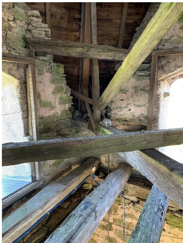
Tornhuvens konstruktion med takstolarnas bindbjälkar i nordöstra svickeln. Till höger östra gavelröset uppifrån visande dess tunna form. Foto JL 2021.
