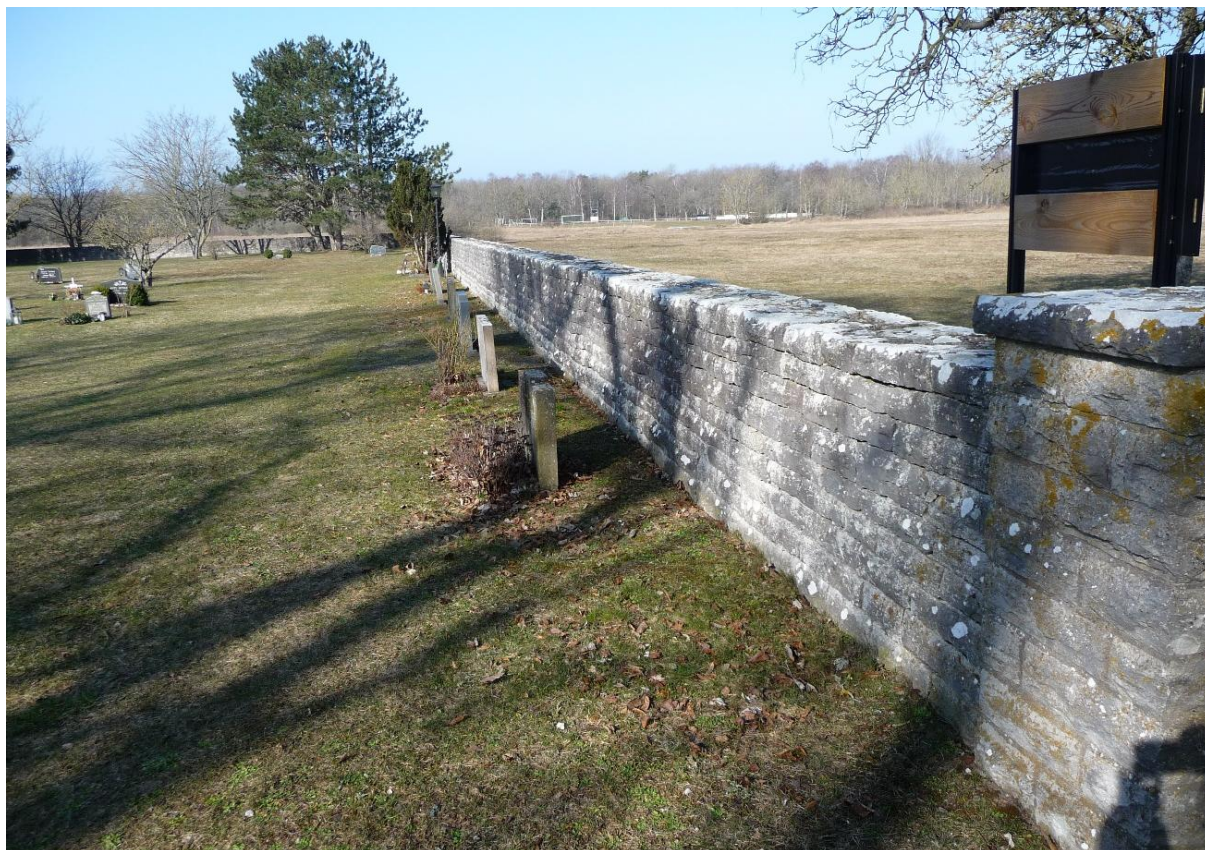
Murarna kring den yngre kyrkogården är uppbyggda av bruksmurad kalksten. Här den norra mursträckningen. Foto ES 2021.
