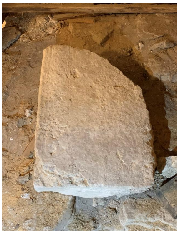
Passagen mellan torn och långhusvind, norra sidan med kvaderritsar som imiterar rektangulära stenblock. Till höger bildsten i bågöppningen mellan torn och långhusvind, lösgjord från murverket. Nedre delen nött och har sannolikt varit exponerad som golv eller trappsten. Foto JL 2021.
