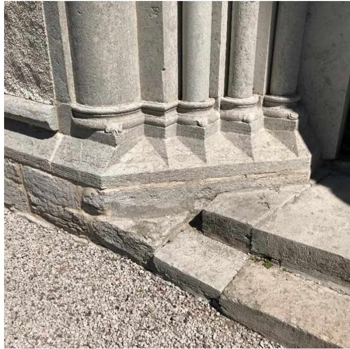
Västportalens norra post och basband. Stenen under skarven mellan basbandet och sockeln är en av flera stenar i kyrkans murar med svaga konkava räfflor på olika ledder. Foto JL 2021.
