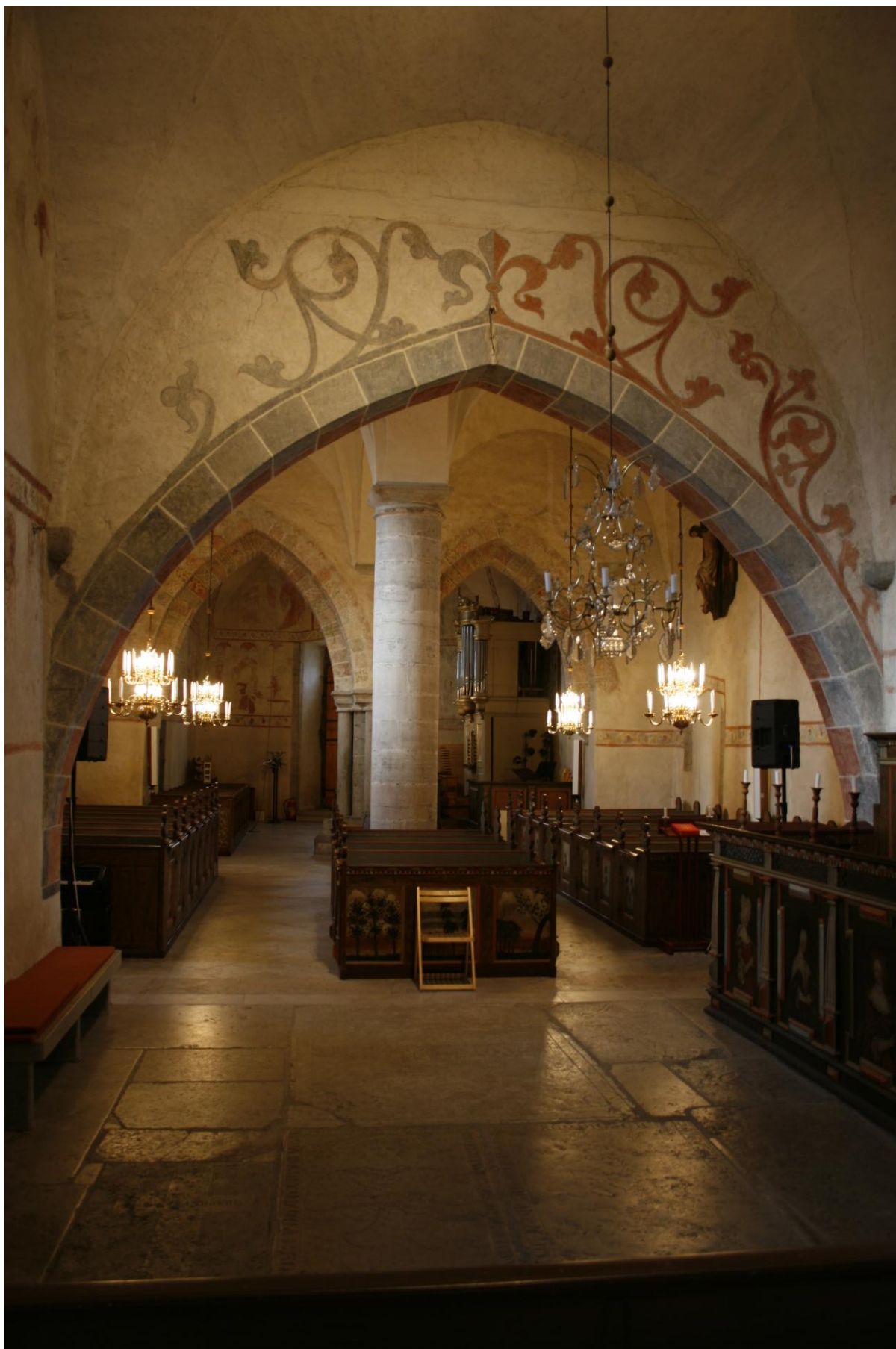
Interiör mot väster före restaureringen 2017-19. Foto Rebecka Svensson 2007, Visby stift.
