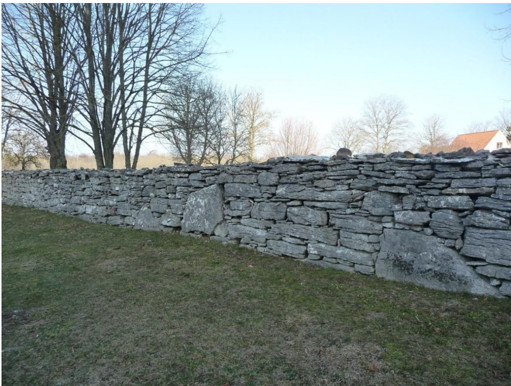
Den norra muren fotograferad från kyrkogården. Muren har en ålderdomlig karaktär med varierande storlek på stenarna och ett flertal större stenar. Foto ES 2021.
