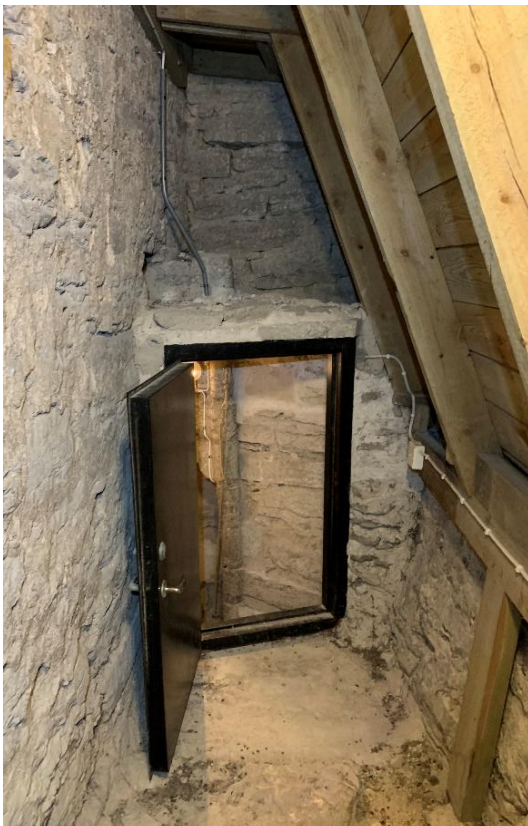
Spiraltrappans mynning i södra galleriet, med inbyggnad i trä och ståldörr från ca 1980. Till höger en av flera inmurade stenar med räfflor på växlande ledd, strax intill ståldörrens gångjärnssida. Foto JL 2021.
