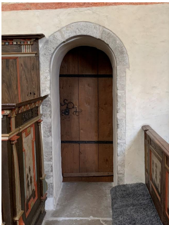
Sakristieportalen. Bågstenarnas snävare välvning talar för att den är överflyttad från äldre kyrkans kor. Till höger interiör av sakristian mot öster. Foto JL 2021.
