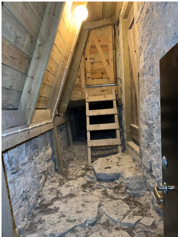
Gallerivåningen vid torntrappans mynning, sedd mot väster med trädörrar till galleriet och till tornets första övervåning. Den inbyggda kammaren tillkom 1978-80. Till höger galleriets golv och bröstning, sett från kammaren från väster in under däckets från 1978-80. Foto JL 2021.
