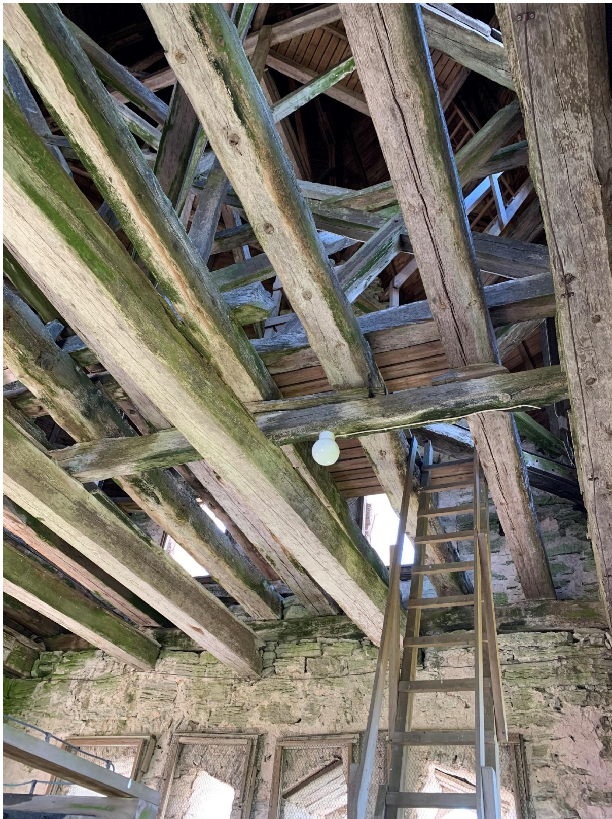
Vy från klockvåningen uppåt mot väster med dubbelt bjälklag under tornhuvens takstolar. Foto JL 2021.
