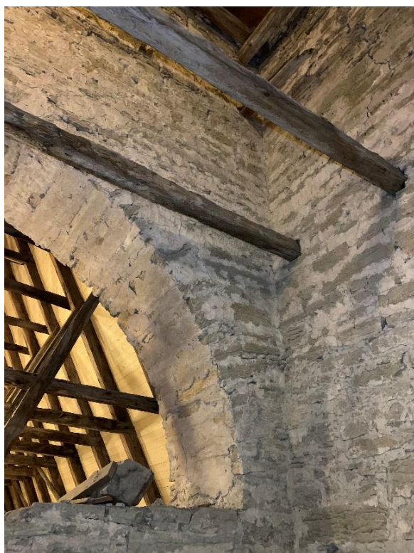
Tornets första övervåning sedd mot sydöst, till vänster i höjd med bågöppningen till långhusvinden med det våningsdelande öppna bjälklaget underifrån, till höger i rummets övre del med det våningsindelade bjälklagets östra bjälke ovanifrån. Bjälkändarna med urtag, möjligen från ett tidigare vattendäck eller återanvända från annat sammanhang. Foto JL 2021.
