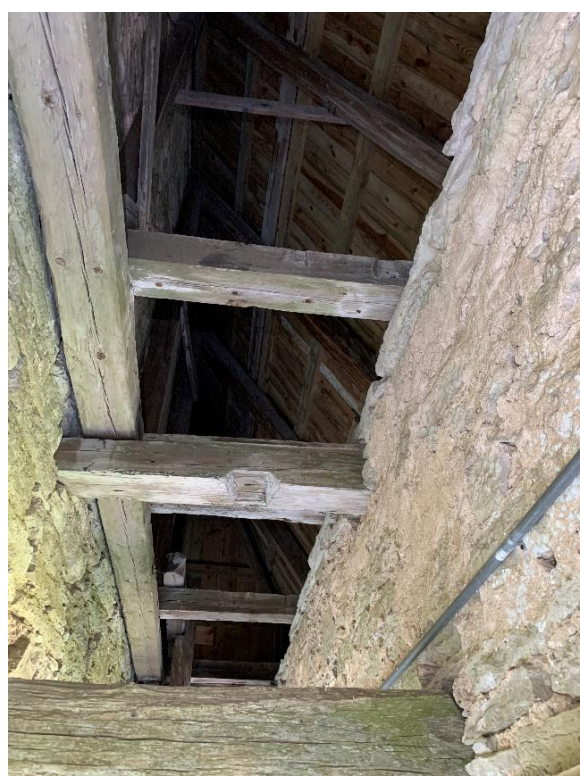
Norra galleriets östra del. Sprickan visar att galleriets mur inte ligger i förband med tornmuren till höger och alltså är yngre än denna, dess förtagningsstenar visar dock att galleriet var planerat. Till höger norra galleriets takstol sedd underifrån med urtag med okänd funktion. Foto JL 2021.
