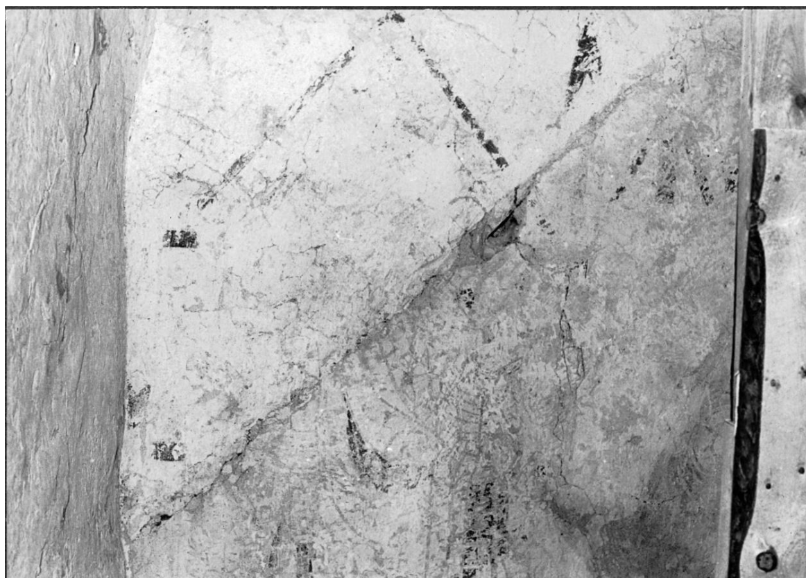
Skarv i murverket i långhusets sydvästra hörn, sannolikt takfall på det äldre långhuset, vilket visar att det i så fall kan ha varit brett och att nuvarande långhus är byggt direkt utanför murarna. Foto Lars Karlsson under restaureringen 1954-55, ATA.
