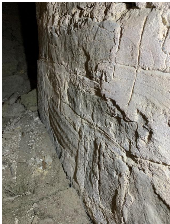
Passagen mellan torn och långhusvind, norra sidan med kvaderritsar som imiterar rektangulära stenblock. Till höger bildsten i bågöppningen mellan torn och långhusvind, lösgjord från murverket. Nedre delen nött och har sannolikt varit exponerad som golv eller trappsten. Foto JL 2021.
