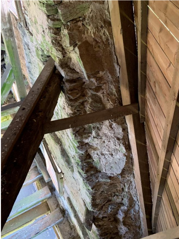
Västra gavelröstets ovansida mot norr med takstolens syll lagd i bruk mot gaveln. Till höger stödben, utgående från de nedre bindbjälkarnas skärningspunkt. Foto JL 2021.
