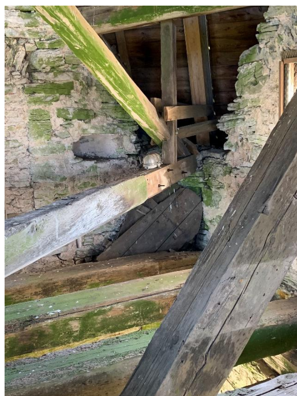
Norra gavelröstets östra glugg. Till höger svickeln mellan södra och västra gavelröstena med lösa tidigare luckor att sätta för några av öppningarna. Foto JL 2021.
