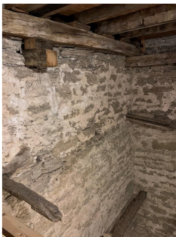
Tornets första övervåning sedd mot sydöst, till vänster i höjd med bågöppningen till långhusvinden med det våningsdelande öppna bjälklaget underifrån, till höger i rummets övre del med det våningsindelade bjälklagets östra bjälke ovanifrån. Bjälkändarna med urtag, möjligen från ett tidigare vattendäck eller återanvända från annat sammanhang. Foto JL 2021.
