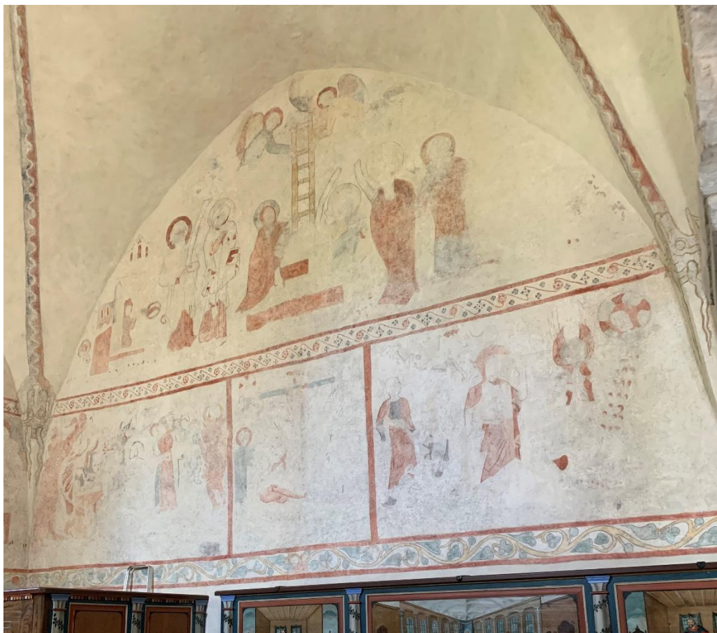
Kalkmålningar på ringkammarens norra mur. Foto JL 2021.
