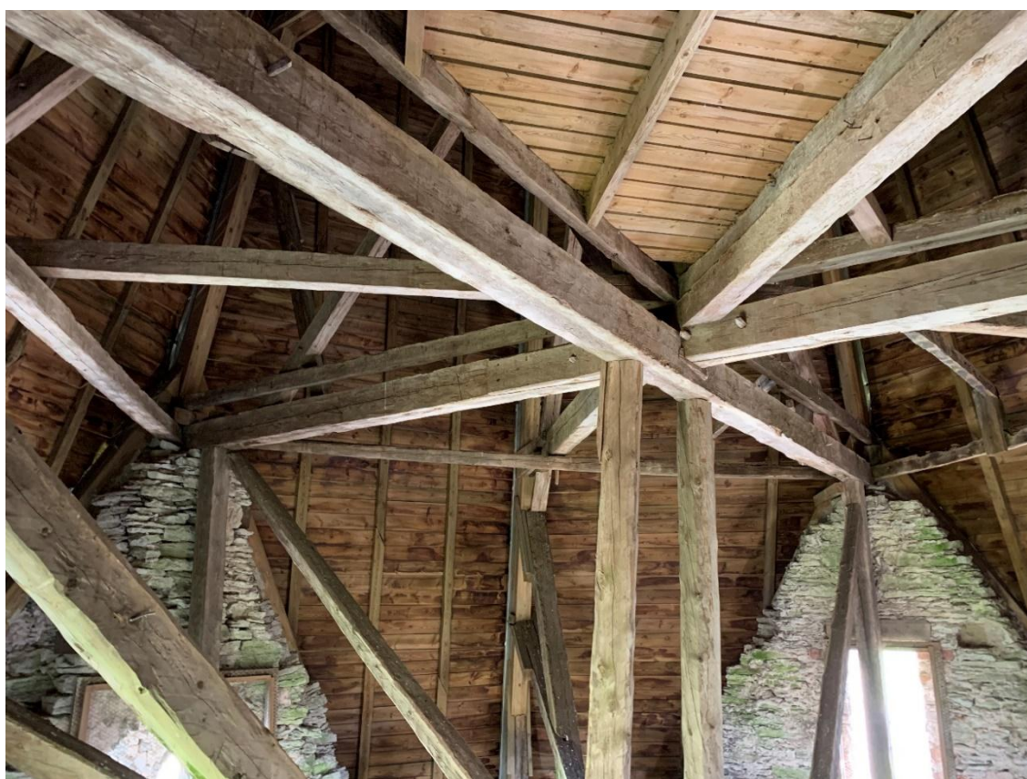
Tornhuvens takstolar med bindbjälkar vilande på gavelkrönen, sedda mot sydöst, sekundärt stöttade underifrån. Foto JL 2021.
