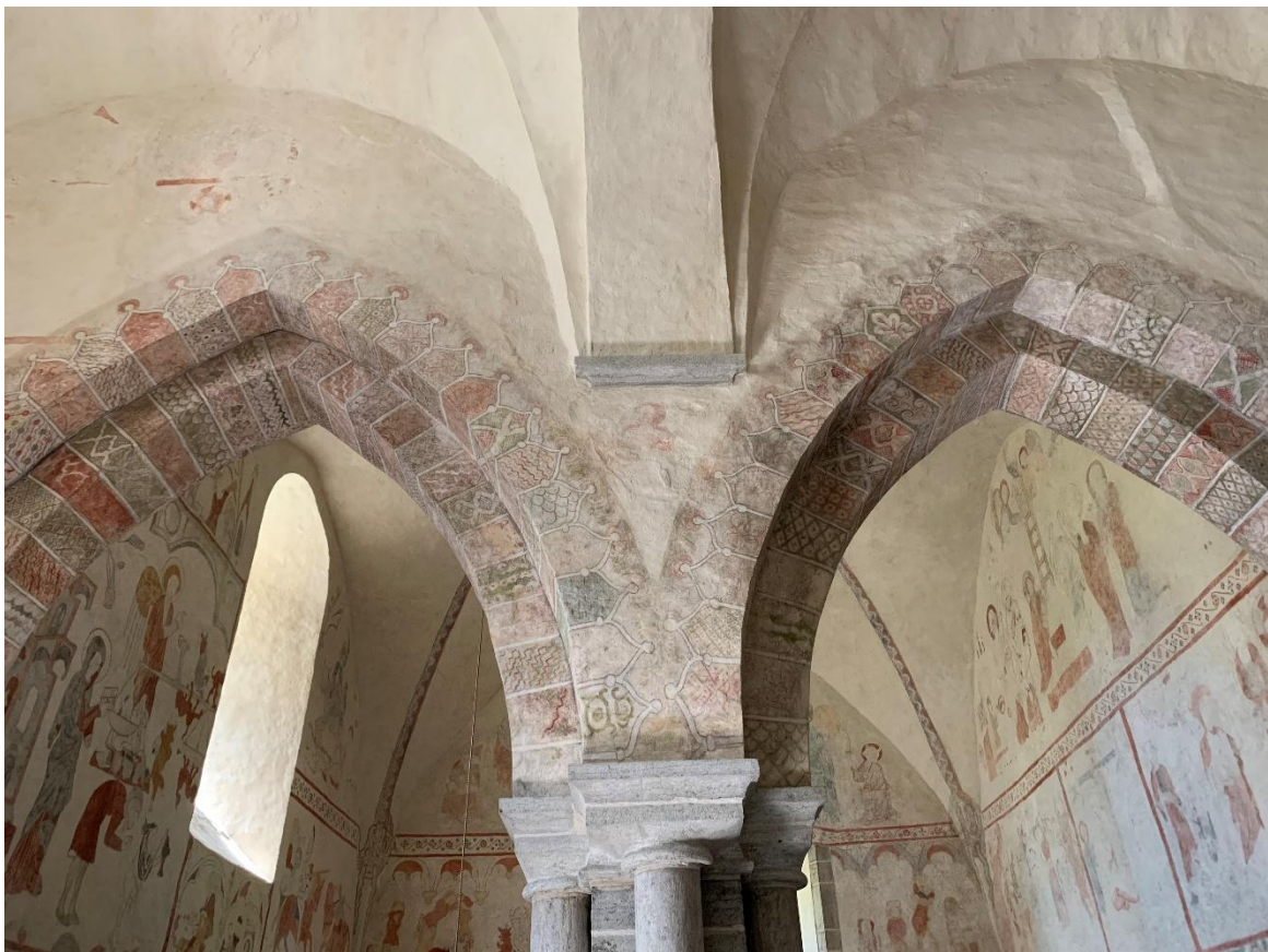
Tornbågen sedd från öster samt murskarvarv kring det tidigare tornets östfasad. Foto JL 2021.
