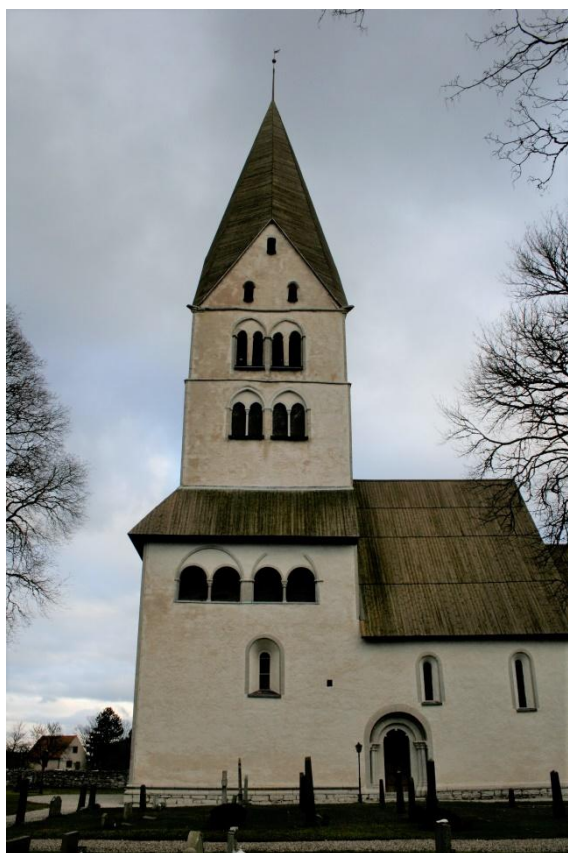
Tornet från söder och sydöst efter restaureringen 1999, då de nedersta södra ljudgluggarnas yttre omfattning rekonstruerades och fasadernas slätputs ersattes med spritputs och översta gluggarnas tegelomfattning frilades, före restaureringen 2015-17. Foto Rebecka Svensson 2007, Visby stift.
