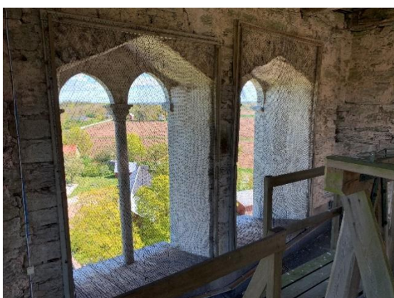
Ljudgluggarna på klockvåningens östra och södra sidor. Fotot JL 2021.
