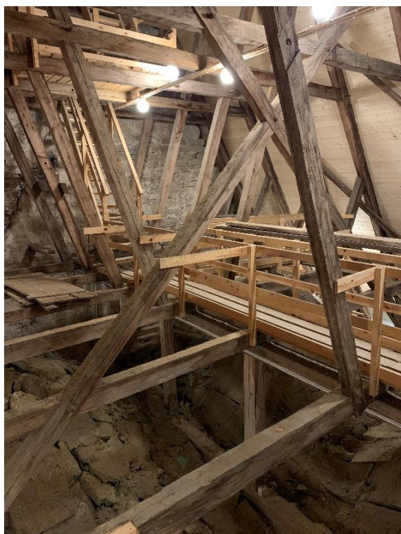
Långhusvinden mot sydöst och mot öster med valvens ovansida, täckt av isoleringsull från 1978-1980. Foto JL 2021.
