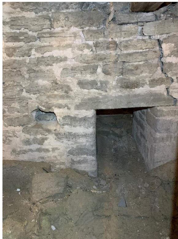
Tornets östra mur sedd från långhusvinden med vertikal skarv vid det äldre tornets sydöstra hörn. Till höger passage mellan torn och långhusvind, sedd från öster, tillkommen som passage mellan det äldre tornet och det tidigare långhuset. Foto JL 2021.
