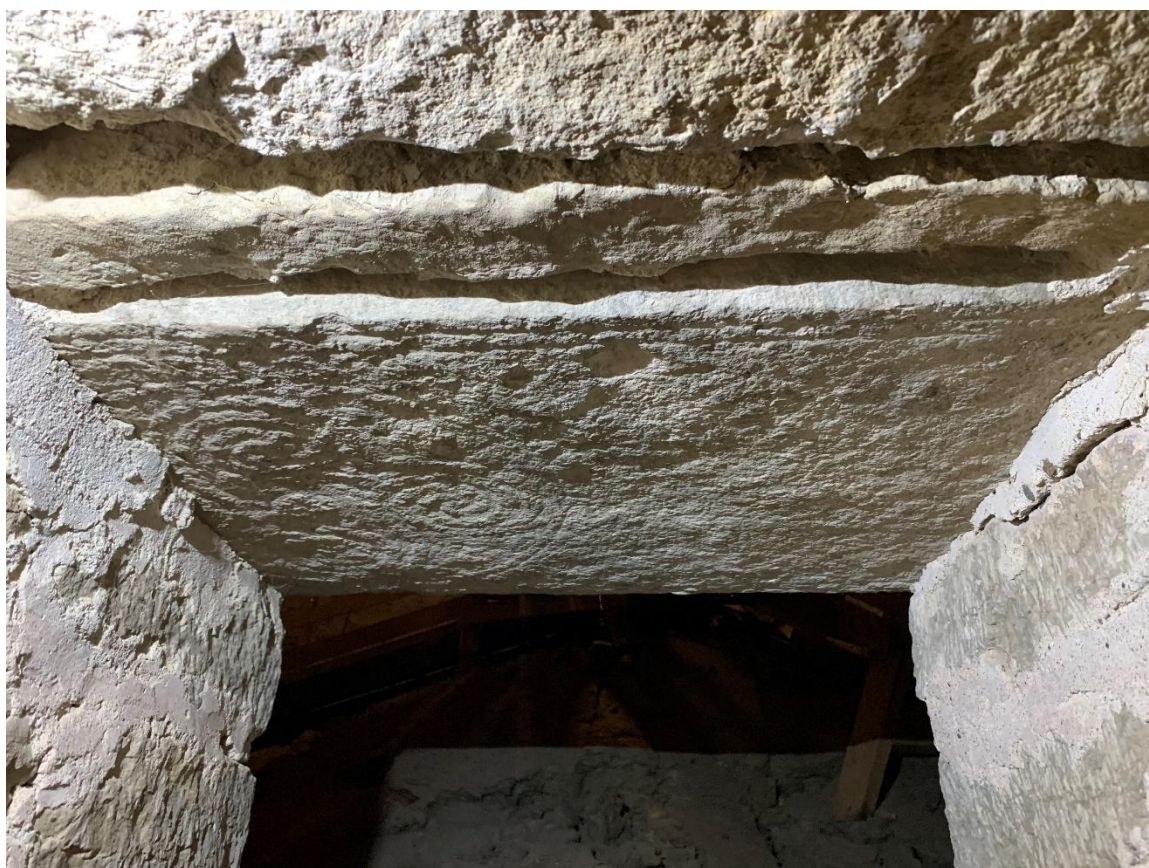
Den ena av två bildstenar, inlagda som täckhällar för öppningen mellan det äldre tornet och långhusvinden. Foto JL 2021.
