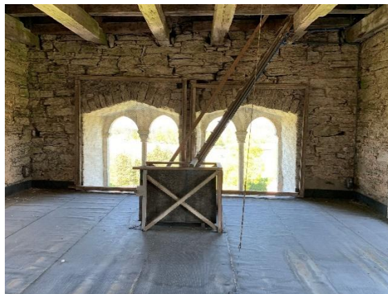
Tornets andra övervåning mot väster och norr. Ljudgluggarna mot väster är med sin trifolieform något rikare än de övriga. De kraftiga murpelarna mitt i öppningarna tillkom kanske vid reparationen 1736. Foto JL 2021.
