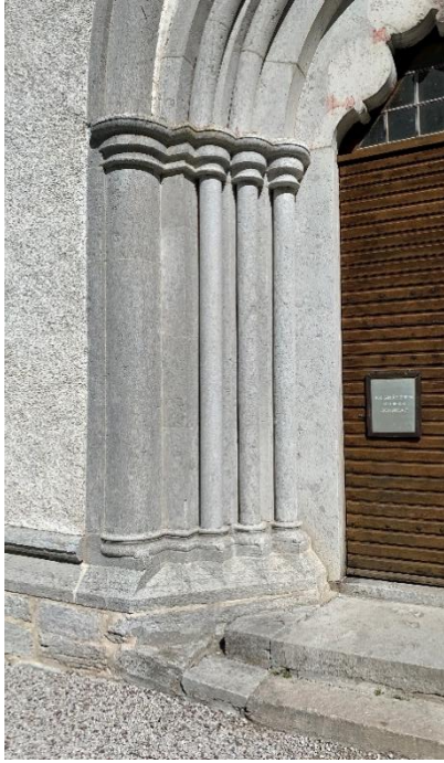
Västportalens norra post och basband. Stenen under skarven mellan basbandet och sockeln är en av flera stenar i kyrkans murar med svaga konkava räfflor på olika ledder. Foto JL 2021.
