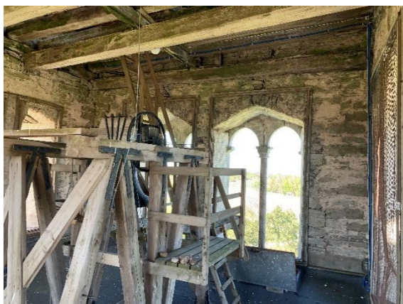
Klockvåningen mot norr och öster. Foto JL 2021.
