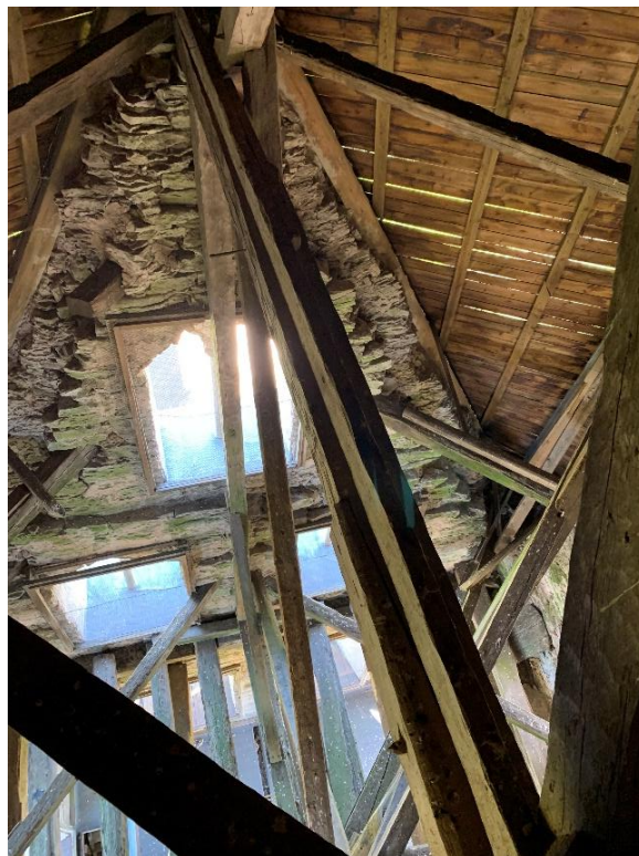
Tornhuvens konstruktion med takstolarnas bindbjälkar i nordöstra svickeln. Till höger östra gavelröset uppifrån visande dess tunna form. Foto JL 2021.
