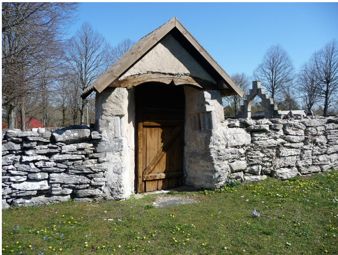
Den norra stigluckan fotograferad från söder. Foto ES 2021.
