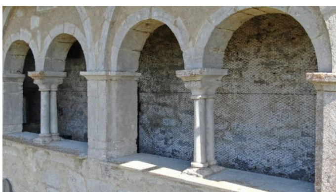
Tornets norra och södra galleri. Till vänster norra och södra galleriet sedda i vinkel. Foto Pär Malmros 2021, Visby stift.
