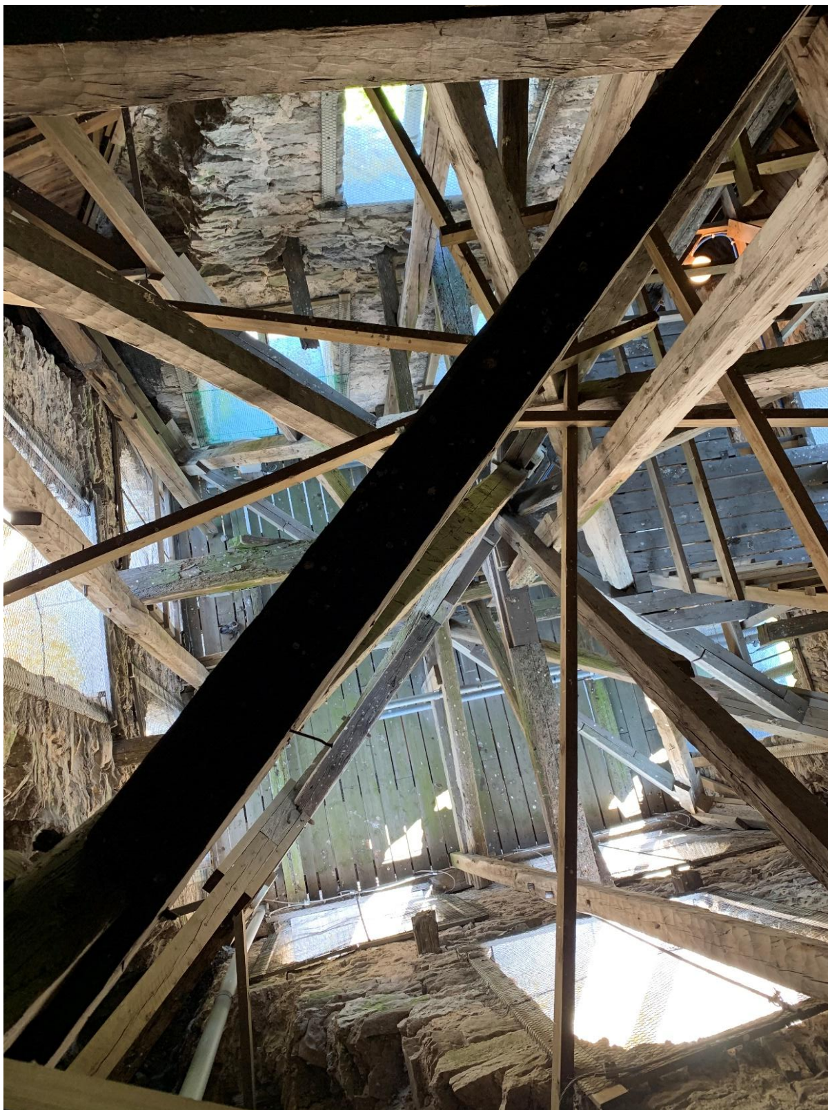
Blick från tornhuven nedåt genom den översta tornvåningen. Foto JL 2021.
