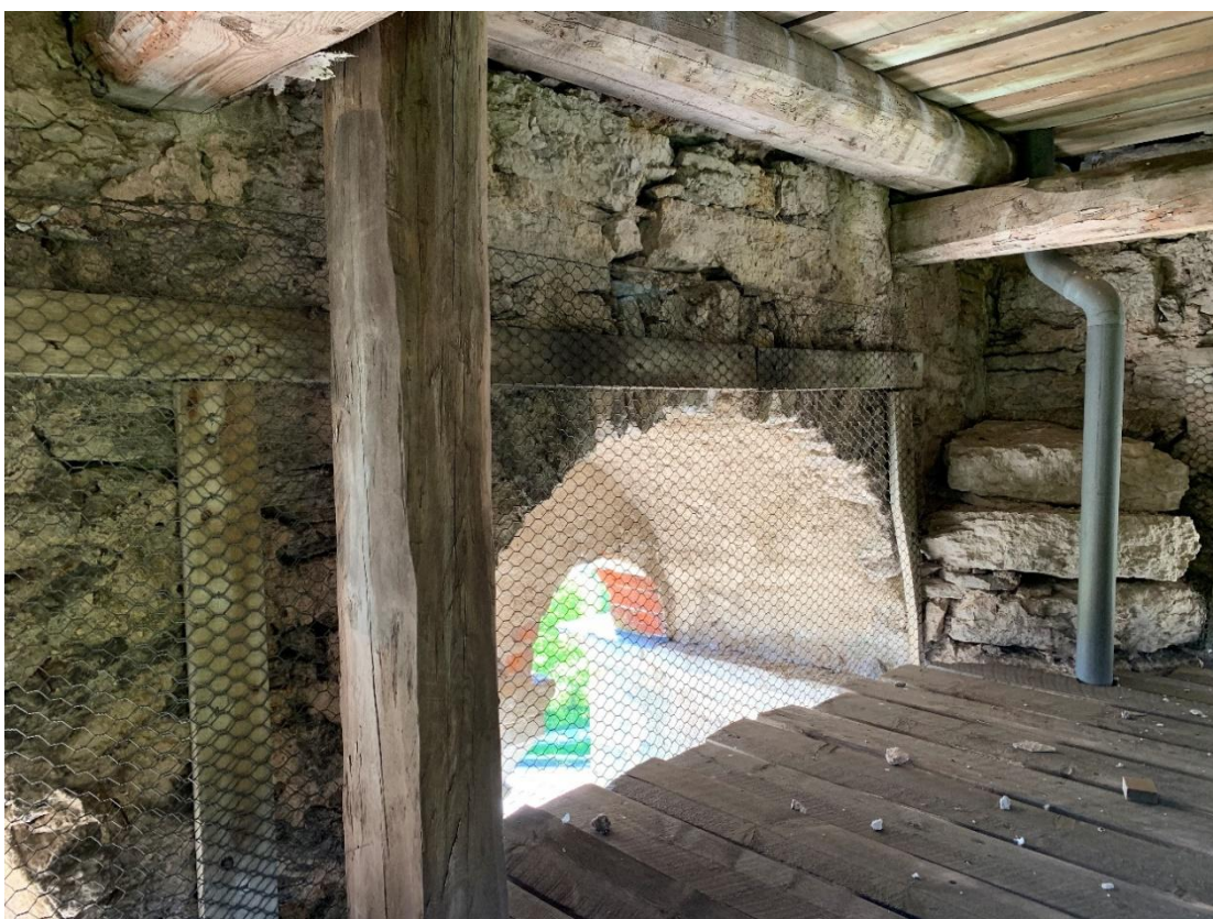
Mellanvåning över klockvåningen, sedd mot sydöst. Foto JL 2021.
