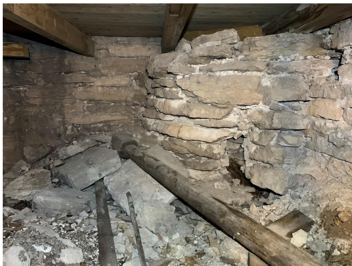
Tornets tredje övervåning, en mellenvåning med begränsad takhöjd under klockvåningens vattendäck. I de fyra hörnen rundade murförstärkningar med infällda bjälkhål i höjd med bjälkhålet till höger. I förgrunden kolonnetter av trä som tidigare suttit i ljudgluggarna. Foto JL 2021.
