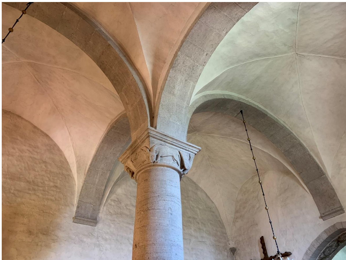
Långhusets valv, sedda mot nordöst. Foto JL 2021.
