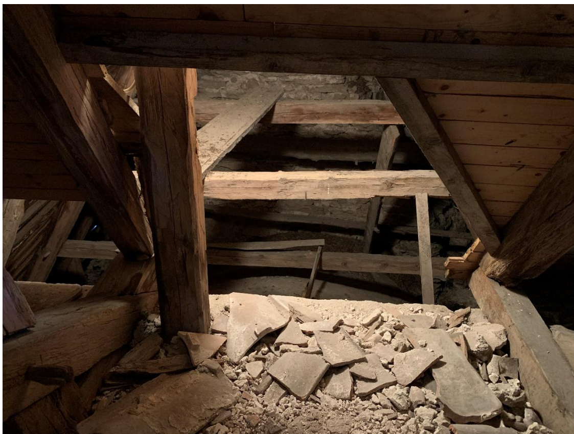
Öppning på korvindens norra sida mot sakristievinden, sedd mot norr. Foto JL 2021.
