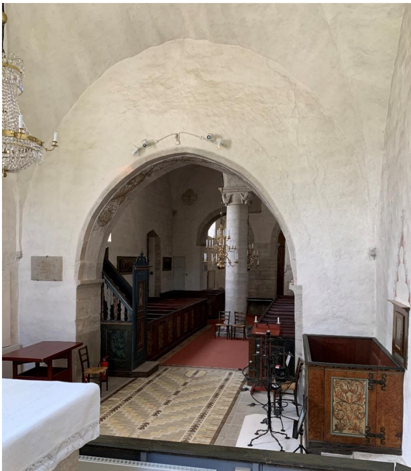
Muren kring triumfbågen sedd från koret. Ojämheter i murpartiet torde vara från det att triumfbågen vidgats och har tolkats som spår av att det tidigare koret haft tunnvalv. En vertikal skarv kan tyda på en inmurad liggande avlastningsbjälke av samma slag som i Stenkyrka på motsvarande plats. Foto JL 2021.
