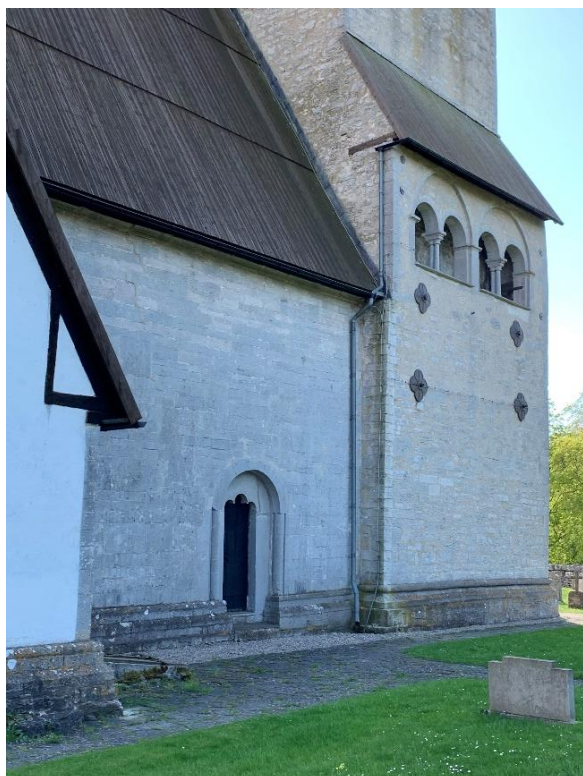
Tornets nedre del från nordöst och väster. Foto JL 2021.
