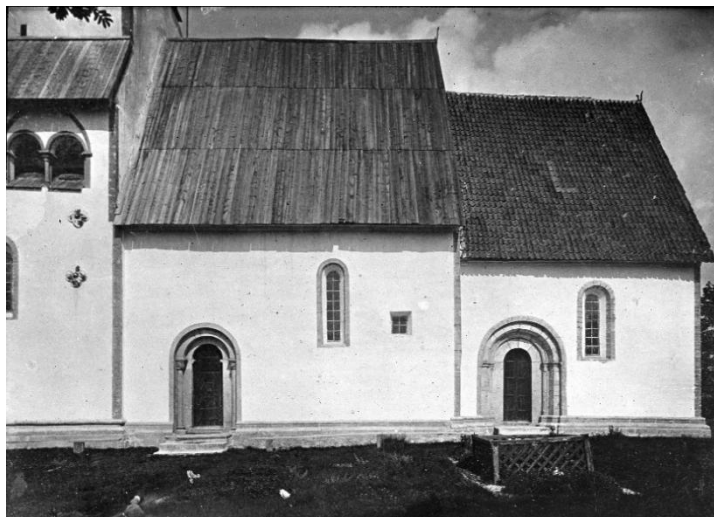
Korets och långhusets södra fasad med ny puts. Foto omkring 1900, ATA.
