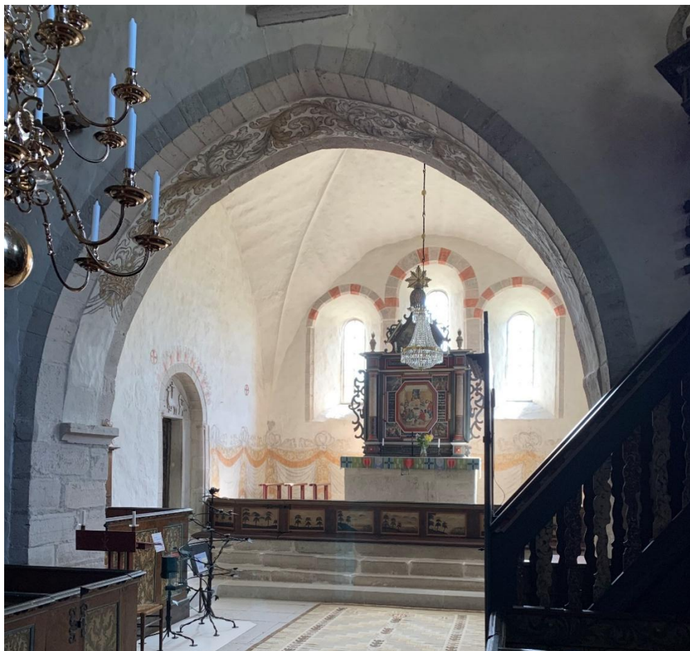
Triumfbågens omfattning sedd från långhuset. Foto JL 2021.
