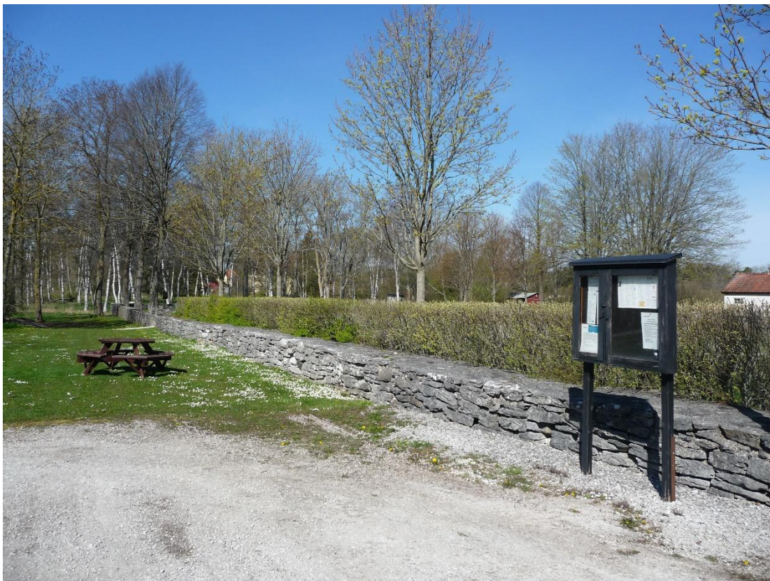
Den västra delen av den södra muren. Innanför terrassmuren växer en häck med måbär. Foto ES 2021.
