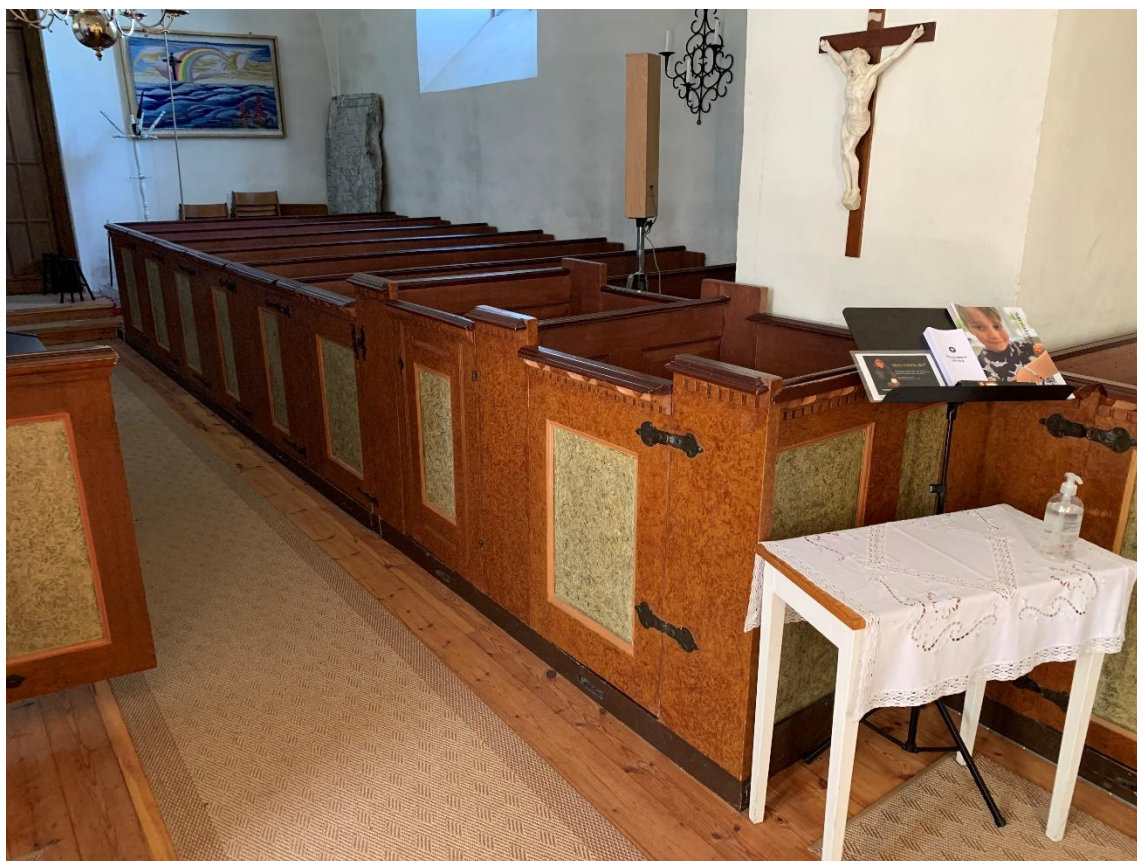
Bänkinredning i tornbågen och ringkammaren. De främsta bänkarna har förhöjda gavlar av ett på 1600-talet karakteristiskt slag som förmodligen funnits på de flesta av kyrkans bänkar. Foto JL 2021.
