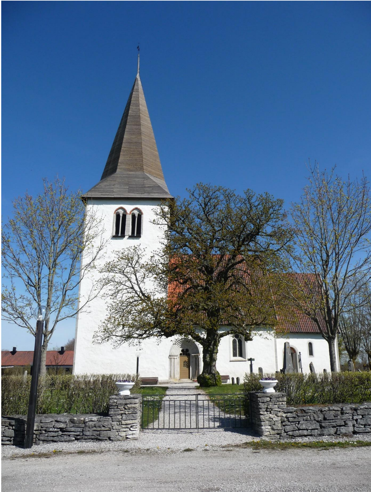
Hangvar kyrka. Huvudingången från söder med dubbla järngrindar och fyrkantiga kallmurade grindstolpar. Foto ES 2021.
