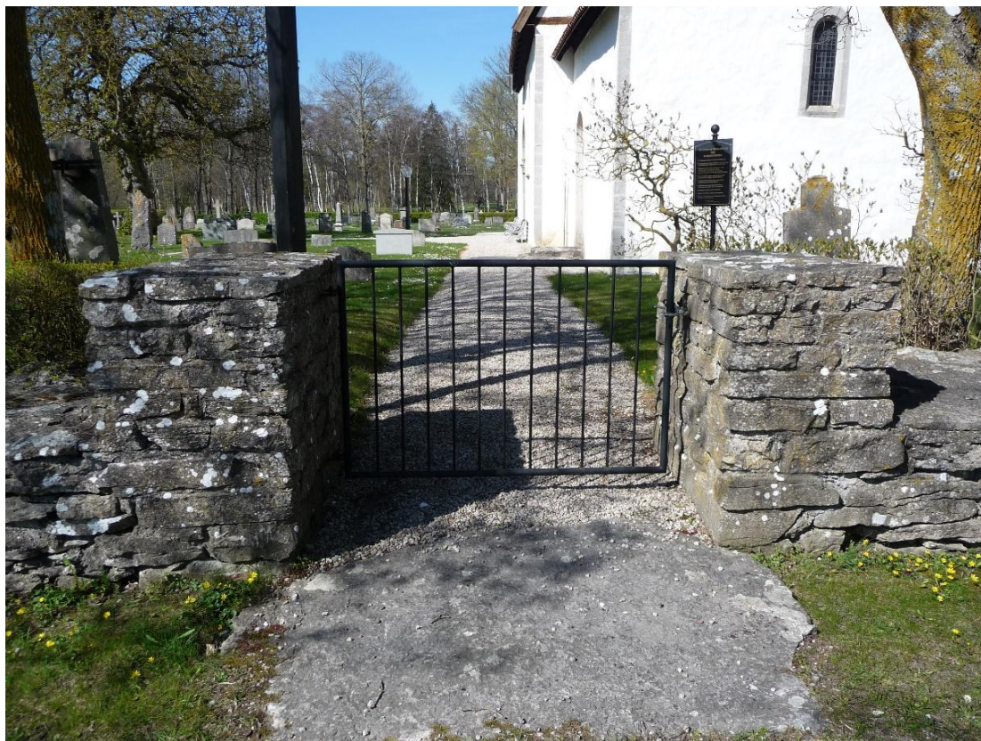
Ingång till den äldre kyrkogården från öster. Ingången har en enkel järngrind och fyrkantiga stolpar av kallmurad kalksten. Foto ES 2021.
