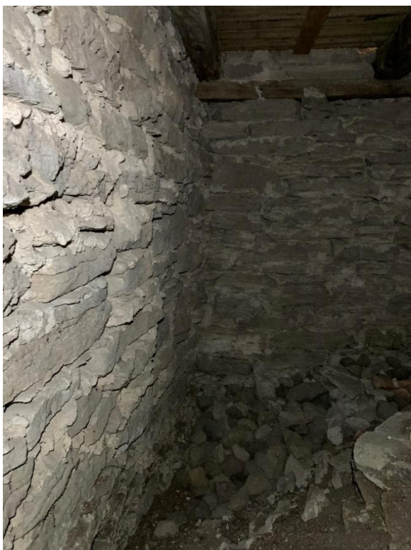
Tornets första övervåning, sedd mot nordvästra hörnet och nordöstra hörnet. Den putsade muren utgör långhusets västgavel. Bjälken är dragstag vid den murade bågens anfang. Foto JL 2021.
