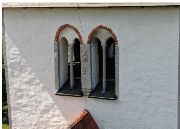
Tornets ljudgluggar mot söder, väster, norr och öster. Skillnaderna i tegelbågarnas murning kan bero på medveten variation eller senare förändringar. Foto Pär Malmros 2021, Visby stift.
