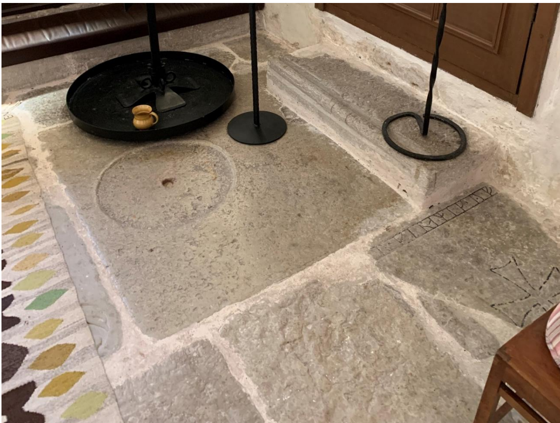
Golvet innanför korportalen med håll för dopfunten, profilerad sten som trappsteg samt gravsten med runinskrift. Foto JL 2021.
