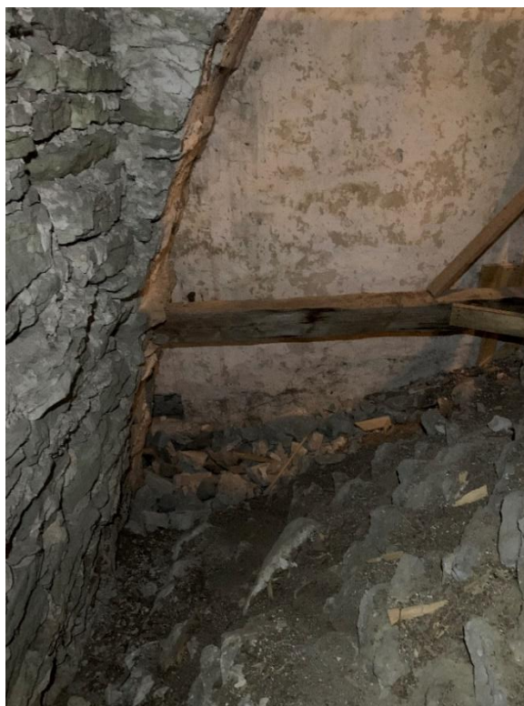
Tornets första övervåning, sedd mot nordvästra hörnet och nordöstra hörnet. Den putsade muren utgör långhusets västgavel. Bjälken är dragstag vid den murade bågens anfang. Foto JL 2021.
