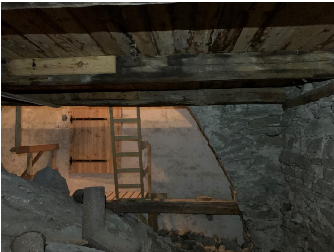
Tornets första övervåning mot sydöst. Trädörren leder till långhusvinden. Dragbjälken som löper mellan den murade bågens anfang är synlig. Foto Ola Nyström 2021, Gotlands Museum.
