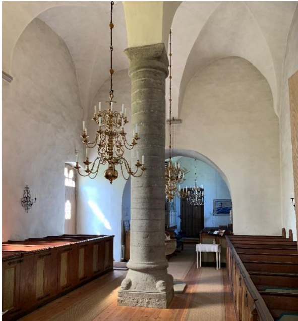
Interiör mot väster. Foto JL 2021.
