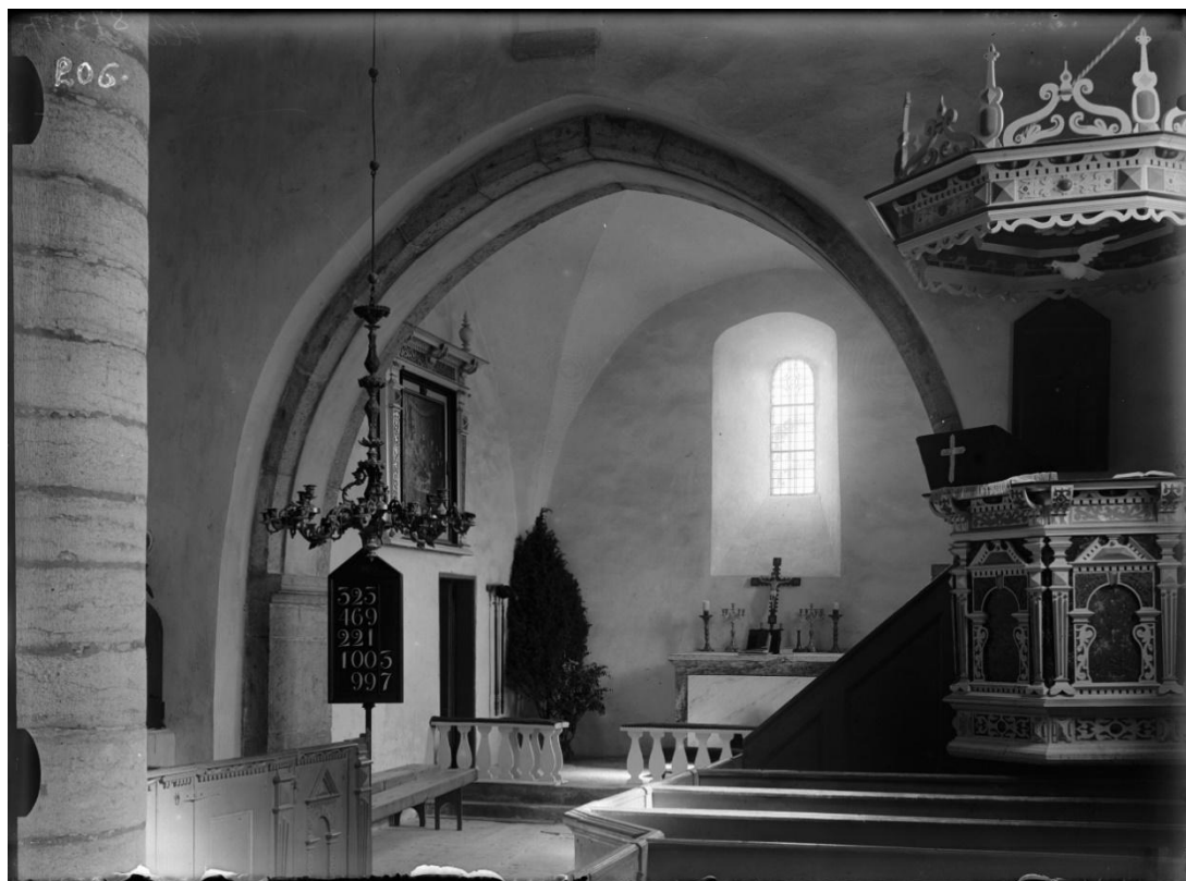
Interiör mot öster efter restaureringen 1910. Altartavlan har fästs på korets norra mur, utan krön, och korfönstret har ny spröjsning. Altaret har kvar sin marmorering från 1882, altarringen är från 1800-talet. Foto Anders Roland 1910, ATA, RAÄ.
