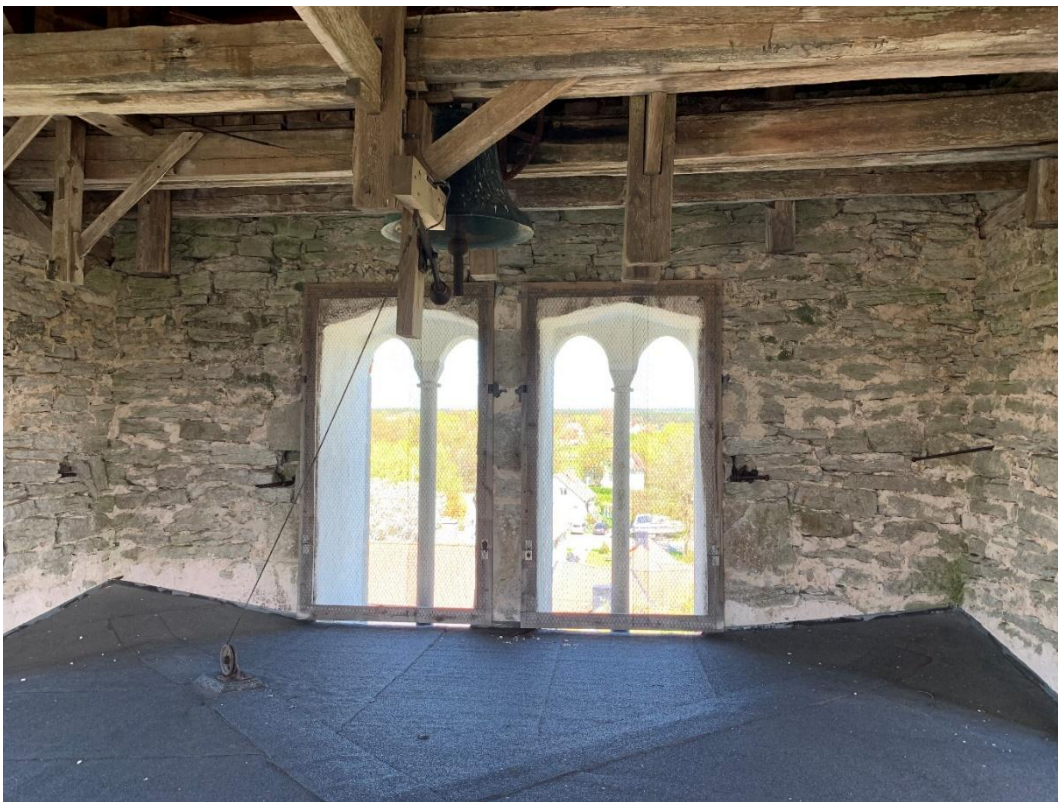
Klockvåningen sedd mot norr. Foto JL 2021.
