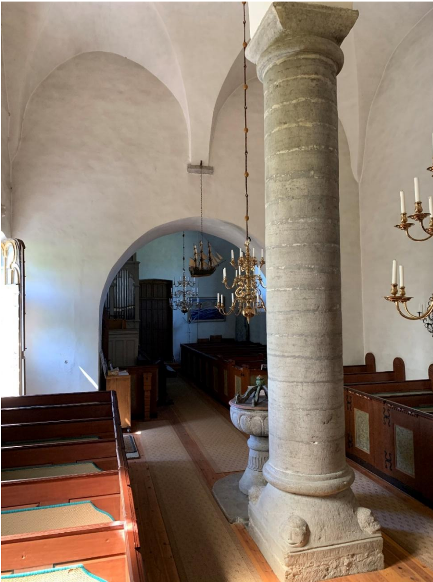
Interiör mot väster. Foto JL 2021.
