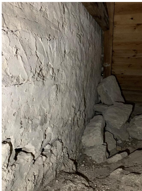
Takstolar på korvinden norra sida. Till höger korvindens nordvästra hörn med långhusets östra gavelröste. Kvarsittande puts visar att det varit putsat mot koret. Sättningsprickorna nedtill kan ha uppstått i samband med vidgning av triumfbågen. Foto JL 2021.
