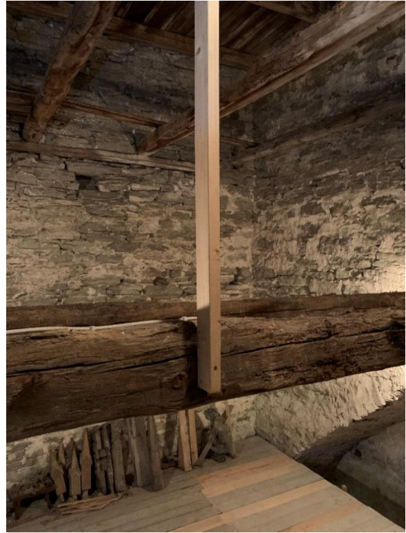
Tornets andra övervåning sedd mot nordväst snett uppåt och sedd mot nordöst i höjd med de två ankarbjälkarna som går i öst-västlig riktning över rummet. Högre upp ett bjälklag för en tidigare tredje övervåning. Foto JL 2021.
