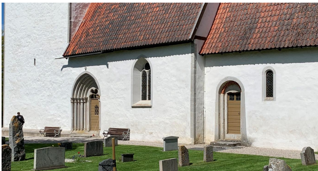
Långhusets och korets södra fasad från sydöst. Foto JL 2021.
