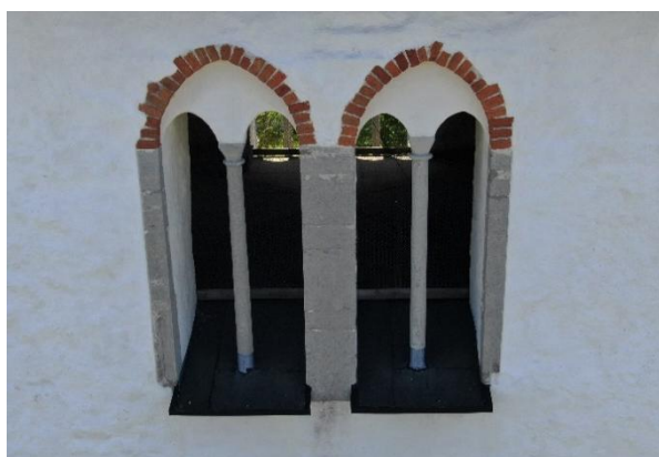
Tornets ljudgluggar mot söder, väster, norr och öster. Skillnaderna i tegelbågarnas murning kan bero på medveten variation eller senare förändringar. Foto Pär Malmros 2021, Visby stift.
