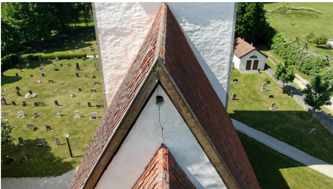
Långhusetets tak och östra gavelnock. Foto Pär Malmros 2021, Visby stift.
