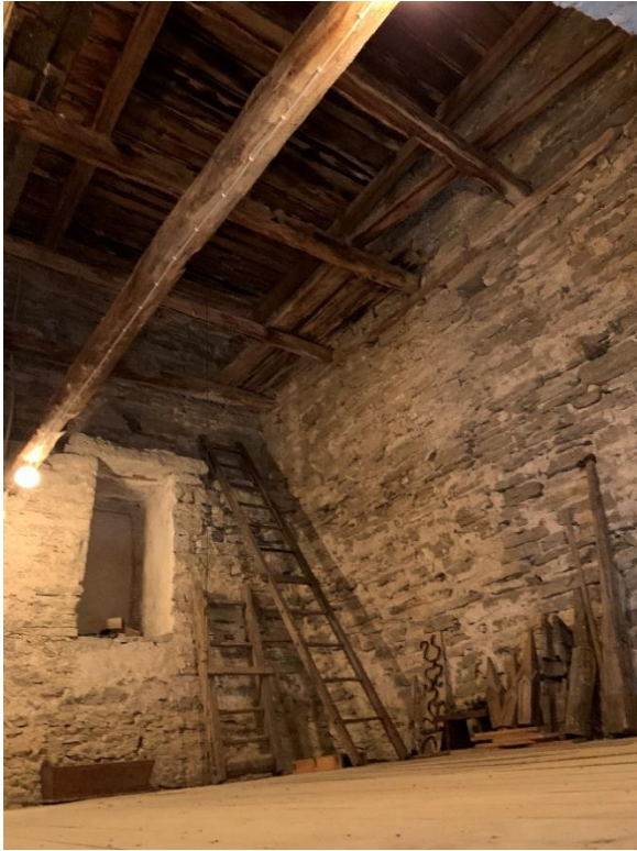
Tornets andra övervåning sedd mot nordväst snett uppåt och sedd mot nordöst i höjd med de två ankarbjälkarna som går i öst-västlig riktning över rummet. Högre upp ett bjälklag för en tidigare tredje övervåning. Foto JL 2021.
