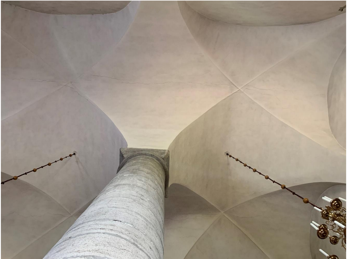
Långhusets valv, norr nedåt. Foto Ola Nyström 2021, Gotlands Museum.
