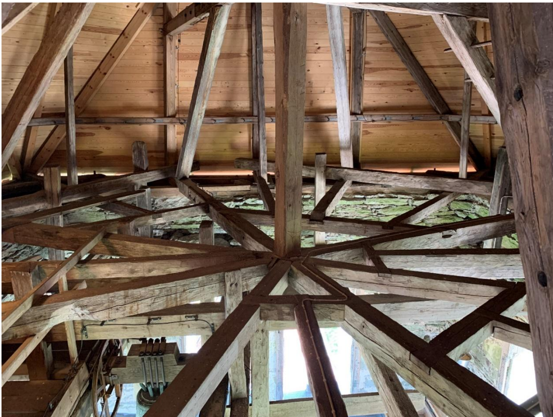
Tornhuvens stjärnformade bärverk. Foto JL 2021.
