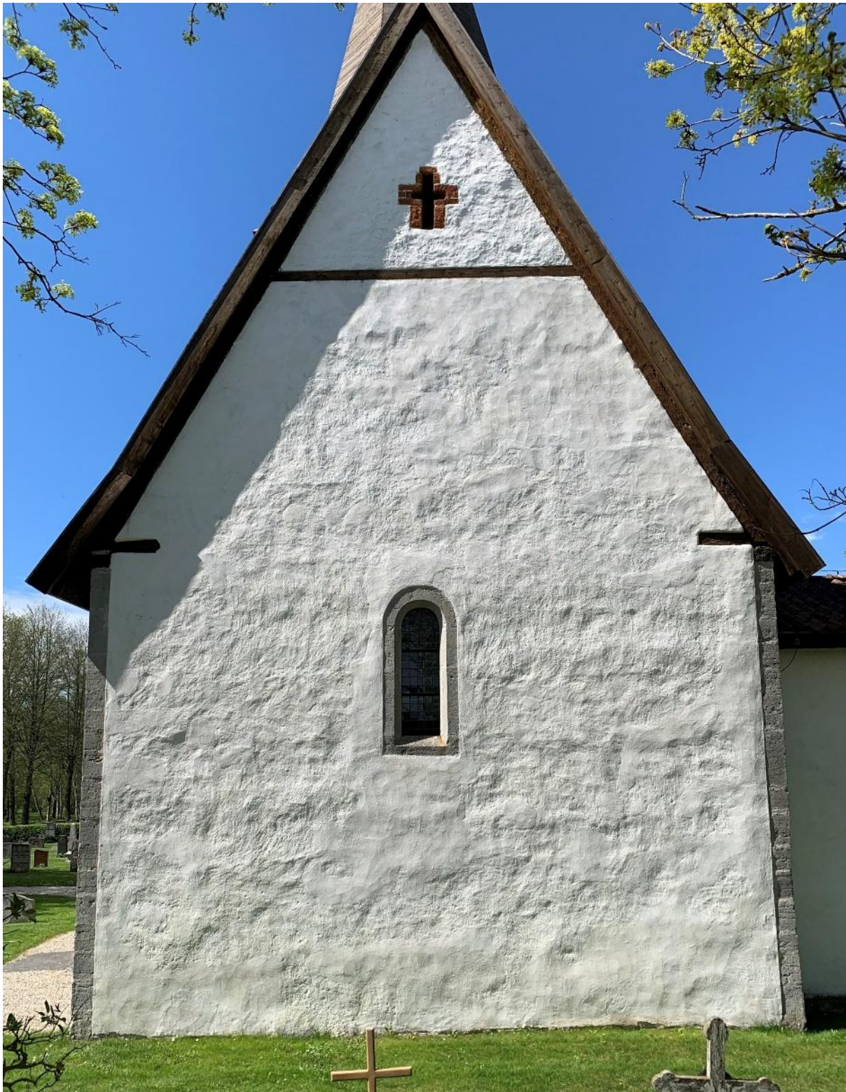
Korets östra fasad. Foto Ola Nyström 2021, Gotlands Museum.
