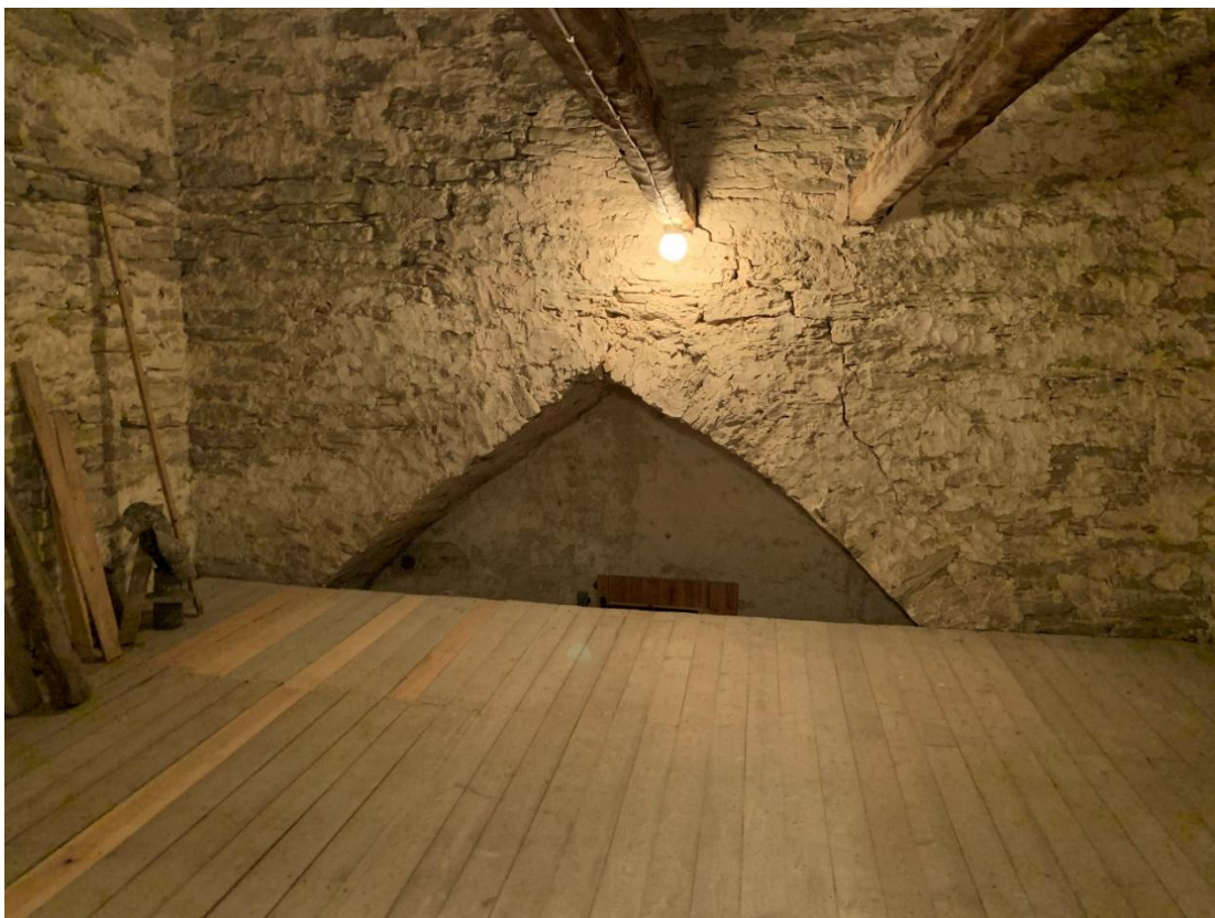
Tornets andra övervåning sedd mot öster med övre delen av östra tornmurens sparbåge samt två ankarbjälkar mellan östra och västra tornmuren. Foto JL 2021.
