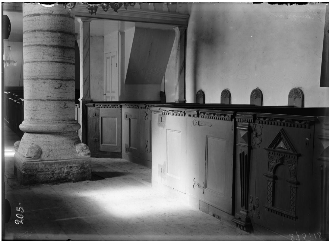
Interiör mot väster efter restaureringen 1910. Mittgången är breddad vid kolonnen, vars färg är borttagen. Läktaren är ännu kvar. Foto Anders Roland 1910, ATA, RAÄ.
