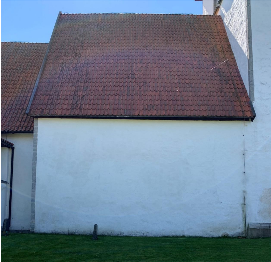
Långhusetets norra fasad. Foto Ola Nyström 2021, Gotlands Museum.
