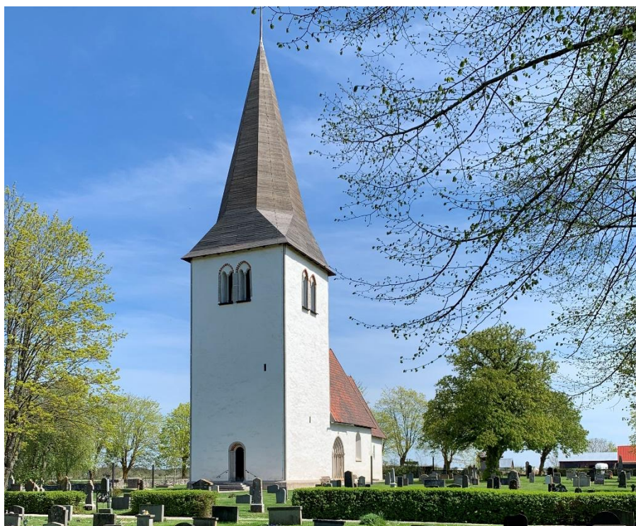
Exteriör från sydväst. Foto JL 2021.
