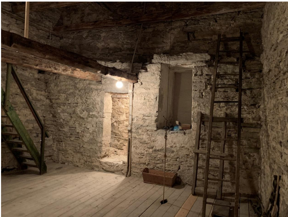
Tornets andra övervåning sedd mot väster med trappans mynning och igensatt lastport. Foto JL 2021.
