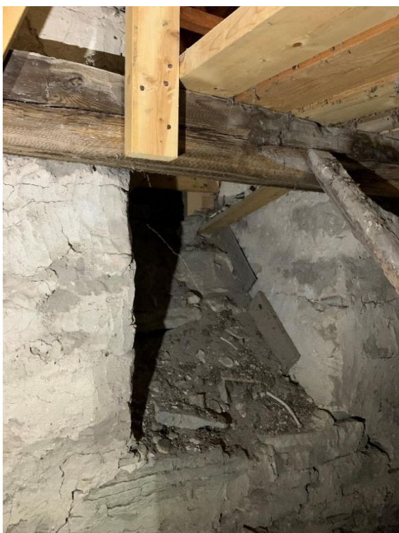
Passage mellan långhus- och korvindarna, sedd från öster, till vänster nedre, till höger övre delen. Den nedtill fint murade öppningen har förstörats uppåt efter valvens tillkomst. Foto JL 2021.
