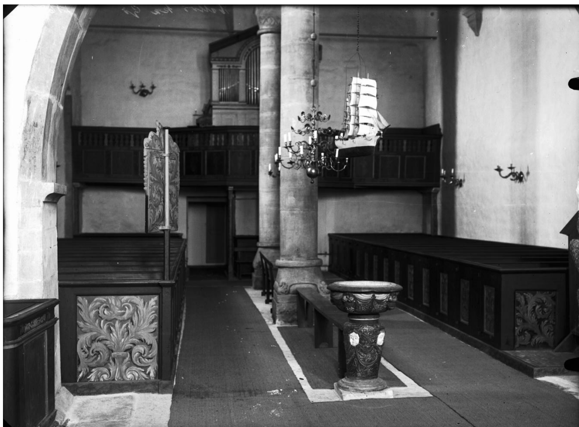
Interiör mot väster efter restaurering 1926-27. Läktaren flyttades på 1950-talet till långhusets norra sida i förminskat skick. Foto Henning Svensson 1931, ATA.
