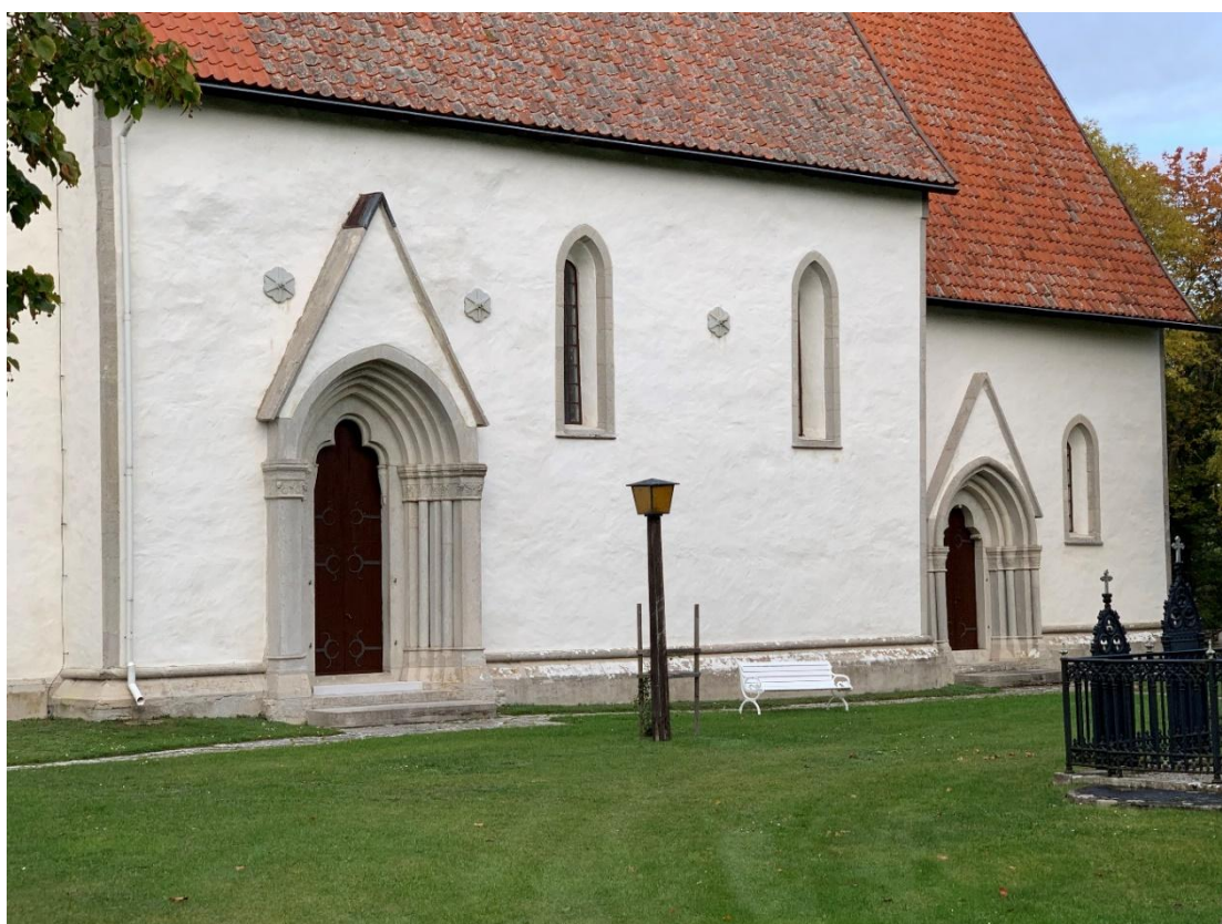
Långhusets och korets sydfasader. Foto JL 2019.
