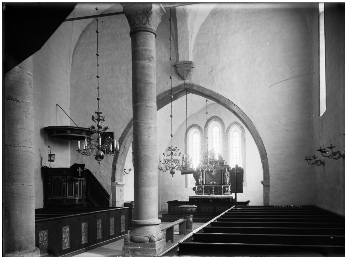
Interiör mot öster efter restaureringen 1926-27. Foto Alfred Edle 1933, ATA.
