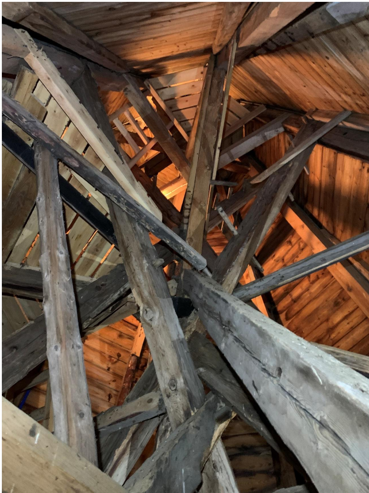
Vy uppåt i tornhuvens övre del, sedd från klockvåningen i tornhuv. Foto JL 2021.
