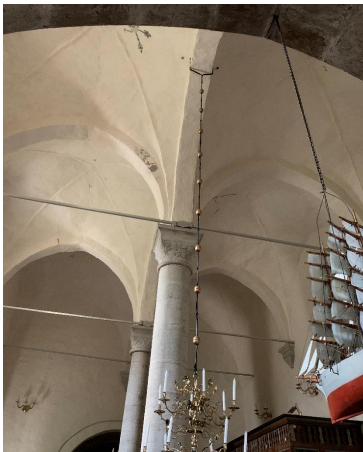
Långhusvalven, sedda mot väster. Foto JL 2019.
