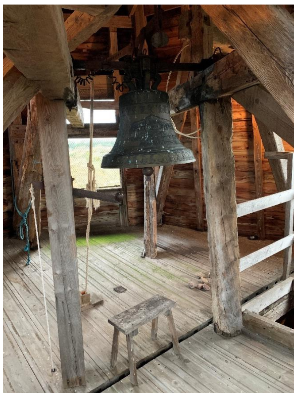
Klockvåningen i tornhuven. Foto JL 2021.
