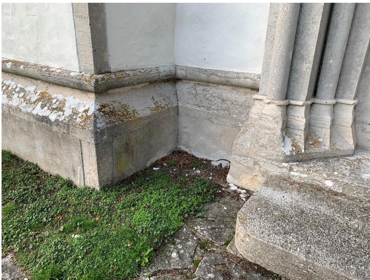
Långhusets sydöstra hörn med sockeln i övergången mot korets södra mur med korportalens västra basband till höger. Foto JL 2019.
