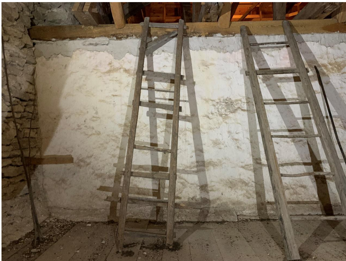
Sakristians vind mot söder med korets norra yttermur med puts från före 1850-talet. Foto JL 2021.
