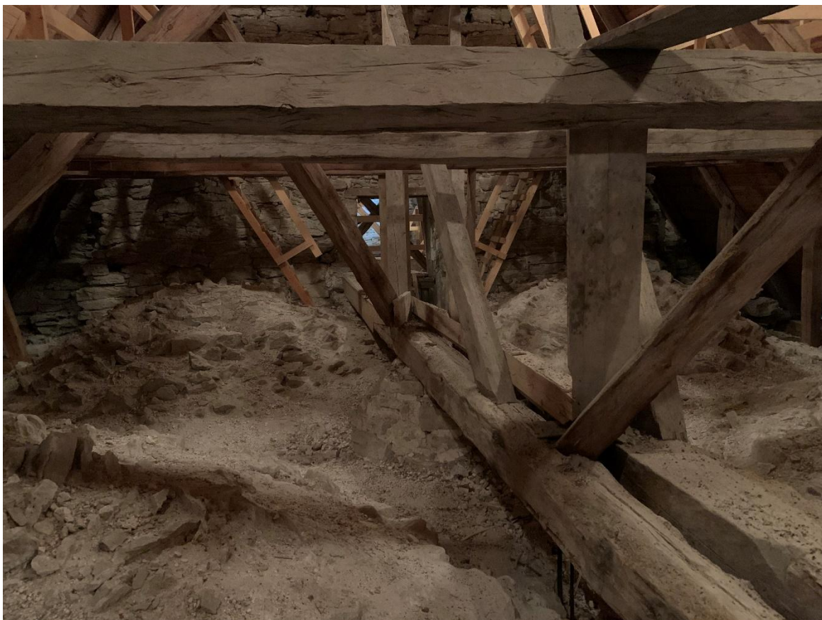
Långhusvinden mot öster med valvens ovansidor. Foto JL 2021.
