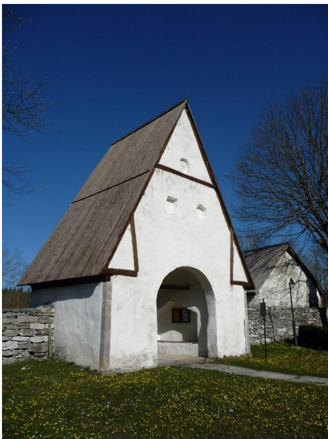
Den västra stigluckan fotograferad från väster. Foto ES 2021.
