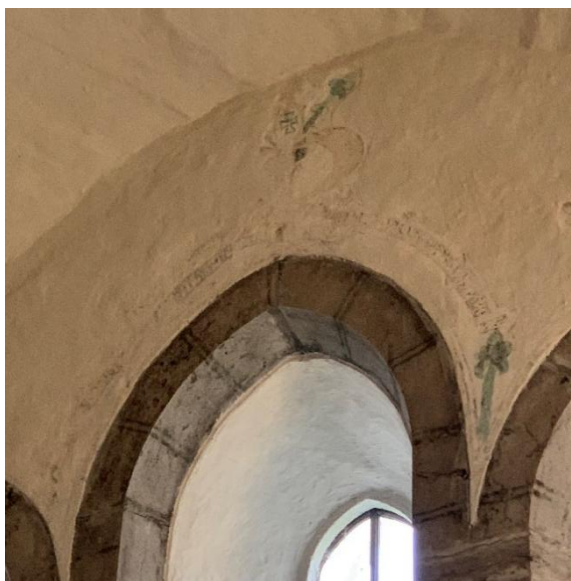
Kalkmålningar på korets östra mur, visande helig biskop söder om altaret, samt en inskrift med runor ovanför mellersta fönstret i öster, delvis framtagna 2008. Enligt en preliminär tolkning säger inskriften att Botulf Rodvidsson målade kyrkan. Foto JL 2019.
