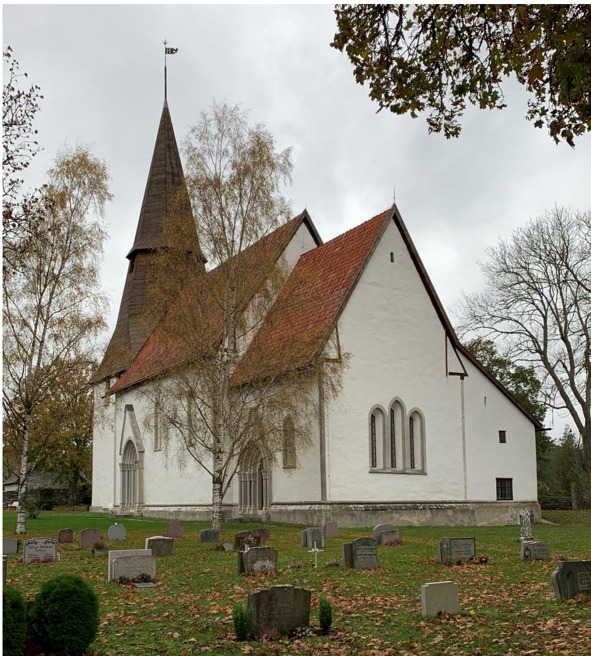
Exteriör från sydöst. Foto JL 2021.
