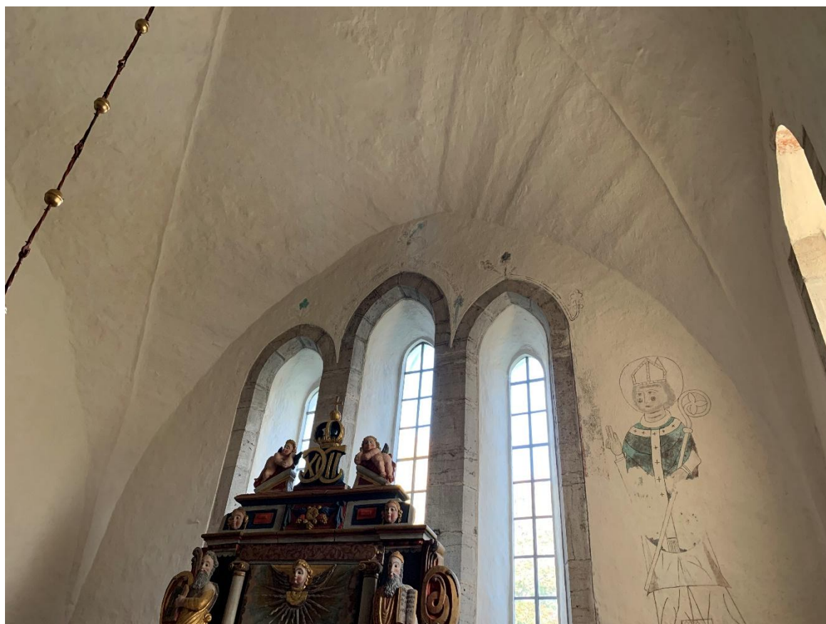
Korets östra valvkappa samt trefönsterggruppen i öster. Foto JL 2019.
