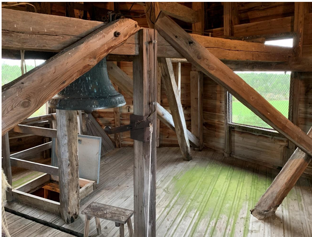
Klockvåningen i tornhuven. Foto JL 2021.
