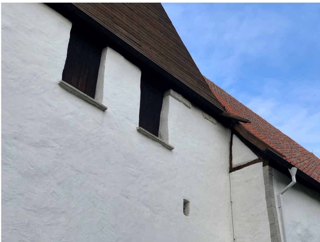
Södra tornfasadens övre del med ljudgluggar och inmurade opputsade stenblock öster om ljudgluggarna. Foto JL 2019.
