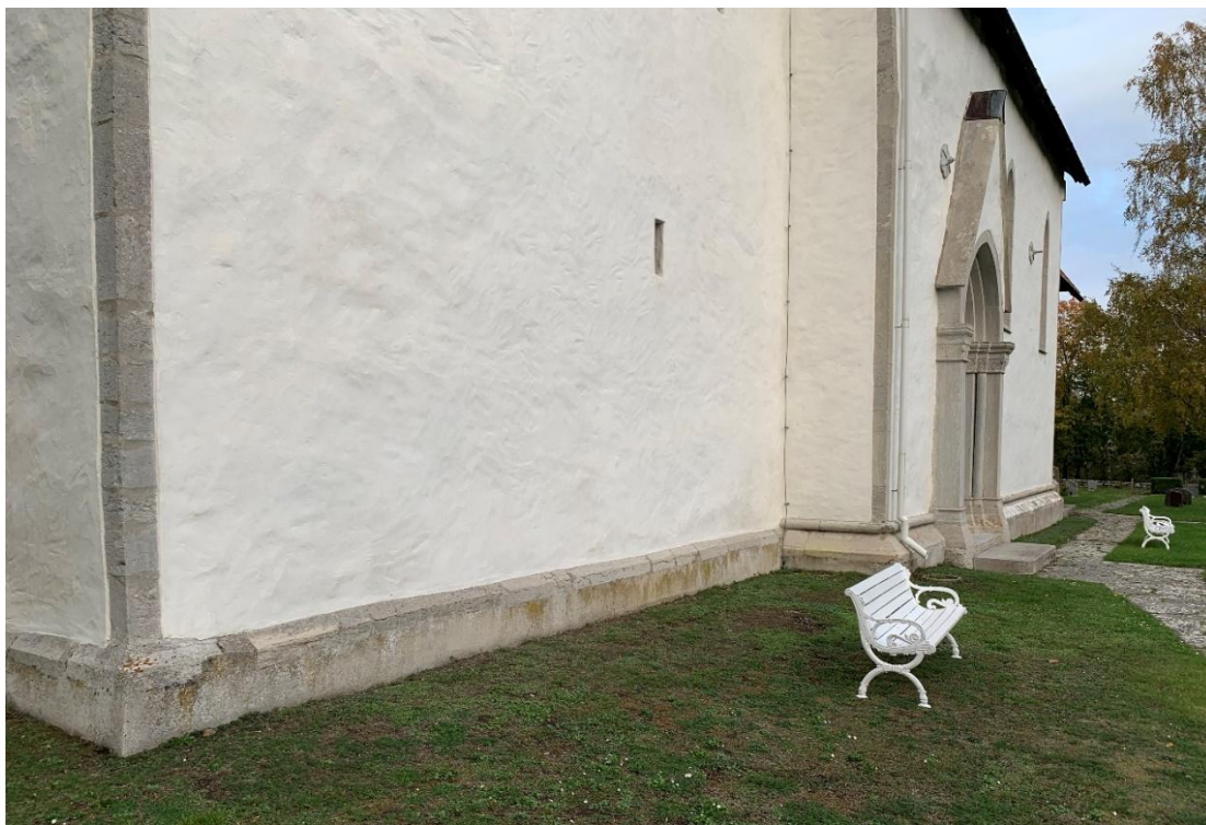
Sockeln på tornets södra sida. Foto JL 2019.
