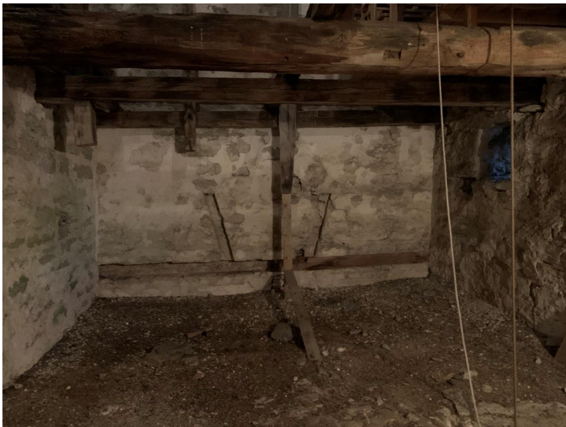
Tornets första övervåning mot öster. I fonden det äldre långhusets bevarade västgavel. Foto JL 2021.
