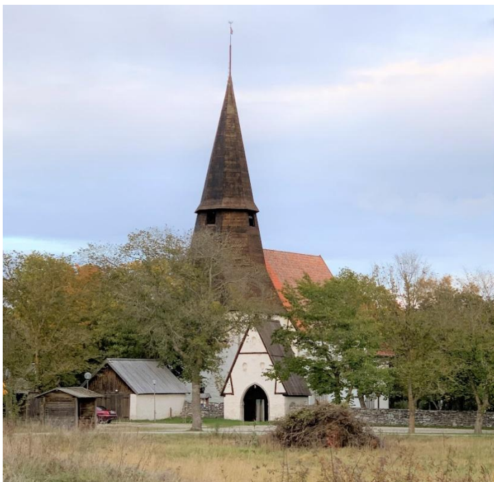
Exteriör från sydväst. Foto JL 2019.
