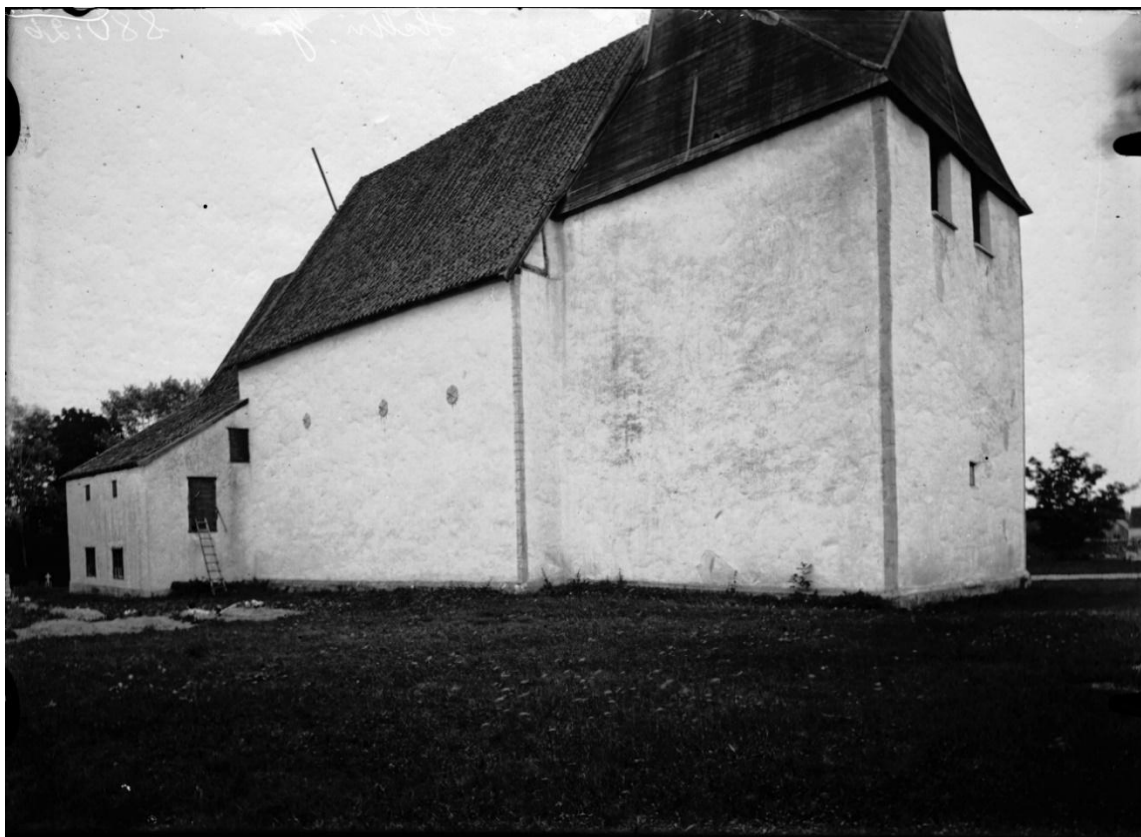
Kyrkan från nordväst på 1910-talet. Dörren till värmekammaren i sakristiebyggnaden har ännu inte tillkommit. Foto Anders Roland 1919, ATA.
