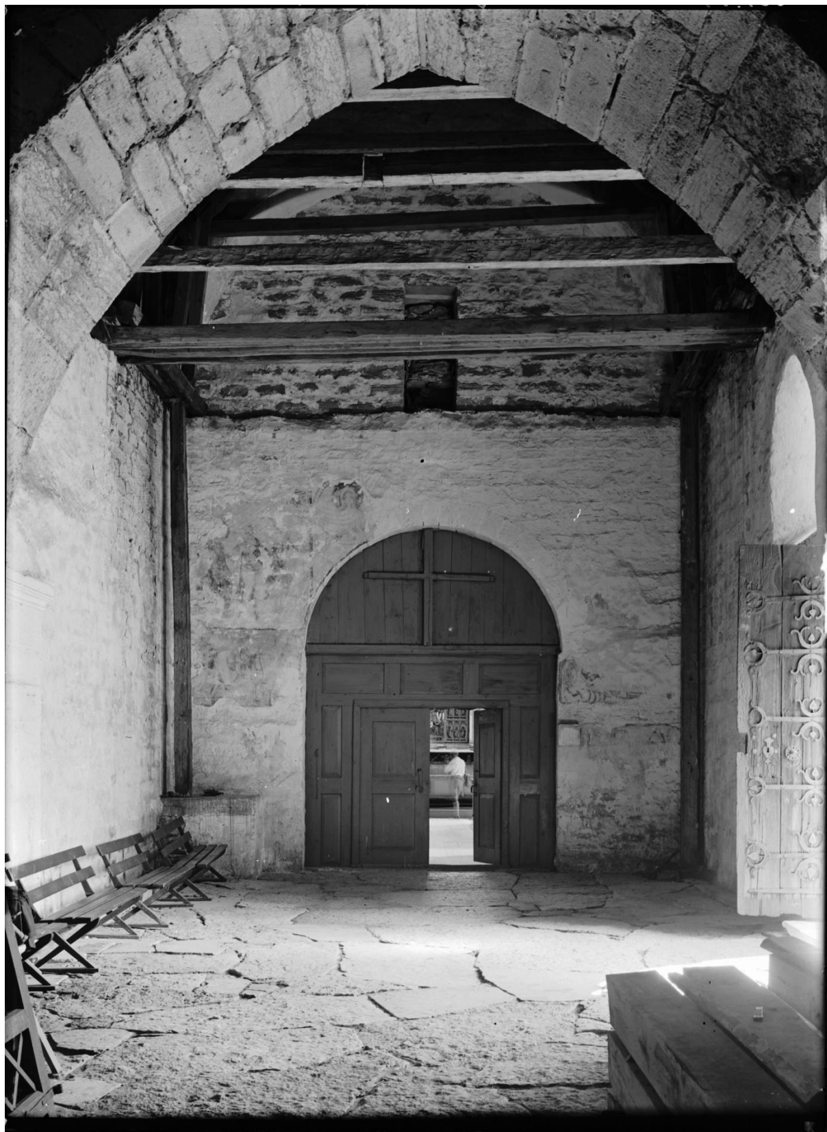
Gammalkyrkan, det romanska långhuset, mot öster före restaureringen 1951. Rummet hade fungerat som magasin och sannolikt vapenhus (förhall). Foto Alfred Edle 1926, ATA, RAÄ.
