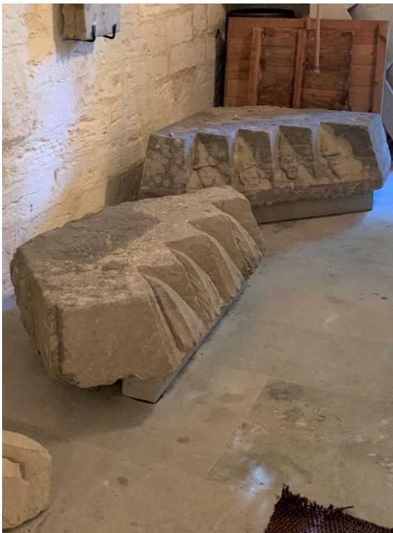
Basband i ej utförd portal, troligen tänkt som västportal. Till höger murat väggparti, avsett som vederlagsmur i en ej utförd tornbåge. Foto JL 2021.
