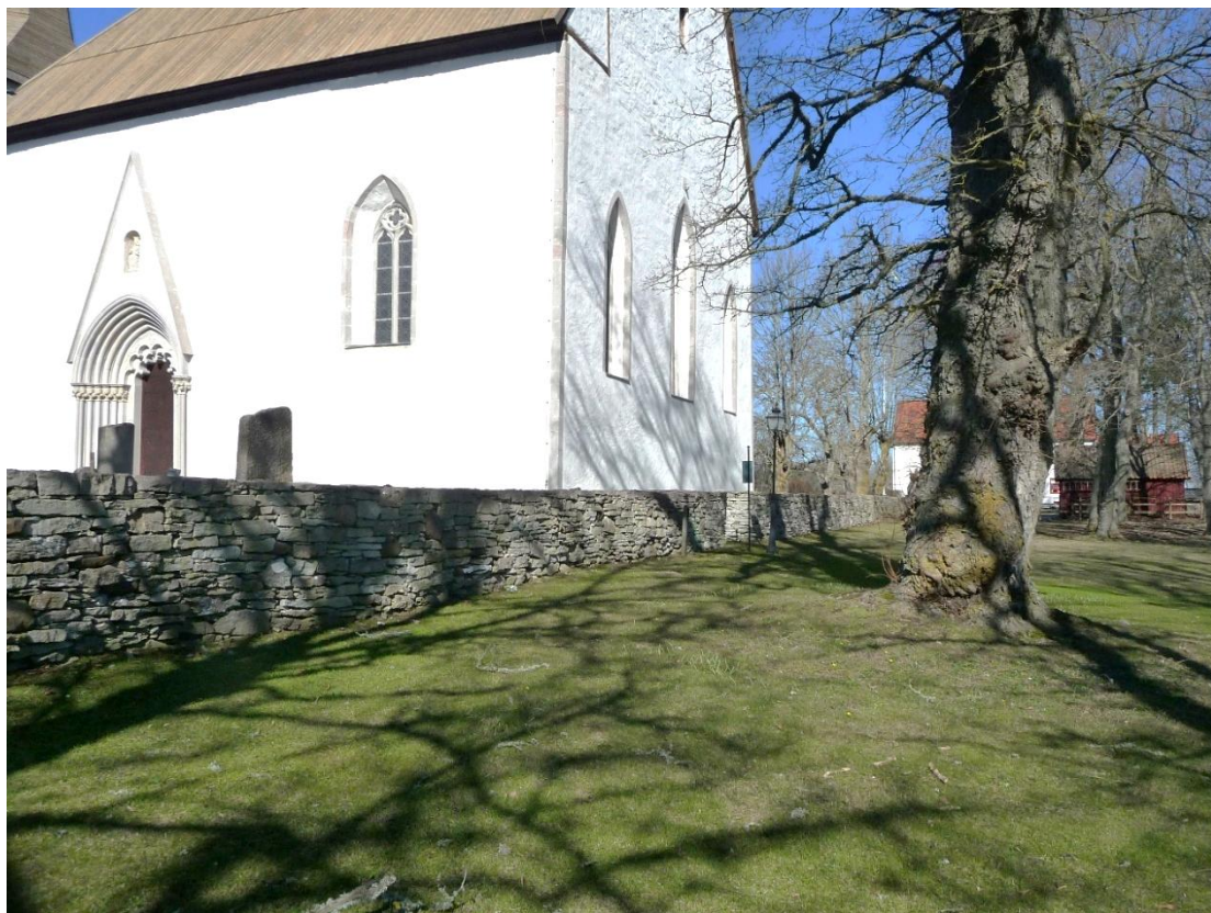
I söder, öster och norr finns kalkstensmurar. Här den östra muren. Foto ES 2021.
