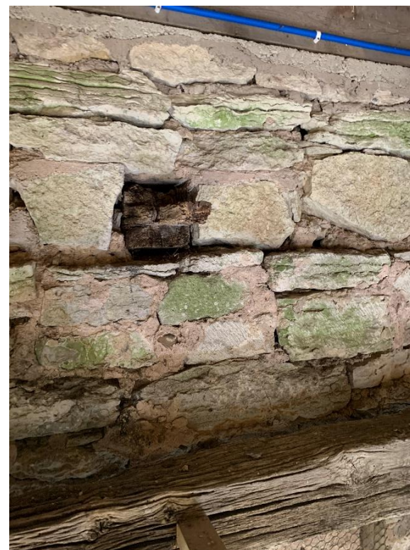
Klockväningen sedd ovanifrån med rester av ett tidigare bjälklag och spår av en påbyggnad eller ommurning, sedd mot nordväst. Till höger detalj av kortare bjälke in i västra muren. Foto JL 2021.
