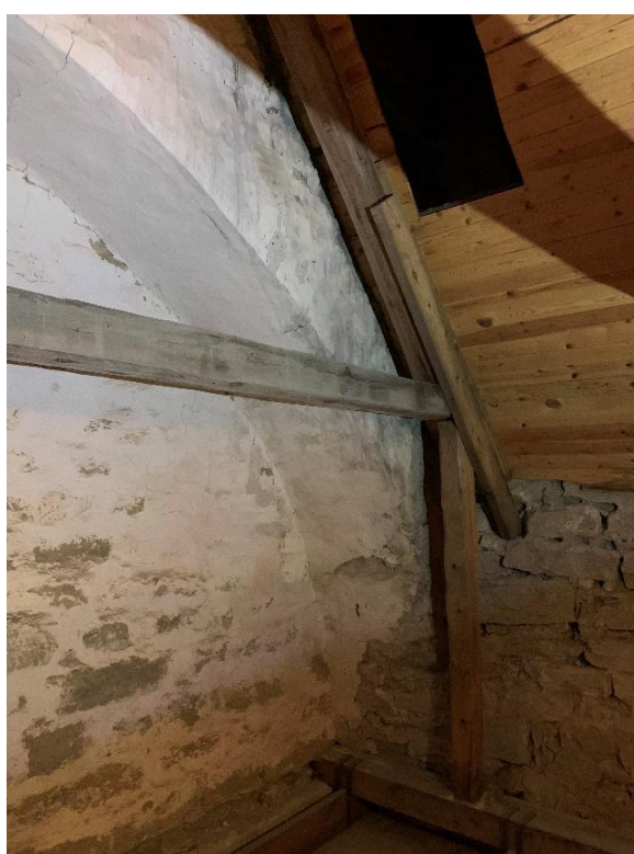
Murverket söder om den tidigare passagen till korvinden. Till höger avlastningsbåge från nuvarande korets byggnadstid samt ett stycke av strävpelaren ovanför södra långhusmuren. Över denna öppning till taket från 1950-talet ovanför strävpelaren. Foto JL 2021.
