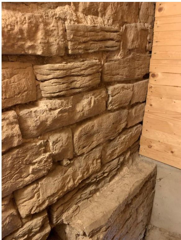
Tornmurens insida i sydöstra respektive sydvästra hörnet av tornets första övervåning, till vänster inne i kuren ovanför valvöppningen. Murverket är vittrat mot söder och väster men inte mot väster och norr. Vissa block har en anmärkningsvärd längd i förhållande till sin tjocklek och kan vara återanvända från annat sammanhang. Foto JL 2021.
