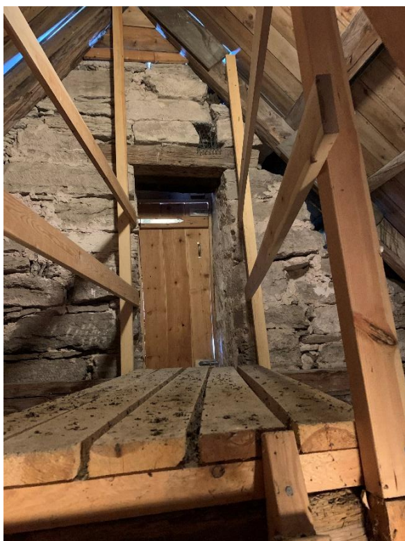
Östgavelns spets med den övre lastporten. Den rektangulära öppningen ovanpå bjälken är går genom muren och är sannolikt avsedd för en hissbox. Några av blocken i gaveln har en finare behuggning som talar för att de kommer från den romanska kyrkan. Till höger korvinden mot väster, sett från den övre lastporten. Foto JL 2021.
