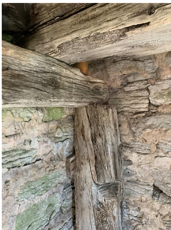
Delar av klockstolen, klockans bärkonstruktion, sedd mot nordvästra respektive sydvästra hörnet. Urtag, bland annat från tidigare klockupphängningar, visar att det väderbitna virket använts och återanvänts under lång tid. Foto JL 2021.
