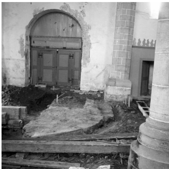
Det romanska korets grundmurar under utgrävning 1951, sedda mot väster. Den åttkantiga pelaren står med ena kanten på grundmuren. Kalkmålningarna i triumfbågen endast fragmentariskt synliga och brädväggen ännu övermålad. Foto Ingrid Swartling 1951, ATA, RAÄ.
