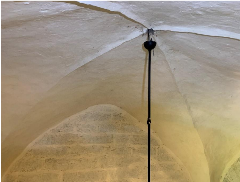
Valvet över tornets bottenvåning, sannolikt från 1200-talets mitt eller senare. Till höger delar till ej utförd valvpilaster. Foto JL 2021.
