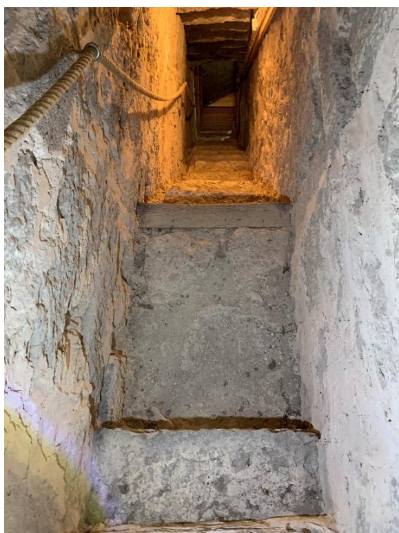
Till vänster murtrappan till korvinden sedd nedåt mot öster det första av två vilplan i trappan. Dess kantsteg utgörs av den bjälke vars utskjutande ända syns i korets norra fasad, väster om sakristian. Till höger fyrpasformat fönster i murtrappan i höjd med trappans andra vilplan, där en öppning funnits mot kyrkorummet. Foto JL 2021.
