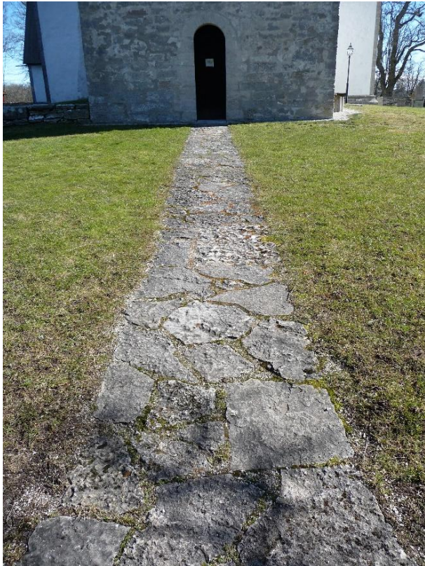
Kyrkogårdens enda gång leder från huvudingången till tornportalen. Den är belagd med kalkstensflis. Foto ES 2021.
