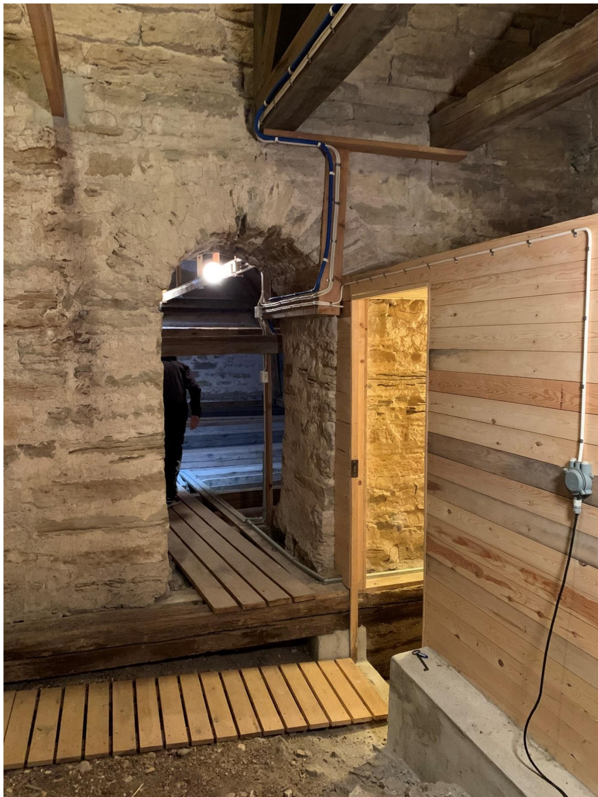
Tornets första övervåning, ingången till tornvinden. Foto JL 2021.
