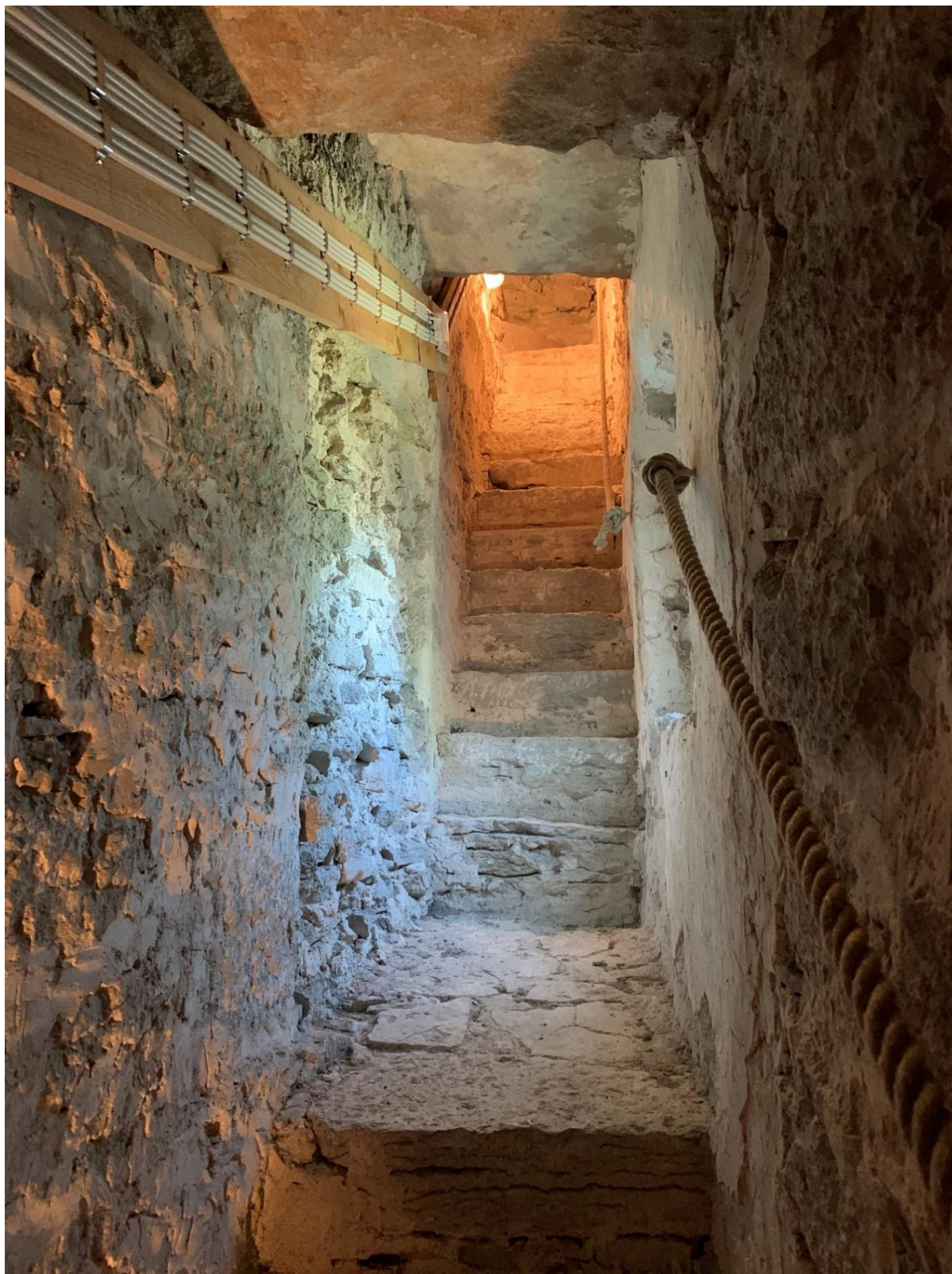
Murtrappan till korvinden sedd mot väster vid trappans andra vilplan vid vilken en nu igenmurad öppning funnits in mot kyrkorummet. Den motstående murytan är putsad innanför öppningen. Någon bröstning syns inte i den igenmurade ytan men kan dölja sig längre in. Foto JL 2021.
