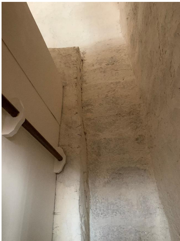
Södra sidoskeppets västra mur, bakom orgelläktaren. Det romanska långhusets sydöstra hörn synligt, utanför vilket den västra muren tilltar i tjocklek i sin nedre del men avtrappas uppåt. Foto JL 2021.
