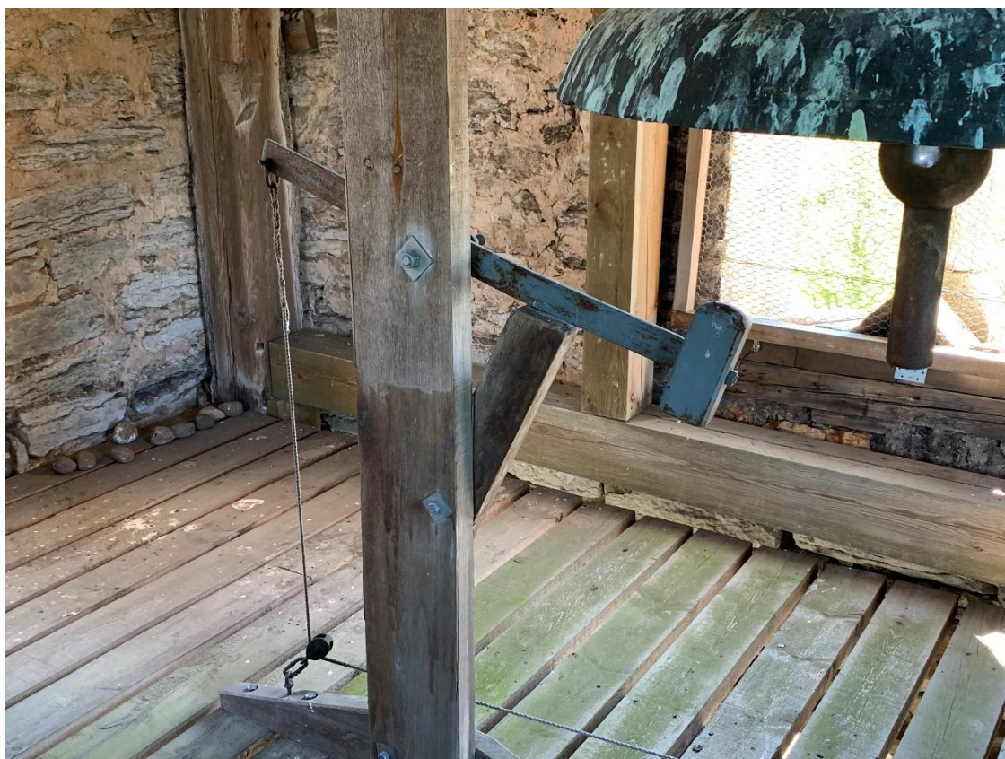
Klämthammare och kimmingsstenar (vid väggen) till klockan. Foto JL 2021.
