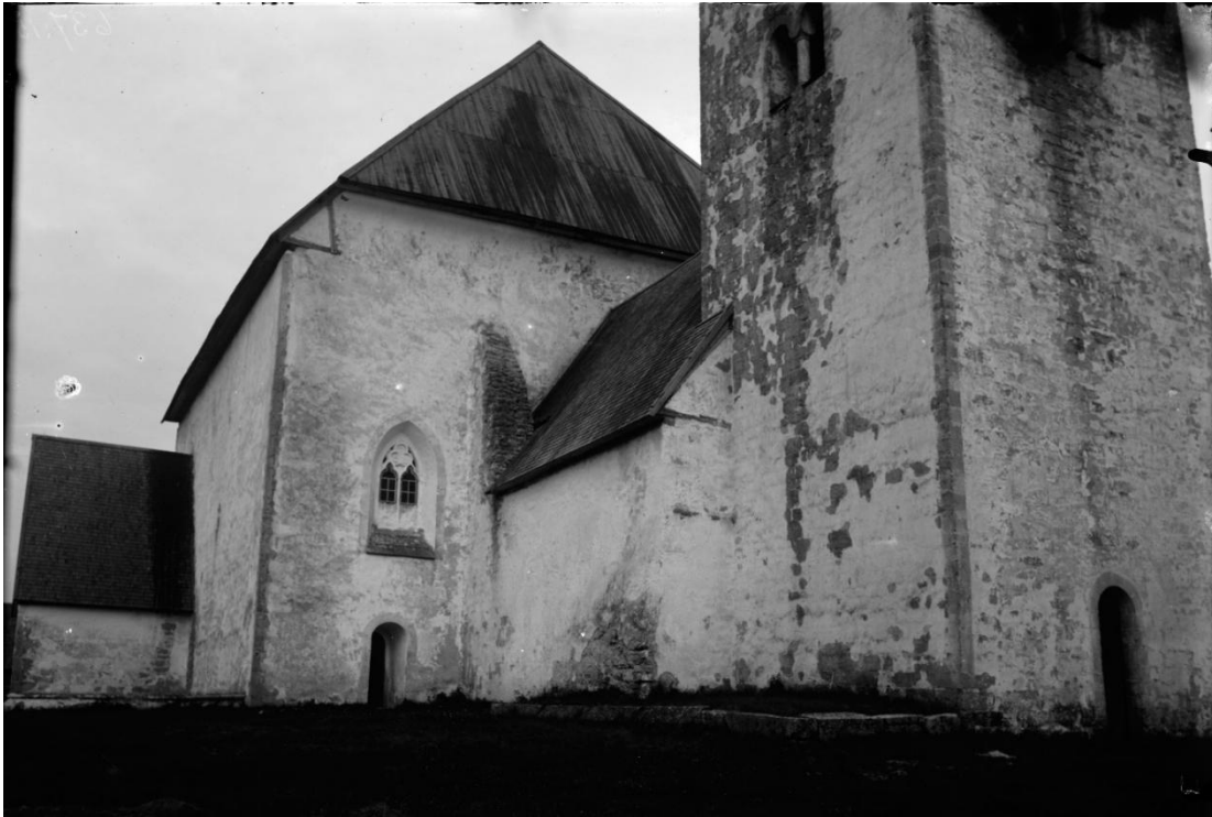
Exteriör från nordöst. Foto Olof Sörling ca 1890, ATA. Korets fönster delvis igensatt, strävmuren ovanför långhusets norra mur saknar tak, tornet putsat.
