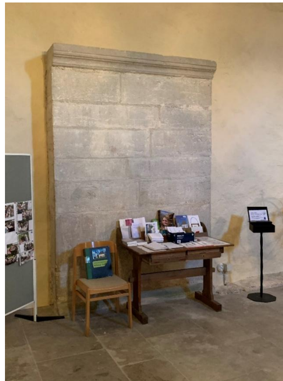
Basband i ej utförd portal, troligen tänkt som västportal. Till höger murat väggparti, avsett som vederlagsmur i en ej utförd tornbåge. Foto JL 2021.
