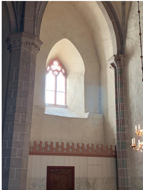
Norra sidoskeppet mot väster. Till höger norra sidoskeppets västra mur. Muren avtrappas uppåt. I förgrunden skärmvägg innanför den lilla västportalen. Foto JL 2021.
