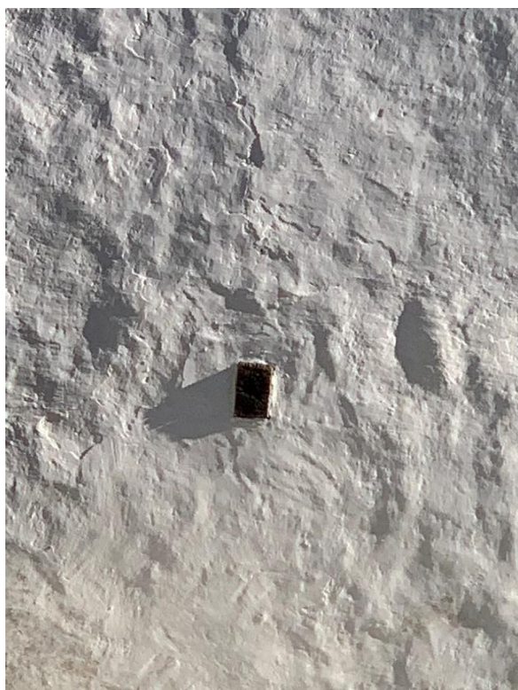
Till vänster inmurat trästycke (bjälkända) av okänd funktion i korets norra mur. Till höger fyrpassformad ljusöppning till murtrappan innanför en tidigare öppning in till kyrkorummet. Foto JL 2021.
