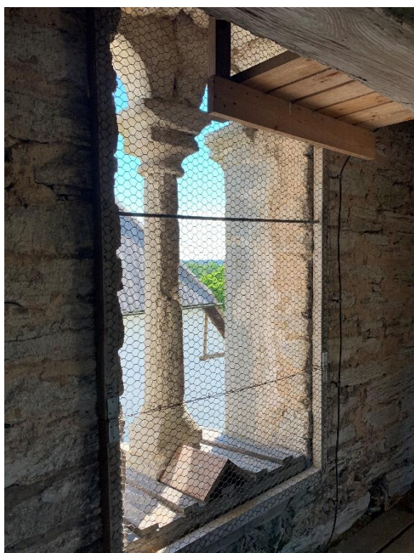
Den östra övre ljudluggen sedd inifrån. Den ursprungliga kolonnen är bevarad. Till höger detalj av västra ljudluggen. Foto JL 2021.
