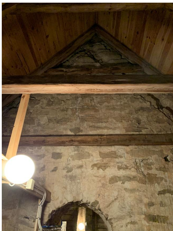
Avtryck av långhusets ursprungliga takfall i tornets östra mur. Foto JL 2021.
