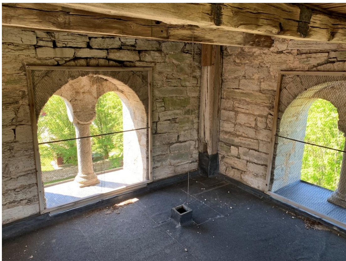
Den nedre våningen med ljudgluggar sedd mot sydväst. Foto JL 2021.
