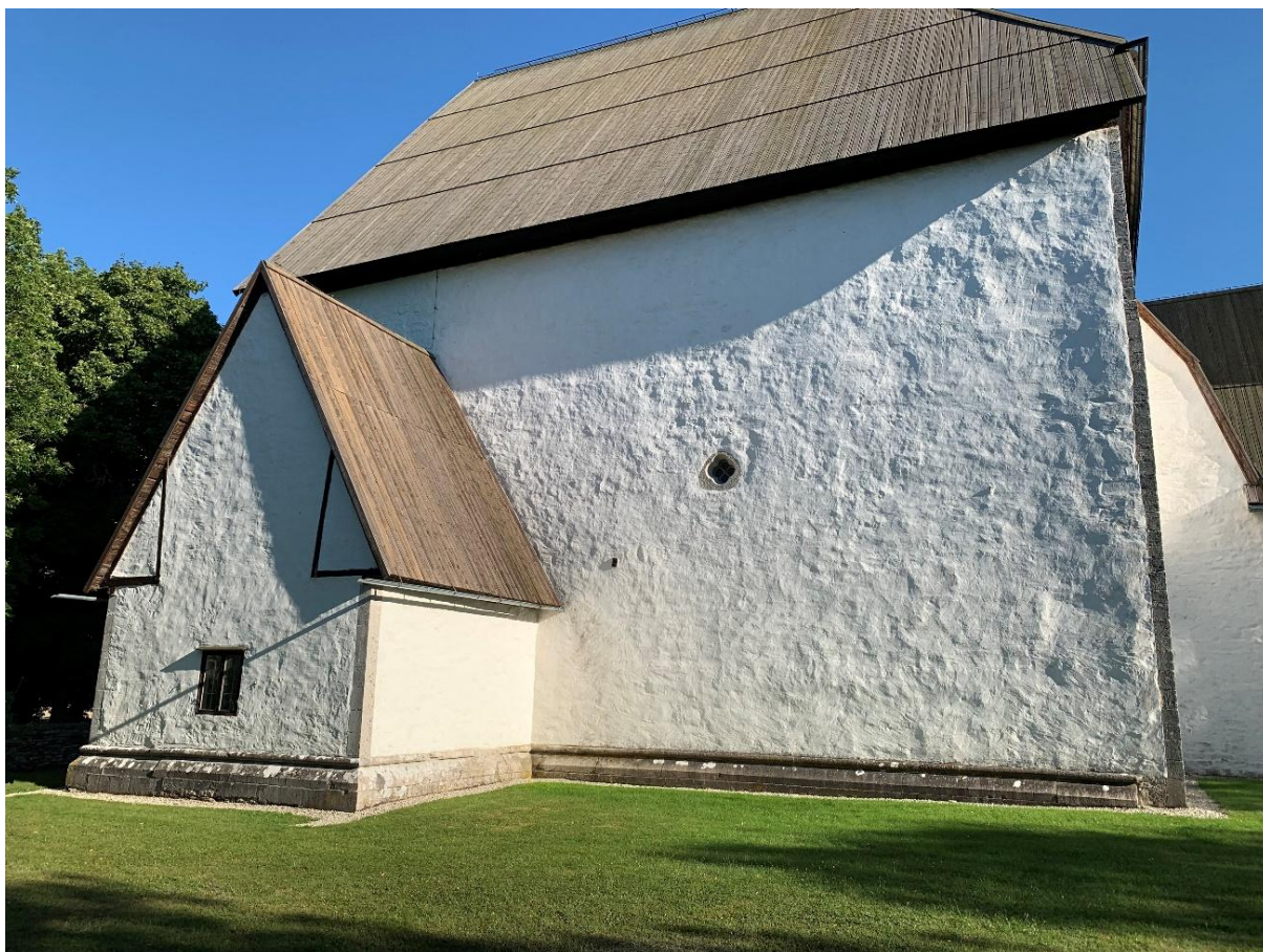
Korets norra fasad. Foto JL 2021.
