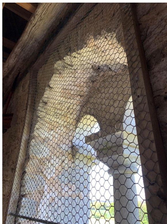
Den östra övre ljudluggen sedd inifrån. Den ursprungliga kolonnen är bevarad. Till höger detalj av västra ljudluggen. Foto JL 2021.
