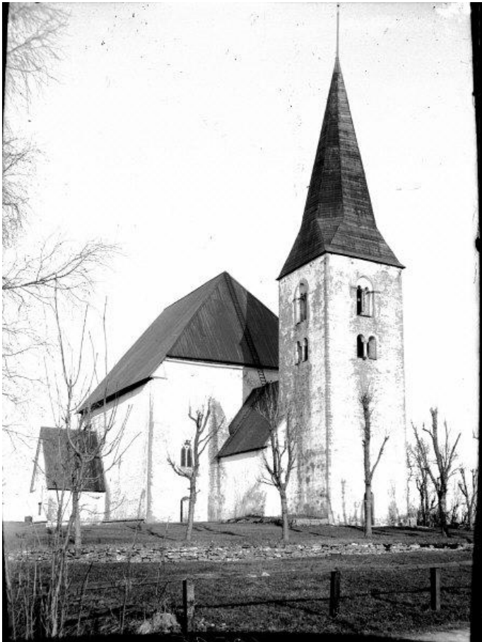
Källunge kyrkogård fotograferad från väster. Närmast syns kvarstående rester av den västra muren vilken raserades 1880. Idag är den ersatt av en häck. Kyrkogården omges av en trädkrans. Foto Einar Erici 1916. RAÄ, Kulturmiljöbild.
