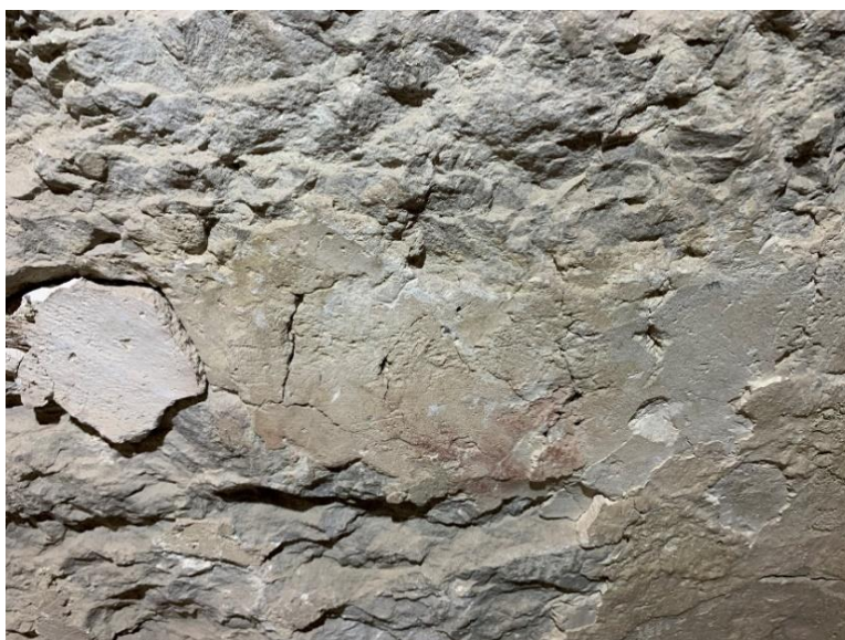
Murtrappan till korvinden sedd mot väster från uppgången i passagen in till sakristian. Till höger mursten med färgspår, sannolikt återanvänd sten från det romanska koret med målningens fragment, vilket visar att delar av kyrkan revs redan när nedre delen av murarna i koret var under uppförande. Foto JL 2021.
