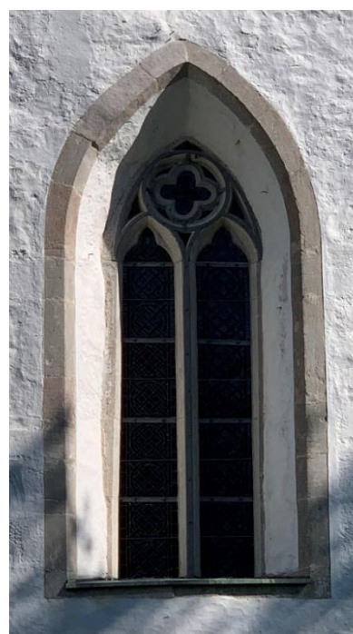
Detalj av korets sockel med block från det äldre korets fasader samt korets södra fönster. Foto JL 2021.
