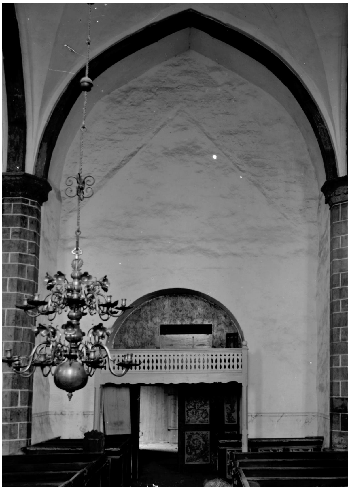
Muren kring triumfbågen före restaureringen 1895. Ovanför och parallellt med avtrycket av korets takfall syns svagare långhusets ursprungliga takfall. Under läktaren från ca 1875 och genom den öppna dörren syns en trävägg inne i gammalkyrkan, placerad så nära portalen att den ger ett släpljus. Gångjärnen till en dörr anas. Foto (detalj) Olof Sörling ca 1890, ATA, RAÄ.
