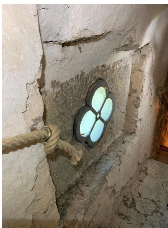
Till vänster murtrappan till korvinden sedd nedåt mot öster det första av två vilplan i trappan. Dess kantsteg utgörs av den bjälke vars utskjutande ända syns i korets norra fasad, väster om sakristian. Till höger fyrpasformat fönster i murtrappan i höjd med trappans andra vilplan, där en öppning funnits mot kyrkorummet. Foto JL 2021.
