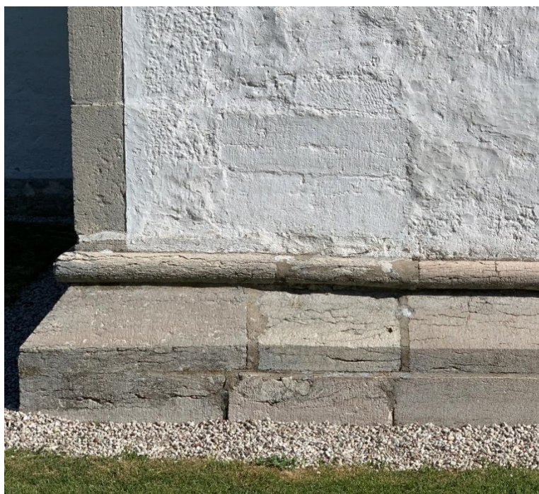
Detalj av korets sockel med block från det äldre korets fasader samt korets södra fönster. Foto JL 2021.
