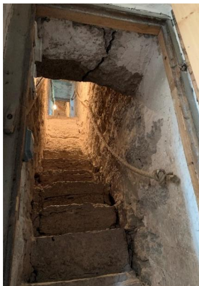
Murtrappan till korvinden sedd mot väster från uppgången i passagen in till sakristian. Till höger mursten med färgspår, sannolikt återanvänd sten från det romanska koret med målningens fragment, vilket visar att delar av kyrkan revs redan när nedre delen av murarna i koret var under uppförande. Foto JL 2021.
