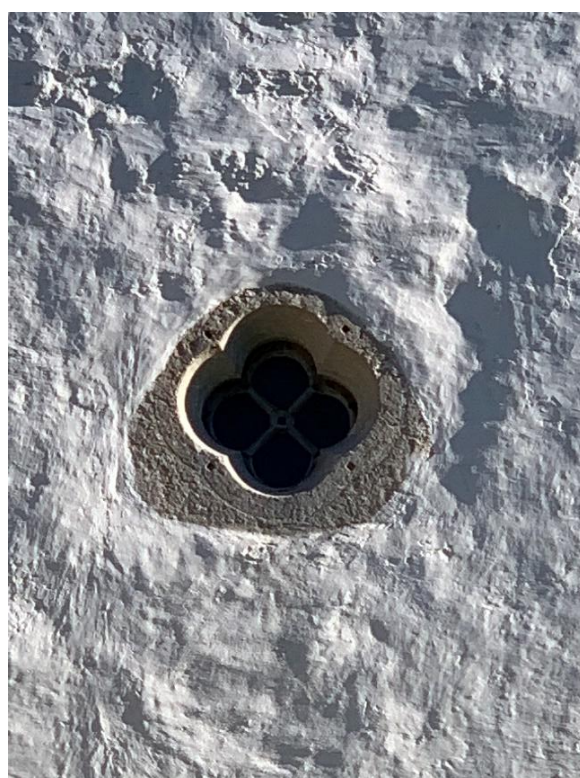
Till vänster inmurat trästycke (bjälkända) av okänd funktion i korets norra mur. Till höger fyrpassformad ljusöppning till murtrappan innanför en tidigare öppning in till kyrkorummet. Foto JL 2021.
