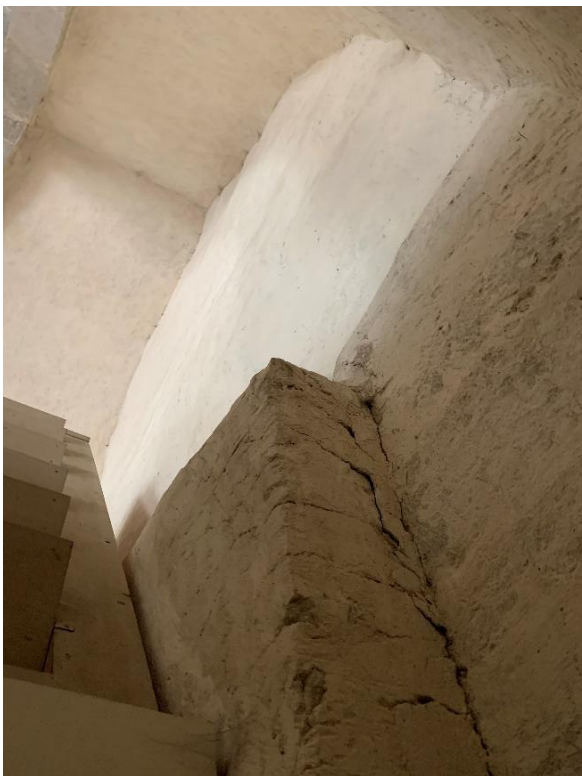
Södra sidoskeppets västra mur, bakom orgelläktaren. Det romanska långhusets sydöstra hörn synligt, utanför vilket den västra muren tilltar i tjocklek i sin nedre del men avtrappas uppåt. Foto JL 2021.
