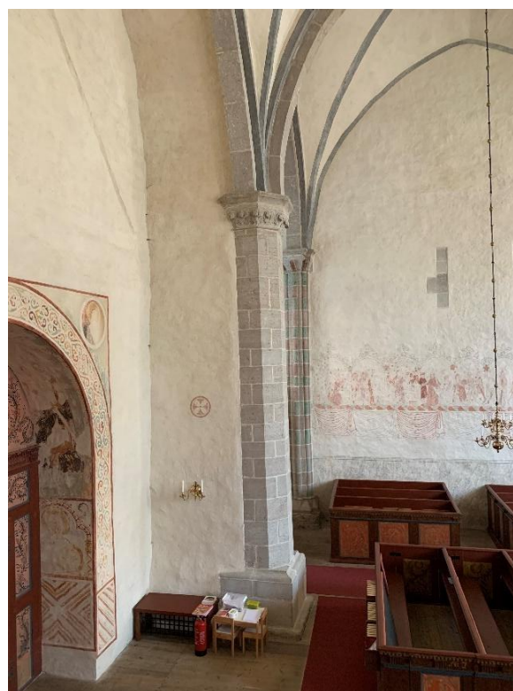
Övre delen av samma som bilden ovan. Till vänster den norra av de två pilastrarna vid mittskeppets västra del, avsedd som fristående åttkantig pelare, men med stark lutning mot väster. Foto JL 2021.
