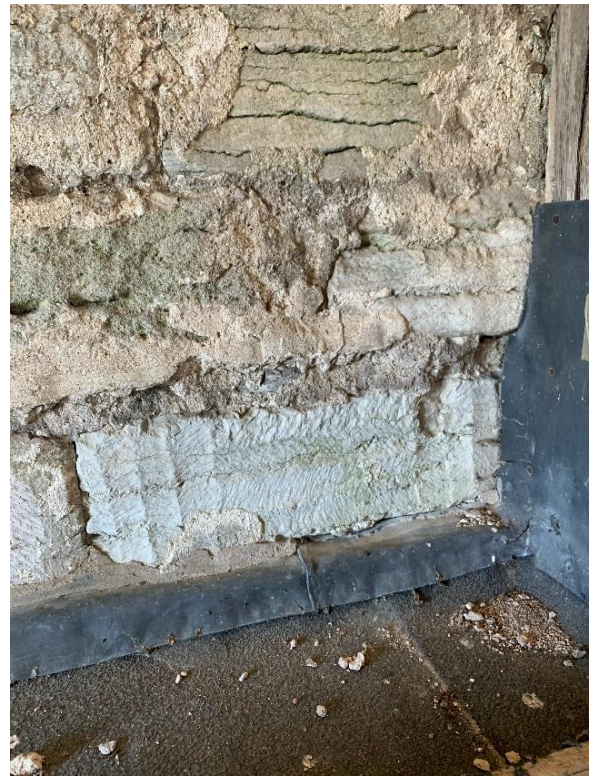
Nedre ljudgluggen mot väster sedd inifrån. Till höger huggen sten i nordvästra hörnet av nedre våningen med ljudgluggar, försedd med mönsterhuggning av en typ som förekommer på spridda stenar i tornet. Möjligen återanvänd. Foto JL 2021.
