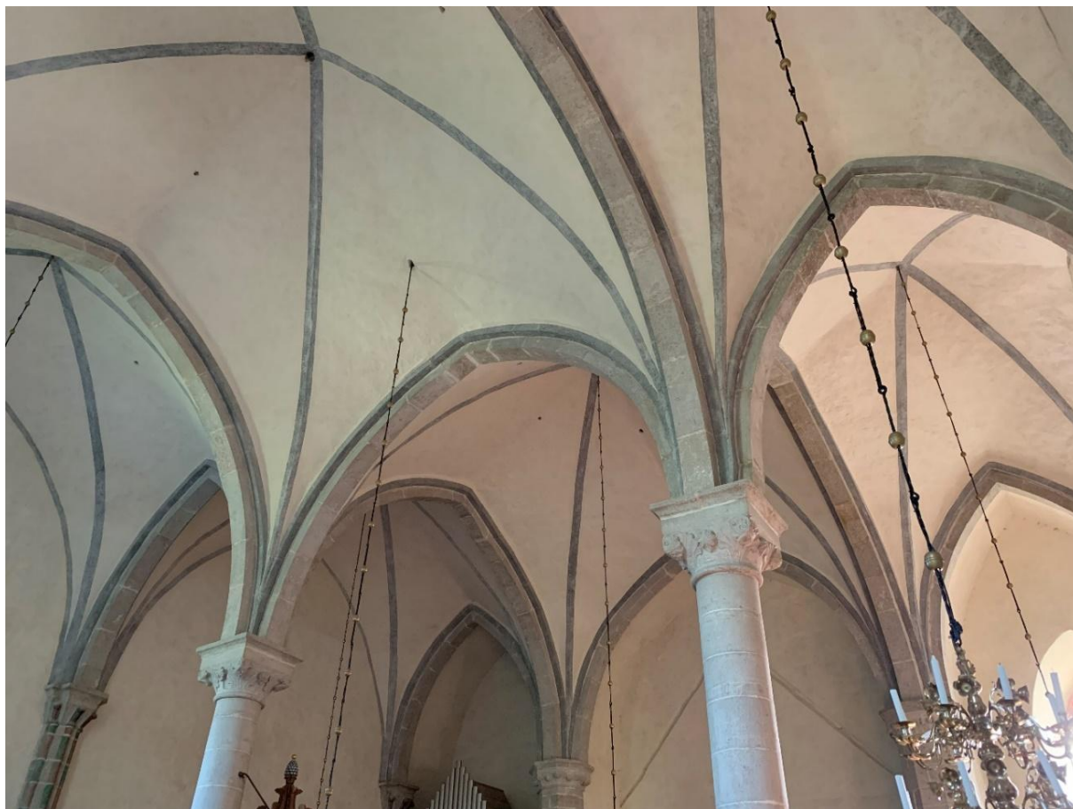
Valven sedda underifrån mot sydväst. Foto JL 2021.
