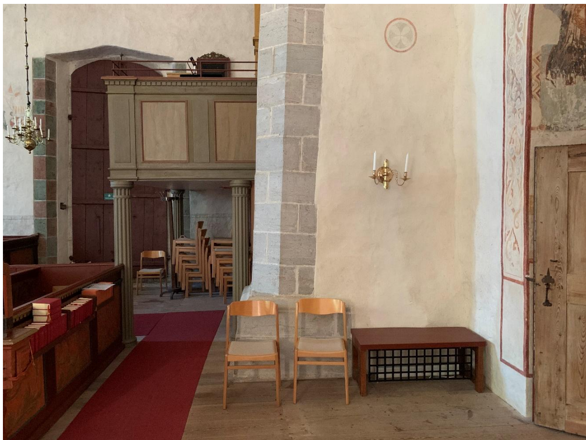
Nedre delen av den södra av de två pilastrarna vid mittskeppets västra del, avsedd som fristående åttkantig pelare, men med stark lutning mot väster. Foto JL 2021.
