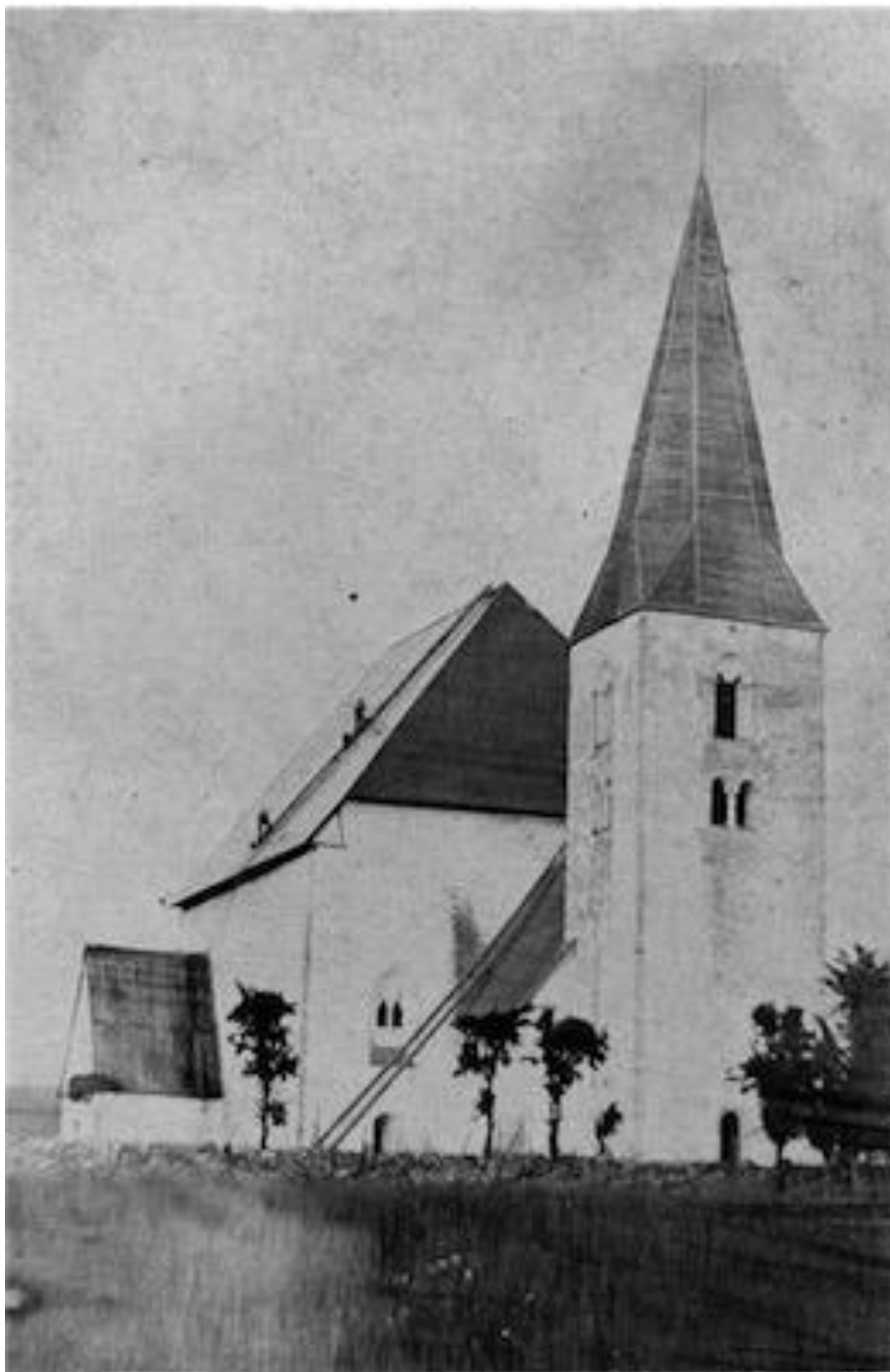
Exteriör från nordöst. Foto Anders Collberg ca 1870. Gotlands Museums arkiv. Övre ljudgluggen åt väster saknar kolonnett. Det stora kortaket tjäras.
