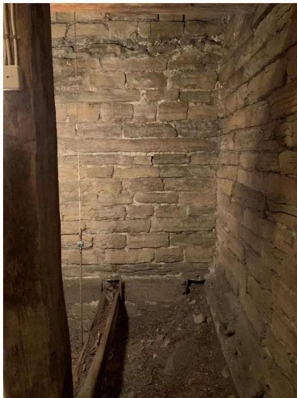
Tornmurens insida i sydöstra respektive sydvästra hörnet av tornets första övervåning, till vänster inne i kuren ovanför valvöppningen. Murverket är vittrat mot söder och väster men inte mot väster och norr. Vissa block har en anmärkningsvärd längd i förhållande till sin tjocklek och kan vara återanvända från annat sammanhang. Foto JL 2021.
