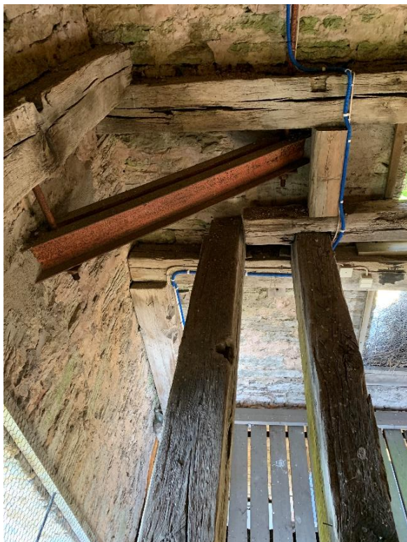
Delar av klockstolen, klockans bärkonstruktion, sedd mot nordvästra respektive sydvästra hörnet. Urtag, bland annat från tidigare klockupphängningar, visar att det väderbitna virket använts och återanvänts under lång tid. Foto JL 2021.
