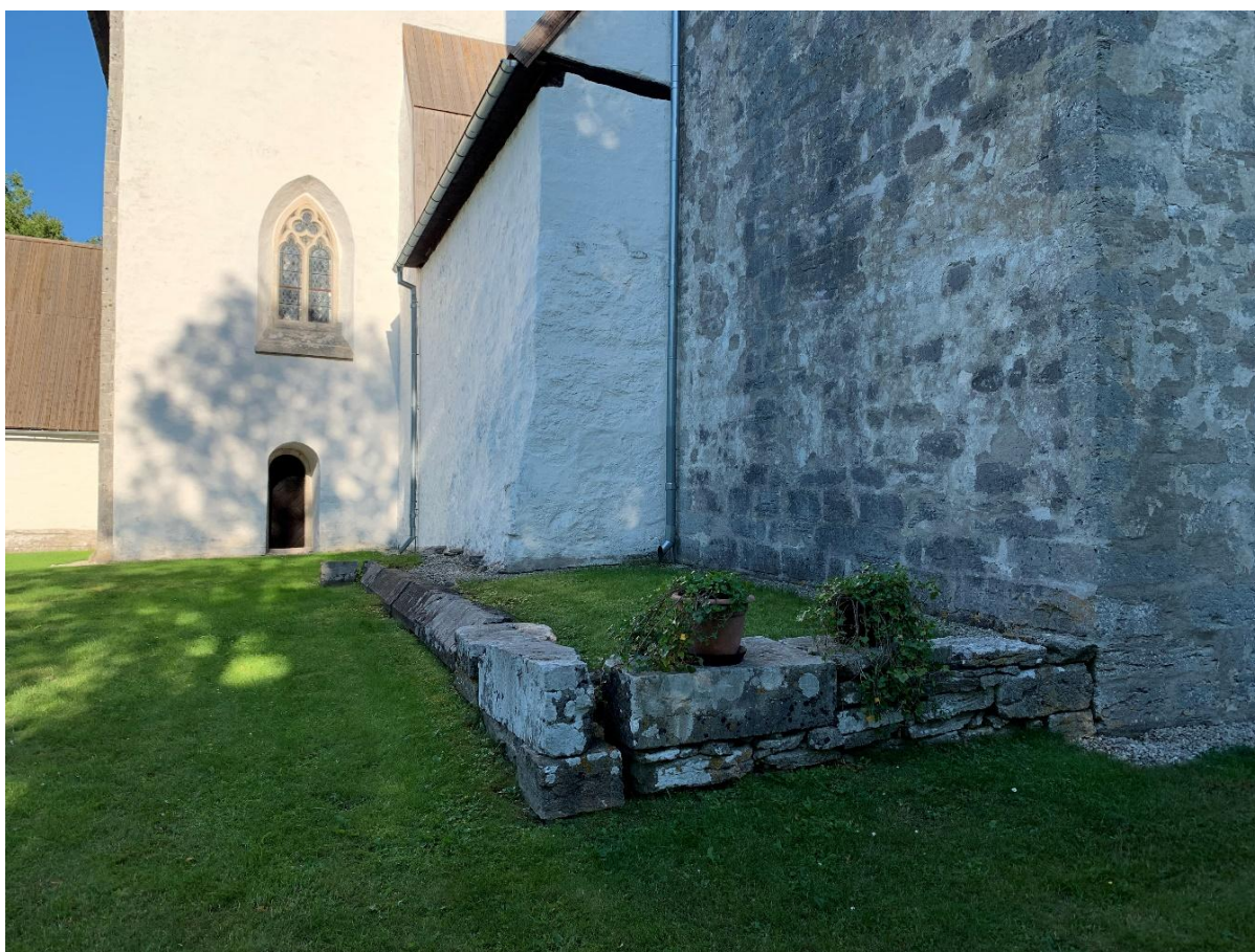
Långhuset från nordväst med grund till planerat torn, norr om det nuvarande tornet. Foto JL 2021.
