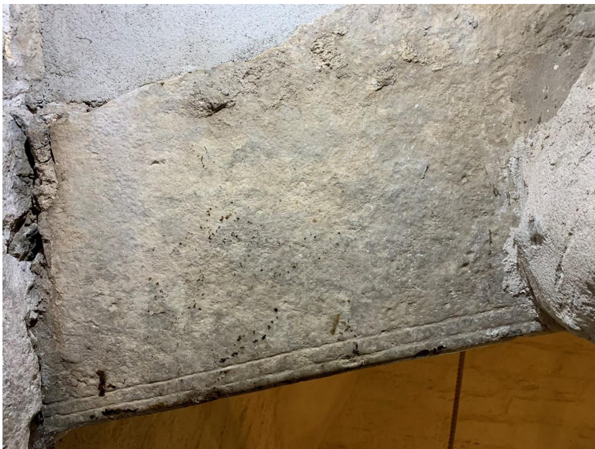
Västra sidan av öppningen i tornvalvet, skonad med en slät sten med behuggning av kanten. En av bildstenarna som påträffats i kyrkan. Insatt vid valvslagningen och troligen återanvänd från annat sammanhang. Foto JL 2021.
