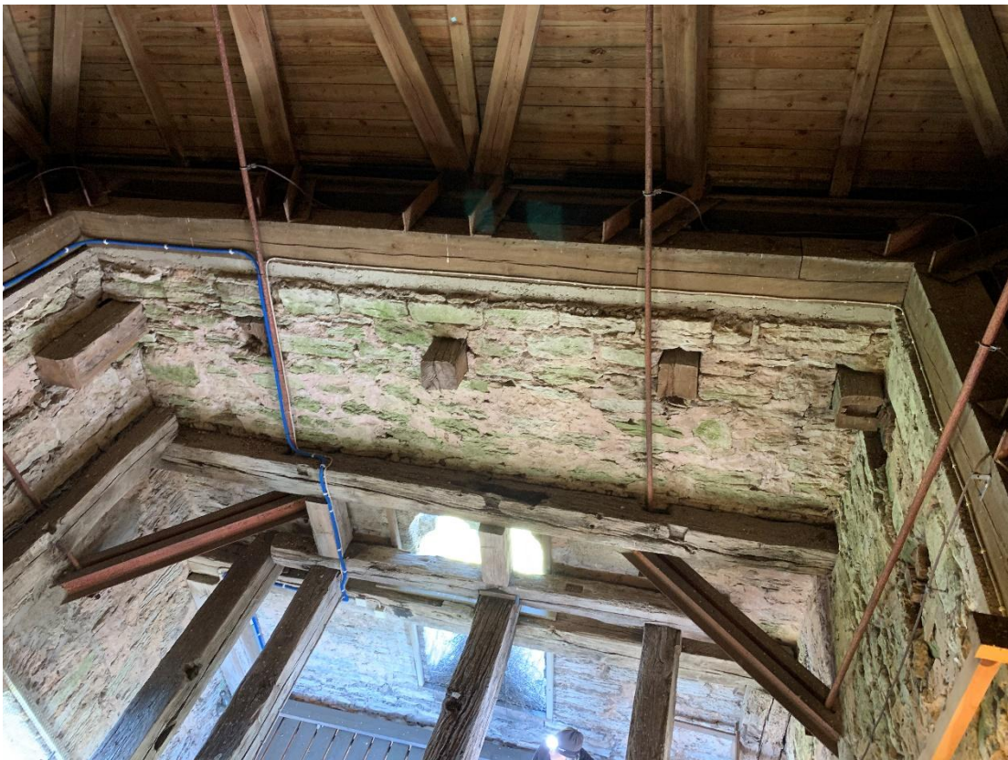
Tornets murkrön mot norr med avsågade bjälkar. I nordöstra hörnet till höger syns hur trästyckena i östra och västra muren endast varit korta och intappade i de längsgående bjälkarna. Foto JL 2021.
