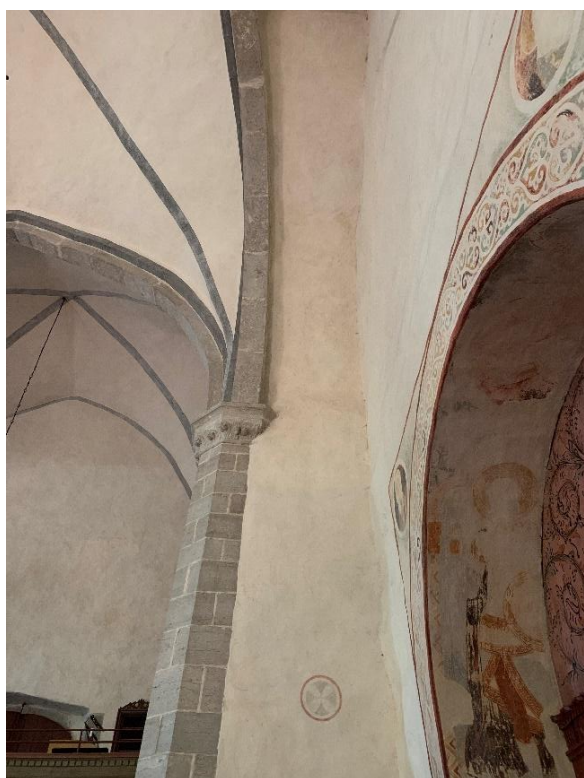
Övre delen av samma som bilden ovan. Till vänster den norra av de två pilastrarna vid mittskeppets västra del, avsedd som fristående åttkantig pelare, men med stark lutning mot väster. Foto JL 2021.
