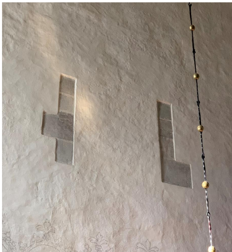
Igenmurad öppning mellan murtrappan och norra sidoskeppet. Nedan närbild av de bevarade omfattningsstenarna. Foto JL 2021.
