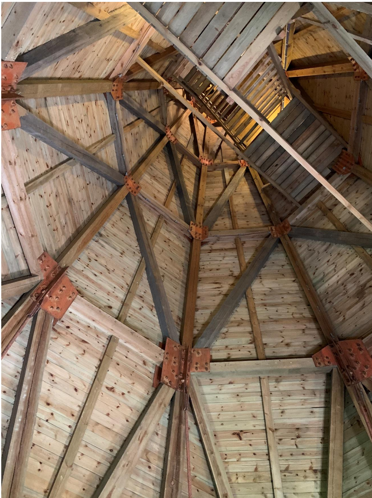
Tornhuven, byggd 1970-71 med samma yttre form som den tidigare men annan inre konstruktion, bland annat för att avlasta tyngden på tornet. Foto JL 2021.
