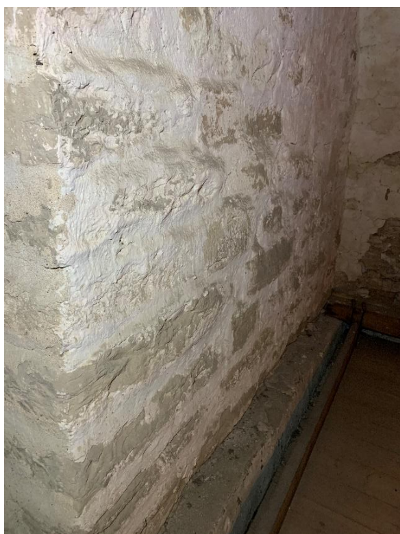
Murverket söder om den tidigare passagen till korvinden. Till höger avlastningsbåge från nuvarande korets byggnadstid samt ett stycke av strävpelaren ovanför södra långhusmuren. Över denna öppning till taket från 1950-talet ovanför strävpelaren. Foto JL 2021.
