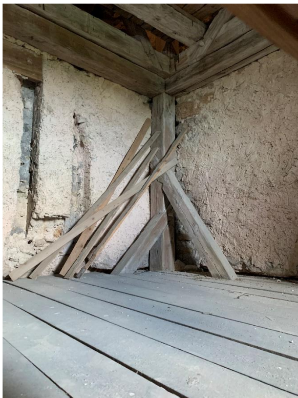
Tornets tredje övervåning sedd mot sydöst samt ljusglugg mot väster. Spår finns i muren efter infällda förstärkningsbjälkar som att döma av den mörka ytan bakom har brunnit. Foto JL 2021.
