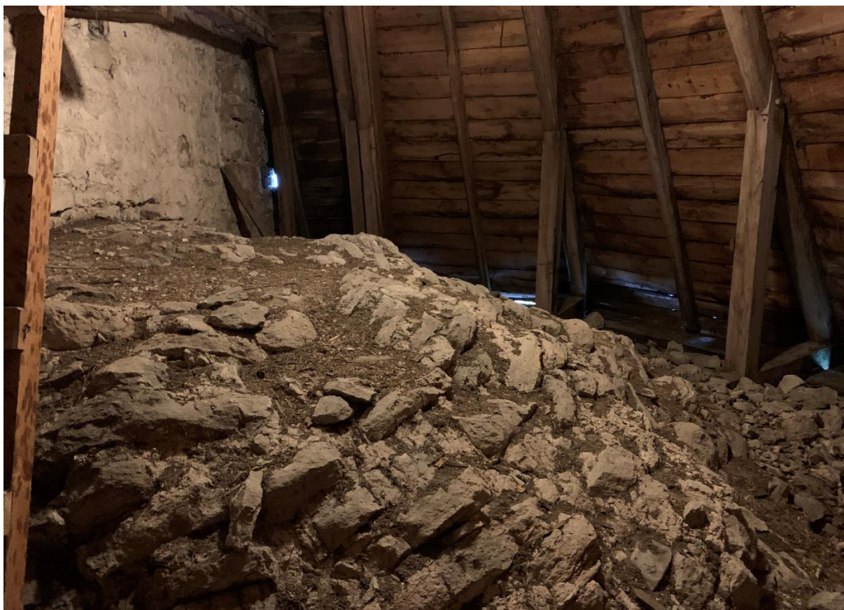
Absidvinden mot norr med ovansidan av absidens hjälmvalv. Foto JL 2021.
