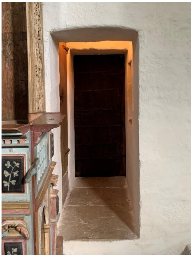
Passage genom korets norra mur till sakristiedörren. På gångens vänstra sida dörr till murtrappa till korvinden, på högra sidan en nisch. Sakristiedörren, tidigare troligen i korportalen, gjord av en ekbräda, något kompletterad för nuvarande plats. Foto JL 2021.
