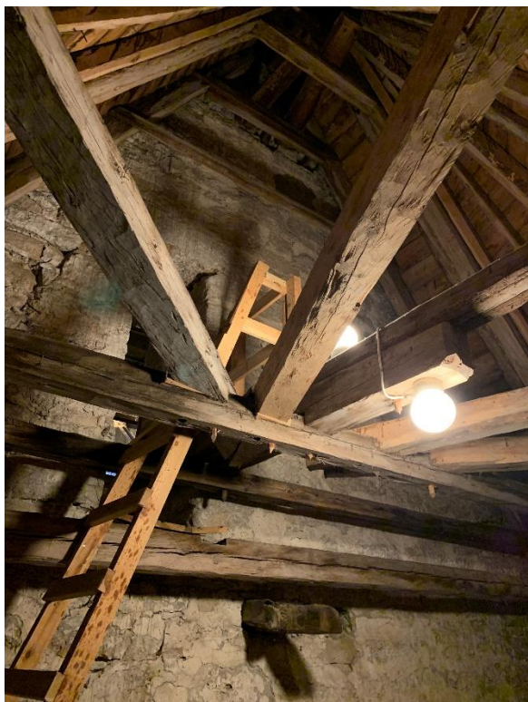
Absidens vind sedd uppåt mot nordväst. Murverket, som delvis förefaller innehålla släthuggen återanvänd äldre mursten, uppvisar skador, kanske från brand. Till höger absidens vind mot nordöst med lös sten som upplag på murkrönet. Foto JL 2021.
