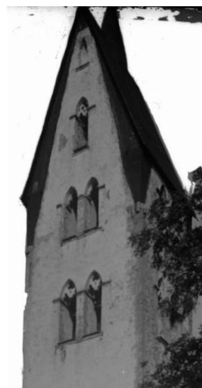
Ljudgluggspar i mellersta våningen mot väster, flankerat av rester av vattenkastare. Foto Pär Malmros 2020, Visby stift. Till höger ljudgluggar på tornets västra sida före restaureringen 1933, då detta par kompletterades med nya masverk och kolonnetter. Foto, detalj, Olof Sörling 1891, ATA.
