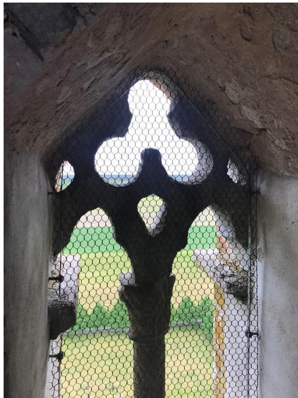
Tornets åttonde övervåning, den övre innanför sadeltaket sedd mot väster med övre delen av västra översta ljudgluggen. Till höger övre delen av östra översta ljudgluggen, vars masverk och kolonnnett är medeltida till skillnad från övriga som till stor del rekonstruerades 1933. Foto JL 2021.
