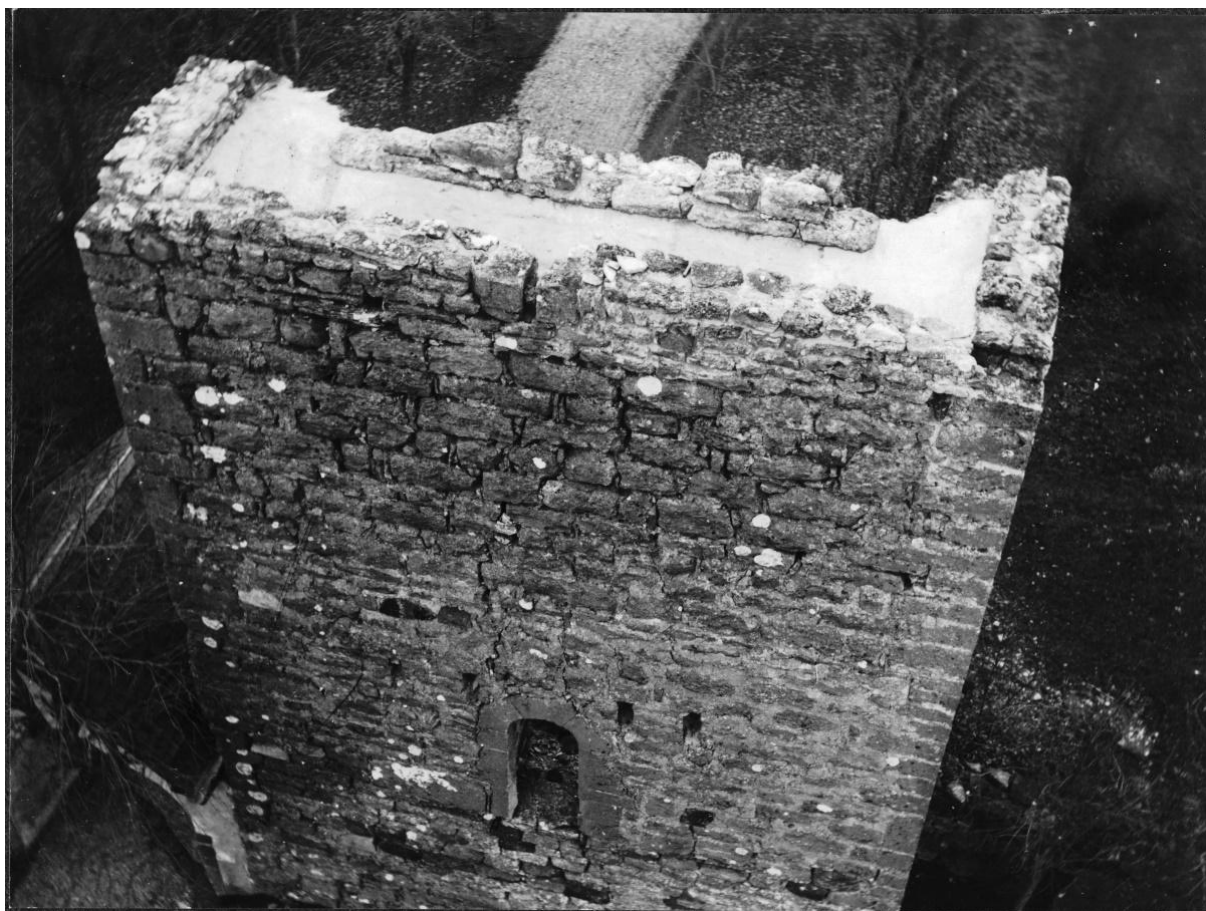
Kastalen efter konservering 1936, sedd ovanifrån med omgången väl synlig, belagd med cementavtäckning. Foto Nils P. Tidmark 1940, ATA.
