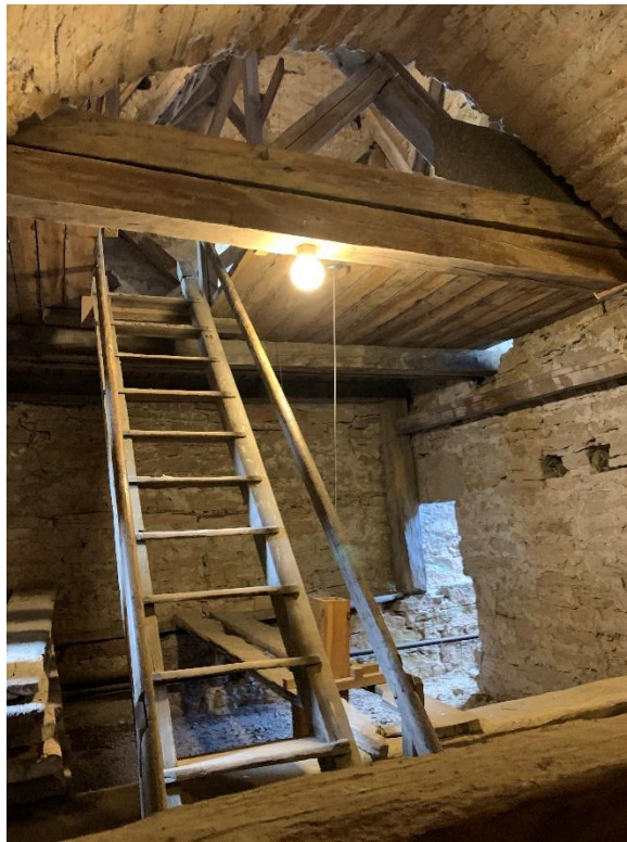
Tornets första övervåning mot söder och nordväst med utgångar till gallerierna. Murtrappor via gallerierna ledde vidare till nästa våning men ersätts nu av en trätrappa. Foto JL 2021.
