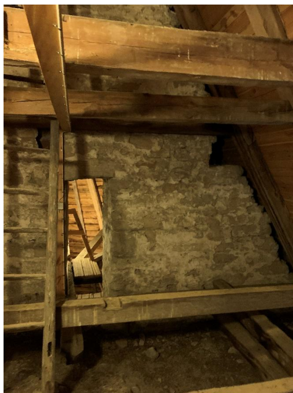
Korvinden sedd mot sydväst. Korets västra gavelröste, triumfbågsmuren, saknar kommunikation med långhusvinden, utöver de genom muren gående bomhålen. Att passage saknas kan bero på att det äldre långhuset var mycket lägre eller att det hade en öppen takstol. Till höger passage i korets östra gavelröste till sakristiavinden, sedd från korvinden mot öster. Foto JL 2021.
