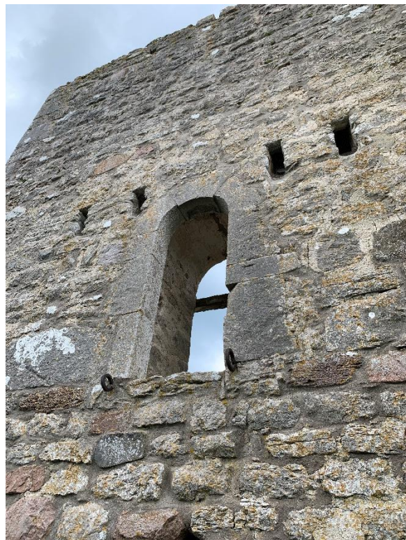
Kastalens ingång i marknivå och ingång högre upp på muren. Järnöglorna utgör fästen för en vindbrygga och hålen ovanför är rännor för dess hissanordning. Foto JL 2021.
