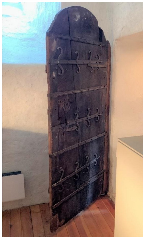
Passage genom korets norra mur till sakristiedörren. På gångens vänstra sida dörr till murtrappa till korvinden, på högra sidan en nisch. Sakristiedörren, tidigare troligen i korportalen, gjord av en ekbräda, något kompletterad för nuvarande plats. Foto JL 2021.
