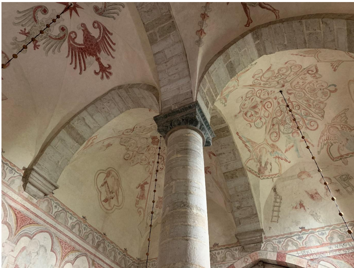
Långhusvalven sedda underifrån mot nordöst. Foto JL 2021.
