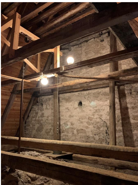
Korvinden sedd mot sydväst. Korets västra gavelröste, triumfbågsmuren, saknar kommunikation med långhusvinden, utöver de genom muren gående bomhålen. Att passage saknas kan bero på att det äldre långhuset var mycket lägre eller att det hade en öppen takstol. Till höger passage i korets östra gavelröste till sakristiavinden, sedd från korvinden mot öster. Foto JL 2021.
