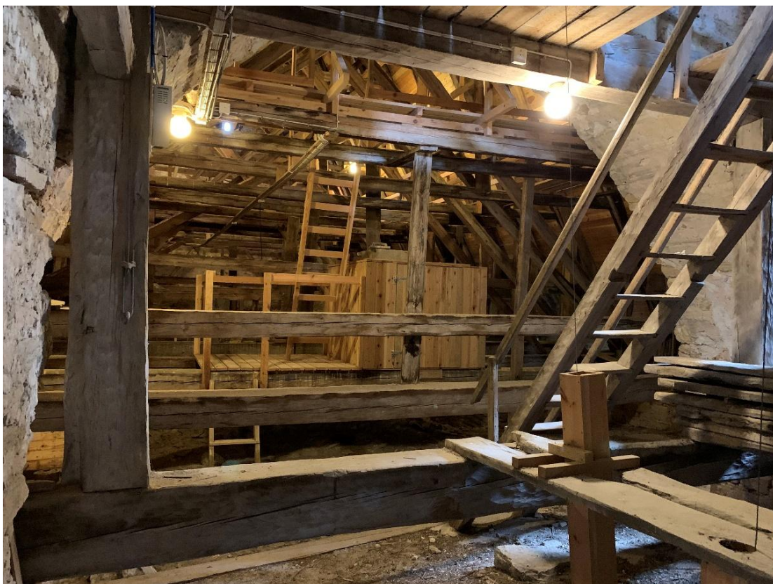
Långhusvinden sedd mot öster från tornets första övervåning. En vid båöppning förenar rummen. Foto JL 2021.
