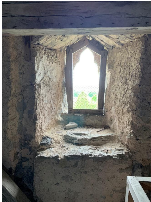
Tornets tredje övervåning sedd mot sydöst samt ljusglugg mot väster. Spår finns i muren efter infällda förstärkningsbjälkar som att döma av den mörka ytan bakom har brunnit. Foto JL 2021.
