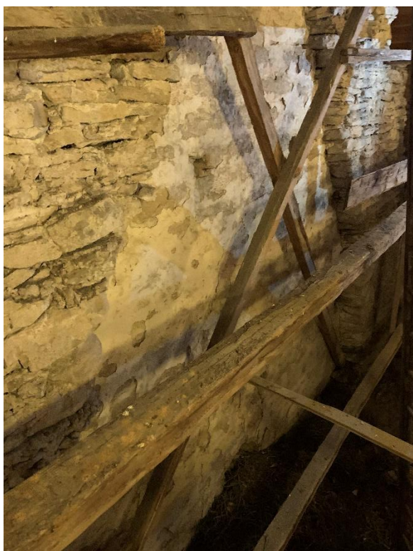
Korets kringbyggda västgavel. Putsen visar att denna del av röstet tidigare stod fritt. En hålighet längst ner närmast långhusvalvet anger möjligen det äldre långhusets taknockshöjd. Till höger långhusvinden mot väster. Foto JL 2021.
