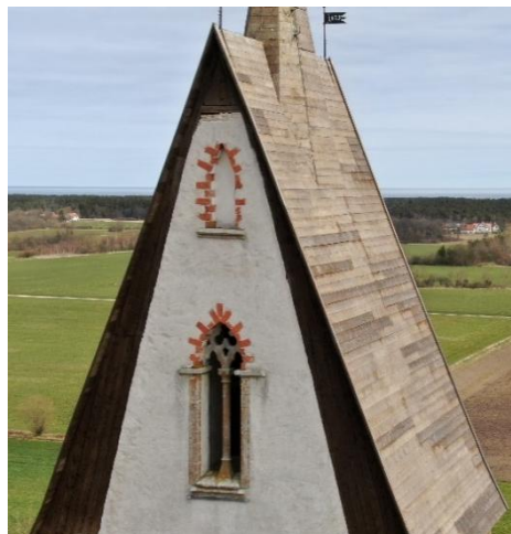
Övre ljudgluggsparet mot söder, flankerat av rester av vattenkastare. Till höger översta gluggen mot väster samt ovanför den en blinding. Foto Pär Malmros 2020, Visby stift.
