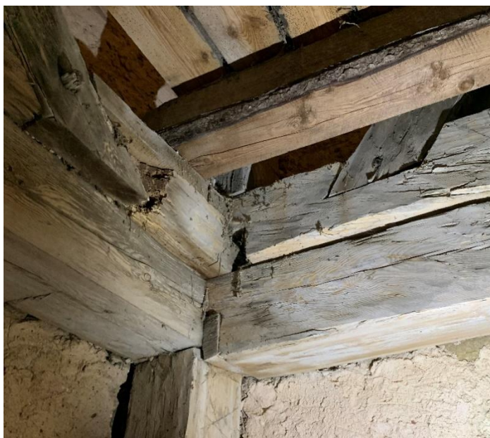
Tredje övervåningens sydvästra hörn. Knutpunkt mellan hörnstolpar och kryss samt del av bjälklaget till nästa våning. Foto JL 2021.
