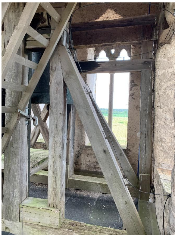
Klockvåningens nedre och övre del mot norr. Foto JL 2021.
