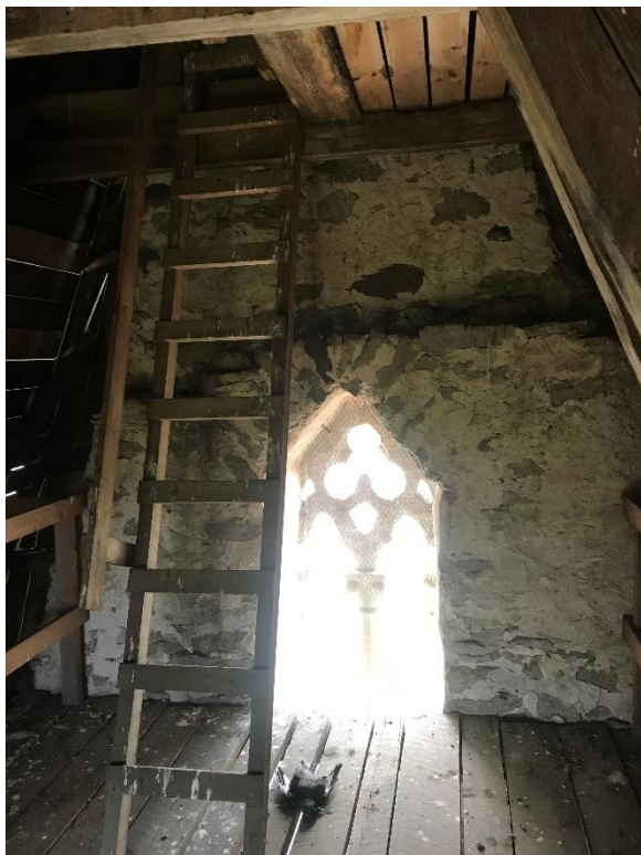
Tornets åttonde övervåning, den övre innanför sadeltaket sedd mot väster med övre delen av västra översta ljudgluggen. Till höger övre delen av östra översta ljudgluggen, vars masverk och kolonnnett är medeltida till skillnad från övriga som till stor del rekonstruerades 1933. Foto JL 2021.
