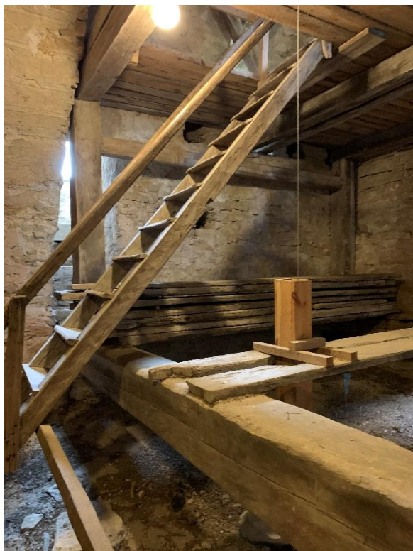
Tornets första övervåning mot söder och nordväst med utgångar till gallerierna. Murtrappor via gallerierna ledde vidare till nästa våning men ersätts nu av en trätrappa. Foto JL 2021.
