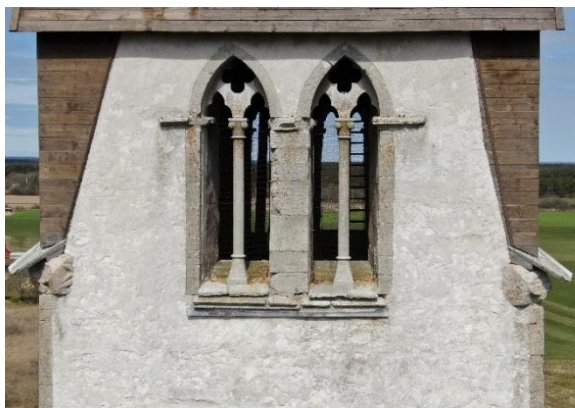
Övre ljudgluggsparet mot söder, flankerat av rester av vattenkastare. Till höger översta gluggen mot väster samt ovanför den en blinding. Foto Pär Malmros 2020, Visby stift.
