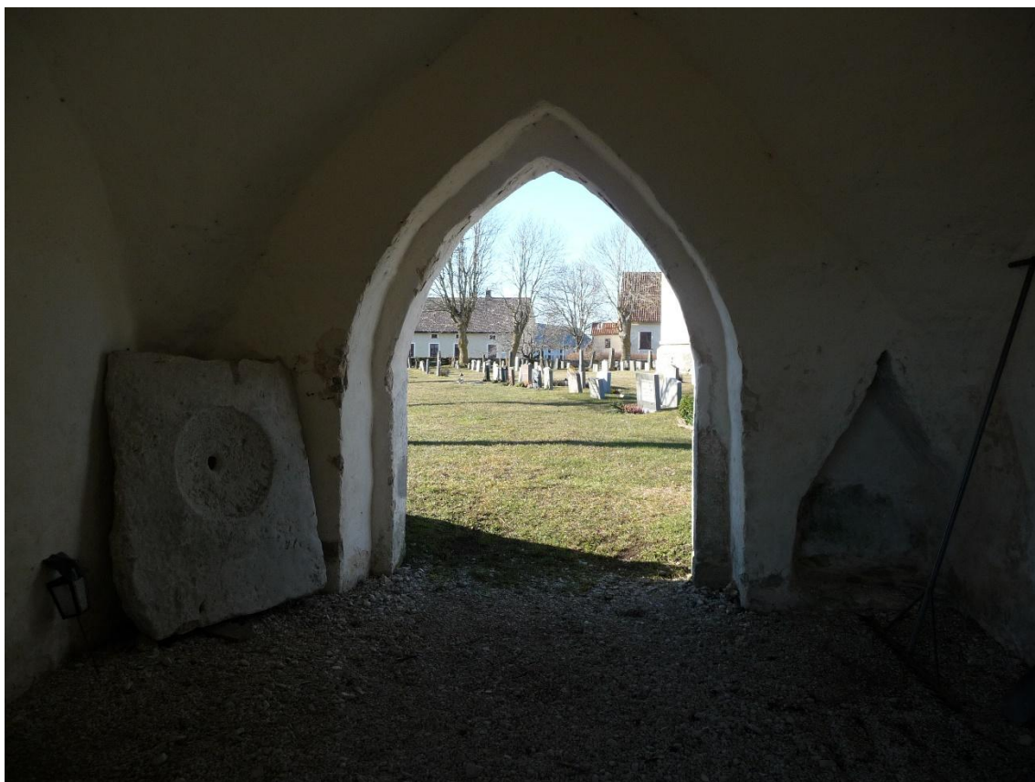
Den nordöstra stigluckan fotograferad inifrån mot söder. Foto ES 2021.
