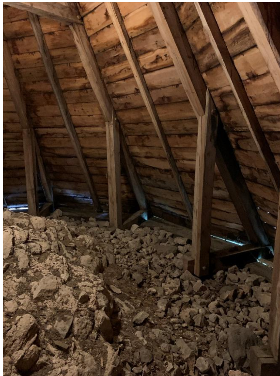
Absidens vind sedd uppåt mot nordväst. Murverket, som delvis förefaller innehålla släthuggen återanvänd äldre mursten, uppvisar skador, kanske från brand. Till höger absidens vind mot nordöst med lös sten som upplag på murkrönet. Foto JL 2021.
