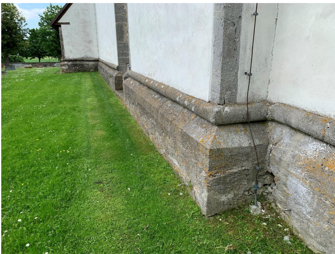
Norra långhusfasadens sockel, sedd från nordväst med sakristians sockel i fonden och tornets sockel längst till höger. Foto JL 2021.
