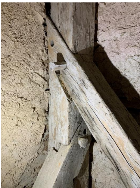
Tredje övervåningens sydvästra hörn. Knutpunkt mellan hörnstolpar och kryss samt del av bjälklaget till nästa våning. Foto JL 2021.
