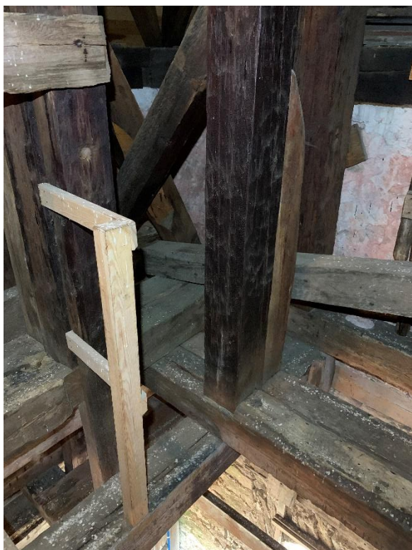
Tornhuvens bärverk i övre delen av våningen ovanför klockvåningen. Till höger murkrönet och huvens nedre takfall. Foto JL 2021.
