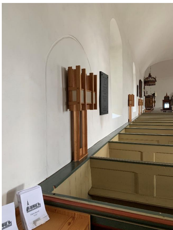
Markering i putsen på norra långhusmuren av medeltida nordportalen till långhusets västra del, igenmurad troligen senast på 1700-talet. Till höger skärningen mellan långhusets och tvärskeppets putsade trätunnvalv. Foto JL 2021.
