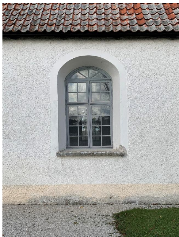
Till vänster det näst östligaste fönstret i sydfasaden, troligen upptaget på 1700-talet. Till höger fönster från 1858-59 på västra sidan av det södra korsarmen. Fönstren från 1850-talet har ett något skarpare markerat båganfang än de äldre, dock sällan så tydligt som i detta. Foto JL 2021.
