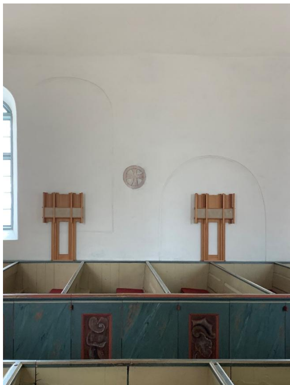
Markering i putsen på södra långhusmuren av fönster från 1700-talet och den medeltida portalen till det tidigare korpartiet samt, till höger, den medeltida sydportalen till långhusets västra del, igenmurade 1858-59. Foto JL 2021.
