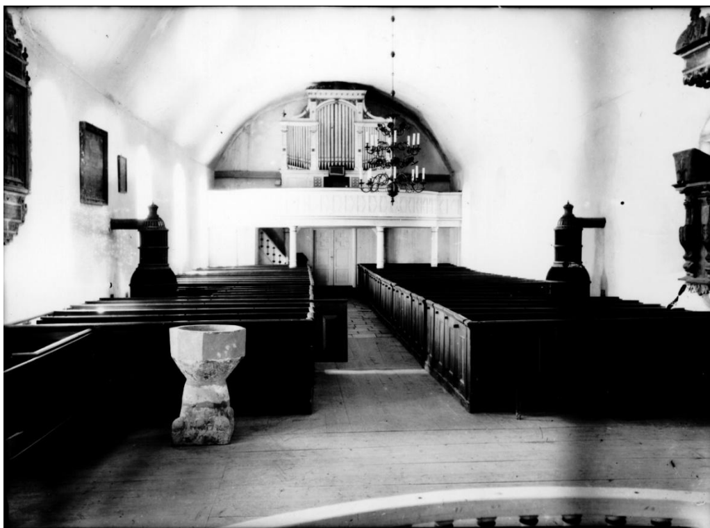
Interiör mot väster med de 1913 anskaffade kaminerna och den samma år tillkomna träväggen mot vapenhuset i tornets bottenvåning. Foto 1920, ATA.
