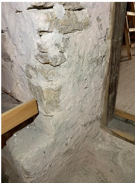
Passage genom långhusets västgavel från tornets andra övervåning in till långhusvinden. Det relativt kraftiga murverket och öppningens raka sidor tyder på att långhusgaveln är medeltida samt att öppningen är ursprunglig och inte uppbruten. Foto JL 2021.
