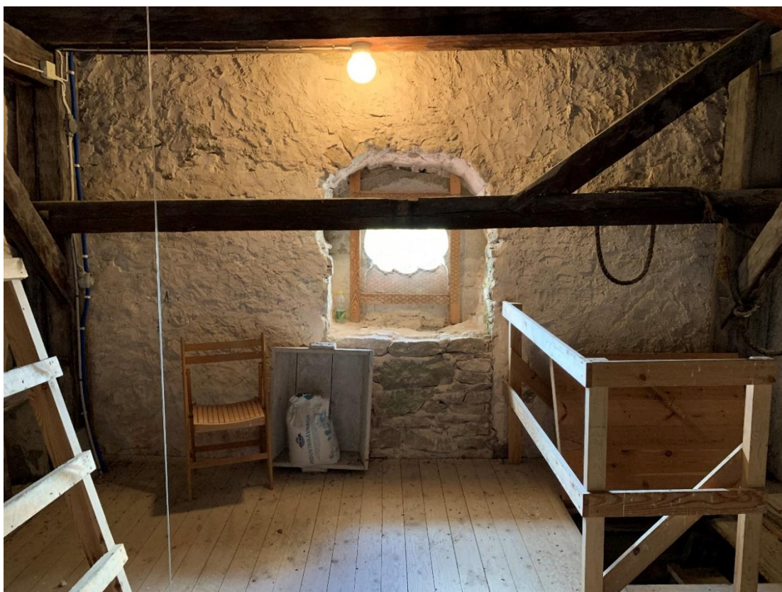
Tornets andra övervåning, tidigare klockvåning och troligen byggd i slutet av 1600-talet, sedd mot väster. Foto JL 2021.
