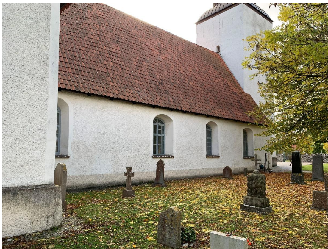
Långhusets norra fasad sedd från nordöst. Av de tre bortre fönstren härrör åtminstone något från 1700-talet. Foto JL 2021.
