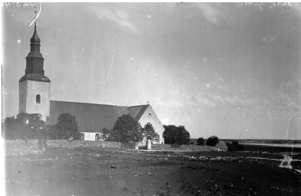
Fårö kyrka fotograferad från söder. På bilden syns de putsade grindstolparna till ingången i söder. En trädkrans omger kyrkan. I det sydöstra hörnet ligger en liten byggnad som togs bort när muren sträckning förändrades då den nya vägdragningen medförde att det sydöstra hörnet av kyrkogården togs bort. Foto J W Hamner 1900. RAÄ Kulturmiljöbild.
