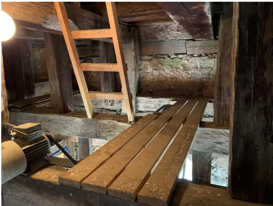
Nedre delen av våningen ovanför klockvåningen, sedd mot sydväst. Foto JL 2021.
