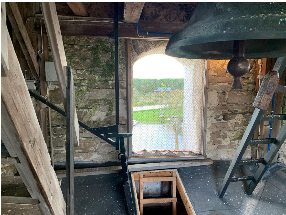
Klockvåningen mot söder. Foto JL 2021.
