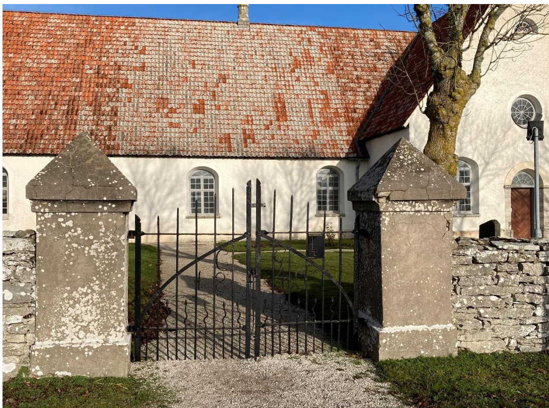
Ingången från söder har en dubbel grind i smidesjärn och kantas av putsade grindstolpar. Grinden skänktes 1840 av Christoffer Gazelius vars initialer finns på den. Foto ES 2021.
