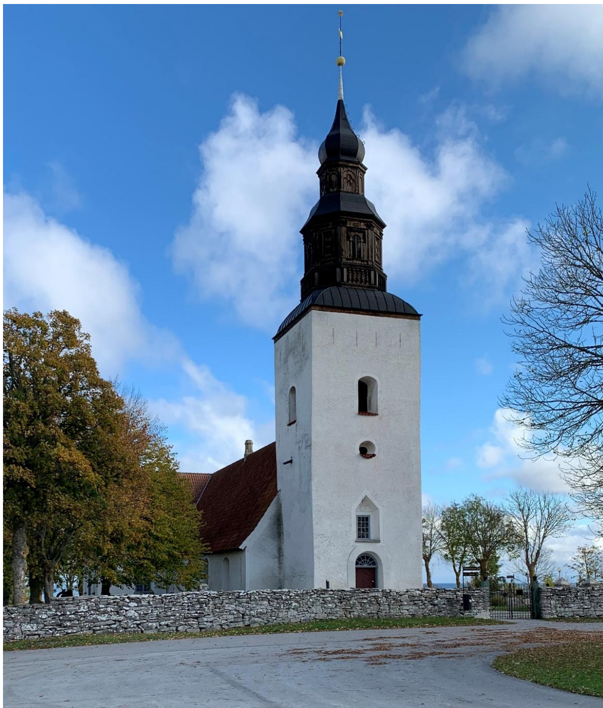
Exteriör från nordväst. Foto JL 2021.
