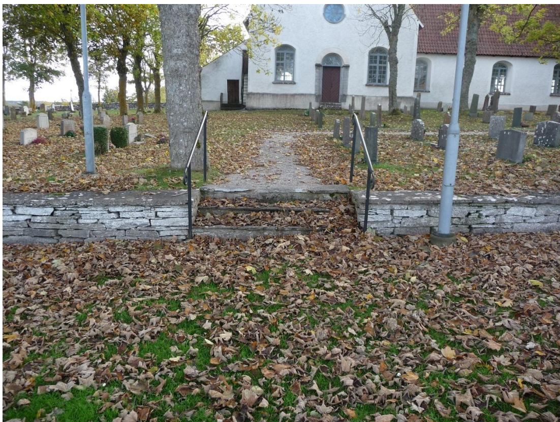
Den äldre kyrkogårdens norra mur, uppbyggd som en terrassmur troligen omkring 1912. En kort trappa med handledare i järn leder ned till den yngre kyrkogården. Foto ES 2021.
