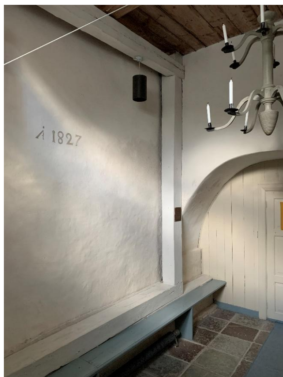
Interiör av vapenhuset i tornets bottenvåning, sedd mot nordöst och väster. Det på norra muren målade året 1827 syftar sannolikt på en reparation av tornet. Golvet sänktes och belades med stenplattor 1967-69. Foto JL 2021.
