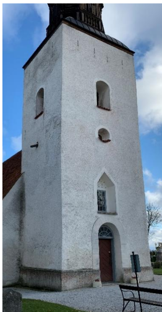
Tornet från nordväst. De medeltida murarna sträcker sig sannolikt upp till och med fönstret. Ljudgluggarna, troligen från 1600-talets slut, låg innanför den runda gluggen och spygattet. Murarna från klockvåningarna och uppåt tillkom omkring 1750. Foto JL 2021. Tornets östra sida. Foto Pär Malmros 2021, Visby stift.
