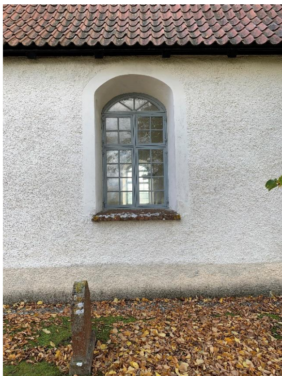
Norra långhusfasadens två västligaste fönster. Det till höger, det längst åt väster, har rundare övergång mellan sidorna och välvningen samt en vidare smyg och är sannolikt det fönster som togs upp 1761. Inskrift skall enl. Utas finnas i ett av fönstren med året 1761, men det anges inte i vilket. Foto JL 2021.
