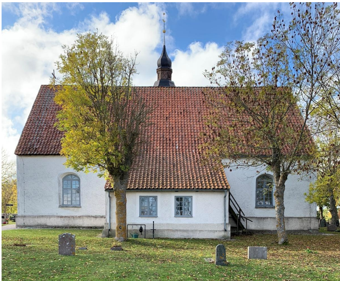
Tvårskeppet och sakristian från öster. Foto JL 2021.
