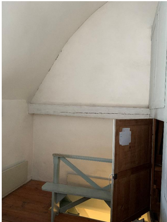
Långhusets sydvästra och nordvästra hörn med bindbjälke längs västra långhusmuren synlig på var sida om orgeln uppe på läktaren. Foto JL 2021.
