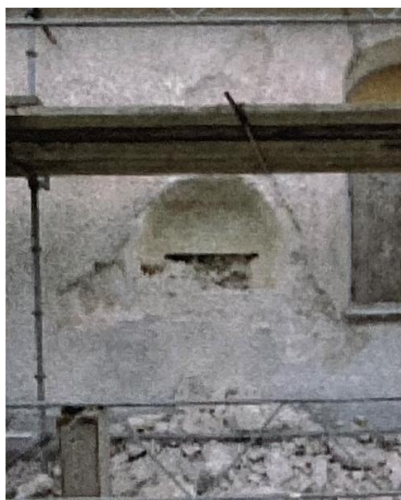
Murverksundersökningar i norra långhusmuren. Till vänster väster om det östligaste fönstret, visande en del av innerposten till den 1858-59 ingången till den tidigare sakristian. Att den var huggen talar för att sakristia fanns under medeltiden. Till höger mellan de båda västligaste fönstren visande övre delen av den tidigare nordportalen, igensatt troligen senast på 1700-talet, kanske långt tidigare. Foto Louise Borgö 2001 (GF 0765-188 och GF 0765-144), efter Borgö, dokumentation, rapport 2001.
