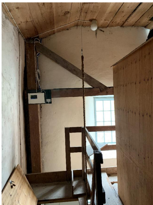
Tornets första övervåning, sedd mot sydväst och uppåt mot nordväst. Det vällagda tredingstaket, format som prydligt innertak under bjälklaget, visar att rummet varit synligt från kyrkorummet. Foto JL 2021.
