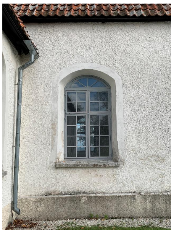
Till vänster det näst östligaste fönstret i sydfasaden, troligen upptaget på 1700-talet. Till höger fönster från 1858-59 på västra sidan av det södra korsarmen. Fönstren från 1850-talet har ett något skarpare markerat båganfang än de äldre, dock sällan så tydligt som i detta. Foto JL 2021.
