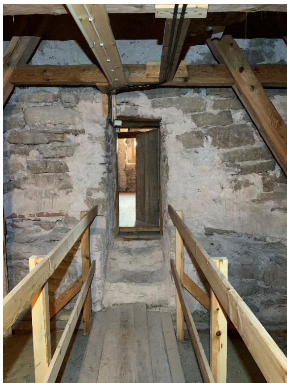
Passage genom långhusets västgavel från tornets andra övervåning in till långhusvinden. Det relativt kraftiga murverket och öppningens raka sidor tyder på att långhusgaveln är medeltida samt att öppningen är ursprunglig och inte uppbruten. Foto JL 2021.
