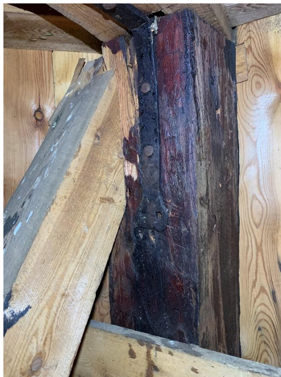
Luckförsedd öppning i huvens nedre våning. Stolpen i förgrunden visar spår av den rödtjära som enligt uppgift tidigare använts på delar av huven. Till höger knutpunkt med sannolikt ursprungligt järnbeslag. Foto JL 2021.
