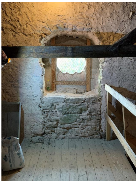
Glugg i andra övervåningens västra mur. Omfattningen utgör del av tidigare ljudglugg, sannolikt från 1600-talets senare del, formad av äldre huggen omfattning med okänt ursprung. Foto JL 2021.
