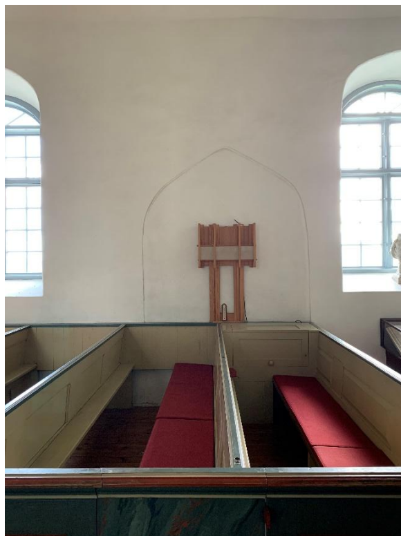
Markering i putsen på södra långhusmuren av fönster från 1700-talet och den medeltida portalen till det tidigare korpartiet samt, till höger, den medeltida sydportalen till långhusets västra del, igenmurade 1858-59. Foto JL 2021.
