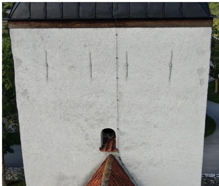
Tornet från nordväst. De medeltida murarna sträcker sig sannolikt upp till och med fönstret. Ljudgluggarna, troligen från 1600-talets slut, låg innanför den runda gluggen och spygattet. Murarna från klockvåningarna och uppåt tillkom omkring 1750. Foto JL 2021. Tornets östra sida. Foto Pär Malmros 2021, Visby stift.
