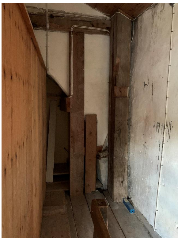
Tornets första övervåning, sedd mot sydöst och nordöst. Den murade bågen var öppen in mot kyrkorummet innan orgeln tillkom 1875. Hörnstolpen har urtag för tidigare bjälkkonstruktion. Foto JL 2021.
