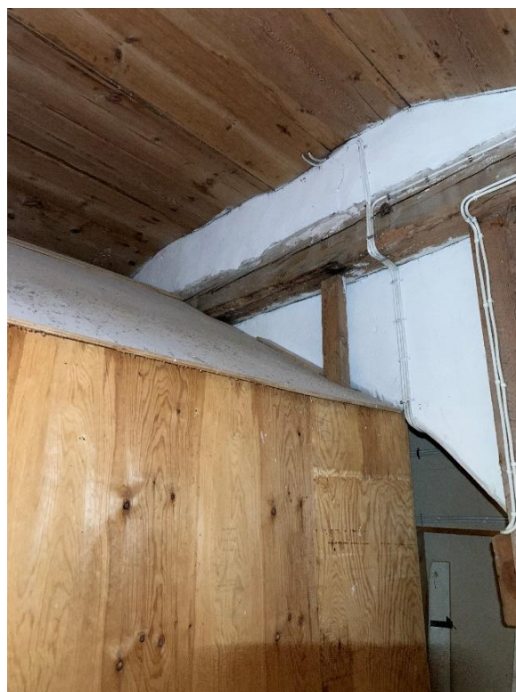
Tornets första övervåning, sedd mot sydöst och nordöst. Den murade bågen var öppen in mot kyrkorummet innan orgeln tillkom 1875. Hörnstolpen har urtag för tidigare bjälkkonstruktion. Foto JL 2021.
