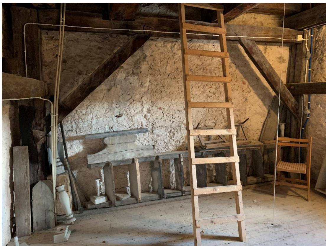
Tornets andra övervåning mot söder med spår av igensatt ljudglugg. Foto JL 2021.
