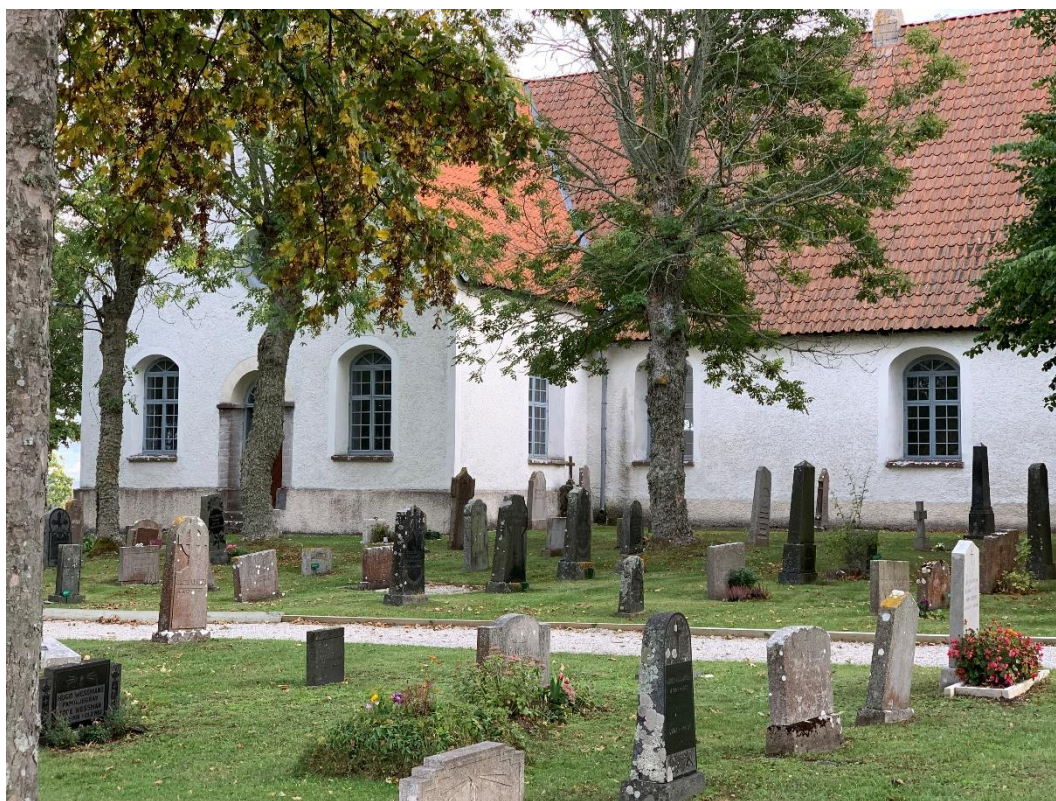
Exteriör från nordväst. Foto JL 2019.
