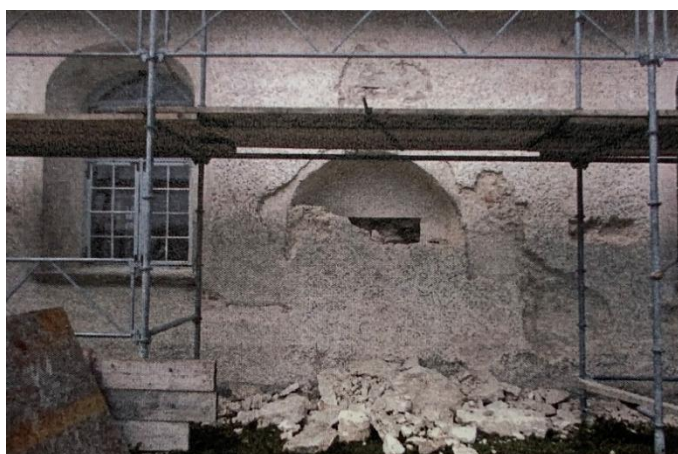
Medeltida portal i nuvarande långhusets sydöstra del, på det tidigare korpartiets södra sida, igenmurad 1858-59, delvis frilagd under restaureringen 2000-2001, invid det tredje fönstret från väster. Foto Louise Borgö, GF 0765-147, efter Borgö, dokumentation, rapport 2001, Gotlands Museums arkiv.
