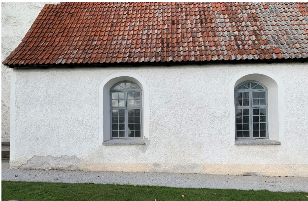
Västra delen av långhusets sydfasad. Svaga spår i putsen mellan fönstren markerar platsen för den tidigare sydportalen. Fönstret till höger fick sin form på 1700-talet, troligen 1723 eller 1781-82, det till vänster togs upp 1858-59. Snickerierna troligen förnyade då och senare. Foto JL 2021
