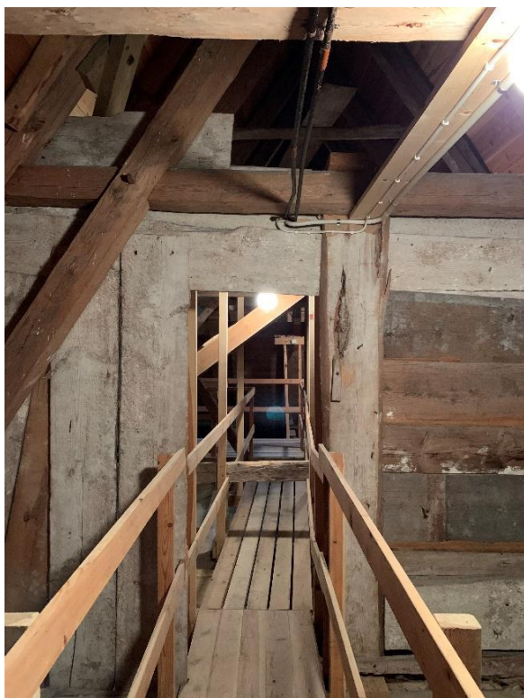
Enkel brädvägg mellan långhusvinden och tvärskeppsvinden, sedd från väster och öster. Foto JL 2021.
