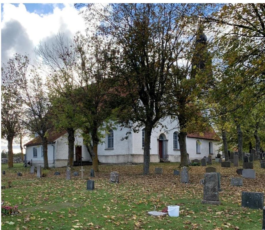
Exteriör från nordöst. Foto JL 2021.
