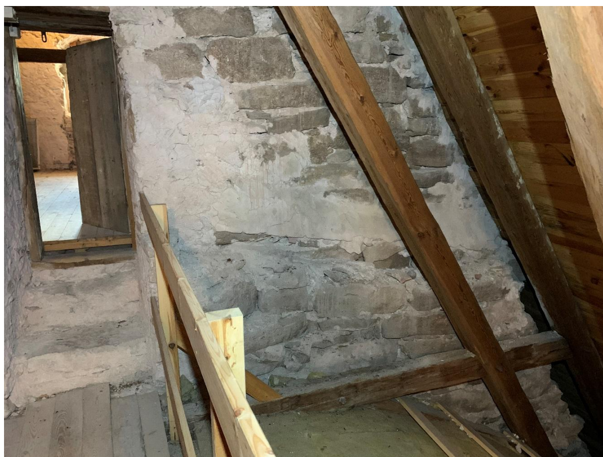
Muravtrappning med spår av takfall på var sida om öppningen in till långhusvinden, antingen ett äldre yttertak eller avledning av läckage vid tornmuren. Foto JL 2021.
