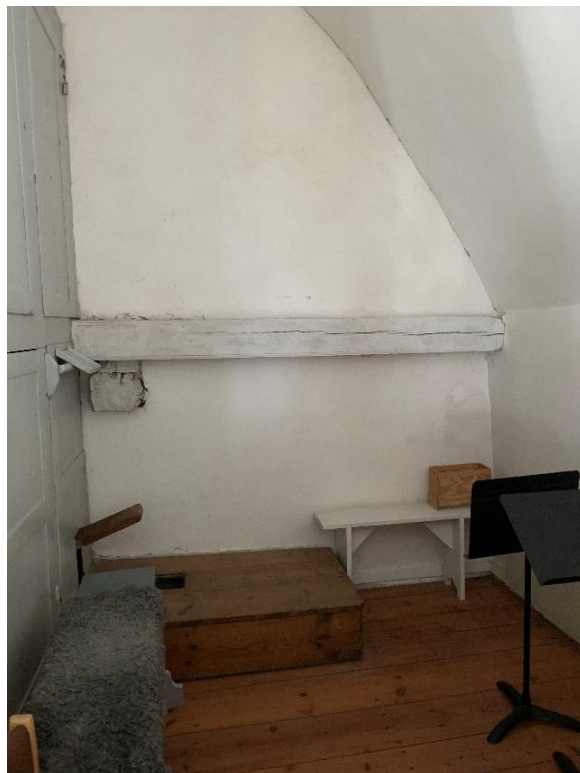
Långhusets sydvästra och nordvästra hörn med bindbjälke längs västra långhusmuren synlig på var sida om orgeln uppe på läktaren. Foto JL 2021.
