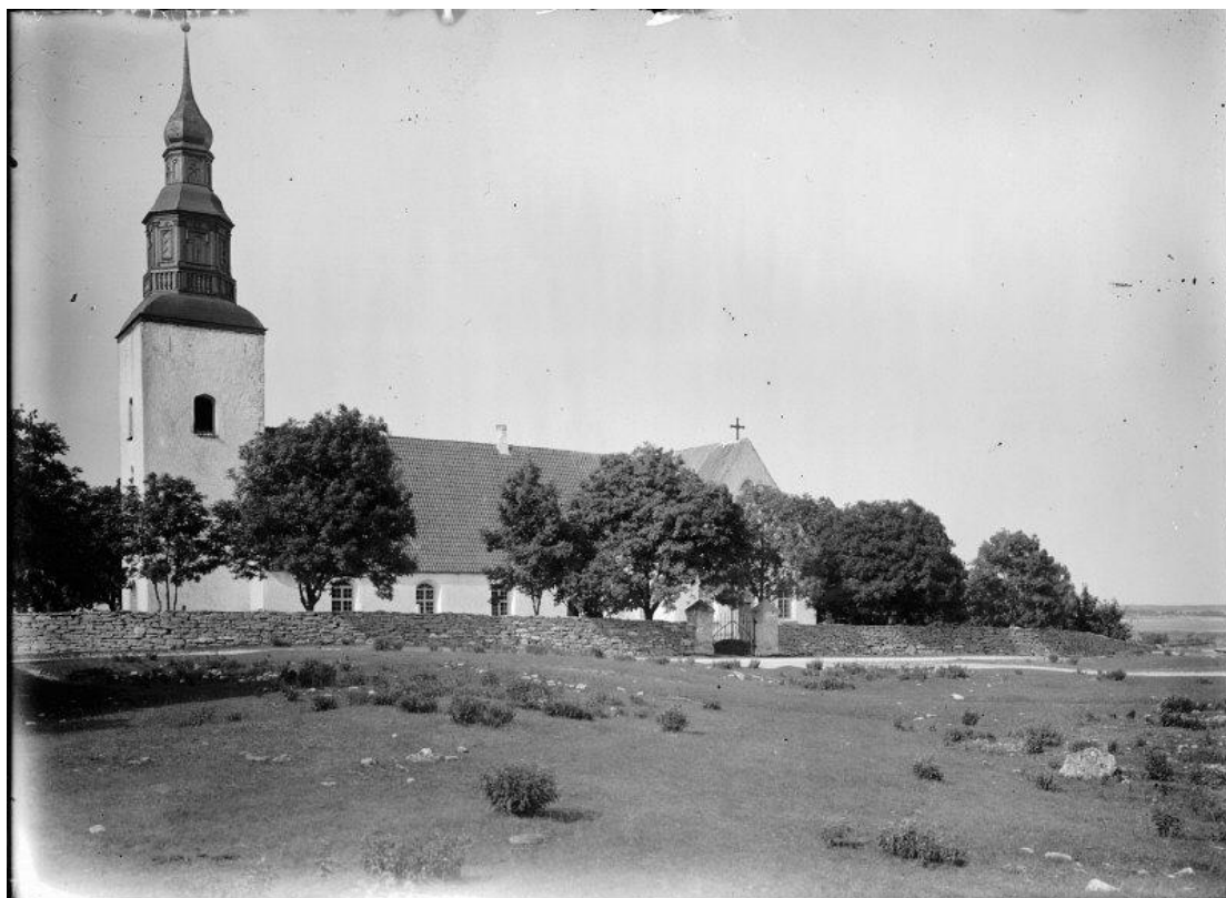
Fårö kyrka 1924. Kyrkogårdsmurens sträckning är nu förändrad med det sydöstra hörnet avklippt. Foto okänd fotograf. RAÄ, Kulturmiljöbild.
