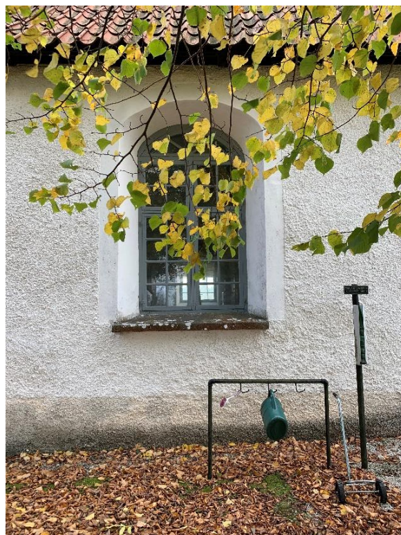
Norra långhusfasadens två västligaste fönster. Det till höger, det längst åt väster, har rundare övergång mellan sidorna och välvningen samt en vidare smyg och är sannolikt det fönster som togs upp 1761. Inskrift skall enl. Utas finnas i ett av fönstren med året 1761, men det anges inte i vilket. Foto JL 2021.
