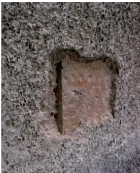
Murverksundersökningar i norra långhusmuren. Till vänster väster om det östligaste fönstret, visande en del av innerposten till den 1858-59 ingången till den tidigare sakristian. Att den var huggen talar för att sakristia fanns under medeltiden. Till höger mellan de båda västligaste fönstren visande övre delen av den tidigare nordportalen, igensatt troligen senast på 1700-talet, kanske långt tidigare. Foto Louise Borgö 2001 (GF 0765-188 och GF 0765-144), efter Borgö, dokumentation, rapport 2001.
