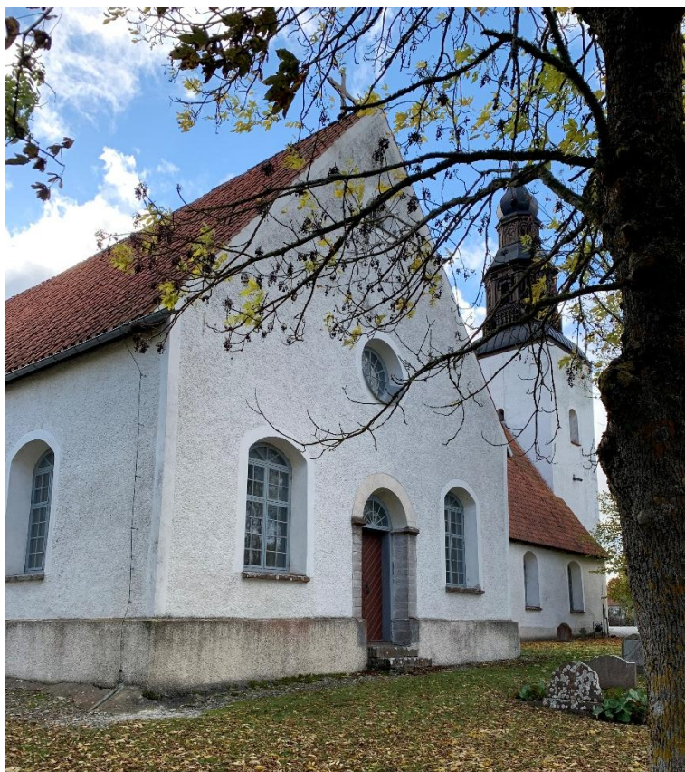
Exteriör från nordöst. Foto JL 2021.
