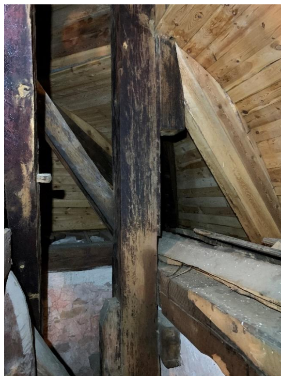
Tornhuvens bärverk i övre delen av våningen ovanför klockvåningen. Till höger murkrönet och huvens nedre takfall. Foto JL 2021.
