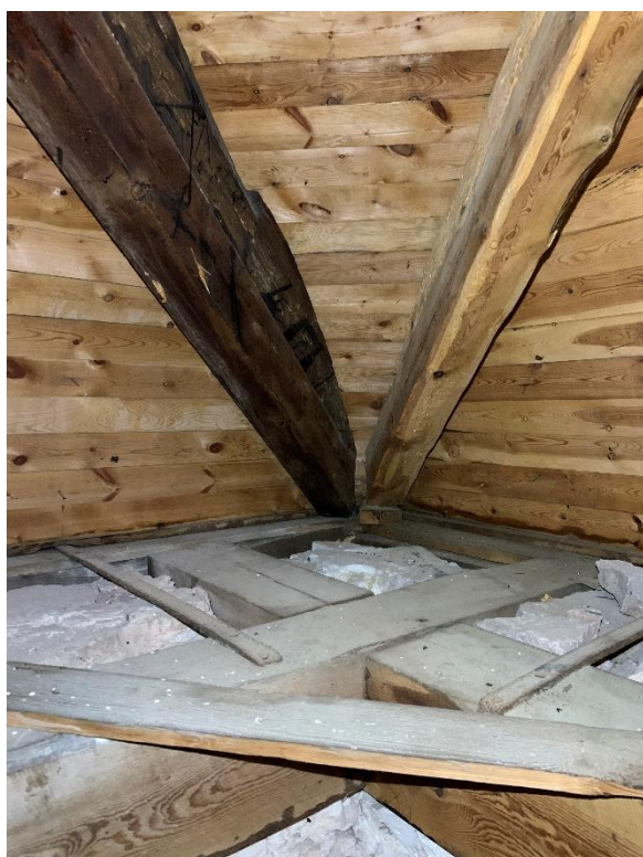
Murkrönet i ett av hörnen. Synliga spår av de på 1850-talet rivna spirorna i hörnen saknas. Till höger blick upp i huvens nedre våning. Foto JL 2021.
