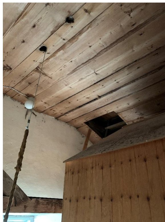
Tornets första övervåning, sedd mot sydväst och uppåt mot nordväst. Det vällagda tredingstaket, format som prydligt innertak under bjälklaget, visar att rummet varit synligt från kyrkorummet. Foto JL 2021.
