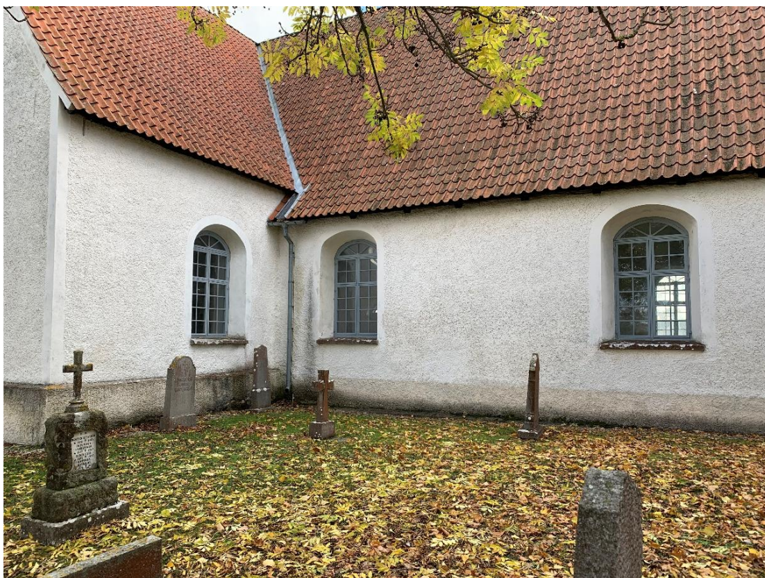
Norra korsarmen och långhuset från nordväst. Det mellersta fönstret togs upp 1858-59 på den tidigare platsen för sakristian, vars ingång låg strax till höger om fönstret. Foto JL 2021.
