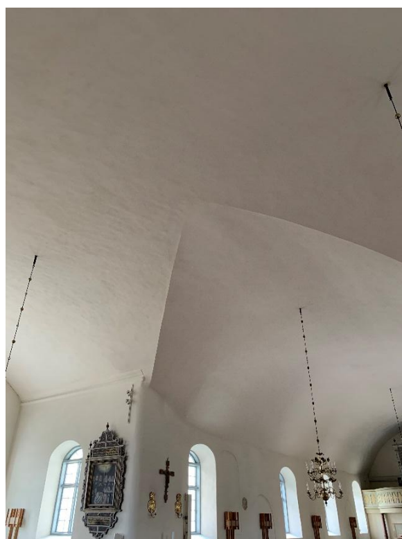
Markering i putsen på norra långhusmuren av medeltida nordportalen till långhusets västra del, igenmurad troligen senast på 1700-talet. Till höger skärningen mellan långhusets och tvärskeppets putsade trätunnvalv. Foto JL 2021.
