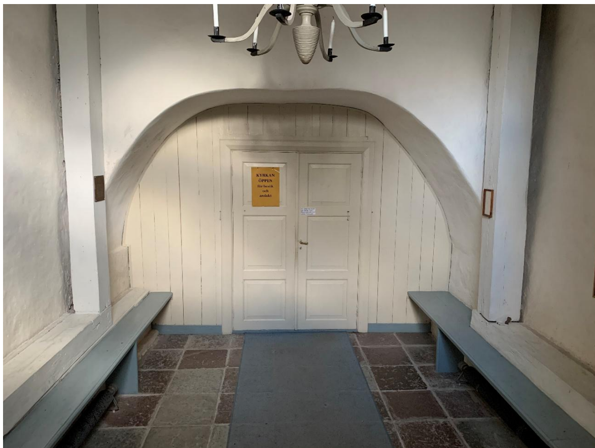
Vapenhuset i tornets bottenvåning, sedd mot öster. Träväggen i den låga, murade och tidigare öppna tornbågen tillkom 1913. Hörnstolparna utgör stödkonstruktion för klockvåningen. Foto JL 2021.
