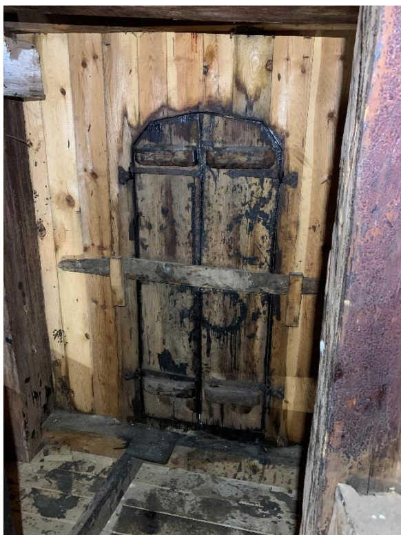
Luckförsedd öppning i huvens nedre våning. Stolpen i förgrunden visar spår av den rödtjära som enligt uppgift tidigare använts på delar av huven. Till höger knutpunkt med sannolikt ursprungligt järnbeslag. Foto JL 2021.
