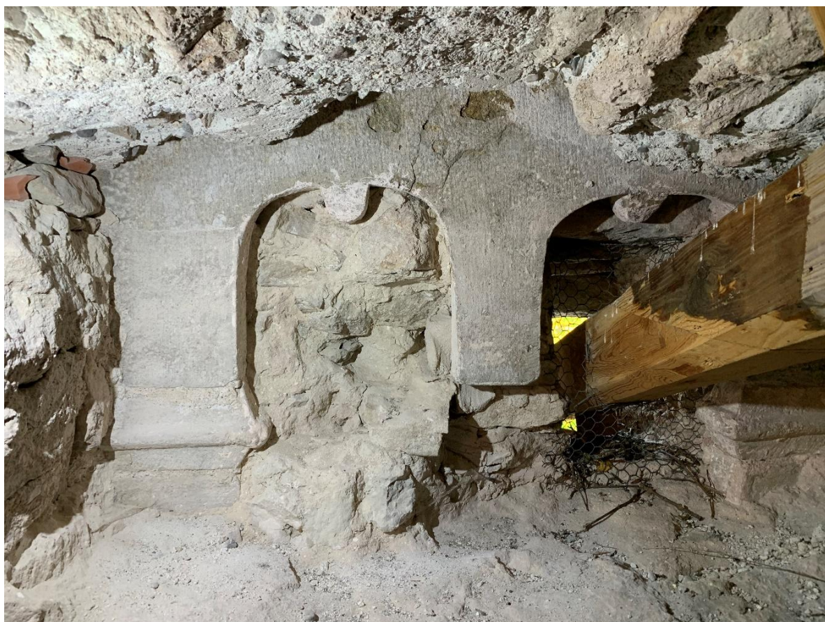
Del av omfattning till tidigare ljudglugg i andra övervåningens norra mur, nu öppning för klockdäckets spygatt. Formad sannolikt vid 1600-talets senare del av huggstensdetaljer med okänt ursprung. Foto JL 2021.
