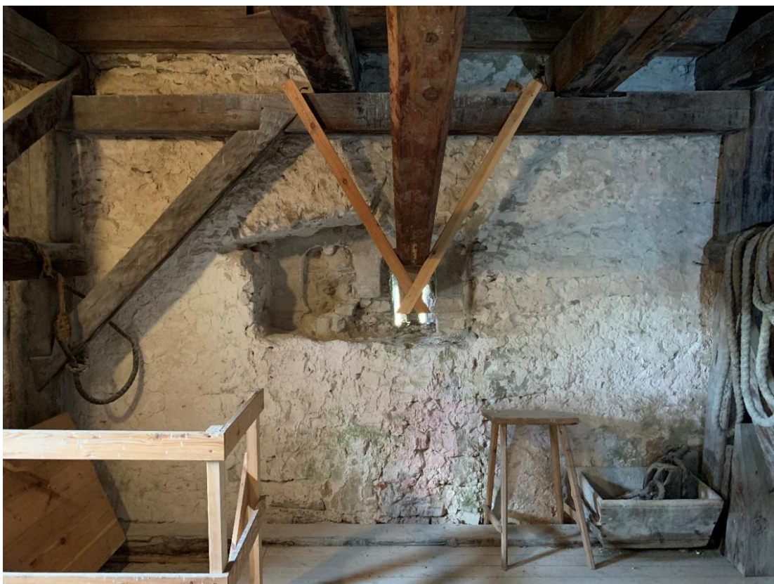
Tornets andra övervåning mot norr med igensatt tidigare ljudglugg. Foto JL 2021.
