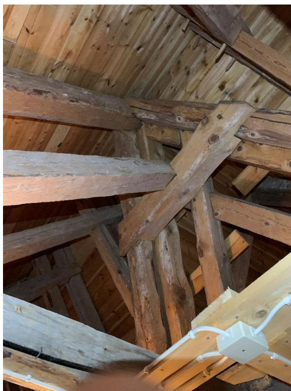
Anslutningen mellan tvärskepps- och långhustaket, sedd nedåt mot söder och uppåt mot sydväst. Foto JL 2021.
